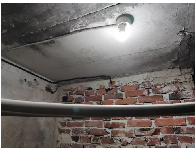
48. «Жилой дом акционерного общества «Пеликан», Ленинградская область, Выборгский район, г. Выборг, Ленинградский пр., д.2. Подвал. Фрагмент. Фото 20.08.2022г.
