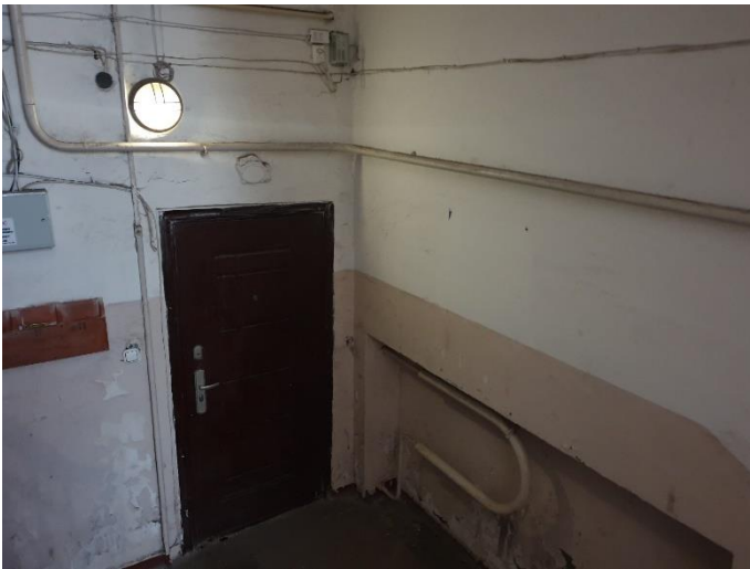
34. «Жилой дом акционерного общества «Пеликан», Ленинградская область, Выборгский район, г. Выборг, Ленинградский пр., д.2. Подъезд №7. Общий вид. Фото 20.08.2022г.
