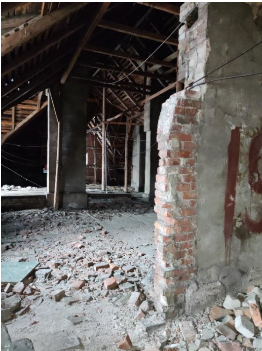
65. «Жилой дом акционерного общества «Пеликан», Ленинградская область, Выборгский район, г. Выборг, Ленинградский пр., д.2. Чердак. Фрагмент. Фото 20.08.2022г.
