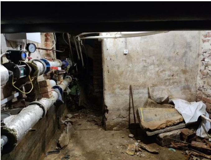
46. «Жилой дом акционерного общества «Пеликан», Ленинградская область, Выборгский район, г. Выборг, Ленинградский пр., д.2. Подвал. Общий вид. Фото 20.08.2022г.
