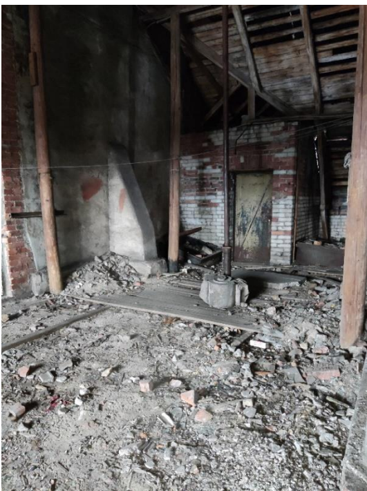
68. «Жилой дом акционерного общества «Пеликан», Ленинградская область, Выборгский район, г. Выборг, Ленинградский пр., д.2. Чердак. Фрагмент. Фото 20.08.2022г.
