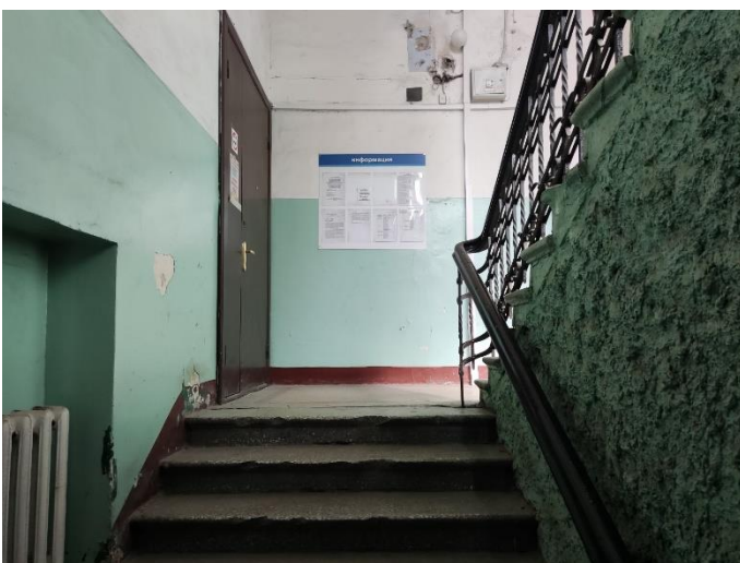
8. «Жилой дом акционерного общества «Пеликан», Ленинградская область, Выборгский район, г. Выборг, Ленинградский пр., д.2. Подъезд №2. Общий вид. Фото 20.08.2022г.
