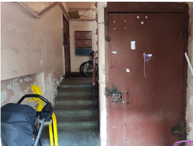
24. «Жилой дом акционерного общества «Пеликан», Ленинградская область, Выборгский район, г. Выборг, Ленинградский пр., д.2. Подъезд №5. Общий вид. Фото 20.08.2022г.
