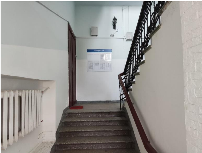
13. «Жилой дом акционерного общества «Пеликан», Ленинградская область, Выборгский район, г. Выборг, Ленинградский пр., д.2. Подъезд №3. Общий вид. Фото 20.08.2022г.
