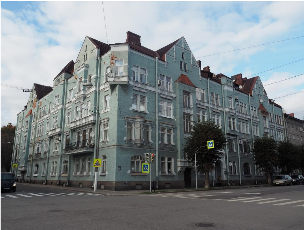
1. «Жилой дом акционерного общества «Пеликан», Ленинградская область, Выборгский район, г. Выборг, Ленинградский пр., д.2. Лицевой фасад. Общий вид с юга. Фото 20.08.2022г.
