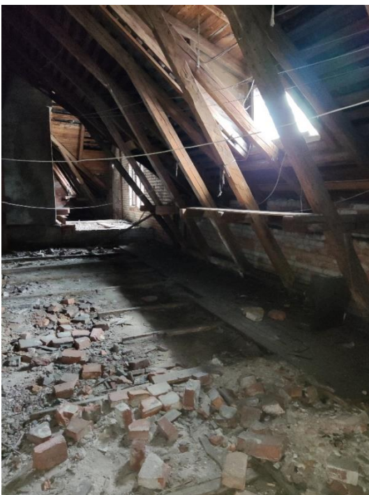
64. «Жилой дом акционерного общества «Пеликан», Ленинградская область, Выборгский район, г. Выборг, Ленинградский пр., д.2. Чердак. Фрагмент. Фото 20.08.2022г.
