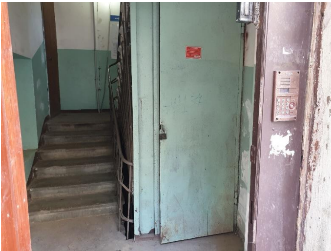
18. «Жилой дом акционерного общества «Пеликан», Ленинградская область, Выборгский район, г. Выборг, Ленинградский пр., д.2. Подъезд №4. Общий вид. Фото 20.08.2022г.
