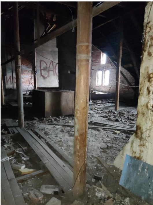
62. «Жилой дом акционерного общества «Пеликан», Ленинградская область, Выборгский район, г. Выборг, Ленинградский пр., д.2. Чердак. Фрагмент. Фото 20.08.2022г.
