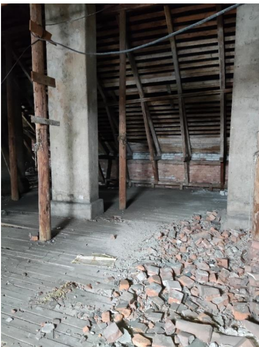
66. «Жилой дом акционерного общества «Пеликан», Ленинградская область, Выборгский район, г. Выборг, Ленинградский пр., д.2. Чердак. Фрагмент. Фото 20.08.2022г.
