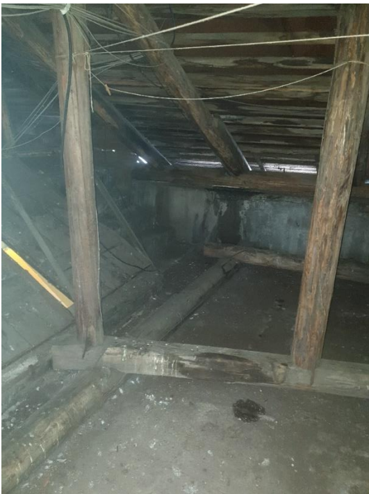
32. «Жилой дом», Ленинградская область, Выборгский район, г. Выборг, ул. Водной заставы., д.6. Чердак. Общий вид. Фото 20.08.2022г.
