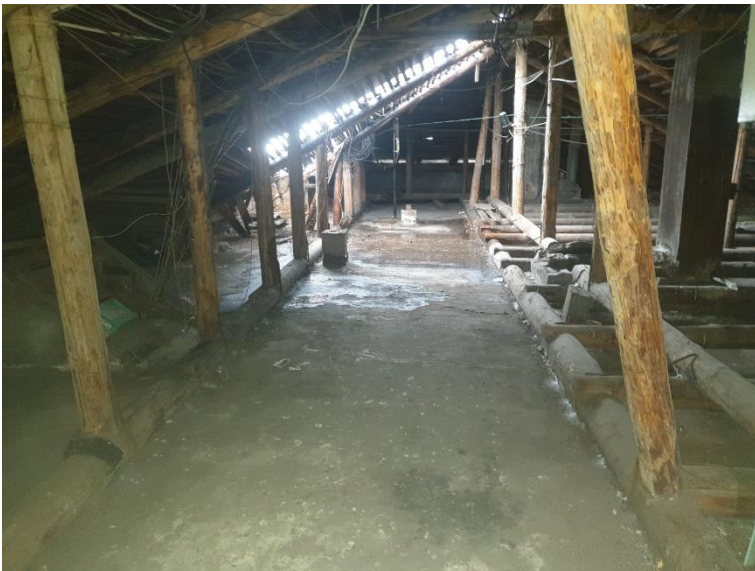
40. «Жилой дом», Ленинградская область, Выборгский район, г. Выборг, ул. Водной заставы., д.6. Чердак. Общий вид. Фото 20.08.2022г.
