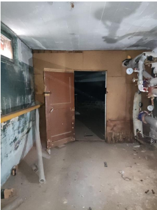
22. «Жилой дом», Ленинградская область, Выборгский район, г. Выборг, ул. Водной заставы., д.6. Подвал. Общий вид. Фото 20.08.2022г.
