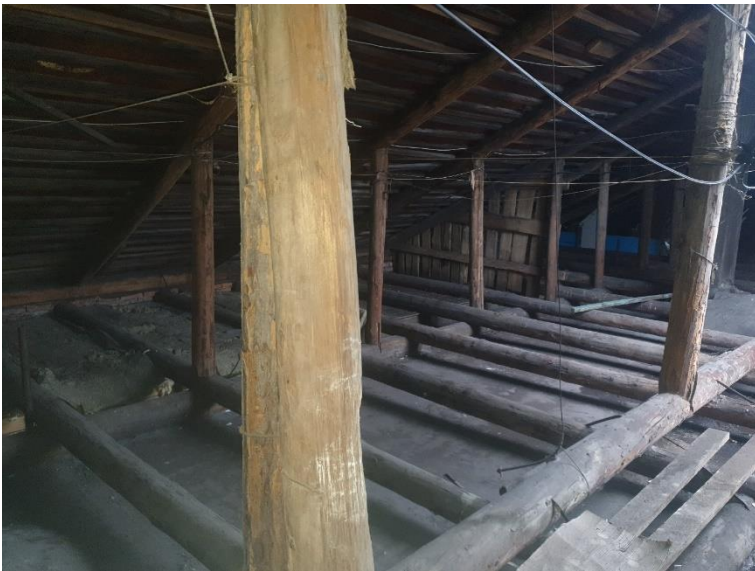
34. «Жилой дом», Ленинградская область, Выборгский район, г. Выборг, ул. Водной заставы., д.6. Чердак. Общий вид. Фото 20.08.2022г.
