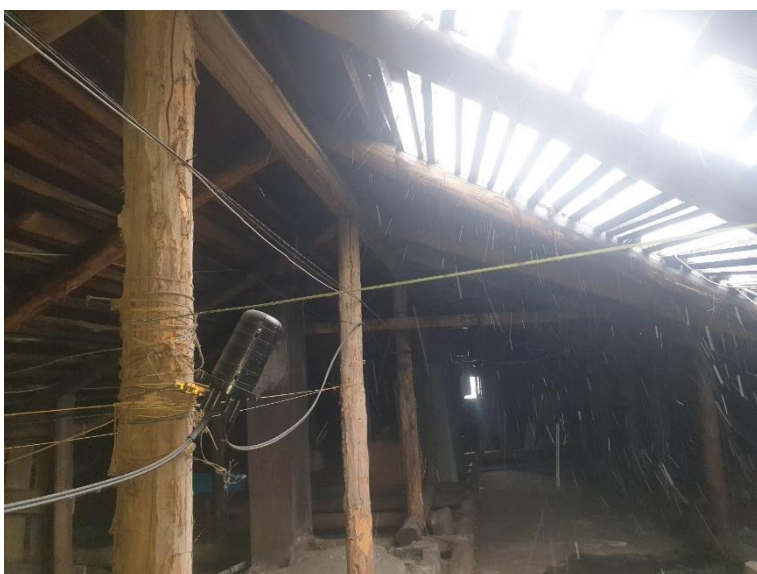
37. «Жилой дом», Ленинградская область, Выборгский район, г. Выборг, ул. Водной заставы., д.6. Чердак. Общий вид. Фото 20.08.2022г.
