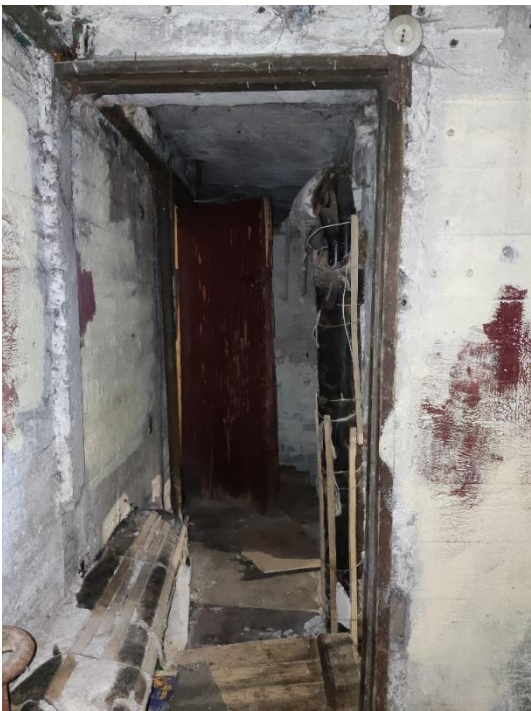
30. «Жилой дом», Ленинградская область, Выборгский район, г. Выборг, ул. Водной заставы., д.6. Подвал. Фрагмент. Фото 20.08.2022г.
