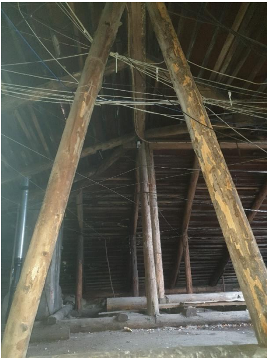
31. «Жилой дом», Ленинградская область, Выборгский район, г. Выборг, ул. Водной заставы., д.6. Чердак. Общий вид. Фото 20.08.2022г.
