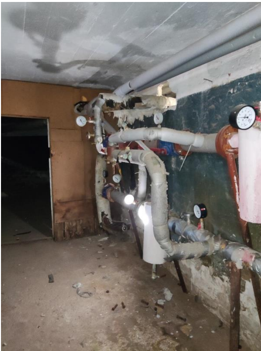
21. «Жилой дом», Ленинградская область, Выборгский район, г. Выборг, ул. Водной заставы., д.6. Подвал. Общий вид. Фото 20.08.2022г.
