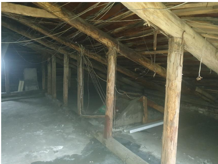
38. «Жилой дом», Ленинградская область, Выборгский район, г. Выборг, ул. Водной заставы., д.6. Чердак. Общий вид. Фото 20.08.2022г.
