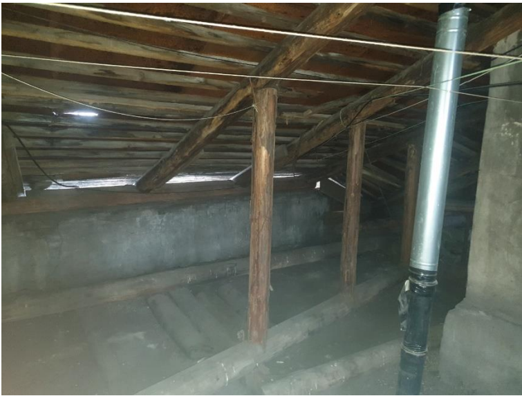
33. «Жилой дом», Ленинградская область, Выборгский район, г. Выборг, ул. Водной заставы., д.6. Чердак. Общий вид. Фото 20.08.2022г.
