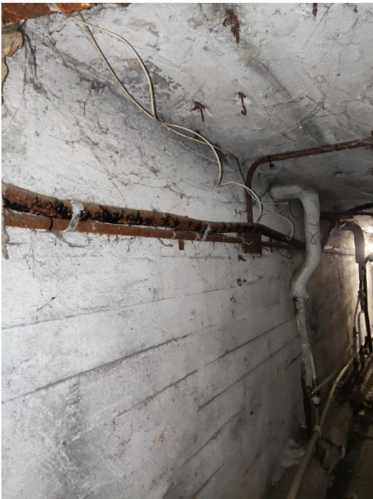
27. «Жилой дом», Ленинградская область, Выборгский район, г. Выборг, ул. Водной заставы., д.6. Подвал. Фрагмент. Фото 20.08.2022г.
