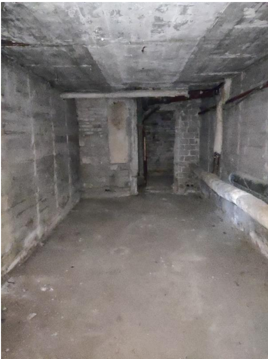
29. «Жилой дом», Ленинградская область, Выборгский район, г. Выборг, ул. Водной заставы., д.6. Подвал. Фрагмент. Фото 20.08.2022г.
