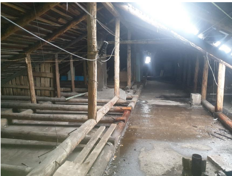
35. «Жилой дом», Ленинградская область, Выборгский район, г. Выборг, ул. Водной заставы., д.6. Чердак. Общий вид. Фото 20.08.2022г.
