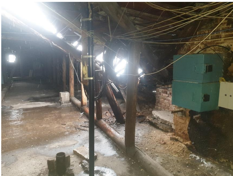
36. «Жилой дом», Ленинградская область, Выборгский район, г. Выборг, ул. Водной заставы., д.6. Чердак. Общий вид. Фото 20.08.2022г.
