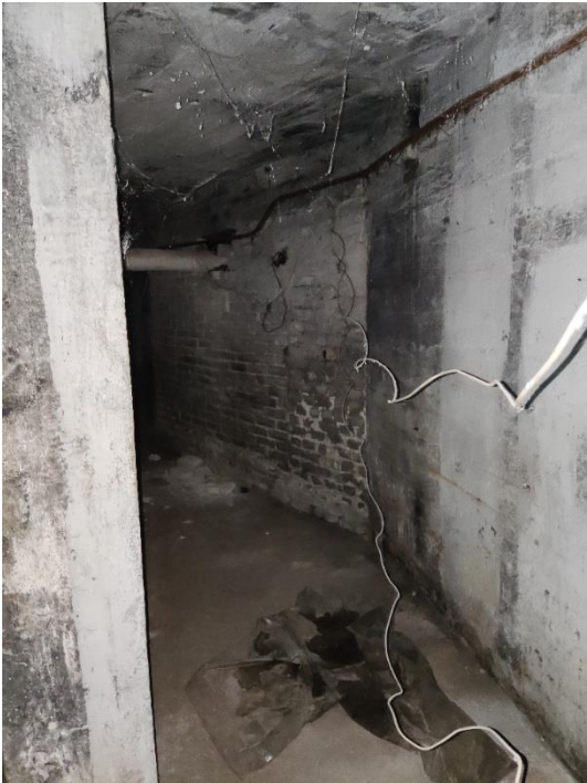
28. «Жилой дом», Ленинградская область, Выборгский район, г. Выборг, ул. Водной заставы., д.6. Подвал. Фрагмент. Фото 20.08.2022г.
