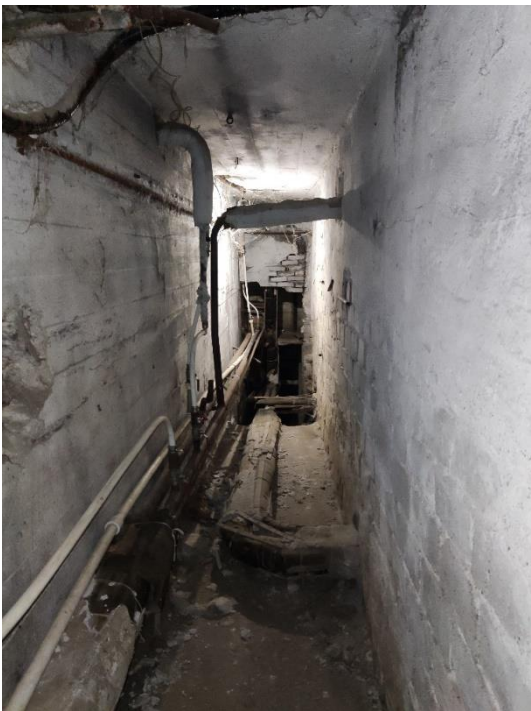
26. «Жилой дом», Ленинградская область, Выборгский район, г. Выборг, ул. Водной заставы., д.6. Подвал. Фрагмент. Фото 20.08.2022г.
