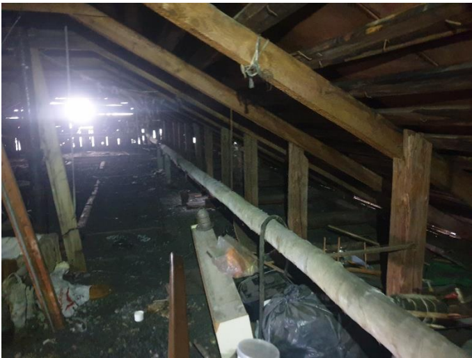
22. «Жилой дом акционерного общества «Айнола», Ленинградская область, Выборгский район, г. Выборг, ул. Некрасова, д.1. Чердак. Фрагмент. Фото 20.08.2022г.
