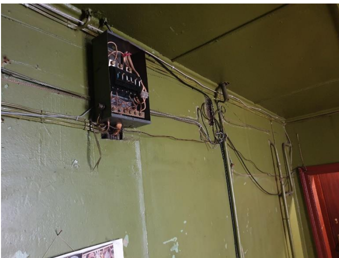
11. «Жилой дом акционерного общества «Айнола», Ленинградская область, Выборгский район, г. Выборг, ул. Некрасова, д.1. Подъезд. Фрагмент. Фото 20.08.2022г.
