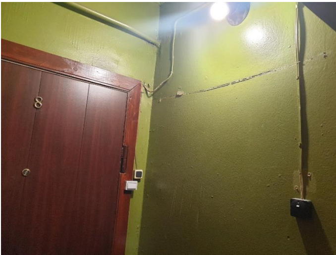
12. «Жилой дом акционерного общества «Айнола», Ленинградская область, Выборгский район, г. Выборг, ул. Некрасова, д.1. Подъезд. Фрагмент. Фото 20.08.2022г.
