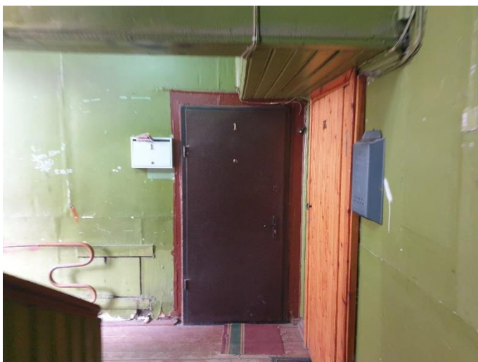
6. «Жилой дом акционерного общества «Айнола», Ленинградская область, Выборгский район, г. Выборг, ул. Некрасова, д.1. Подъезд. Фрагмент. Фото 20.08.2022г.
