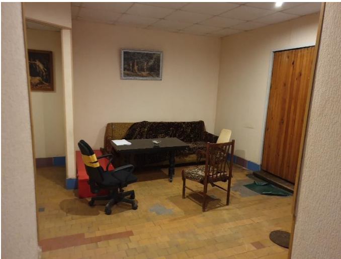
15. «Жилой дом акционерного общества «Айнола», Ленинградская область, Выборгский район, г. Выборг, ул. Некрасова, д.1. Подвал. Общий вид. Фото 20.08.2022г.
