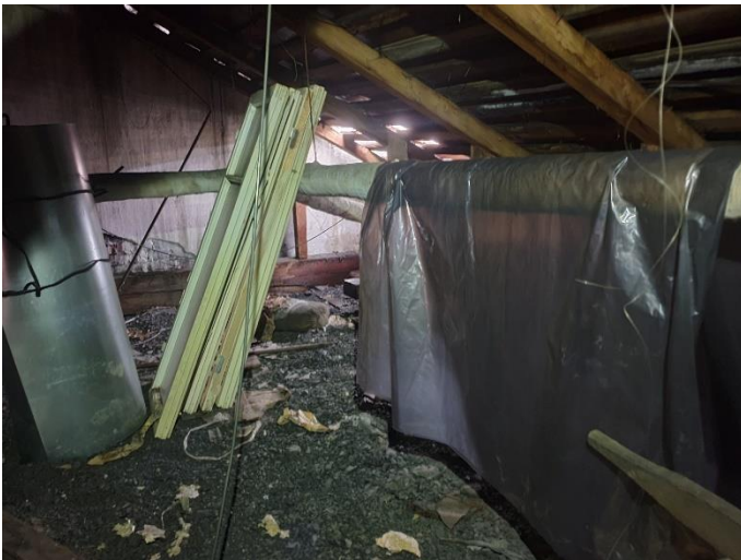
25. «Жилой дом акционерного общества «Айнола», Ленинградская область, Выборгский район, г. Выборг, ул. Некрасова, д.1. Чердак. Фрагмент. Фото 20.08.2022г.
