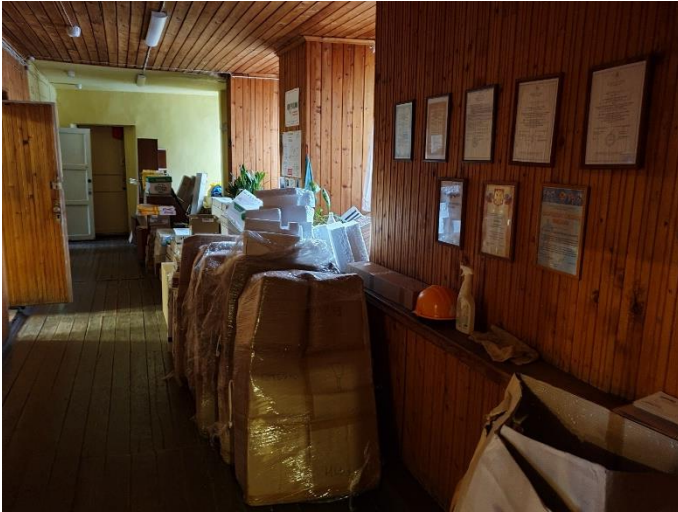
18. «Жилой дом акционерного общества «Айнола», Ленинградская область, Выборгский район, г. Выборг, ул. Некрасова, д.1. Подвал. Фрагмент. Фото 20.08.2022г.
