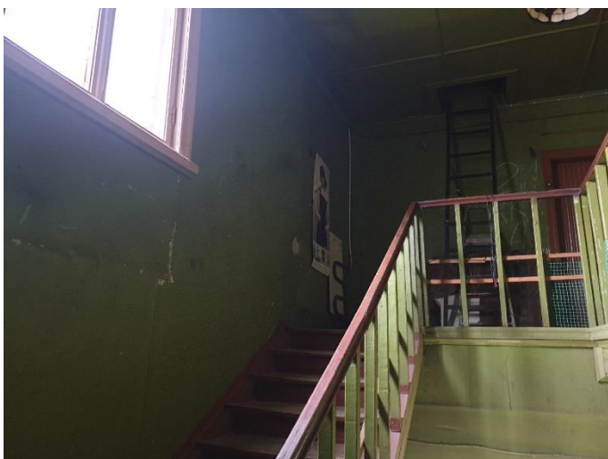
7. «Жилой дом акционерного общества «Айнола», Ленинградская область, Выборгский район, г. Выборг, ул. Некрасова, д.1. Подъезд. Фрагмент. Фото 20.08.2022г.
