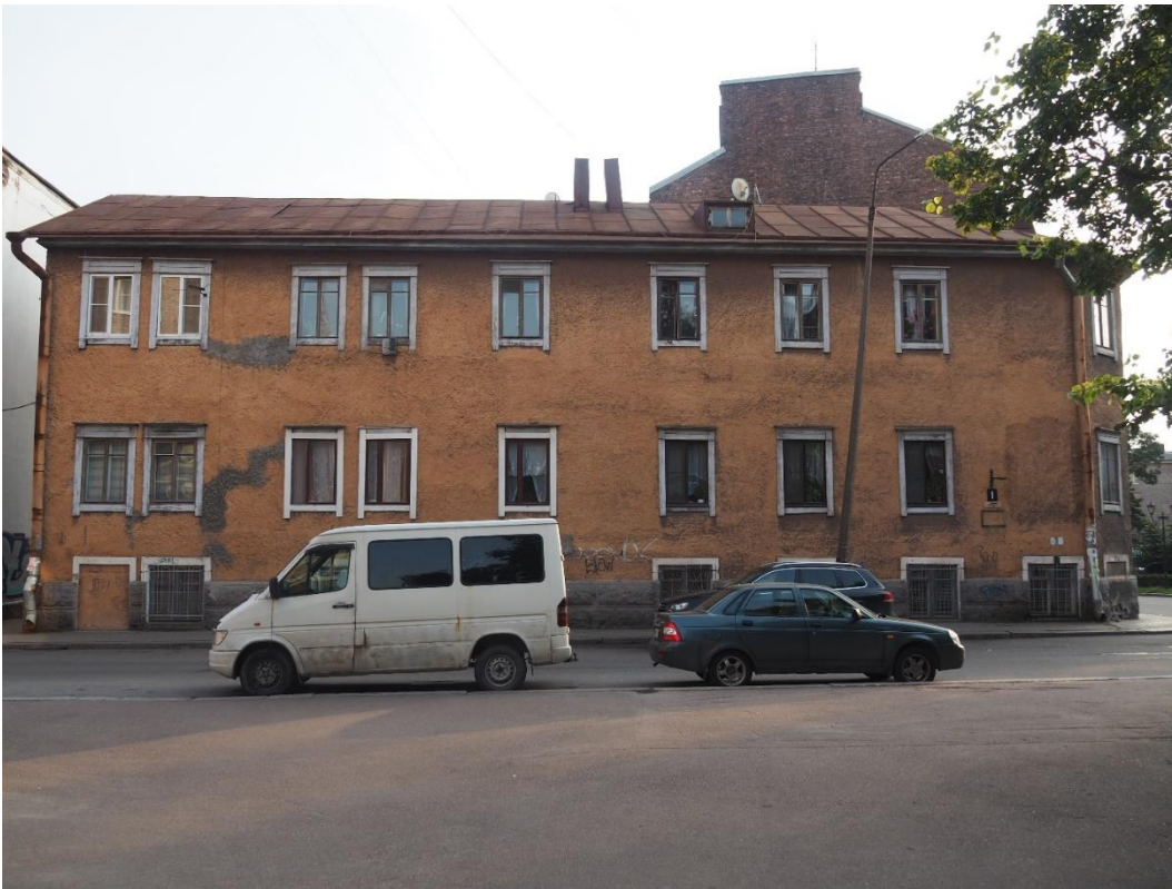
1. «Жилой дом акционерного общества «Айнола», Ленинградская область, Выборгский район, г. Выборг, ул. Некрасова, д.1. Северо-восточный фасад. Общий вид. Фото 20.08.2022г.
