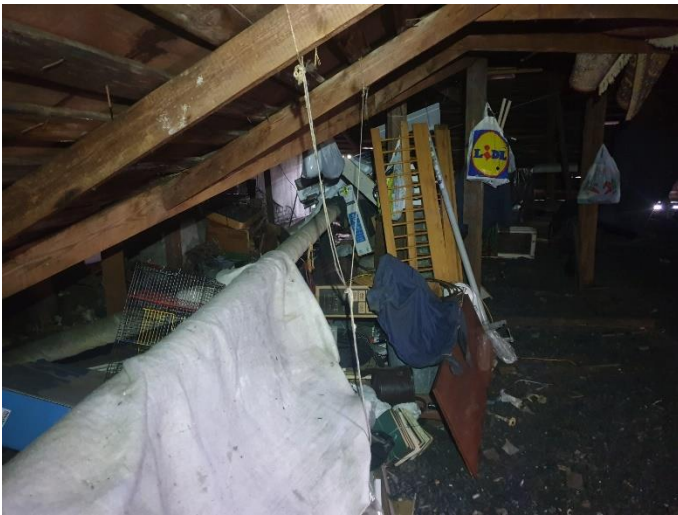
21. «Жилой дом акционерного общества «Айнола», Ленинградская область, Выборгский район, г. Выборг, ул. Некрасова, д.1. Чердак. Фрагмент. Фото 20.08.2022г.
