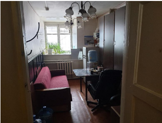
19. «Жилой дом акционерного общества «Айнола», Ленинградская область, Выборгский район, г. Выборг, ул. Некрасова, д.1. Подвал. Фрагмент. Фото 20.08.2022г.
