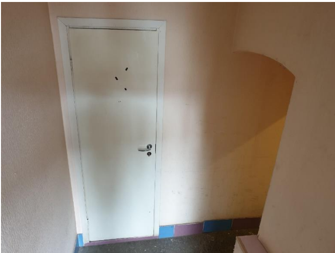
13. «Жилой дом акционерного общества «Айнола», Ленинградская область, Выборгский район, г. Выборг, ул. Некрасова, д.1. Подвал. Фрагмент. Фото 20.08.2022г.
