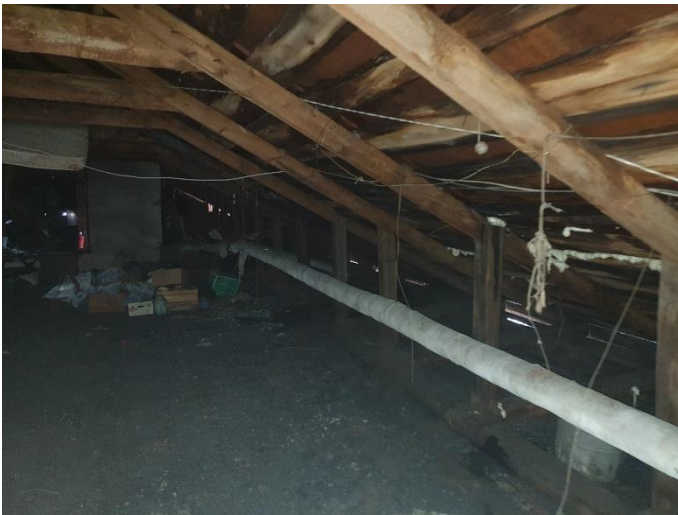
24. «Жилой дом акционерного общества «Айнола», Ленинградская область, Выборгский район, г. Выборг, ул. Некрасова, д.1. Чердак. Фрагмент. Фото 20.08.2022г.
