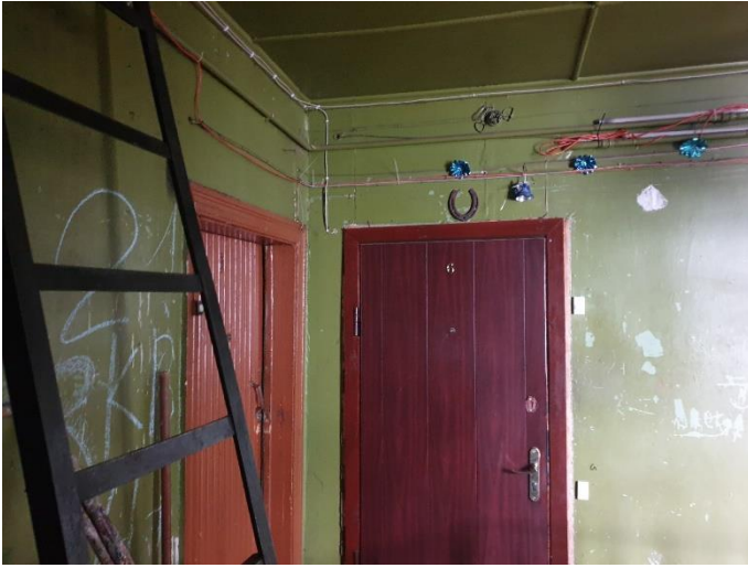
9. «Жилой дом акционерного общества «Айнола», Ленинградская область, Выборгский район, г. Выборг, ул. Некрасова, д.1. Подъезд. Фрагмент. Фото 20.08.2022г.
