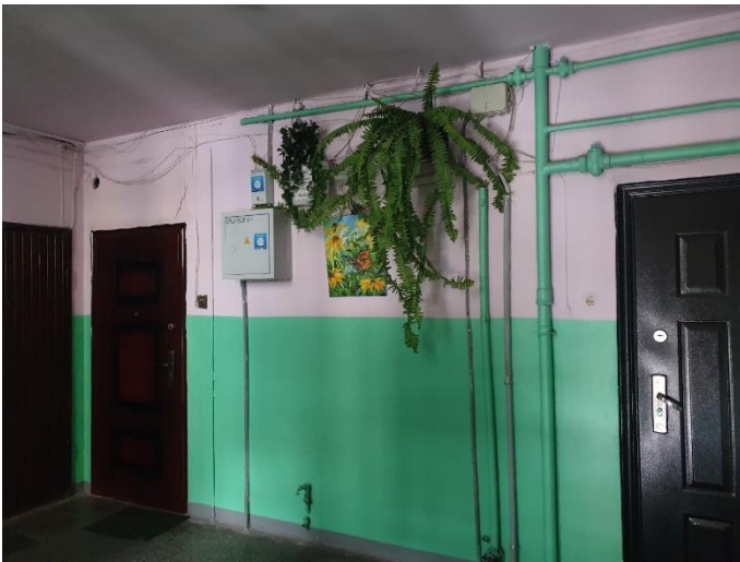
10. «Дом жилой с магазинами, гаражом», Ленинградская область, Выборгский район, г. Выборг, ул. Крепостная, д.47. Подъезд. Фрагмент. Фото 20.08.2022г.
