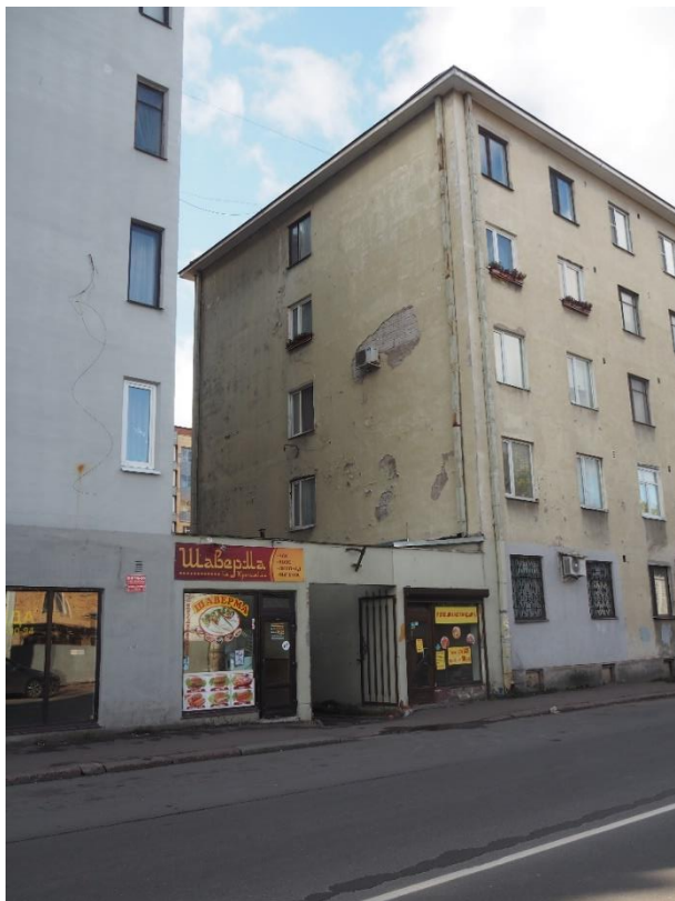
2. «Дом жилой с магазинами, гаражом», Ленинградская область, Выборгский район, г. Выборг, ул. Крепостная, д.47. Лицевой фасад. Общий вид с востока. Фото 20.08.2022г.
