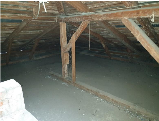
21. «Дом жилой с магазинами, гаражом», Ленинградская область, Выборгский район, г. Выборг, ул. Крепостная, д.47. Чердак. Фрагмент. Фото 20.08.2022г.
