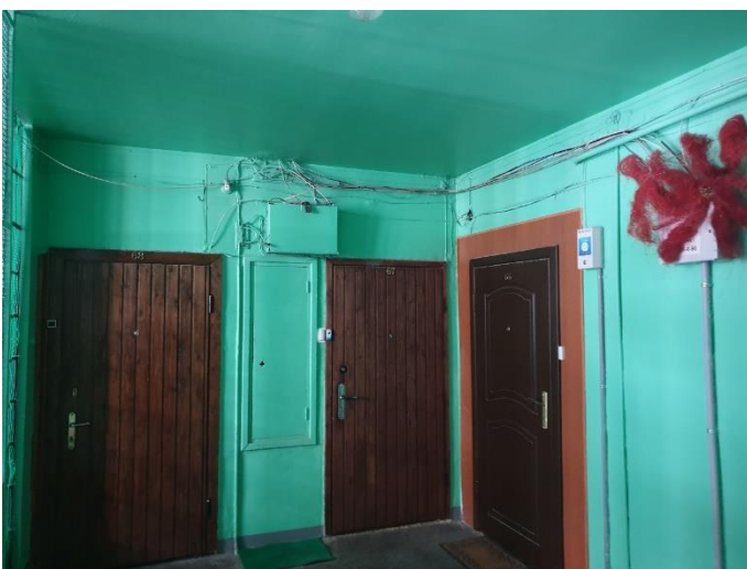
14. «Дом жилой с магазинами, гаражом», Ленинградская область, Выборгский район, г. Выборг, ул. Крепостная, д.47. Подъезд. Фрагмент. Фото 20.08.2022г.
