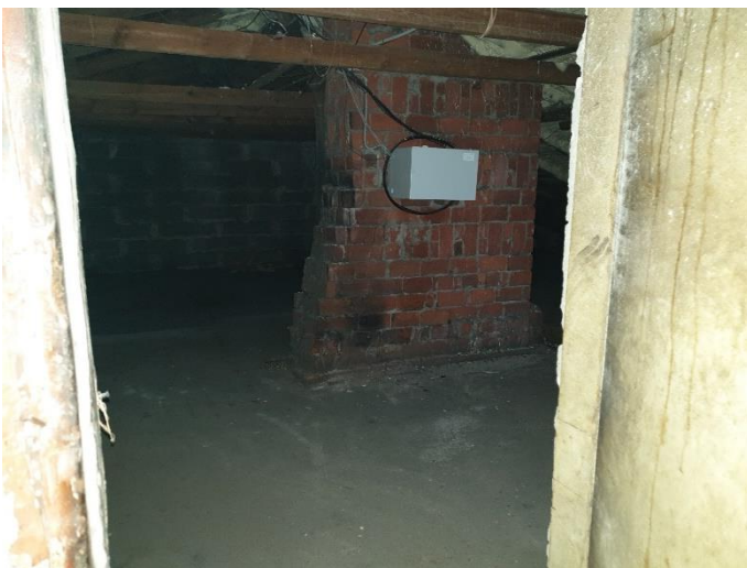
17. «Дом жилой с магазинами, гаражом», Ленинградская область, Выборгский район, г. Выборг, ул. Крепостная, д.47. Чердак. Фрагмент. Фото 20.08.2022г.
