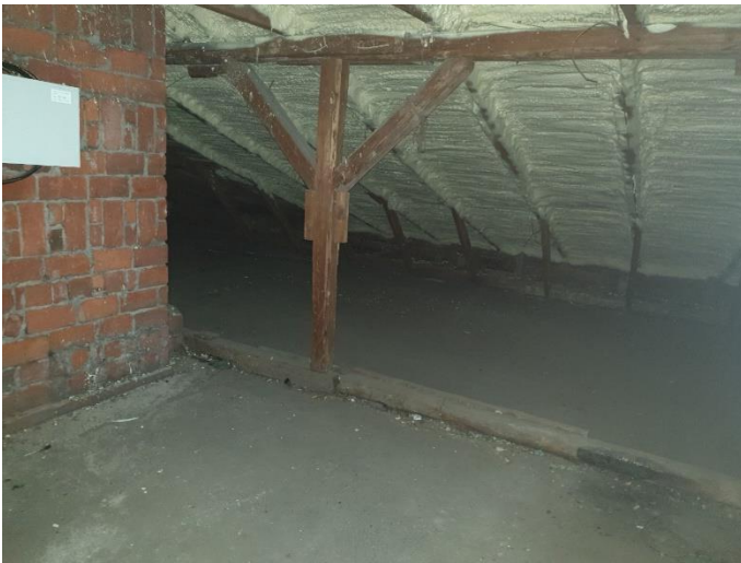
18. «Дом жилой с магазинами, гаражом», Ленинградская область, Выборгский район, г. Выборг, ул. Крепостная, д.47. Чердак. Фрагмент. Фото 20.08.2022г.
