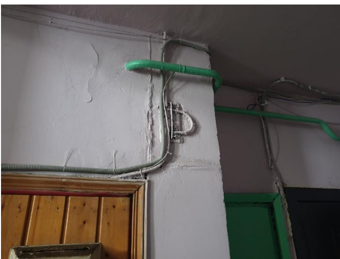
8. «Дом жилой с магазинами, гаражом», Ленинградская область, Выборгский район, г. Выборг, ул. Крепостная, д.47. Подъезд. Фрагмент. Фото 20.08.2022г.
