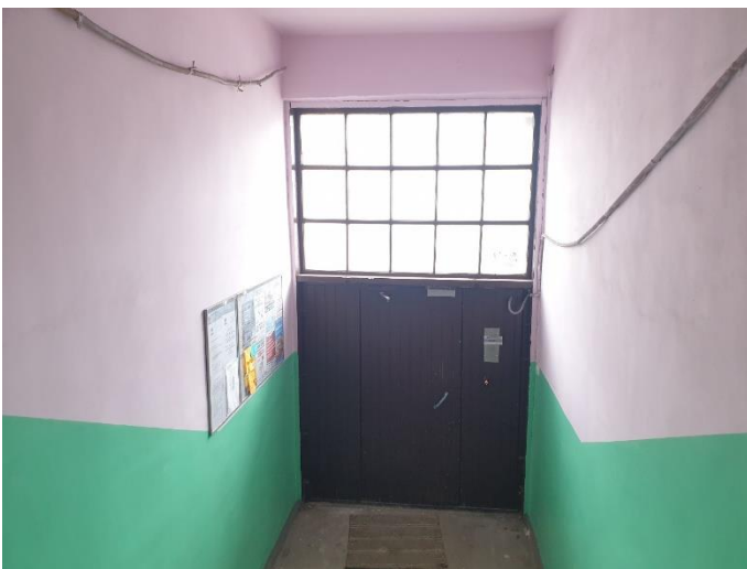
5. «Дом жилой с магазинами, гаражом», Ленинградская область, Выборгский район, г. Выборг, ул. Крепостная, д.47. Подъезд. Общий вид. Фото 20.08.2022г.
