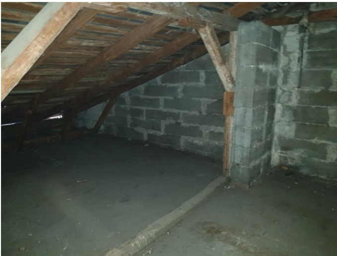
19. «Дом жилой с магазинами, гаражом», Ленинградская область, Выборгский район, г. Выборг, ул. Крепостная, д.47. Чердак. Фрагмент. Фото 20.08.2022г.
