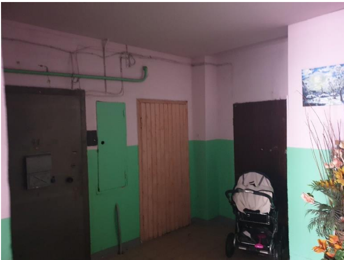
7. «Дом жилой с магазинами, гаражом», Ленинградская область, Выборгский район, г. Выборг, ул. Крепостная, д.47. Подъезд. Фрагмент. Фото 20.08.2022г.
