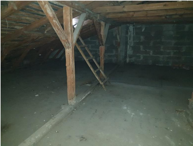
16. «Дом жилой с магазинами, гаражом», Ленинградская область, Выборгский район, г. Выборг, ул. Крепостная, д.47. Чердак. Общий вид. Фото 20.08.2022г.
