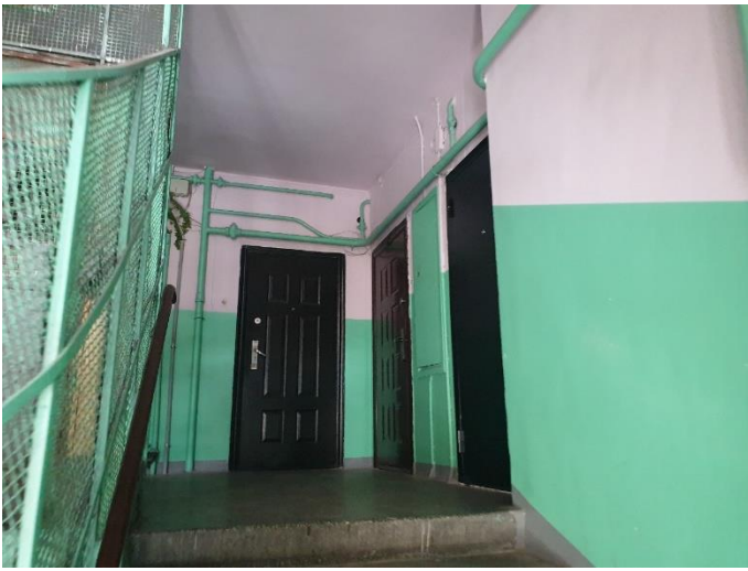
9. «Дом жилой с магазинами, гаражом», Ленинградская область, Выборгский район, г. Выборг, ул. Крепостная, д.47. Подъезд. Фрагмент. Фото 20.08.2022г.
