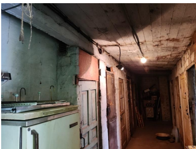
50. «Жилой дом с магазинами акционерного общества «Илвес», Ленинградская область, Выборгский район, г. Выборг, Ленинградское шоссе, д.11. Чердак. Общий вид. Фото 20.08.2022г.
