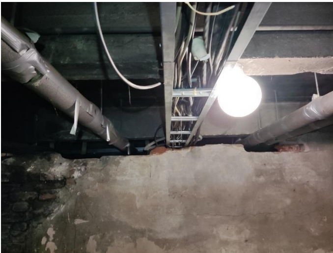
33. «Жилой дом с магазинами акционерного общества «Илвес», Ленинградская область, Выборгский район, г. Выборг, Ленинградское шоссе, д.11. Подвал. Фрагмент. Фото 20.08.2022г.
