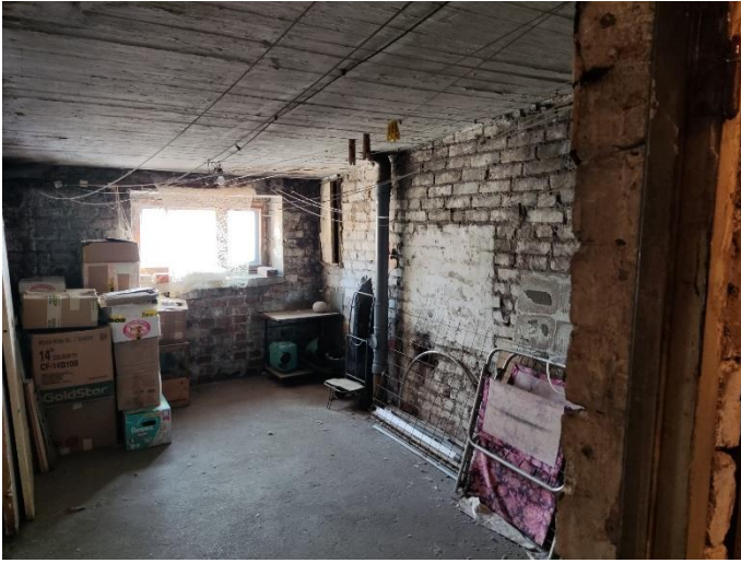
51. «Жилой дом с магазинами акционерного общества «Илвес», Ленинградская область, Выборгский район, г. Выборг, Ленинградское шоссе, д.11. Чердак. Общий вид. Фото 20.08.2022г.
