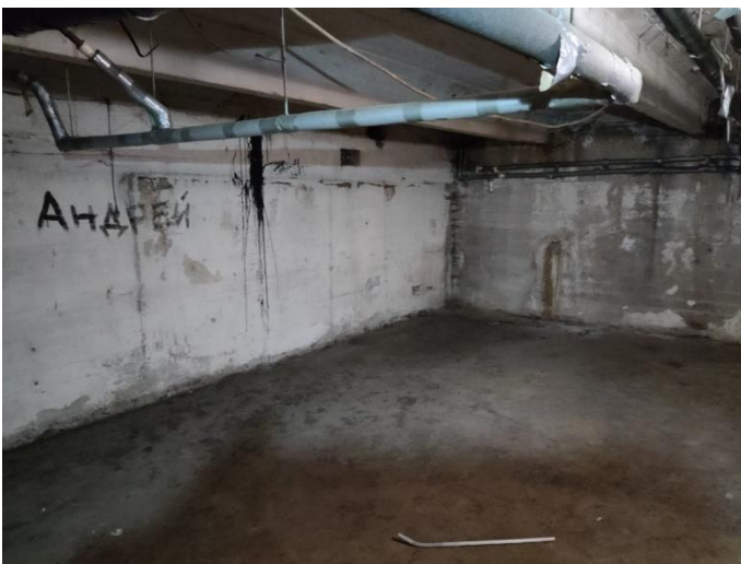
38. «Жилой дом с магазинами акционерного общества «Илвес», Ленинградская область, Выборгский район, г. Выборг, Ленинградское шоссе, д.11. Подвал. Фрагмент. Фото 20.08.2022г.
