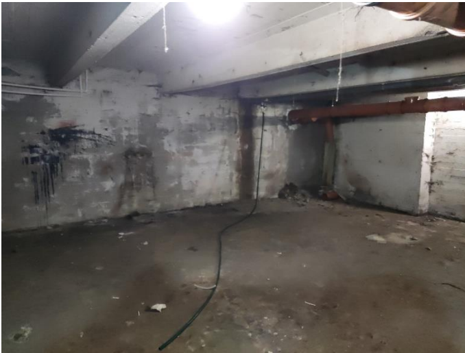
40. «Жилой дом с магазинами акционерного общества «Илвес», Ленинградская область, Выборгский район, г. Выборг, Ленинградское шоссе, д.11. Подвал. Фрагмент. Фото 20.08.2022г.
