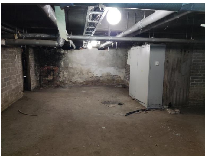
35. «Жилой дом с магазинами акционерного общества «Илвес», Ленинградская область, Выборгский район, г. Выборг, Ленинградское шоссе, д.11. Подвал. Фрагмент. Фото 20.08.2022г.
