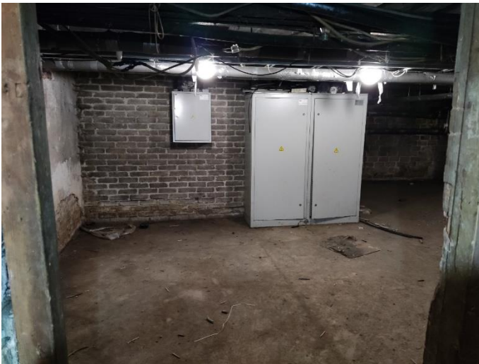
31. «Жилой дом с магазинами акционерного общества «Илвес», Ленинградская область, Выборгский район, г. Выборг, Ленинградское шоссе, д.11. Подвал. Общий вид. Фото 20.08.2022г.
