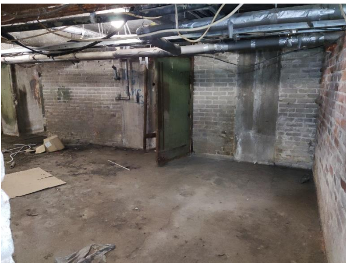
41. «Жилой дом с магазинами акционерного общества «Илвес», Ленинградская область, Выборгский район, г. Выборг, Ленинградское шоссе, д.11. Подвал. Фрагмент. Фото 20.08.2022г.
