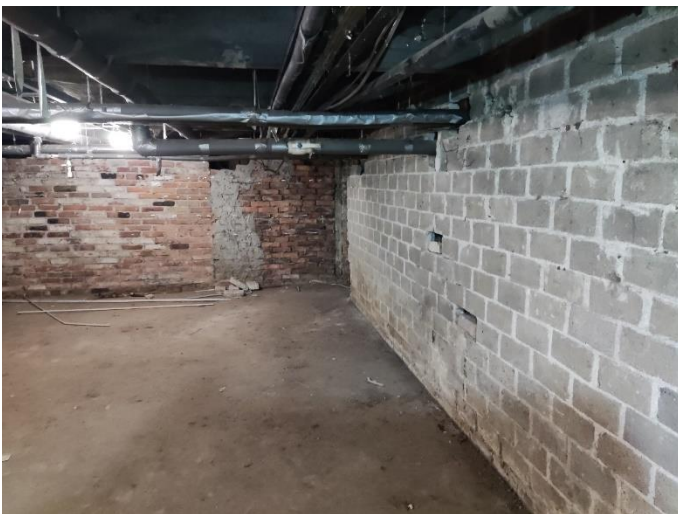
32. «Жилой дом с магазинами акционерного общества «Илвес», Ленинградская область, Выборгский район, г. Выборг, Ленинградское шоссе, д.11. Подвал. Общий вид. Фото 20.08.2022г.
