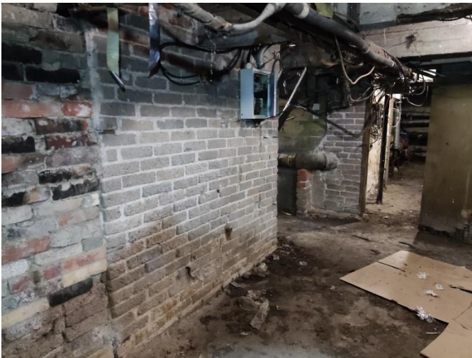
42. «Жилой дом с магазинами акционерного общества «Илвес», Ленинградская область, Выборгский район, г. Выборг, Ленинградское шоссе, д.11. Подвал. Фрагмент. Фото 20.08.2022г.
