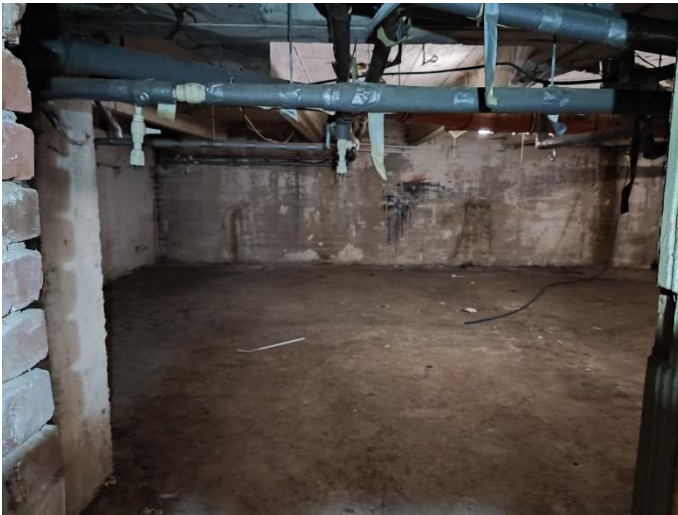
37. «Жилой дом с магазинами акционерного общества «Илвес», Ленинградская область, Выборгский район, г. Выборг, Ленинградское шоссе, д.11. Подвал. Фрагмент. Фото 20.08.2022г.
