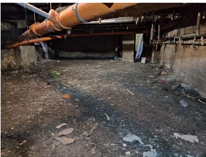
44. «Жилой дом с магазинами акционерного общества «Илвес», Ленинградская область, Выборгский район, г. Выборг, Ленинградское шоссе, д.11. Подвал. Фрагмент. Фото 20.08.2022г.
