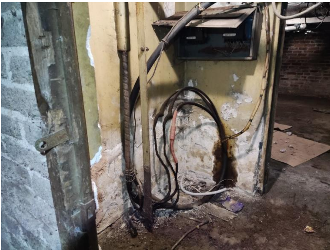
39. «Жилой дом с магазинами акционерного общества «Илвес», Ленинградская область, Выборгский район, г. Выборг, Ленинградское шоссе, д.11. Подвал. Фрагмент. Фото 20.08.2022г.
