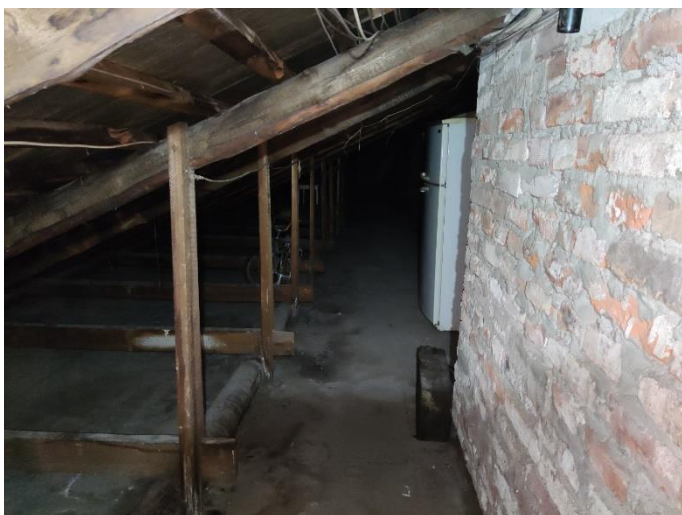
48. «Жилой дом с магазинами акционерного общества «Илвес», Ленинградская область, Выборгский район, г. Выборг, Ленинградское шоссе, д.11. Чердак. Общий вид. Фото 20.08.2022г.
