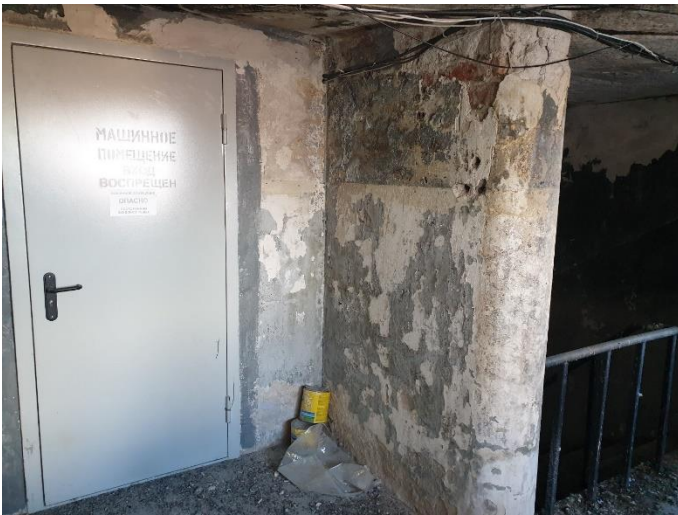
30. «Жилой дом», Ленинградская область, Выборгский район, г. Выборг, ул. Северная, д.10. Подъезд №4. Общий вид. Фото 20.08.2022г.
