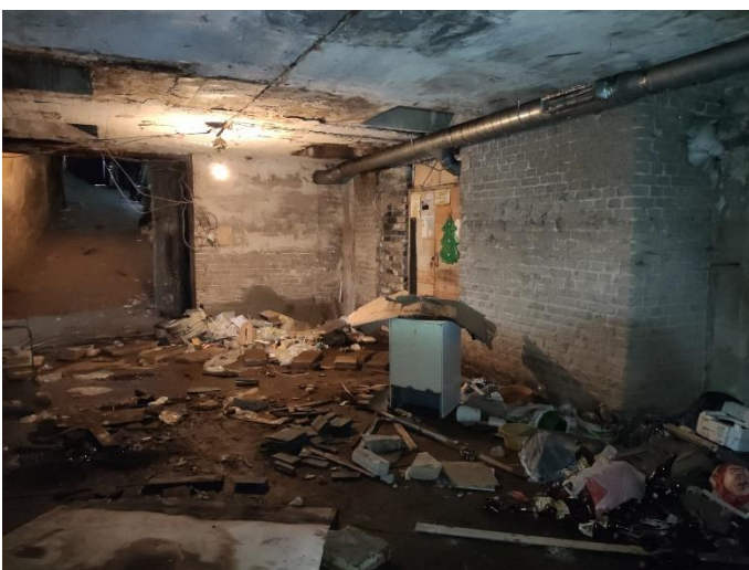
38. «Жилой дом», Ленинградская область, Выборгский район, г. Выборг, ул. Северная, д.10. Подвал. Фрагмент. Фото 20.08.2022г.
