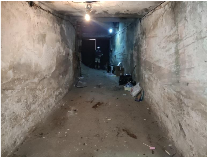
39. «Жилой дом», Ленинградская область, Выборгский район, г. Выборг, ул. Северная, д.10. Подвал. Фрагмент. Фото 20.08.2022г.
