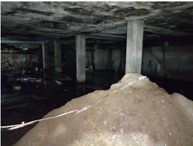
42. «Жилой дом», Ленинградская область, Выборгский район, г. Выборг, ул. Северная, д.10. Подвал. Фрагмент. Фото 20.08.2022г.
