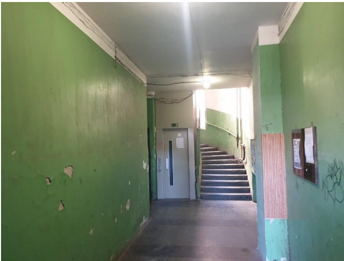
3. «Жилой дом», Ленинградская область, Выборгский район, г. Выборг, ул. Северная, д.10. Подъезд №1. Общий вид. Фото 20.08.2022г.
