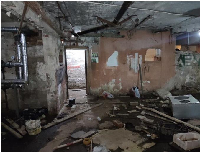
41. «Жилой дом», Ленинградская область, Выборгский район, г. Выборг, ул. Северная, д.10. Подвал. Фрагмент. Фото 20.08.2022г.
