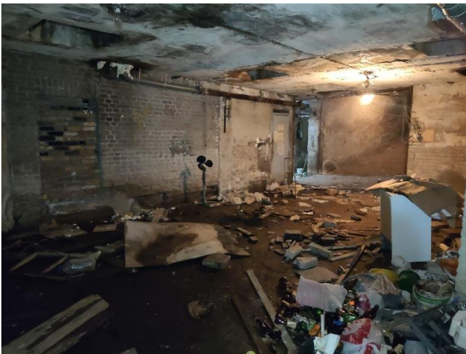
37. «Жилой дом», Ленинградская область, Выборгский район, г. Выборг, ул. Северная, д.10. Подвал. Фрагмент. Фото 20.08.2022г.
