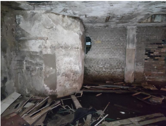
36. «Жилой дом», Ленинградская область, Выборгский район, г. Выборг, ул. Северная, д.10. Подвал. Фрагмент. Фото 20.08.2022г.
