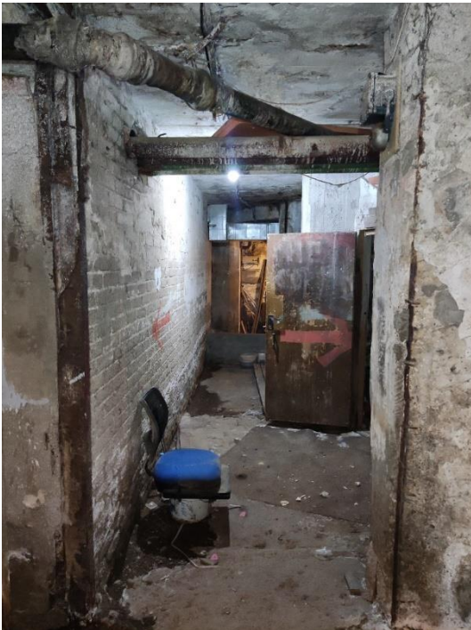
40. «Жилой дом», Ленинградская область, Выборгский район, г. Выборг, ул. Северная, д.10. Подвал. Фрагмент. Фото 20.08.2022г.
