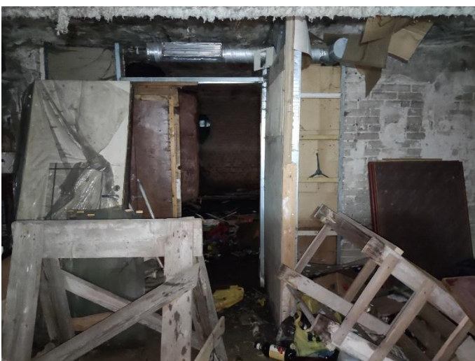
35. «Жилой дом», Ленинградская область, Выборгский район, г. Выборг, ул. Северная, д.10. Подвал. Фрагмент. Фото 20.08.2022г.
