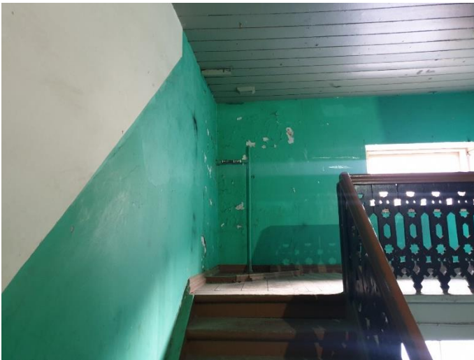
12. «Жилой дом В. Жаворонкова», Ленинградская область, Выборгский район, г. Выборг, ул. Крепостная, д.5а. Подъезд №1. Фрагмент. Фото 20.08.2022г.
