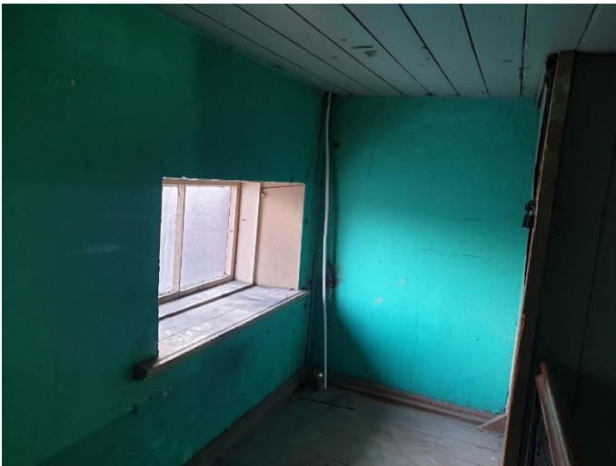
13. «Жилой дом В. Жаворонкова», Ленинградская область, Выборгский район, г. Выборг, ул. Крепостная, д.5а. Подъезд №1. Фрагмент. Фото 20.08.2022г.
