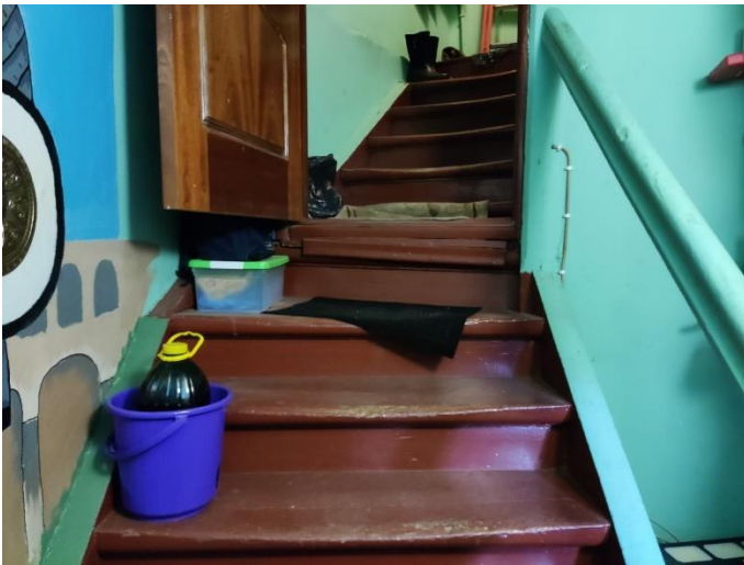
16. «Жилой дом В. Жаворонкова», Ленинградская область, Выборгский район, г. Выборг, ул. Крепостная, д.5а. Подъезд №2. Фрагмент. Фото 20.08.2022г.
