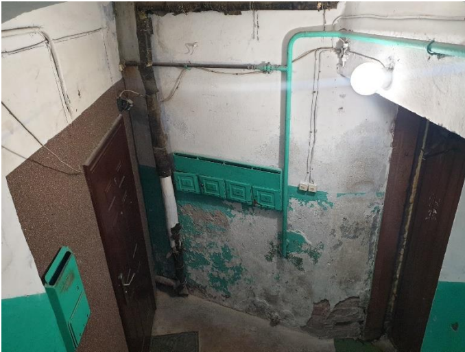
4. «Жилой дом В. Жаворонкова», Ленинградская область, Выборгский район, г. Выборг, ул. Крепостная, д.5а. Подъезд №1. Фрагмент. Фото 20.08.2022г.
