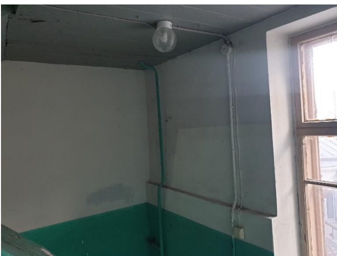
8. «Жилой дом В. Жаворонкова», Ленинградская область, Выборгский район, г. Выборг, ул. Крепостная, д.5а. Подъезд №1. Фрагмент. Фото 20.08.2022г.
