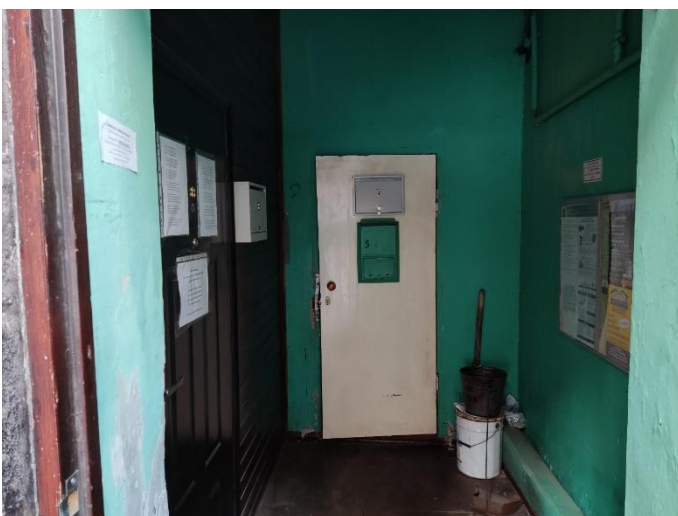
14. «Жилой дом В. Жаворонкова», Ленинградская область, Выборгский район, г. Выборг, ул. Крепостная, д.5а. Подъезд №2. Общий вид. Фото 20.08.2022г.
