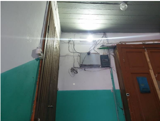
9. «Жилой дом В. Жаворонкова», Ленинградская область, Выборгский район, г. Выборг, ул. Крепостная, д.5а. Подъезд №1. Фрагмент. Фото 20.08.2022г.
