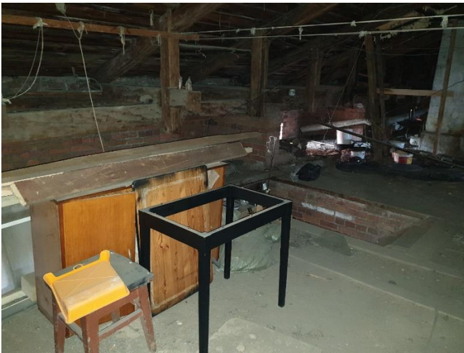
24. «Жилой дом В. Жаворонкова», Ленинградская область, Выборгский район, г. Выборг, ул. Крепостная, д.5а. Чердак. Фрагмент. Фото 20.08.2022г.
