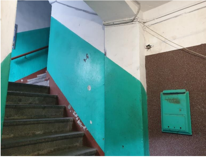
3. «Жилой дом В. Жаворонкова», Ленинградская область, Выборгский район, г. Выборг, ул. Крепостная, д.5а. Подъезд №1. Общий вид. Фото 20.08.2022г.
