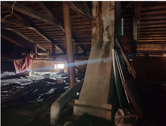
22. «Жилой дом В. Жаворонкова», Ленинградская область, Выборгский район, г. Выборг, ул. Крепостная, д.5а. Чердак. Фрагмент. Фото 20.08.2022г.
