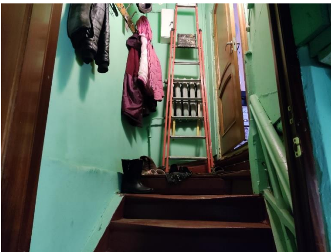
17. «Жилой дом В. Жаворонкова», Ленинградская область, Выборгский район, г. Выборг, ул. Крепостная, д.5а. Подъезд №2. Фрагмент. Фото 20.08.2022г.
