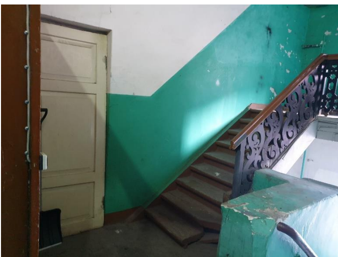
11. «Жилой дом В. Жаворонкова», Ленинградская область, Выборгский район, г. Выборг, ул. Крепостная, д.5а. Подъезд №1. Фрагмент. Фото 20.08.2022г.
