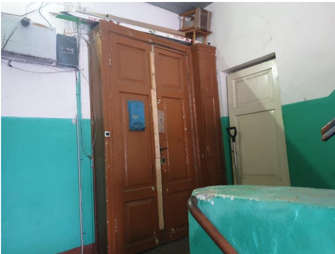
10. «Жилой дом В. Жаворонкова», Ленинградская область, Выборгский район, г. Выборг, ул. Крепостная, д.5а. Подъезд №1. Фрагмент. Фото 20.08.2022г.
