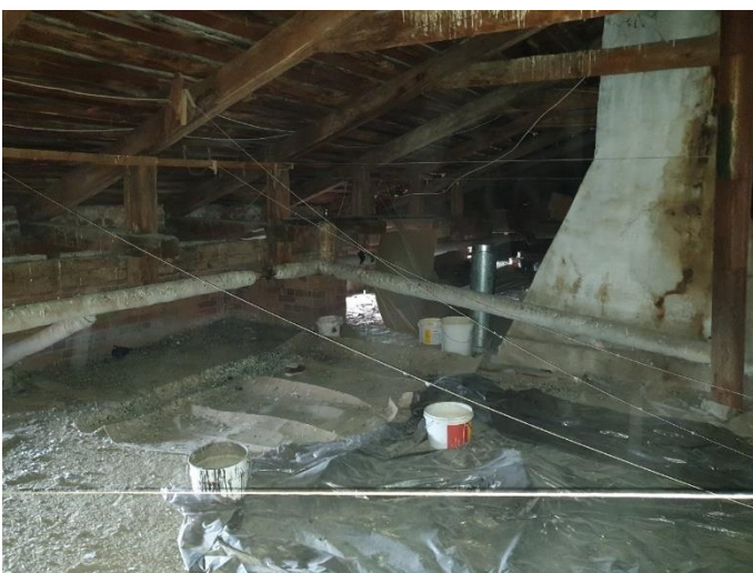
23. «Жилой дом В. Жаворонкова», Ленинградская область, Выборгский район, г. Выборг, ул. Крепостная, д.5а. Чердак. Фрагмент. Фото 20.08.2022г.
