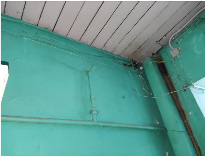
19. «Жилой дом В. Жаворонкова», Ленинградская область, Выборгский район, г. Выборг, ул. Крепостная, д.5а. Подъезд №2. Фрагмент. Фото 20.08.2022г.
