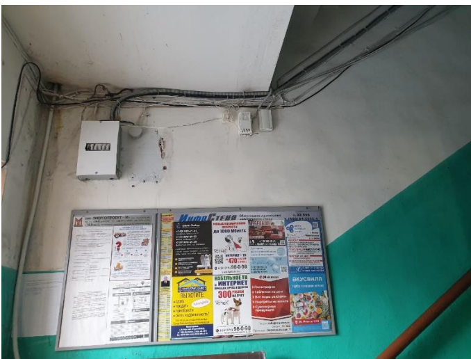
5. «Жилой дом В. Жаворонкова», Ленинградская область, Выборгский район, г. Выборг, ул. Крепостная, д.5а. Подъезд №1. Фрагмент. Фото 20.08.2022г.
