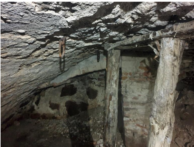
25. «Жилой дом Теслевых», Ленинградская область, Выборгский район, г. Выборг, ул. Прогонная, д.14. Подвал. Фрагмент. Фото 20.08.2022г.
