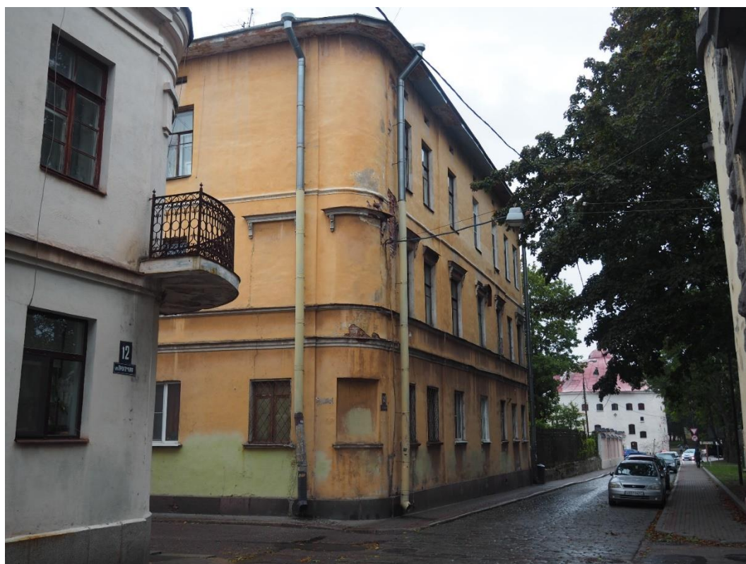
2. «Жилой дом Теслевых», Ленинградская область, Выборгский район, г. Выборг, ул. Прогонная, д.14. Лицевой фасад. Общий вид с Запада. Фото 20.08.2022г.
