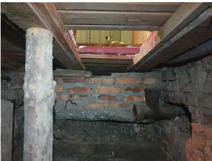
20. «Жилой дом Теслевых», Ленинградская область, Выборгский район, г. Выборг, ул. Прогонная, д.14. Подвал. Фрагмент. Фото 20.08.2022г.
