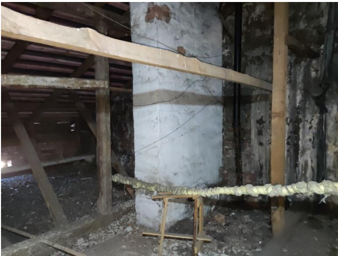
28. «Жилой дом Теслевых», Ленинградская область, Выборгский район, г. Выборг, ул. Прогонная, д.14. Чердак. Общий вид. Фото 20.08.2022г.
