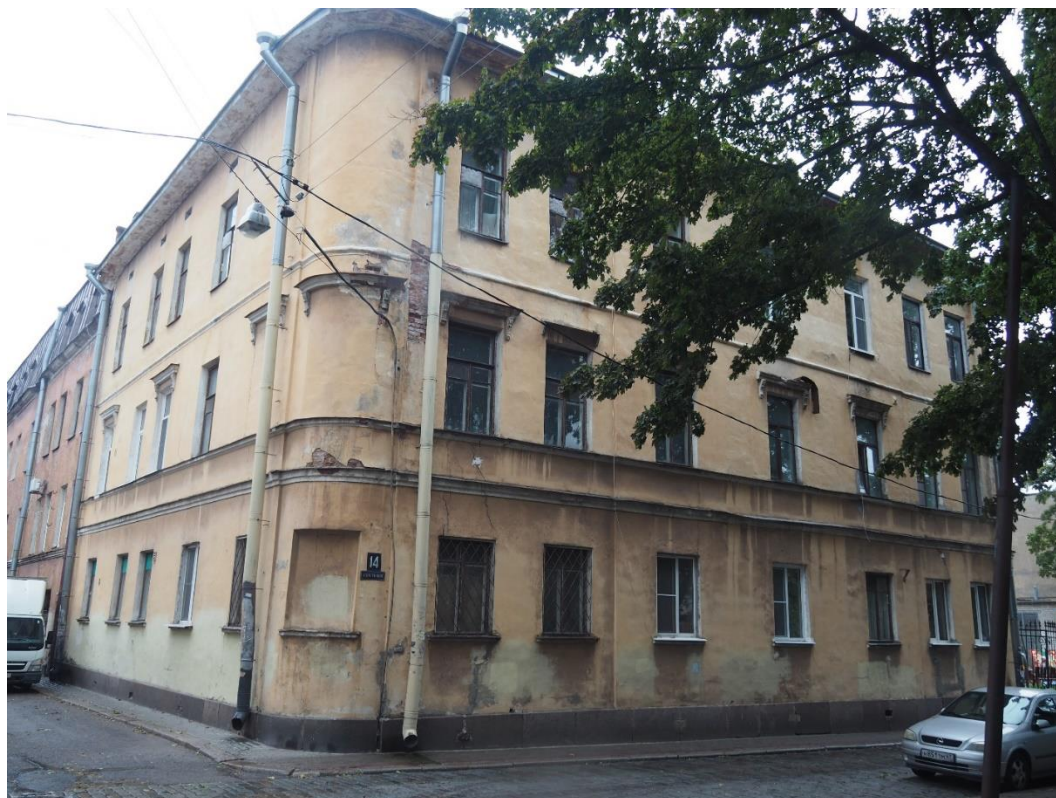
1. «Жилой дом Теслевых», Ленинградская область, Выборгский район, г. Выборг, ул. Прогонная, д.14. Лицевой фасад. Общий вид с Запада. Фото 20.08.2022г.
