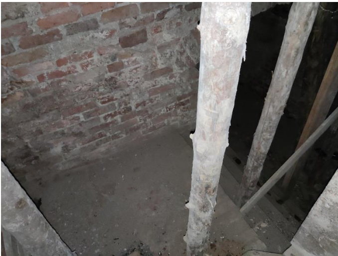
27. «Жилой дом Теслевых», Ленинградская область, Выборгский район, г. Выборг, ул. Прогонная, д.14. Подвал. Фрагмент. Фото 20.08.2022г.
