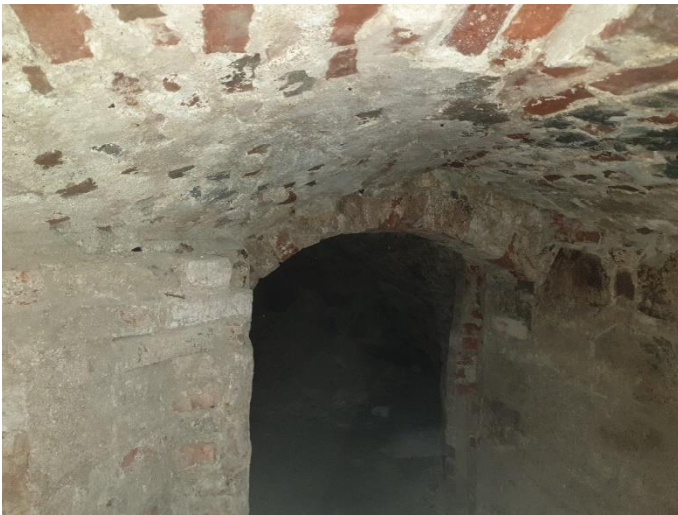
22. «Жилой дом Теслевых», Ленинградская область, Выборгский район, г. Выборг, ул. Прогонная, д.14. Подвал. Фрагмент. Фото 20.08.2022г.
