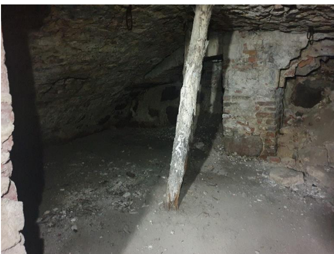
23. «Жилой дом Теслевых», Ленинградская область, Выборгский район, г. Выборг, ул. Прогонная, д.14. Подвал. Фрагмент. Фото 20.08.2022г.
