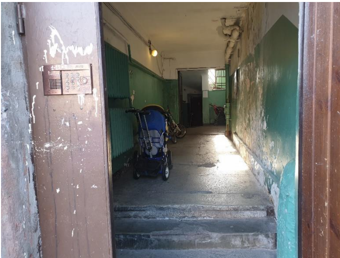
3. «Жилой дом Теслевых», Ленинградская область, Выборгский район, г. Выборг, ул. Прогонная, д.14. Подъезд. Общий вид. Фото 20.08.2022г.
