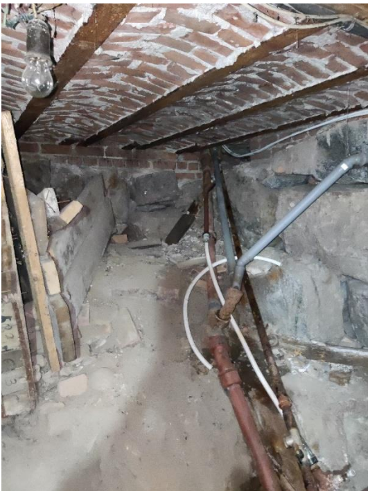
32. «Жилой дом», Ленинградская область, Выборгский район, г. Выборг, ул. Майорова д.2. Подвал. Фрагмент. Фото 20.08.2022г.
