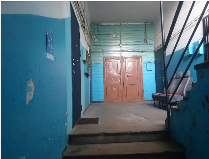
13. «Жилой дом», Ленинградская область, Выборгский район, г. Выборг, ул. Майорова д.2. Подъезд №2. Фрагмент. Фото 20.08.2022г.
