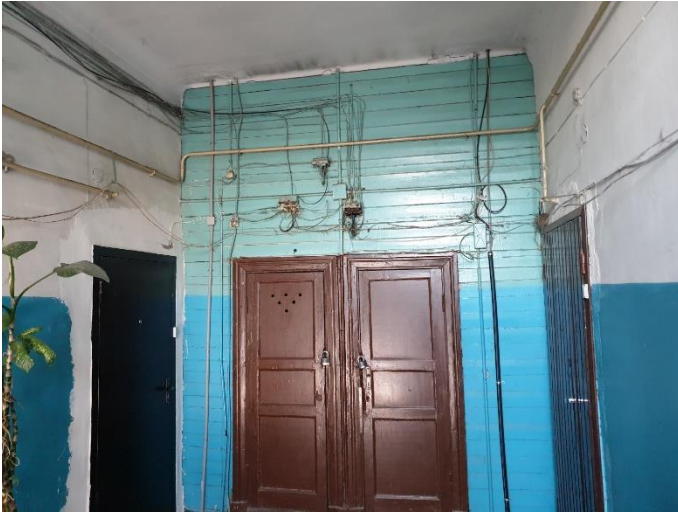
18. «Жилой дом», Ленинградская область, Выборгский район, г. Выборг, ул. Майорова д.2. Подъезд №2. Фрагмент. Фото 20.08.2022г.
