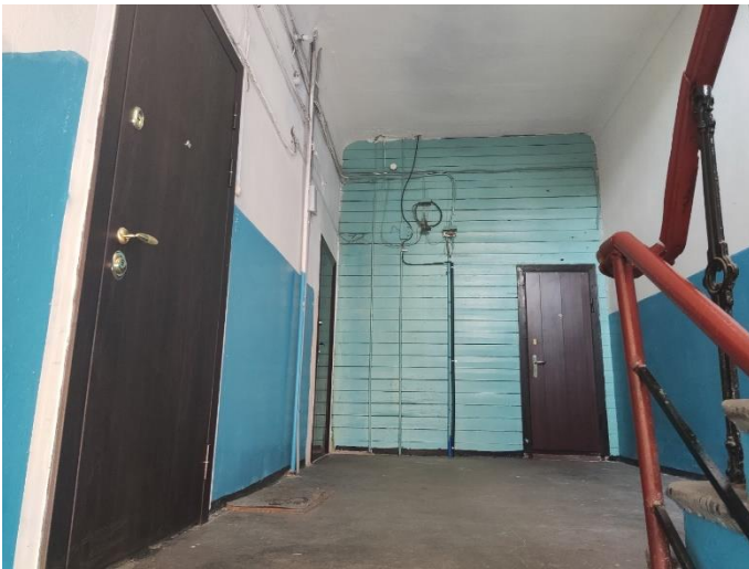
6. «Жилой дом», Ленинградская область, Выборгский район, г. Выборг, ул. Майорова д.2. Подъезд №1. Фрагмент. Фото 20.08.2022г.
