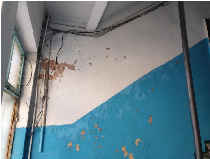
16. «Жилой дом», Ленинградская область, Выборгский район, г. Выборг, ул. Майорова д.2. Подъезд №2. Фрагмент. Фото 20.08.2022г.
