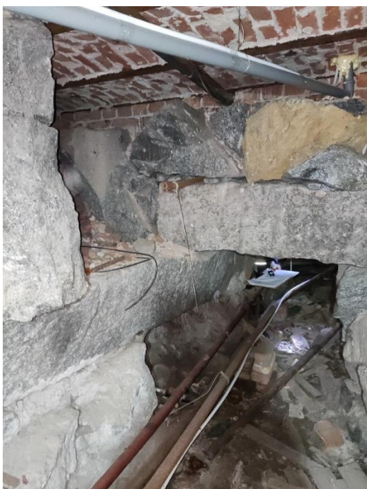
28. «Жилой дом», Ленинградская область, Выборгский район, г. Выборг, ул. Майорова д.2. Подвал. Фрагмент. Фото 20.08.2022г.
