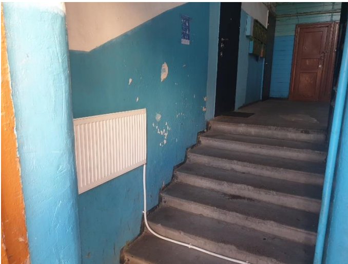
12. «Жилой дом», Ленинградская область, Выборгский район, г. Выборг, ул. Майорова д.2. Подъезд №2. Общий вид. Фото 20.08.2022г.
