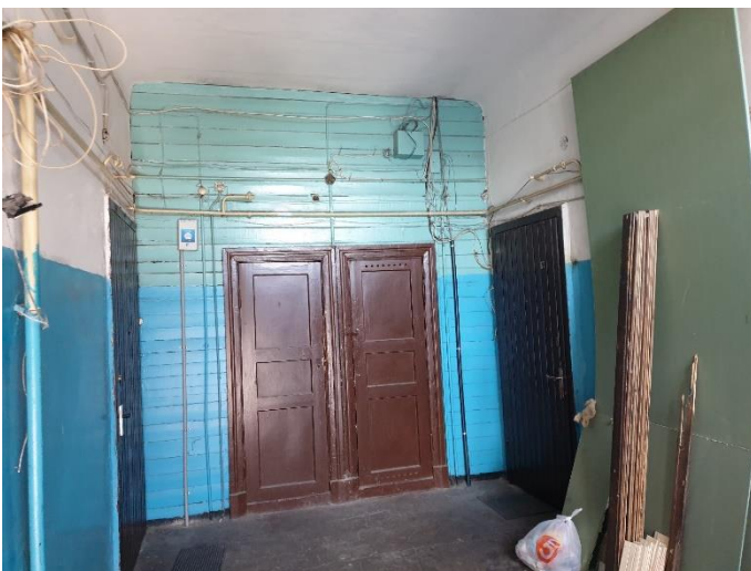
20. «Жилой дом», Ленинградская область, Выборгский район, г. Выборг, ул. Майорова д.2. Подъезд №2. Фрагмент. Фото 20.08.2022г.
