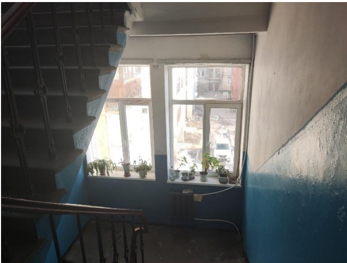
10. «Жилой дом», Ленинградская область, Выборгский район, г. Выборг, ул. Майорова д.2. Подъезд №1. Фрагмент. Фото 20.08.2022г.
