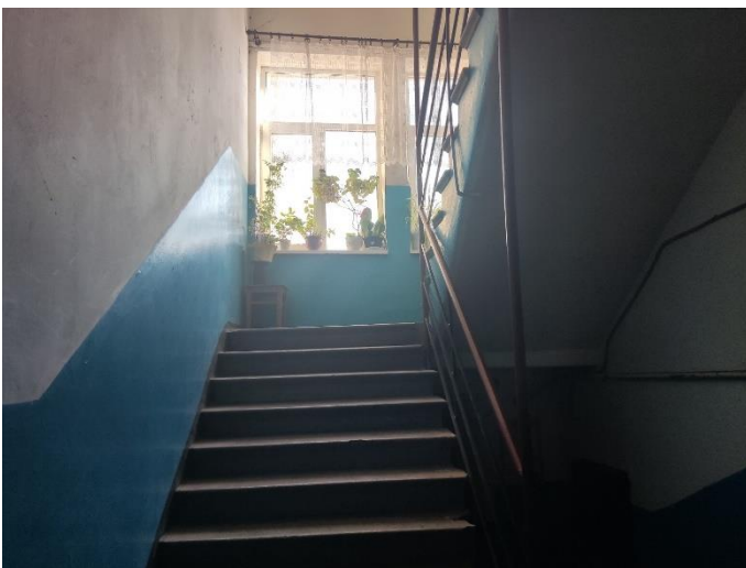
5. «Жилой дом», Ленинградская область, Выборгский район, г. Выборг, ул. Майорова д.2. Подъезд №1. Фрагмент. Фото 20.08.2022г.
