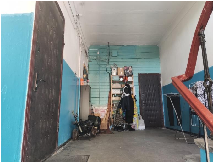
9. «Жилой дом», Ленинградская область, Выборгский район, г. Выборг, ул. Майорова д.2. Подъезд №1. Фрагмент. Фото 20.08.2022г.
