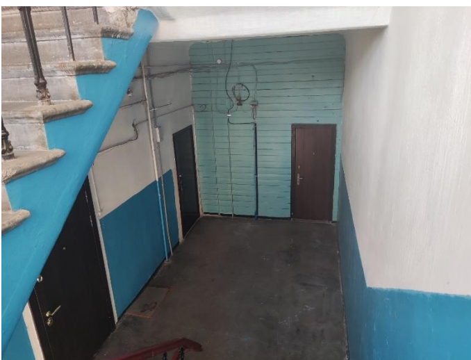
8. «Жилой дом», Ленинградская область, Выборгский район, г. Выборг, ул. Майорова д.2. Подъезд №1. Фрагмент. Фото 20.08.2022г.
