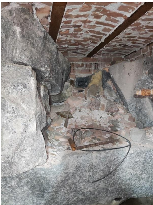
29. «Жилой дом», Ленинградская область, Выборгский район, г. Выборг, ул. Майорова д.2. Подвал. Фрагмент. Фото 20.08.2022г.
