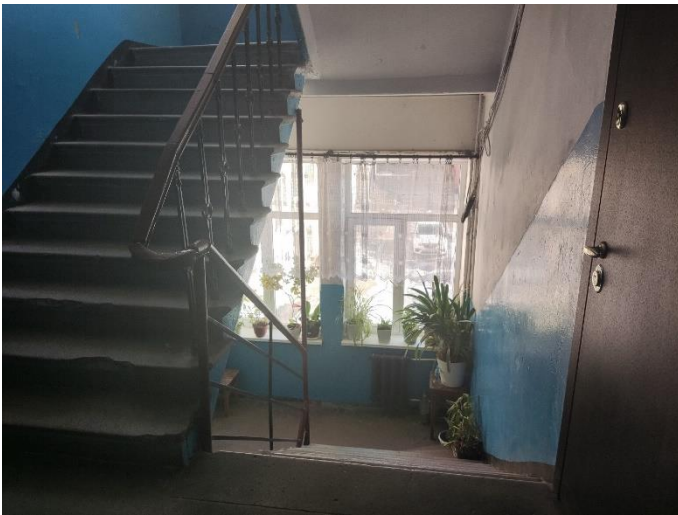
7. «Жилой дом», Ленинградская область, Выборгский район, г. Выборг, ул. Майорова д.2. Подъезд №1. Фрагмент. Фото 20.08.2022г.
