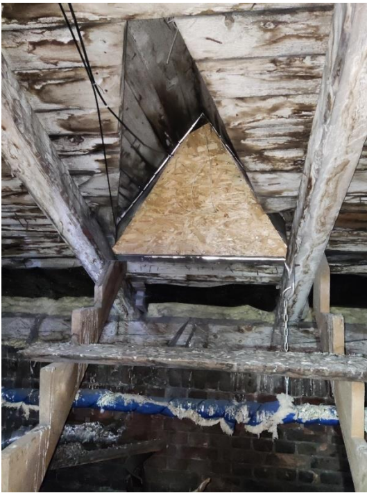
37. «Жилой дом», Ленинградская область, Выборгский район, г. Выборг, ул. Майорова д.2. Чердак. Фрагмент. Фото 20.08.2022г.
