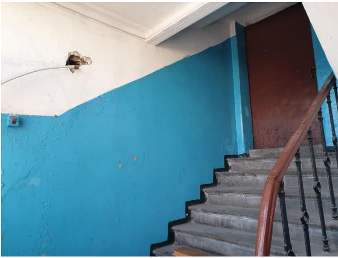
21. «Жилой дом», Ленинградская область, Выборгский район, г. Выборг, ул. Майорова д.2. Подъезд №2. Фрагмент. Фото 20.08.2022г.
