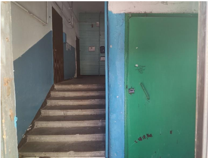
3. «Жилой дом», Ленинградская область, Выборгский район, г. Выборг, ул. Майорова д.2. Подъезд №1. Общий вид. Фото 20.08.2022г.
