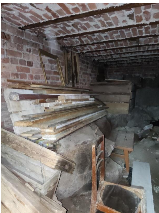
30. «Жилой дом», Ленинградская область, Выборгский район, г. Выборг, ул. Майорова д.2. Подвал. Фрагмент. Фото 20.08.2022г.
