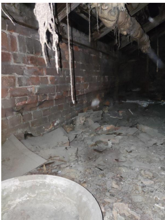
34. «Жилой дом», Ленинградская область, Выборгский район, г. Выборг, ул. Майорова д.2. Чердак. Фрагмент. Фото 20.08.2022г.
