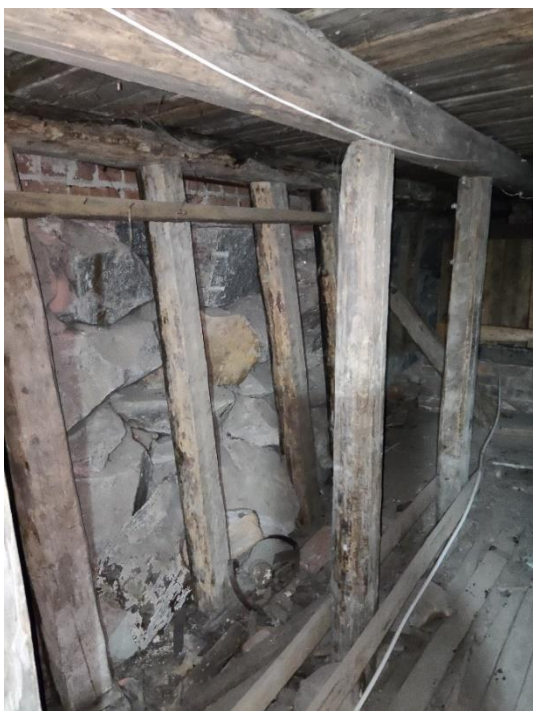
23. «Жилой дом», Ленинградская область, Выборгский район, г. Выборг, ул. Майорова д.2. Подвал. Фрагмент. Фото 20.08.2022г.
