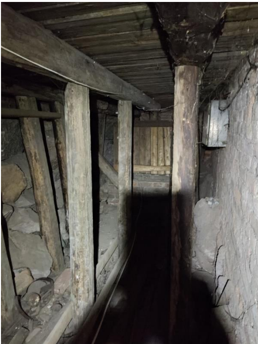
22. «Жилой дом», Ленинградская область, Выборгский район, г. Выборг, ул. Майорова д.2. Подвал. Фрагмент. Фото 20.08.2022г.
