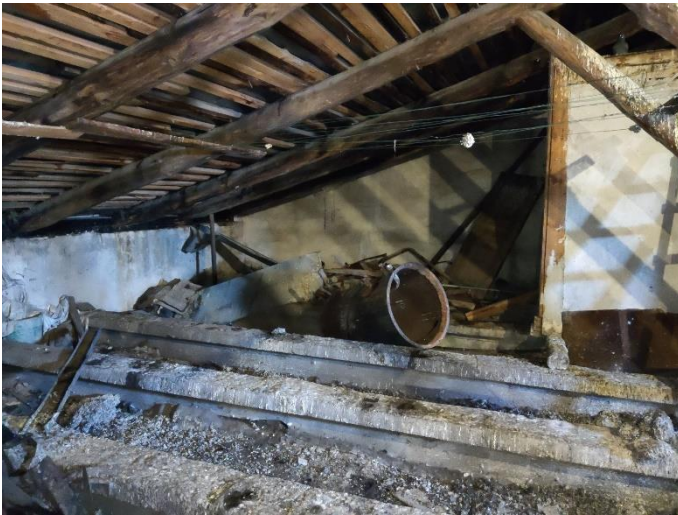
54. «Жилой дом акционерного общества Пампала», Ленинградская область, Выборгский район, г. Выборг, ул. Южный вал, д.18. Чердак. Фрагмент. Фото 20.08.2022г.
