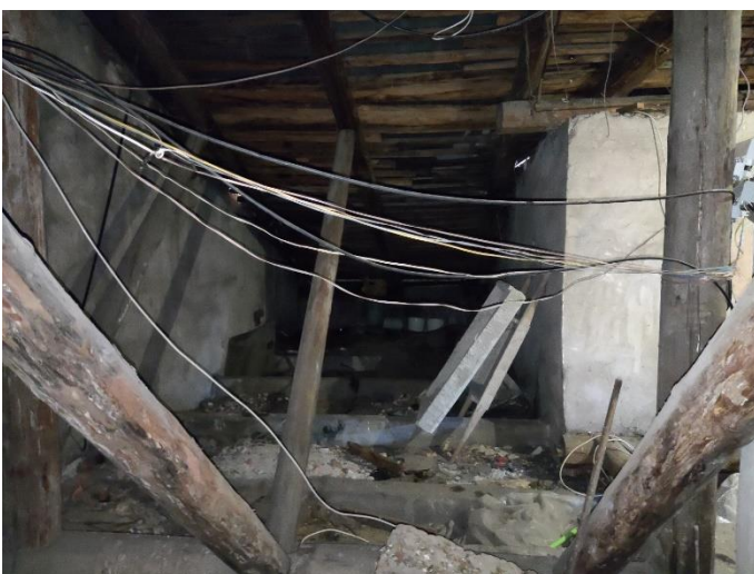
52. «Жилой дом акционерного общества Пампала», Ленинградская область, Выборгский район, г. Выборг, ул. Южный вал, д.18. Чердак. Фрагмент. Фото 20.08.2022г.
