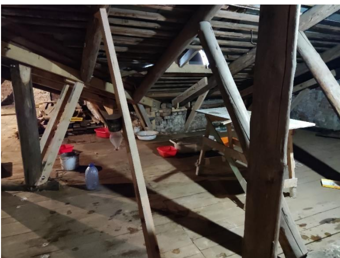
46. «Жилой дом акционерного общества Пампала», Ленинградская область, Выборгский район, г. Выборг, ул. Южный вал, д.18. Чердак. Фрагмент. Фото 20.08.2022г.
