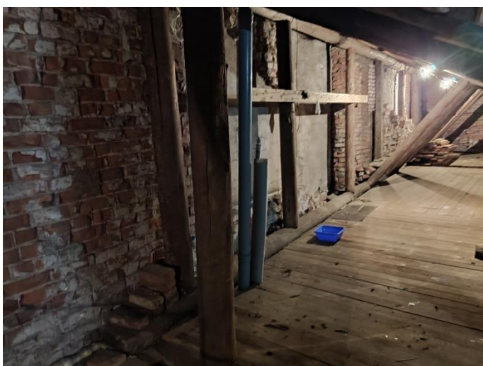
48. «Жилой дом акционерного общества Пампала», Ленинградская область, Выборгский район, г. Выборг, ул. Южный вал, д.18. Чердак. Фрагмент. Фото 20.08.2022г.
