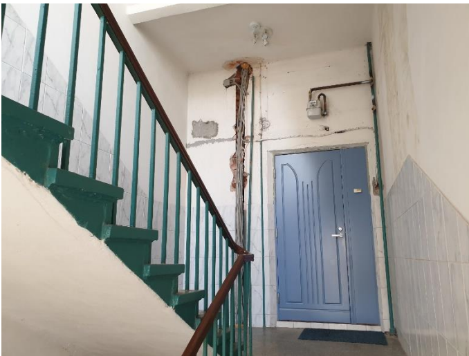
13. «Жилой дом акционерного общества Пампала», Ленинградская область, Выборгский район, г. Выборг, ул. Южный вал, д.18. Подъезд №2. Фрагмент. Фото 20.08.2022г.
