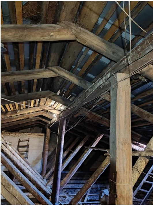
55. «Жилой дом акционерного общества Пампала», Ленинградская область, Выборгский район, г. Выборг, ул. Южный вал, д.18. Чердак. Фрагмент. Фото 20.08.2022г.
