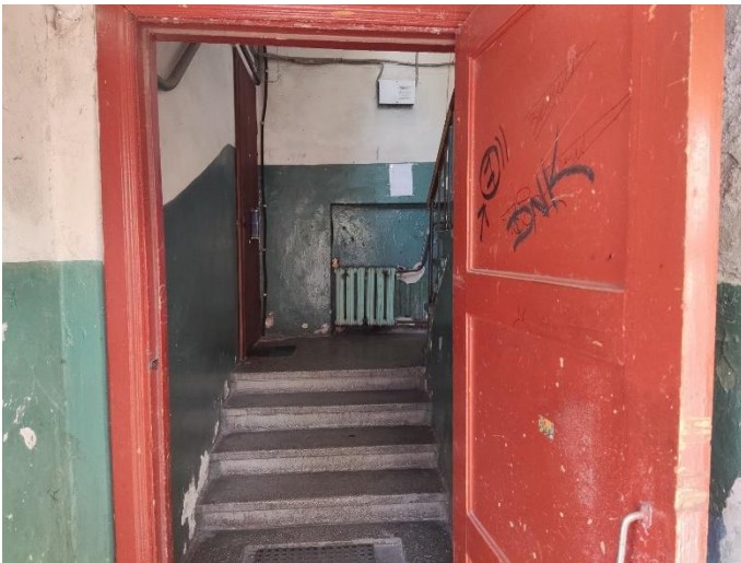
3. «Жилой дом акционерного общества Пампала», Ленинградская область, Выборгский район, г. Выборг, ул. Южный вал, д.18. Подъезд №1. Общий вид. Фото 20.08.2022г.
