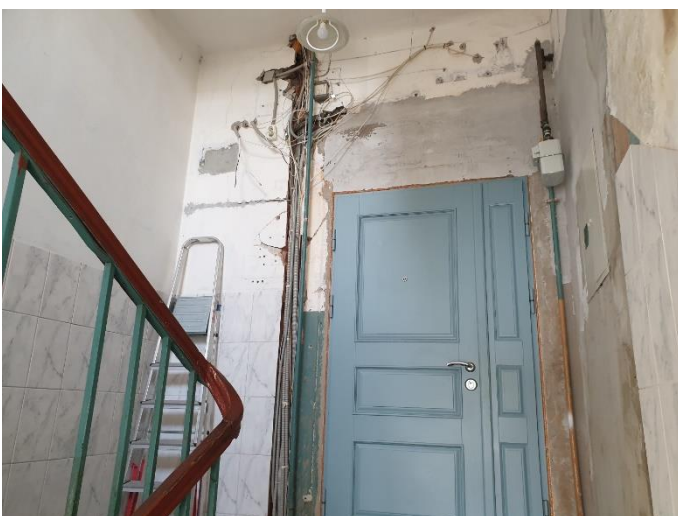
14. «Жилой дом акционерного общества Пампала», Ленинградская область, Выборгский район, г. Выборг, ул. Южный вал, д.18. Подъезд №2. Фрагмент. Фото 20.08.2022г.
