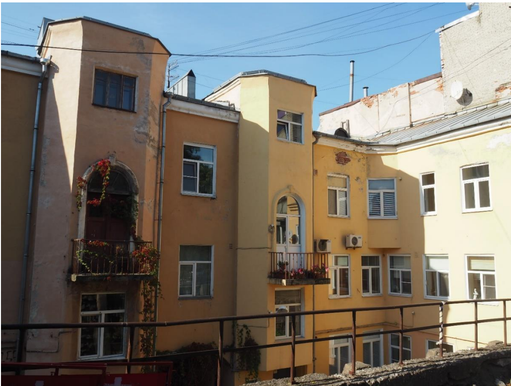
2. «Жилой дом акционерного общества Пампала», Ленинградская область, Выборгский район, г. Выборг, ул. Южный вал, д.18. Дворовый фасад. Общий вид. Фото 20.08.2022г.
