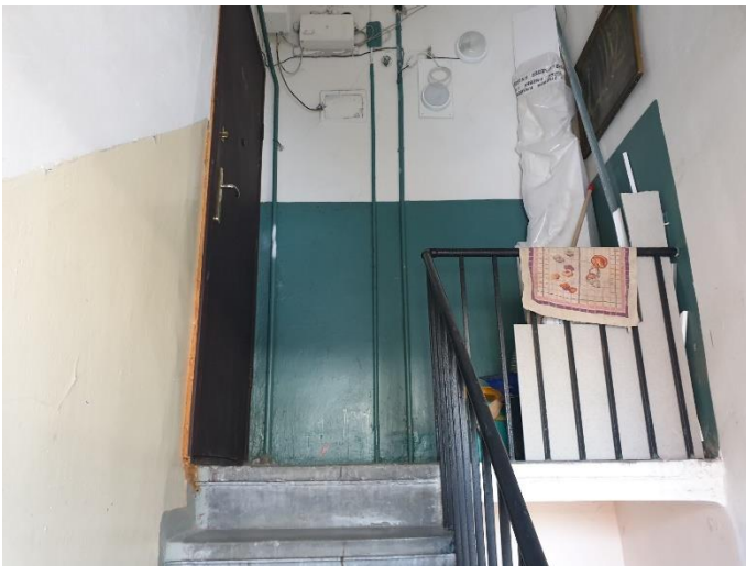
22. «Жилой дом акционерного общества Пампала», Ленинградская область, Выборгский район, г. Выборг, ул. Южный вал, д.18. Подъезд №3. Фрагмент. Фото 20.08.2022г.
