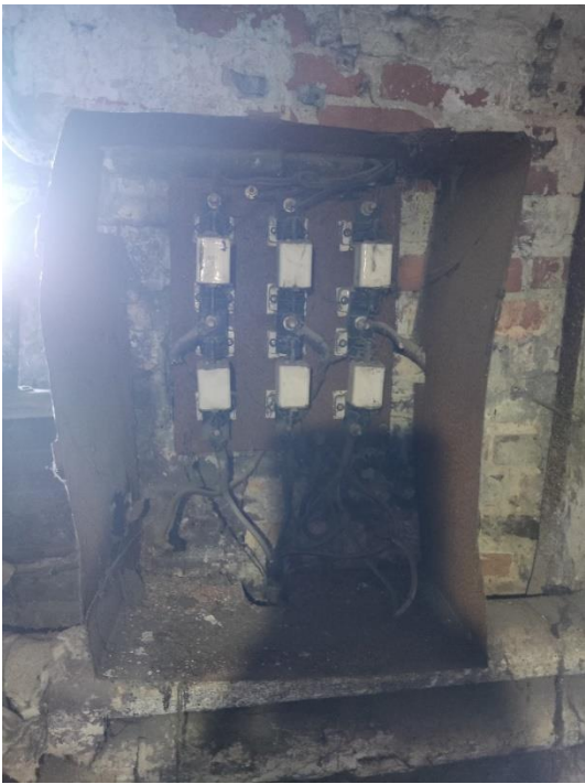
35. «Жилой дом акционерного общества Пампала», Ленинградская область, Выборгский район, г. Выборг, ул. Южный вал, д.18. Подвал. Фрагмент. Фото 20.08.2022г.
