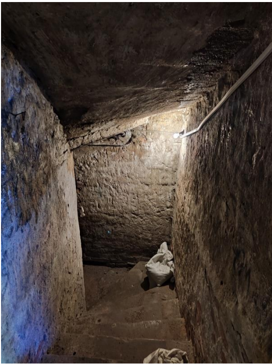
24. «Жилой дом акционерного общества Пампала», Ленинградская область, Выборгский район, г. Выборг, ул. Южный вал, д.18. Подвал. Общий вид. Фото 20.08.2022г.
