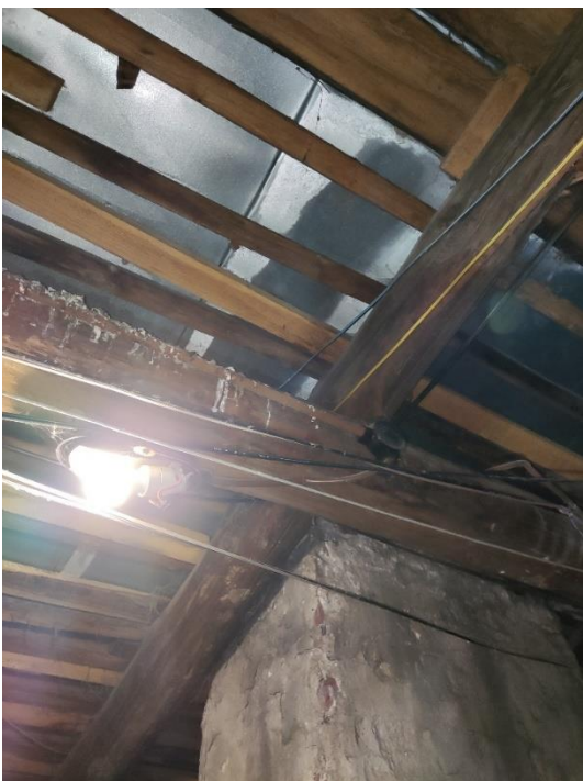
56. «Жилой дом акционерного общества Пампала», Ленинградская область, Выборгский район, г. Выборг, ул. Южный вал, д.18. Чердак. Фрагмент. Фото 20.08.2022г.
