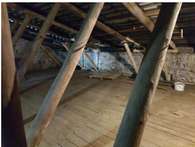
47. «Жилой дом акционерного общества Пампала», Ленинградская область, Выборгский район, г. Выборг, ул. Южный вал, д.18. Чердак. Фрагмент. Фото 20.08.2022г.
