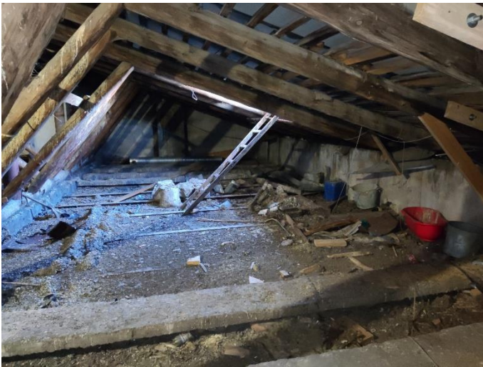
53. «Жилой дом акционерного общества Пампала», Ленинградская область, Выборгский район, г. Выборг, ул. Южный вал, д.18. Чердак. Фрагмент. Фото 20.08.2022г.
