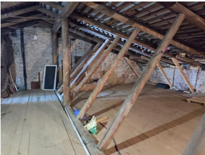
45. «Жилой дом акционерного общества Пампала», Ленинградская область, Выборгский район, г. Выборг, ул. Южный вал, д.18. Чердак. Фрагмент. Фото 20.08.2022г.
