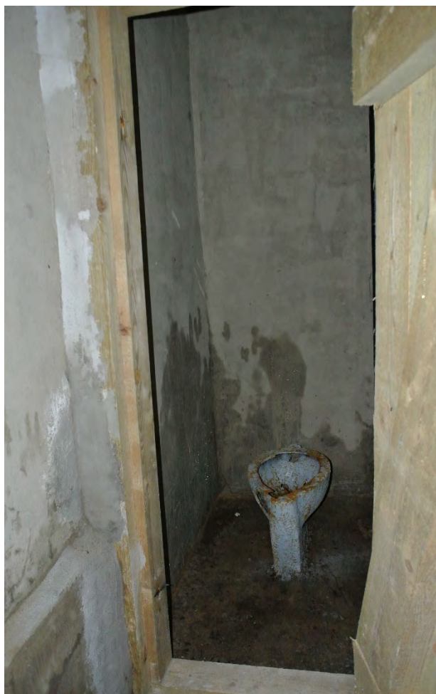
ФОТО 8. Котельная за орудийными позициями. Вид исторического с/у.
