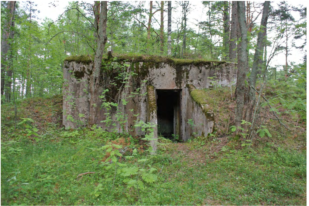
ФОТО 37. Защищенная силовая станция. Западный фасад с центральным входом.
