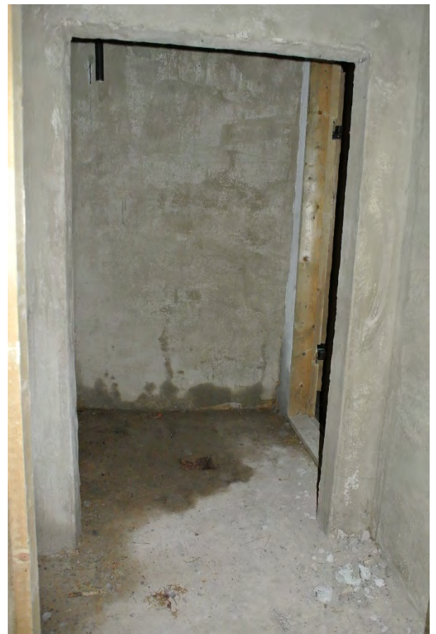
ФОТО 3. Котельная за орудийными позициями. Вид на душевую из сеней блиндажа.
