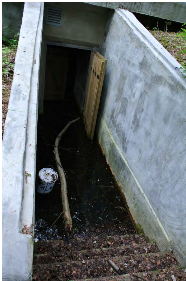
ФОТО 2. Котельная за орудийными позициями. Вид лестничного марша и входной двери.
