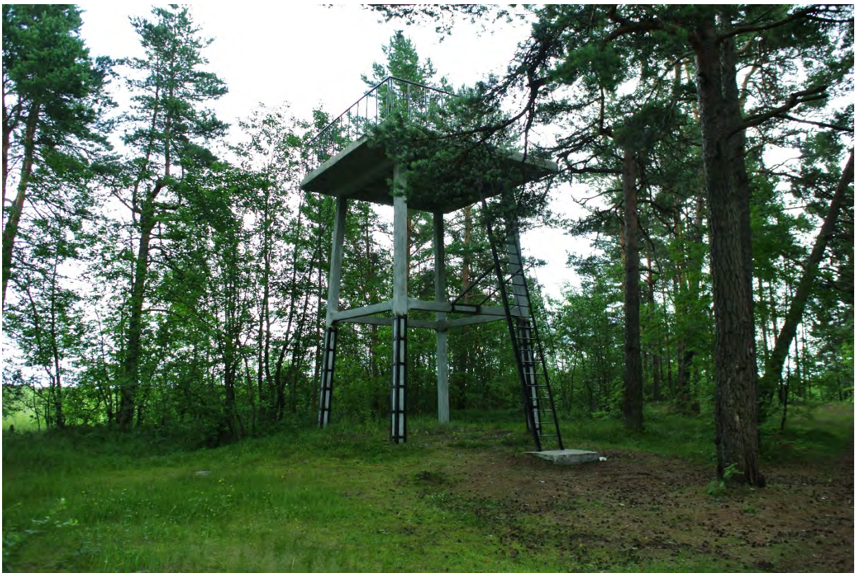
ФОТО 29. Проекторная вышка. Общий вид с северо-западной стороны.
