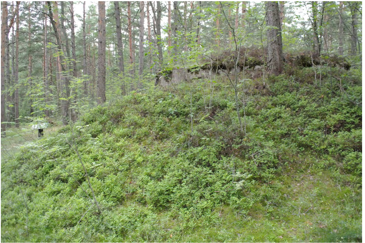
ФОТО 35. Защищенная силовая станция. Вид с южной стороны. У входа установлена информационная табличка.
