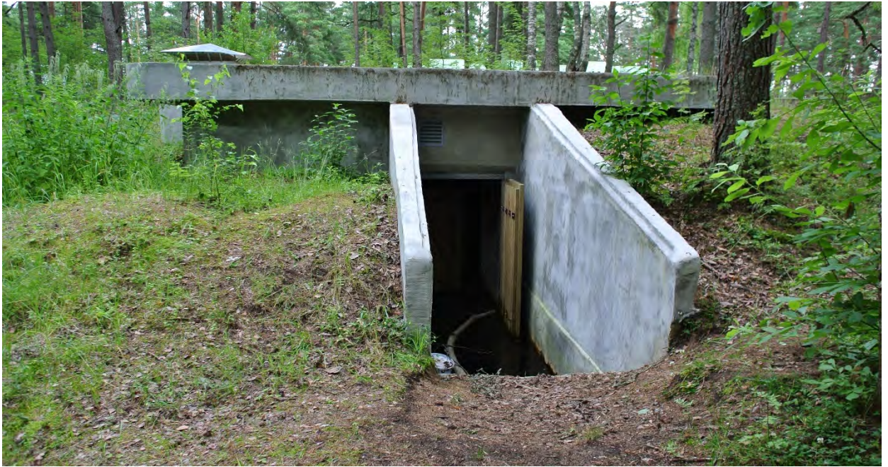
ФОТО 1. Котельная за орудийными позициями. Общий вид с западной стороны.
