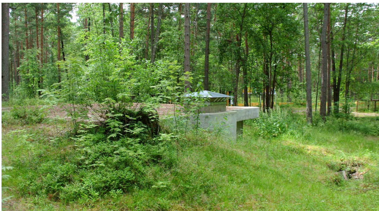
ФОТО 10. Котельная за орудийными позициями. Вид с северо-восточной стороны на сооружение и современный вентиляционный оголовок на его кровле.
