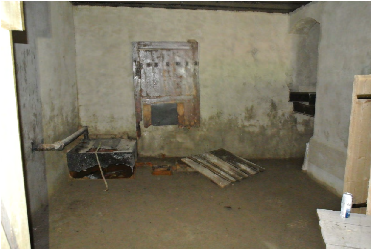
ФОТО 4. Котельная за орудийными позициями. Общий вид интерьера в восточном направлении.
