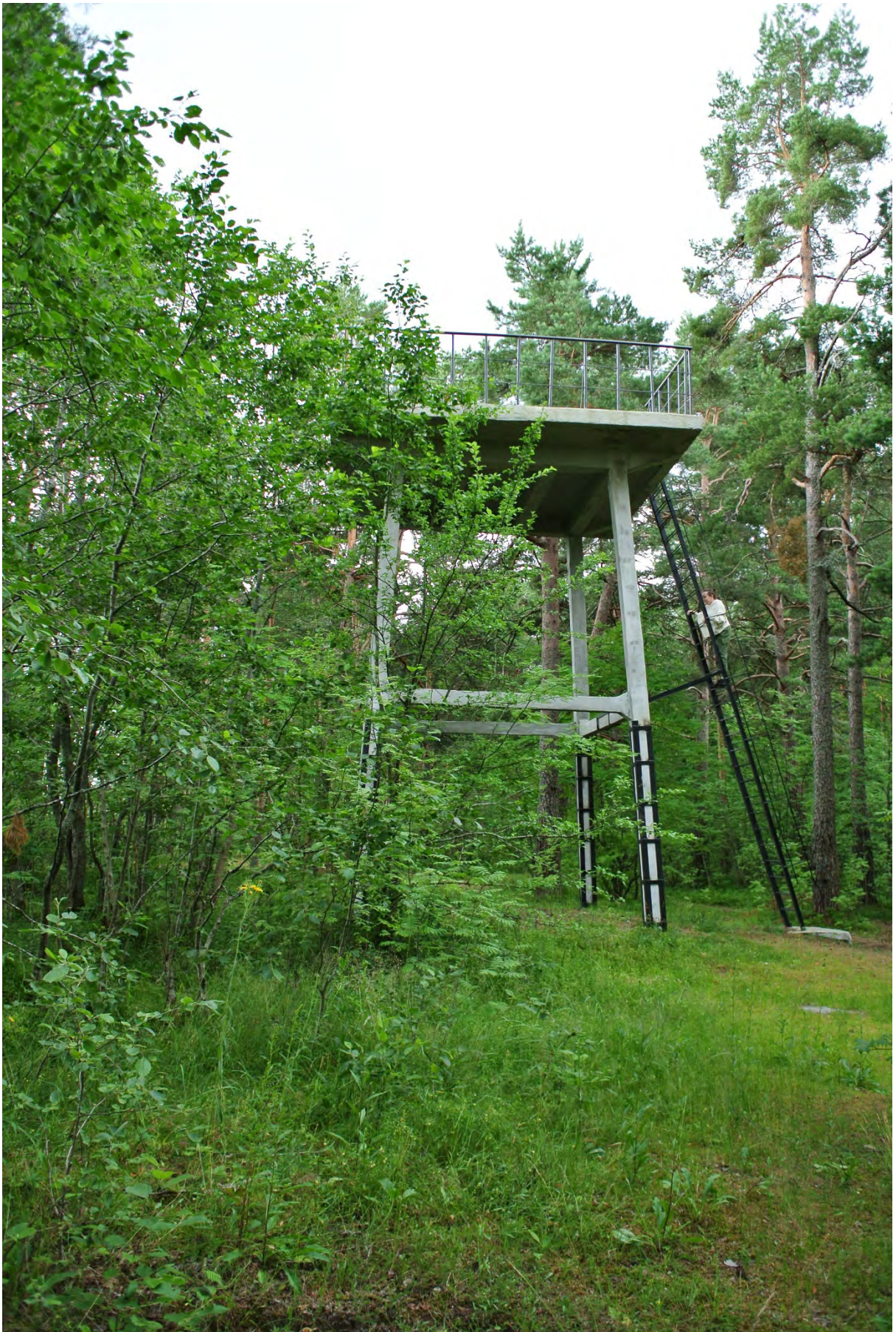
ФОТО 30. Проекторная вышка. Общий вид с северной стороны.
