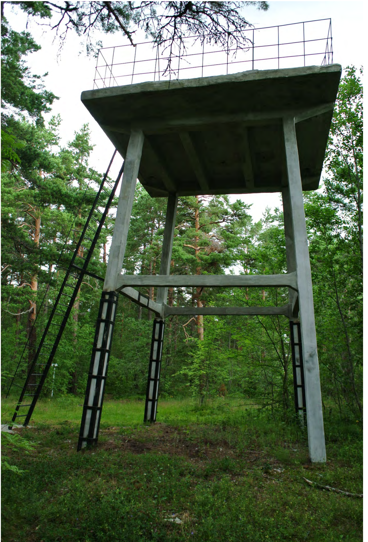
ФОТО 31. Прожекторная вышка. Общий вид с южной стороны.
