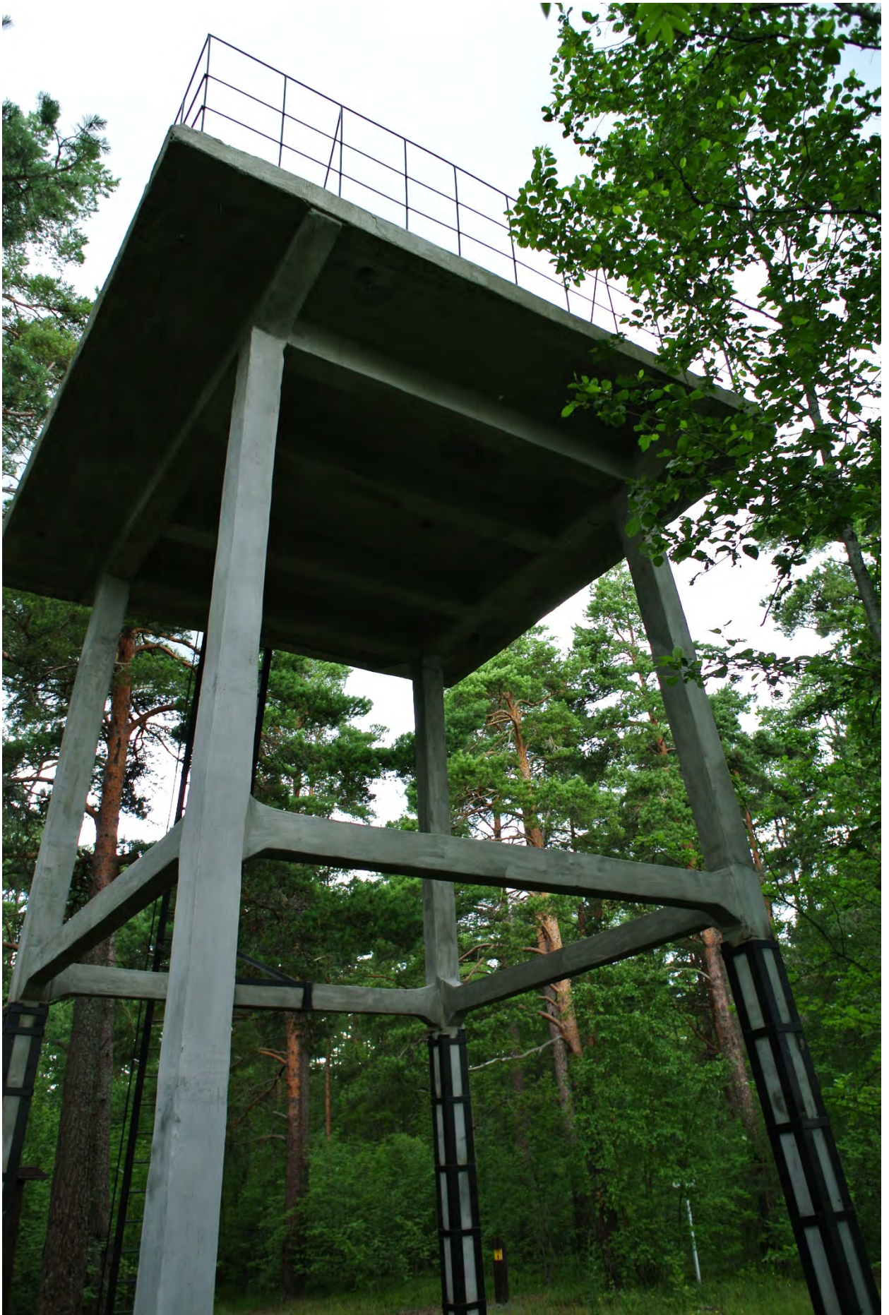
ФОТО 32. Прожекторная вышка. Вид восточного фасада вышки. Фрагмент.
