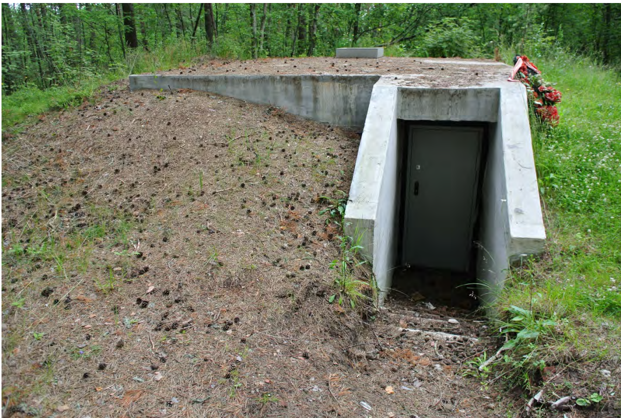
ФОТО 19. Защищенный командный пункт. Вход с западной стороны.
