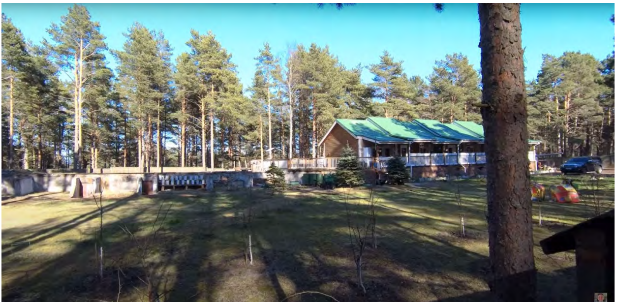
ФОТО 14. Артиллерийская батарея. Бывшие орудийные дворики, а также надстройка капитальных зданий на сооружениях батареи. Вид с запада.
