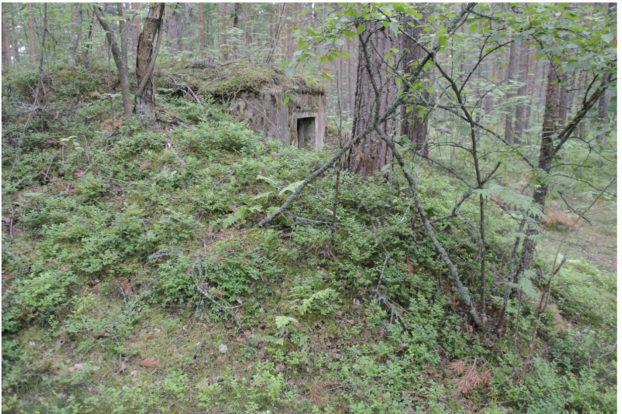
ФОТО 44. Защищенный топливный склад. Вид с северо-западной стороны.
