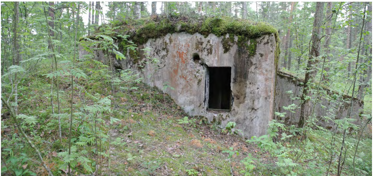
ФОТО 38. Защищенная силовая станция. Вид с севера.
