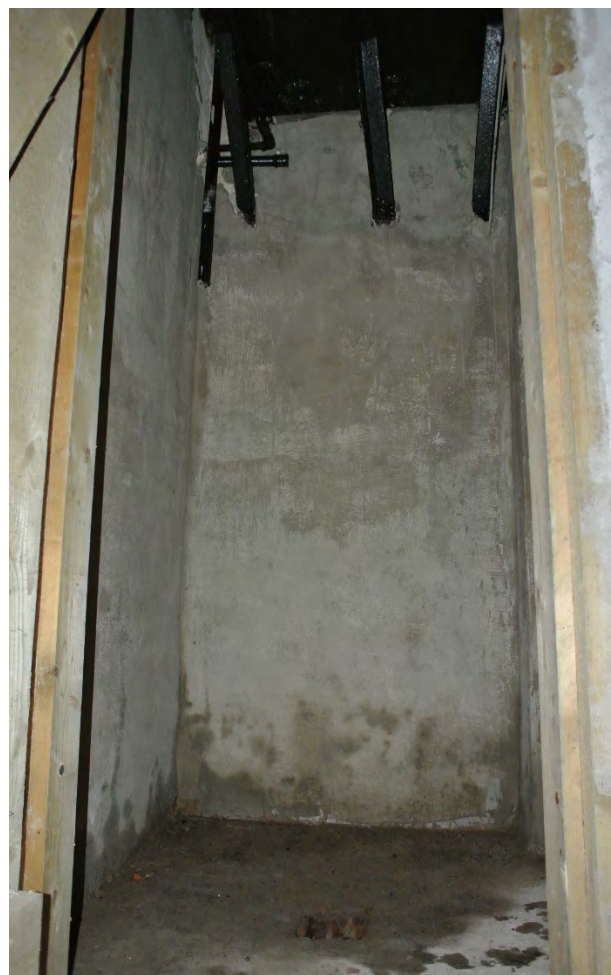
ФОТО 9. Котельная за орудийными позициями. Помещение душевой. Вид из основного объема в западном направлении.
