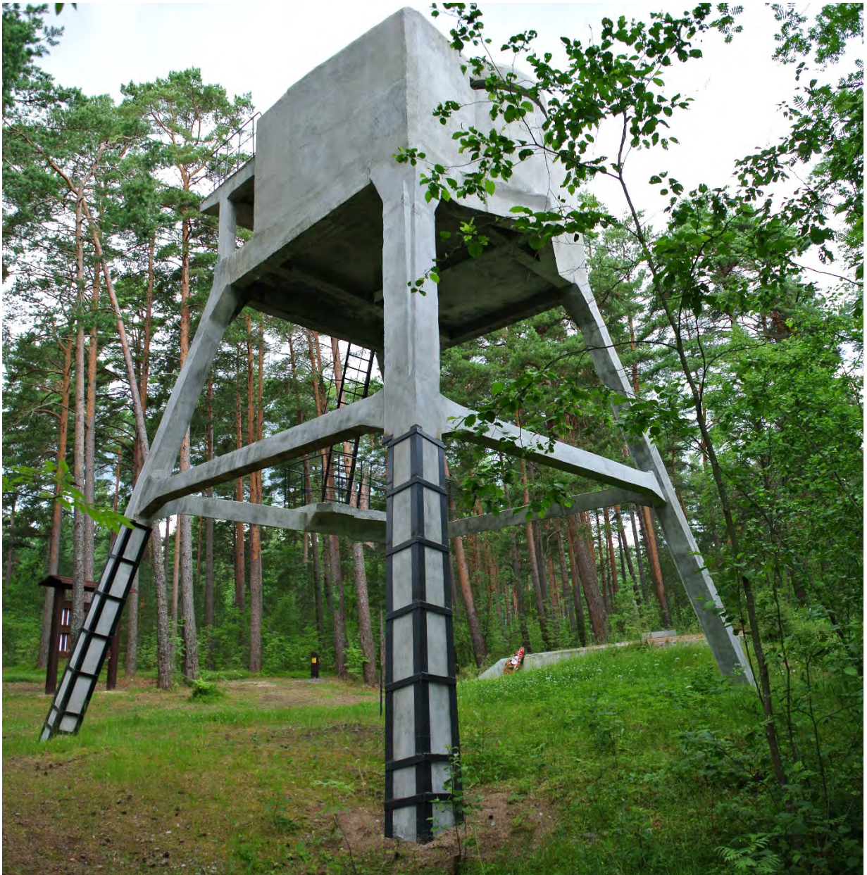
ФОТО 23. Командно-дальномерный пункт. Общий вид с юго-восточной стороны.
