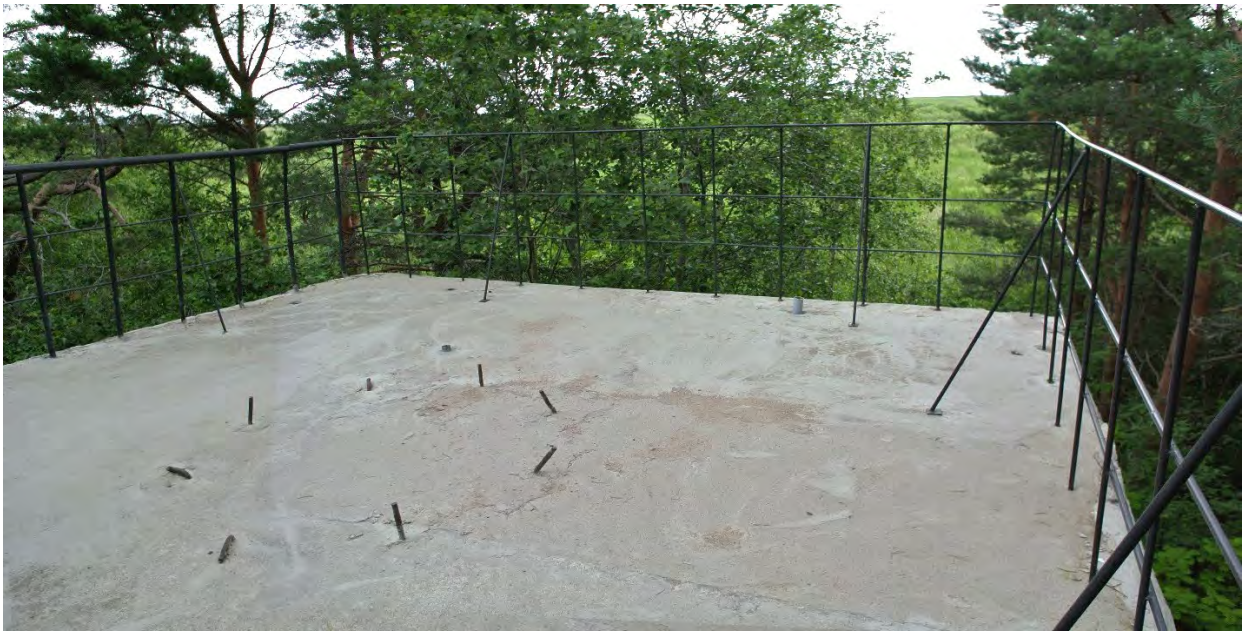
ФОТО 33. Проекторная вышка. Вид верхней площадки, закладных для крепления прожектора. Вид в сторону Ладожского озера.
