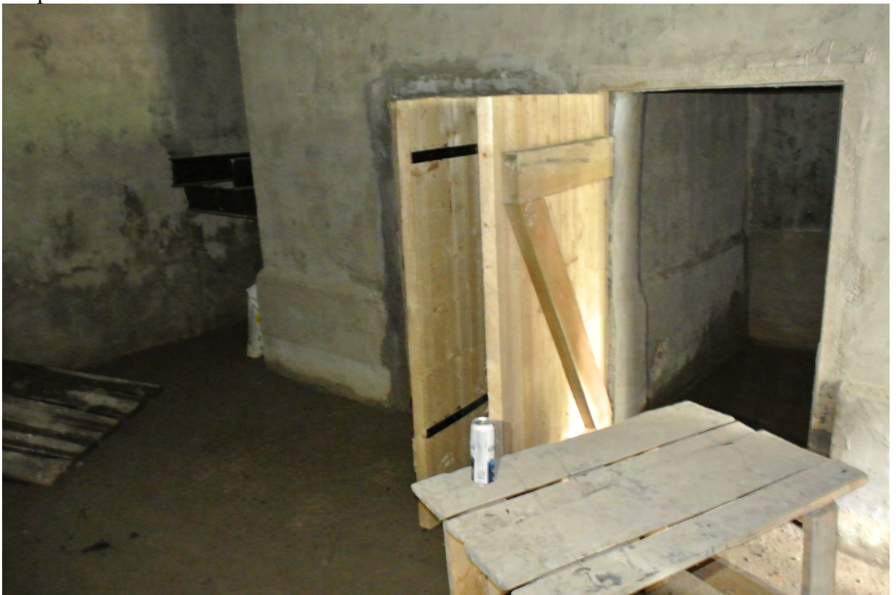
ФОТО 5. Котельная за орудийными позициями. Интерьер. Вид в юго-восточном направлении на помещение с/у и склада.
