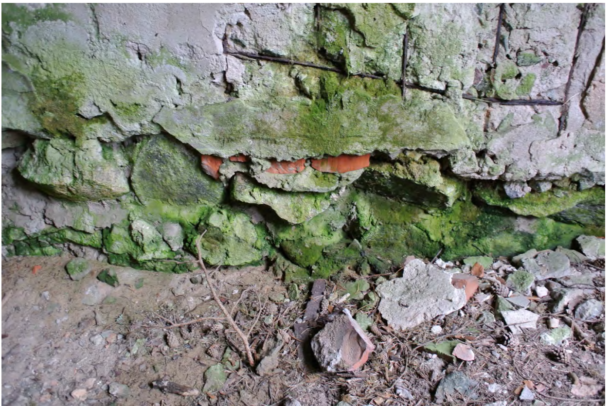
ФОТО 48. Защищенный топливный склад. Бутовая кладка фундамента и цоколя сооружения.
