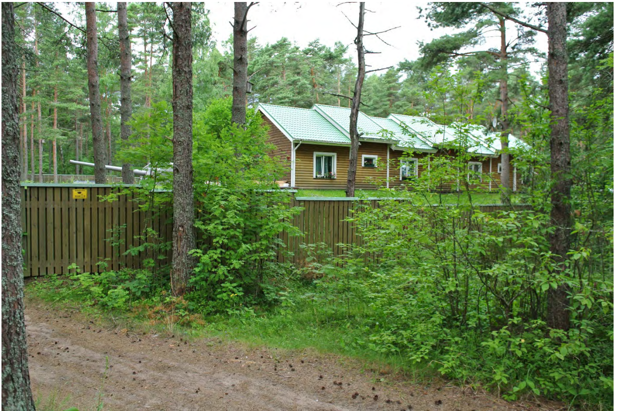
ФОТО 13. Артиллерийская батарея. Надстройка капитальных зданий на сооружениях батареи, ограждение частной территории. Вид с восточной стороны.
