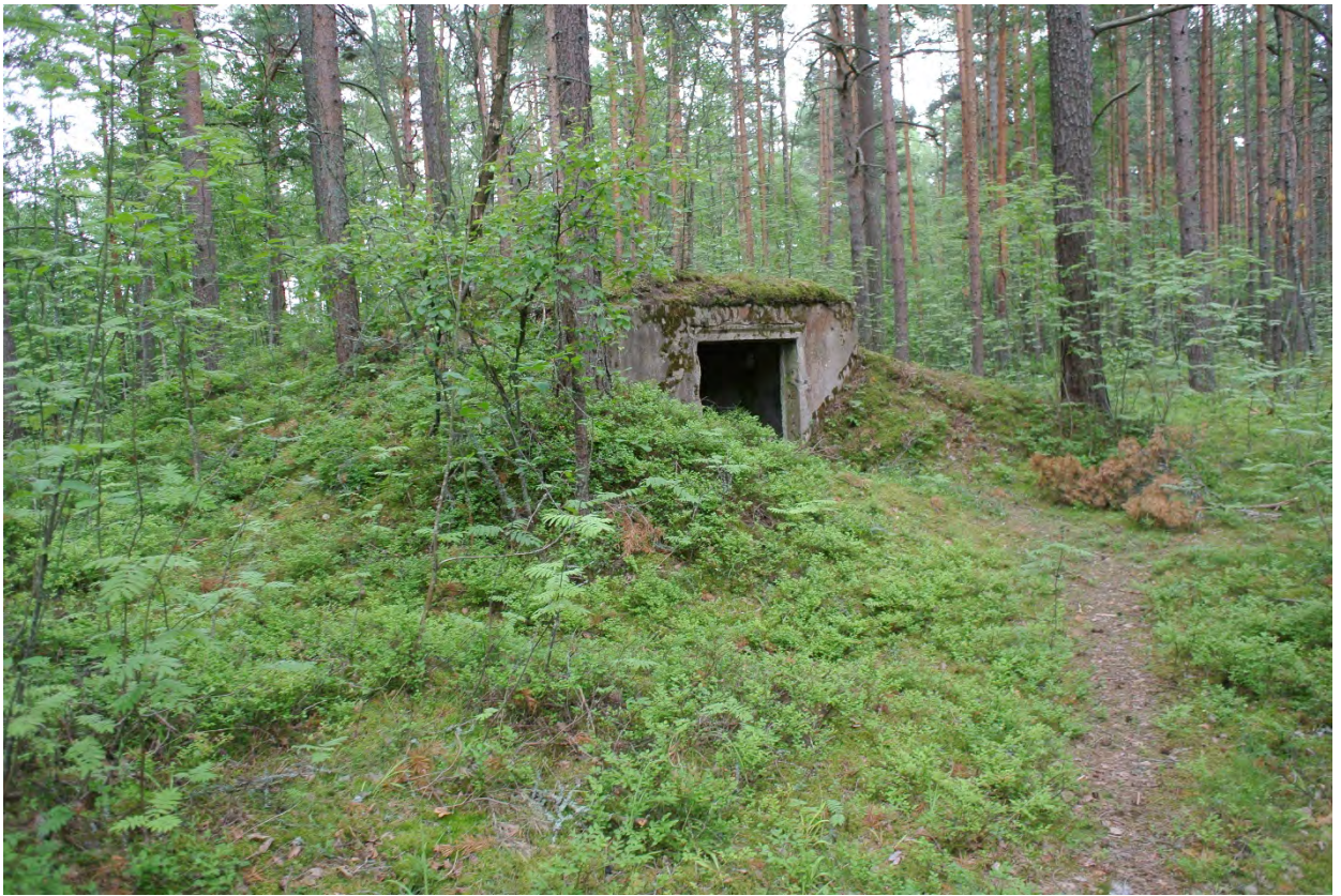
ФОТО 45. Защищенный топливный склад. Вид западного фасада с центральным входом.
