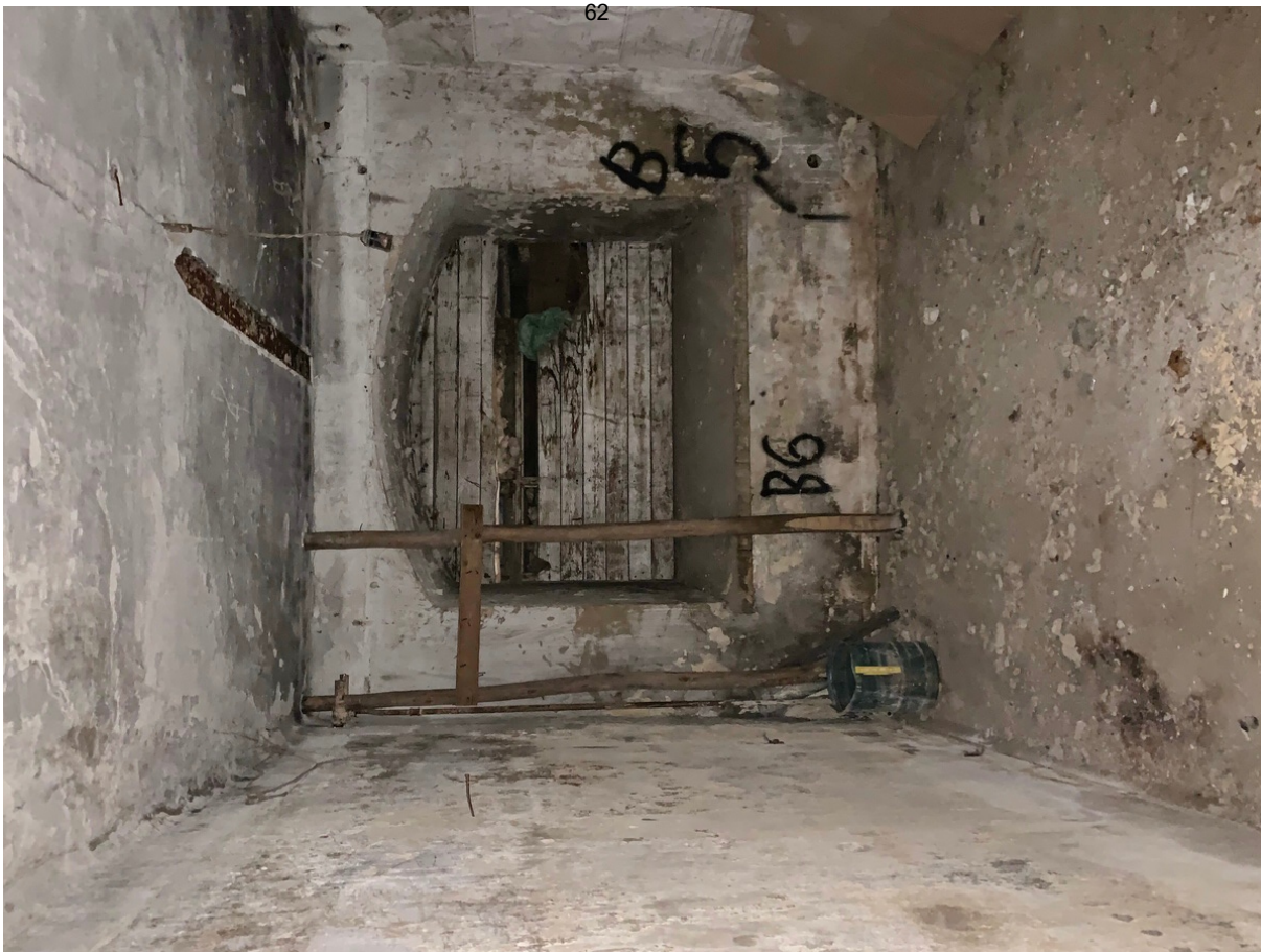
17 ОКН регионального значения “Жилой дом со службами К. Клоуберга” Ленинградская область, Выборгский муниципальный район, г. Выборг, ул. Сторожевой башни, д. 18. Подвал № 1. Помещение 4. Дата съемки: 01.05.2022 г
