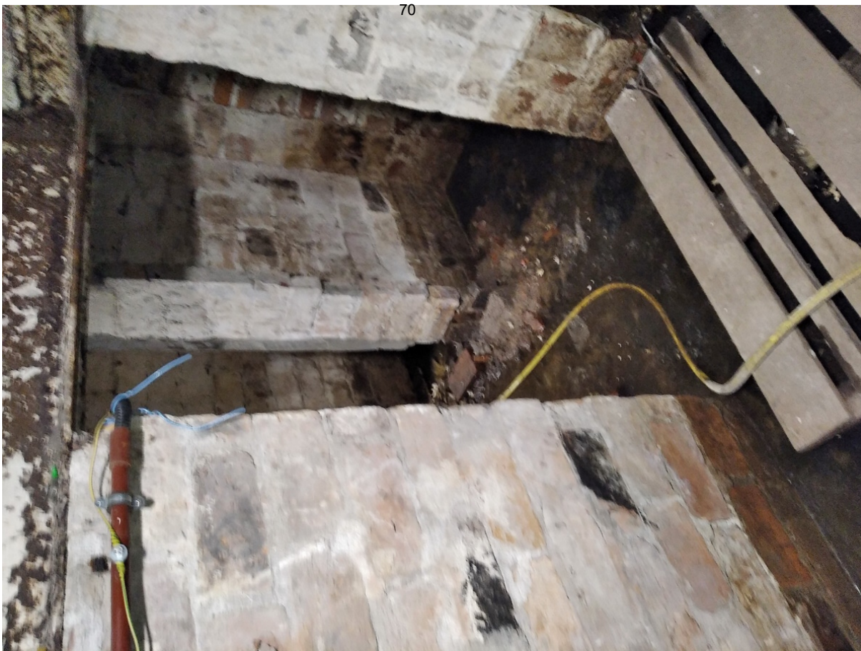
33 ОКН регионального значения “Жилой дом со службами К. Клоуберга” Ленинградская область, Выборгский муниципальный район, г. Выборг, ул. Сторожевой башни, д. 18. Подвал № 3. Помещение 1. Дата съемки: 01.05.2022 г
