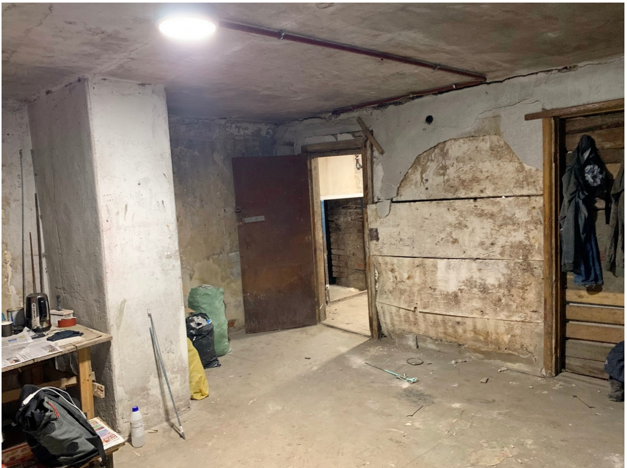
16 ОКН регионального значения “Жилой дом со службами К. Клоуберга” Ленинградская область, Выборгский муниципальный район, г. Выборг, ул. Сторожевой башни, д. 18. Подвал № 1. Помещение 3. Дата съемки: 02.05.2022 г.
