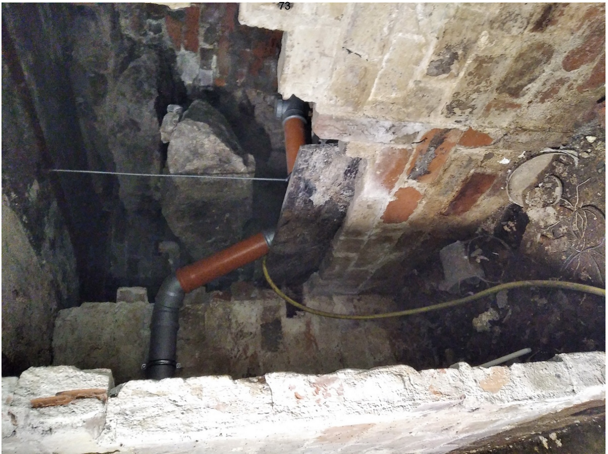
39 ОКН регионального значения “Жилой дом со службами К. Клоуберга” Ленинградская область, Выборгский муниципальный район, г. Выборг, ул. Сторожевой башни, д. 18. Подвал № 3. Вид из помещения 1 на помещение 11. Дата съемки: 01.05.2022 г
