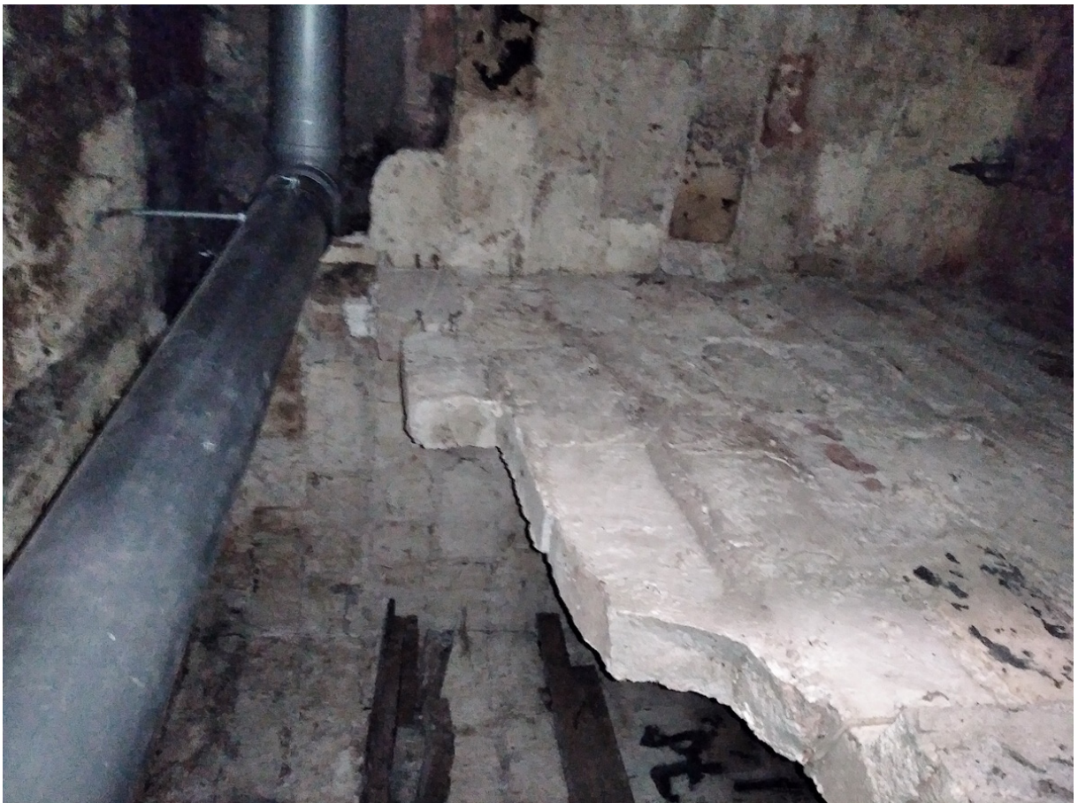
40 ОКН регионального значения “Жилой дом со службами К. Клоуберга” Ленинградская область, Выборгский муниципальный район, г. Выборг, ул. Сторожевой башни, д. 18. Подвал № 3. Вид из помещения 1 на помещения 7 и 8. Дата съемки: 01.05.2022 г
