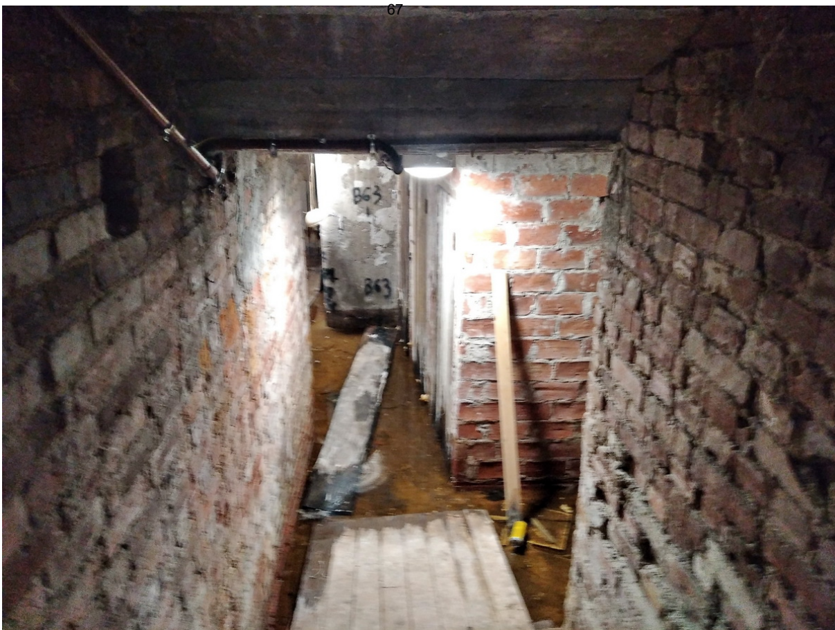
27 ОКН регионального значения “Жилой дом со службами К. Клоуберга” Ленинградская область, Выборгский муниципальный район, г. Выборг, ул. Сторожевой башни, д. 18. Подвал № 2. Помещение 1. Дата съемки: 01.05.2022 г
