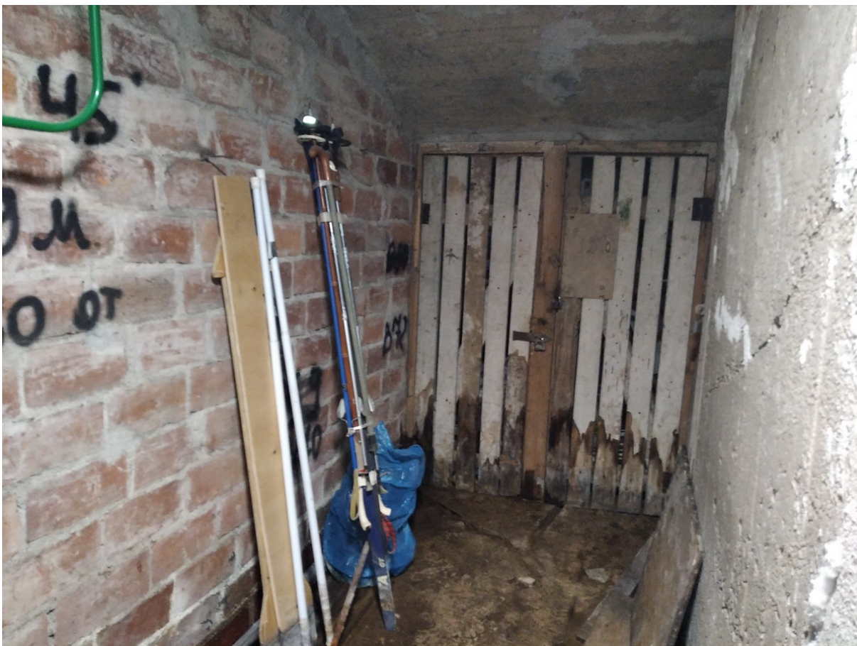
30 ОКН регионального значения “Жилой дом со службами К. Клоуберга” Ленинградская область, Выборгский муниципальный район, г. Выборг, ул. Сторожевой башни, д. 18. Подвал № 2. Помещение 2. Дата съемки: 02.05.2022 г.
