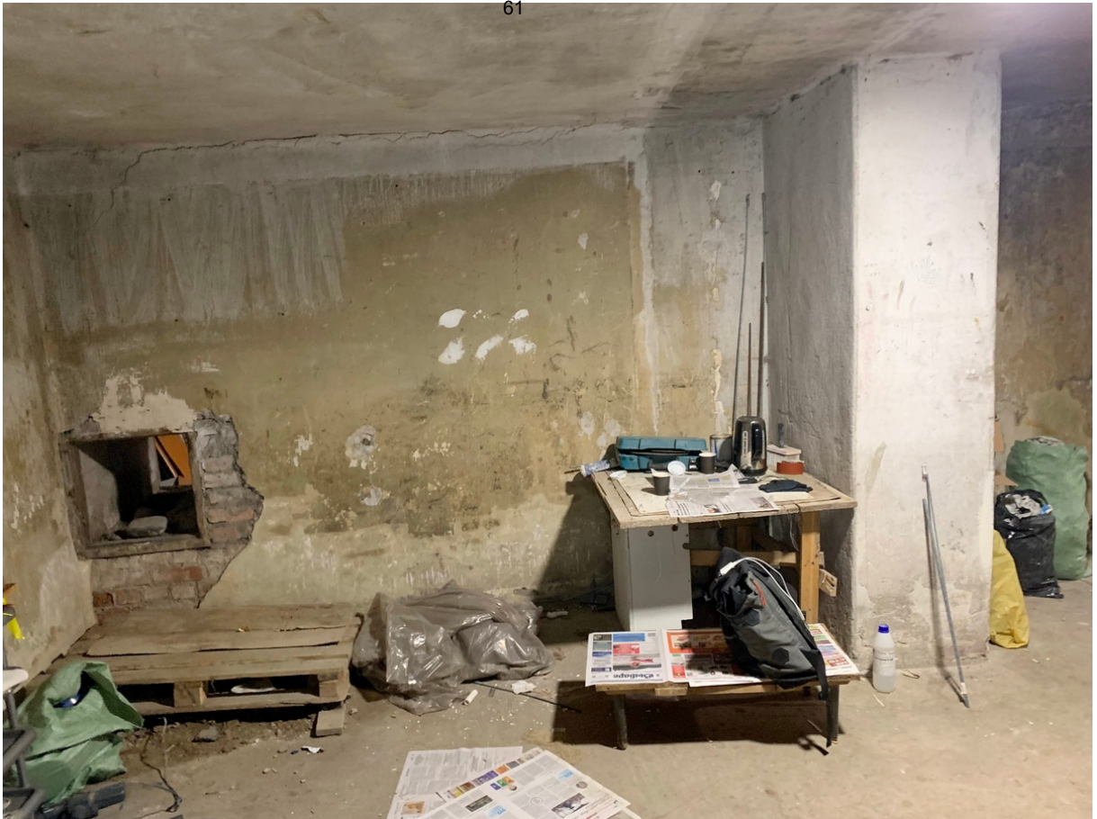
15 ОКН регионального значения “Жилой дом со службами К. Клоуберга” Ленинградская область, Выборгский муниципальный район, г. Выборг, ул. Сторожевой башни, д. 18. Подвал № 1. Помещение 3. Дата съемки: 01.05.2022 г
