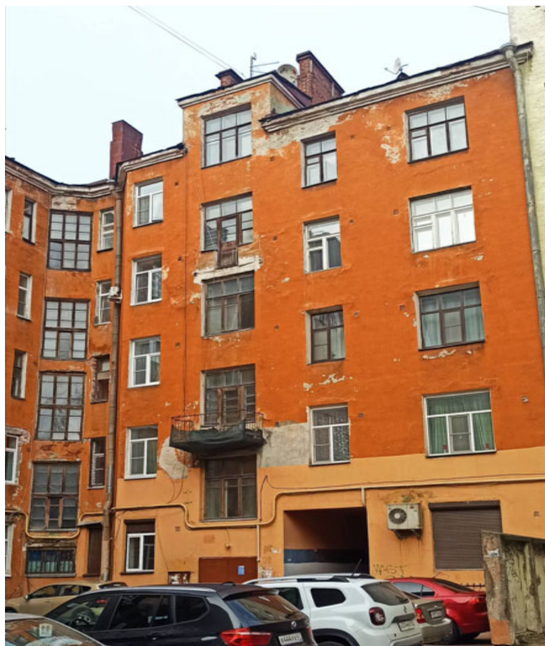
Фото 5. Фрагмент дворового фасада. Правое крыло (фото выполнено 15.09.2022 г.)
