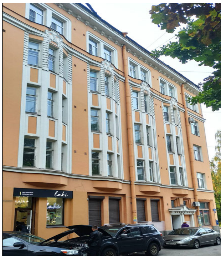
Фото 2. Фасад Объекта со стороны бульвара им. М.И. Кутузова (фото выполнено 15.09.2022 г.)
