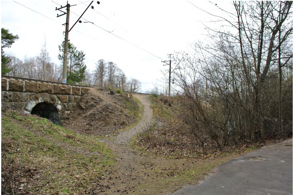
ФОТО 3. Вид в юго-восточном направлении на насыпь железнодорожного полотна. Дата съемки: 04.05.2022 г.
