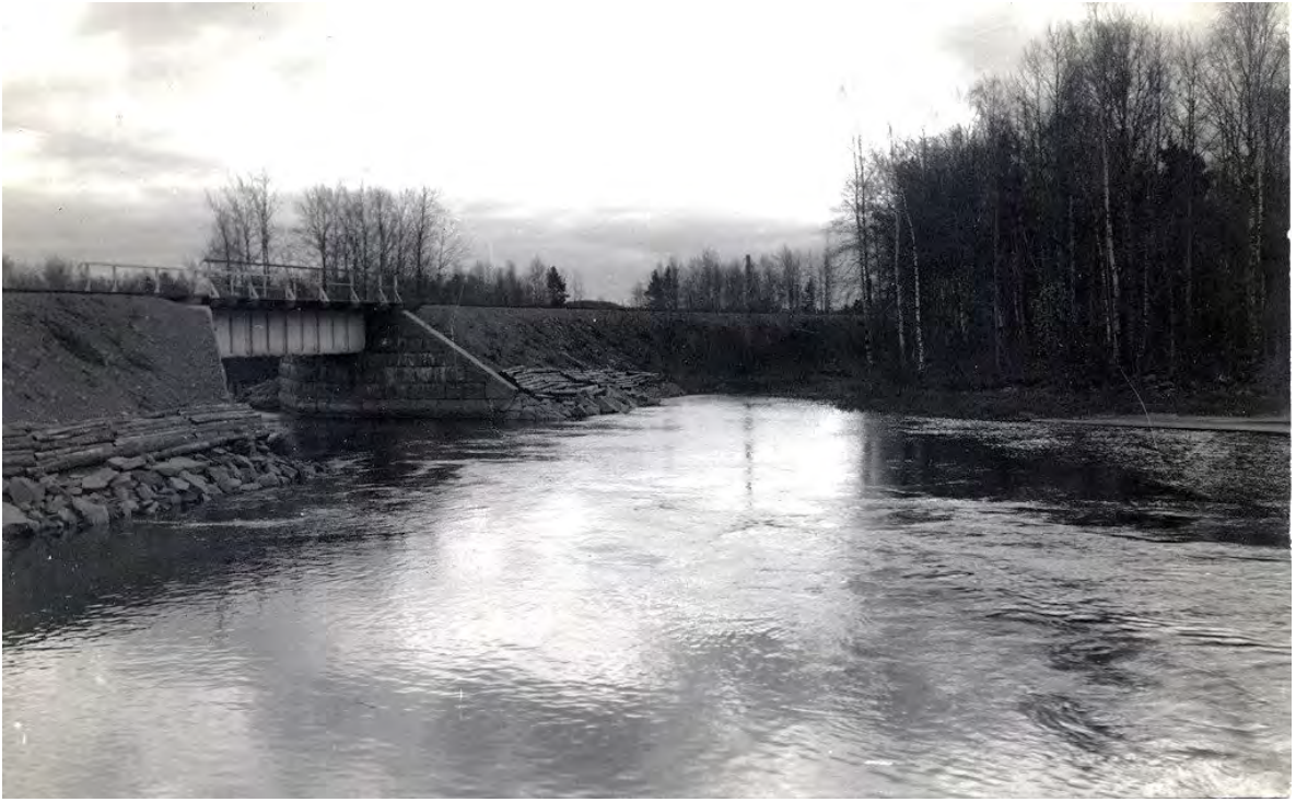
Илл.65. Остров Каллиосаари. Железнодорожный мост. Фото. 1930-е гг.
