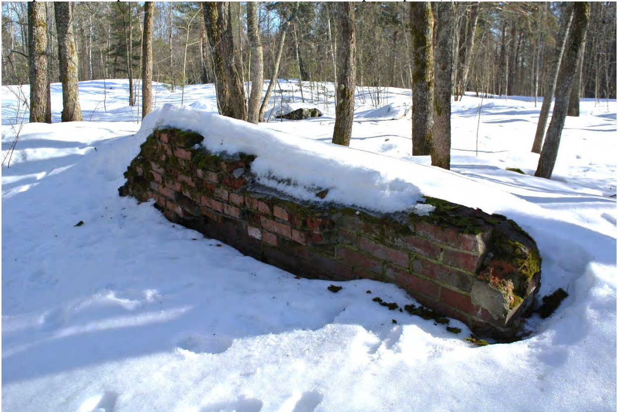
ФОТО 66. Вид в восточном направлении на руины северной стены здания кафе советской постройки в северной части скального выхода в центре острова. Дата съемки: 03.02.2022 г.
