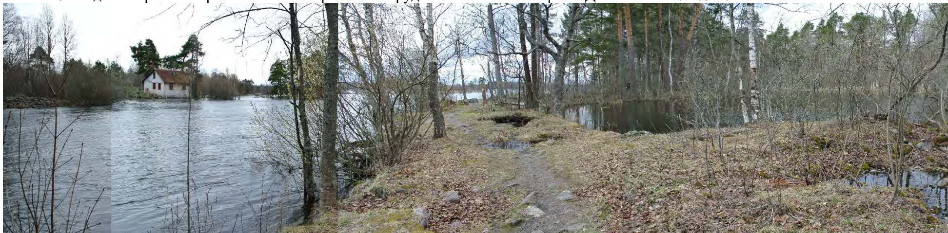
ФОТО 50. Вид в западном направлении на дорожку-дамбу, западную часть пруда (справа), южный рукав р. Вуоксы и Дачный Посёлок (слева). Дата съемки: 04.05.2022 г.
