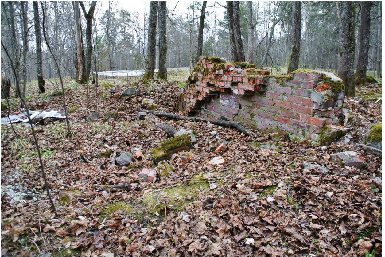
ФОТО 66. Вид в восточном направлении на руины северной стены здания кафе советской постройки в северной части скального выхода в центре острова. Дата съемки: 04.05.2022 г.
