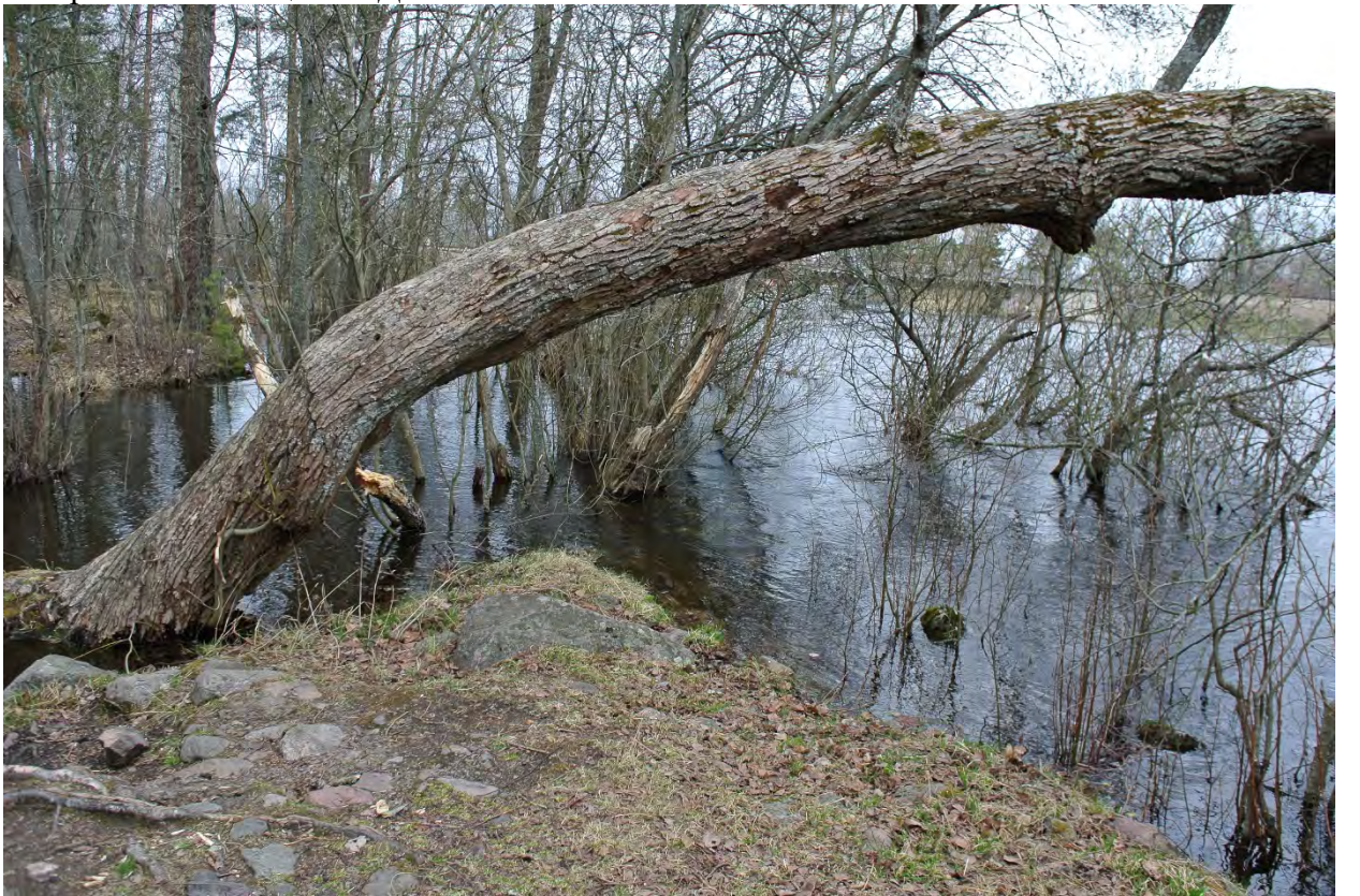
ФОТО 48. Вид в восточном направлении на место прорыва дорожки-дамбы и железнодорожный мост. Дата съемки: 04.05.2022 г.
