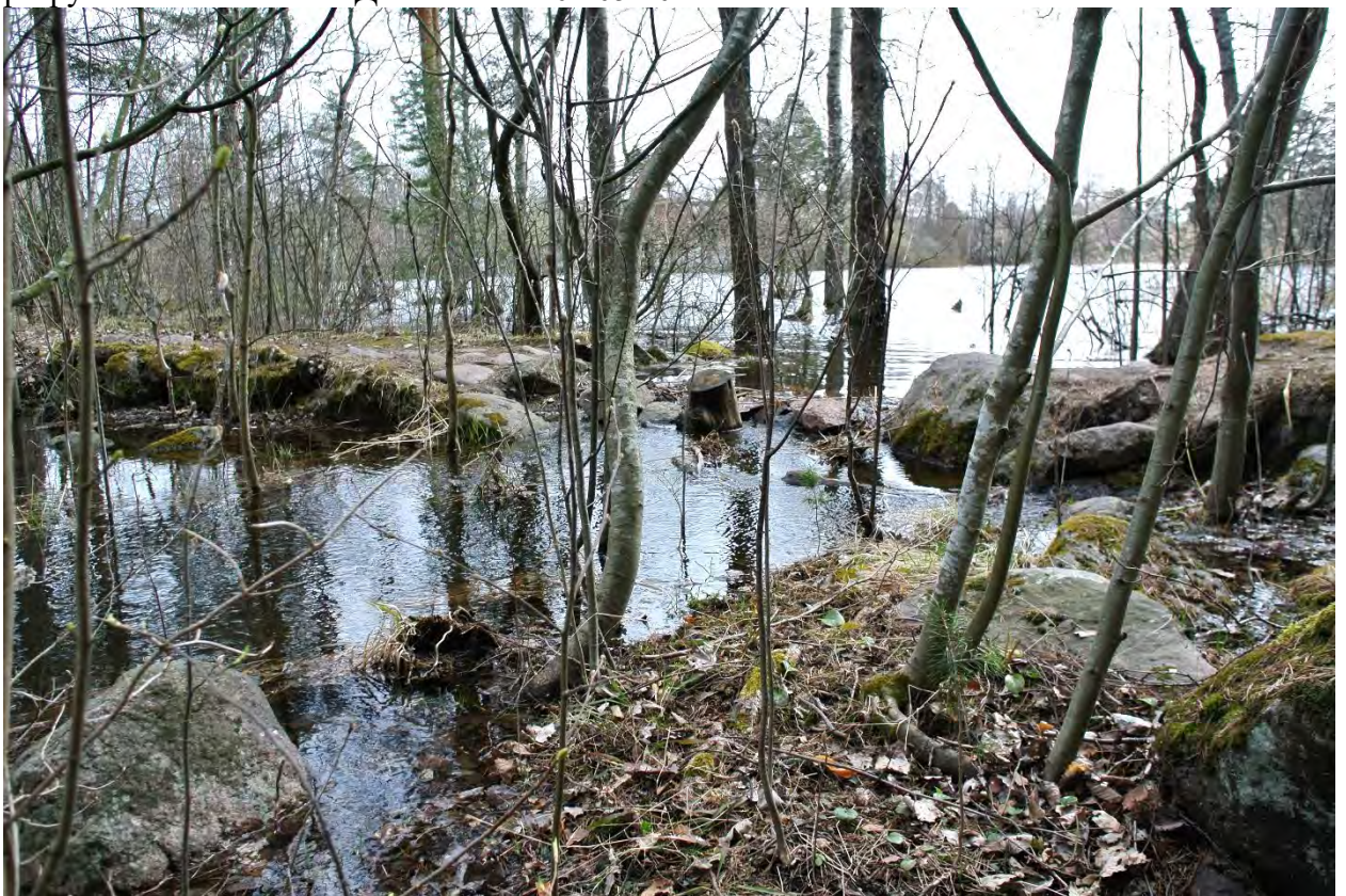
ФОТО 44. Вид в южном направлении на место утраченного мостика на дорожке-дамбе. Дата съемки: 04.05.2022 г.
