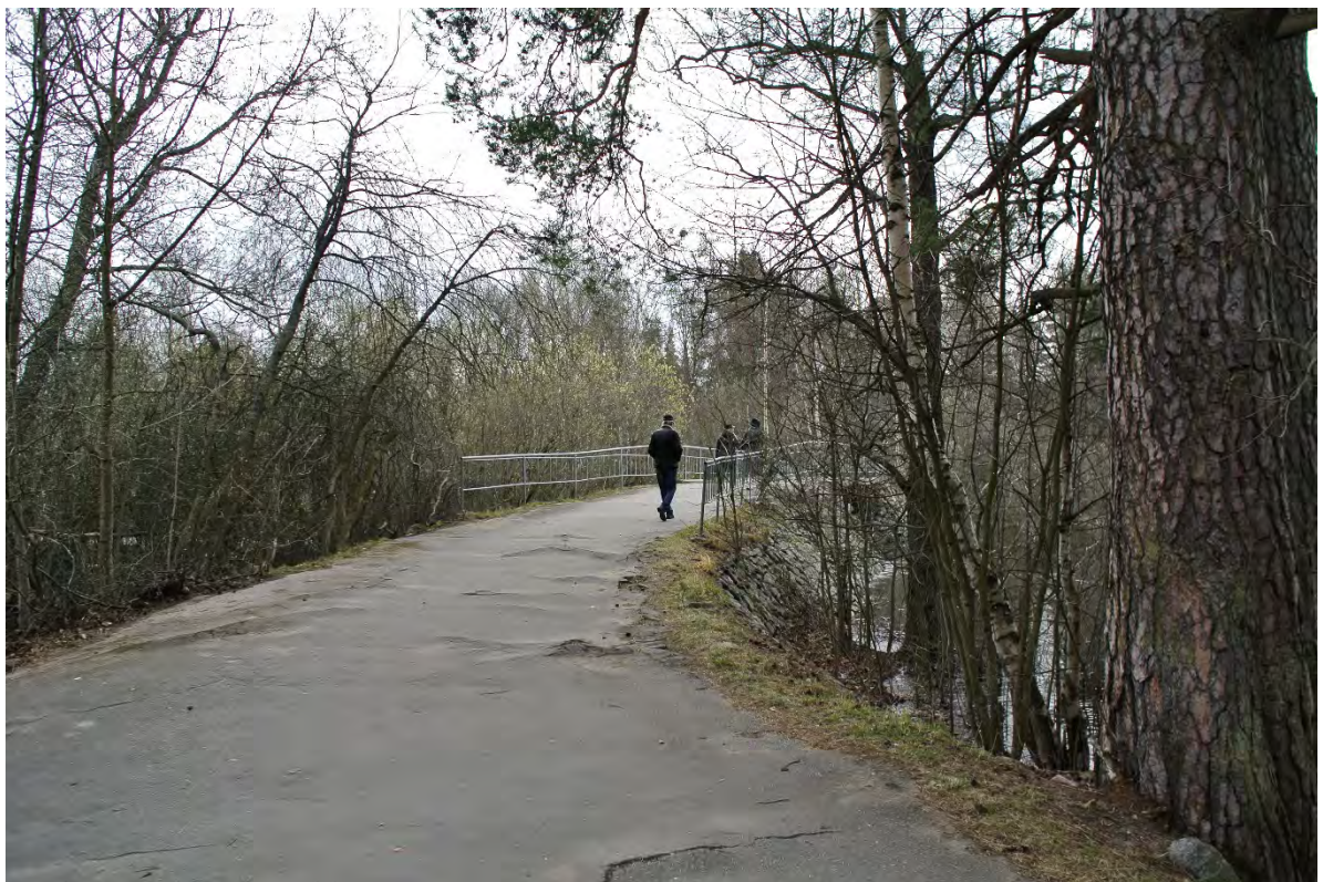
ФОТО 4. Вид в южном направлении на пешеходный мост на остров Скалистый. Дата съемки: 04.05.2022 г.
