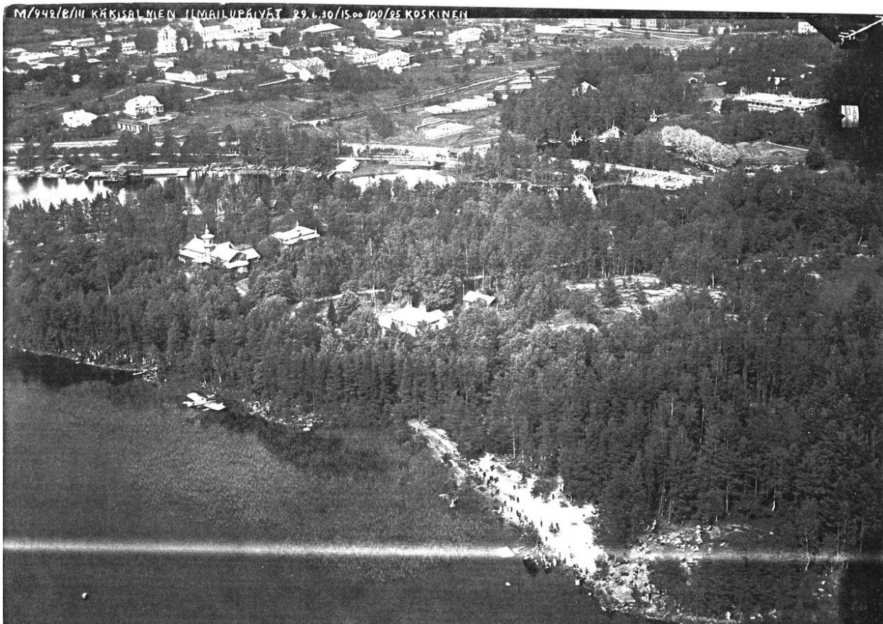
Илл.61. Кексгольмский курорт. Вид на Каллиосаари и постройки на острове. Фото 1930 г.
