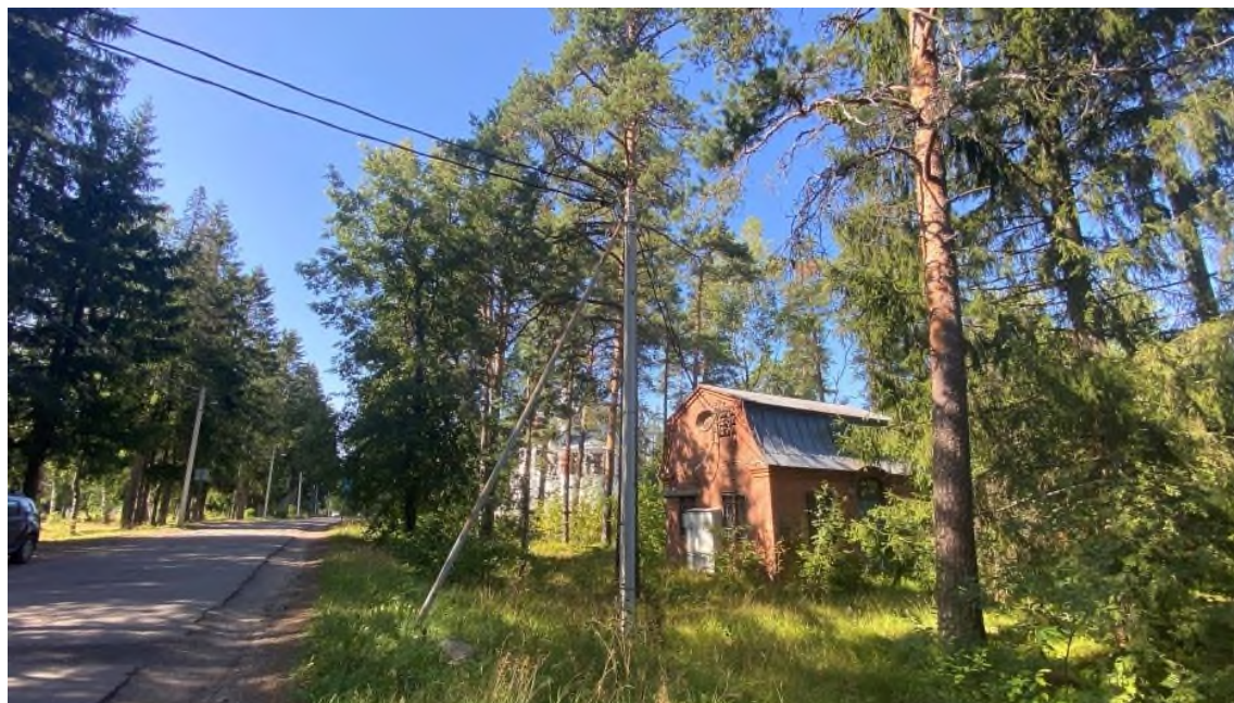
Фото 7. Прозекторская (трансформаторная подстанция), опора № 1
