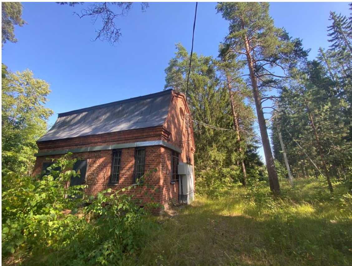
Фото 6. Вид на прозекторскую с юго-запада.
