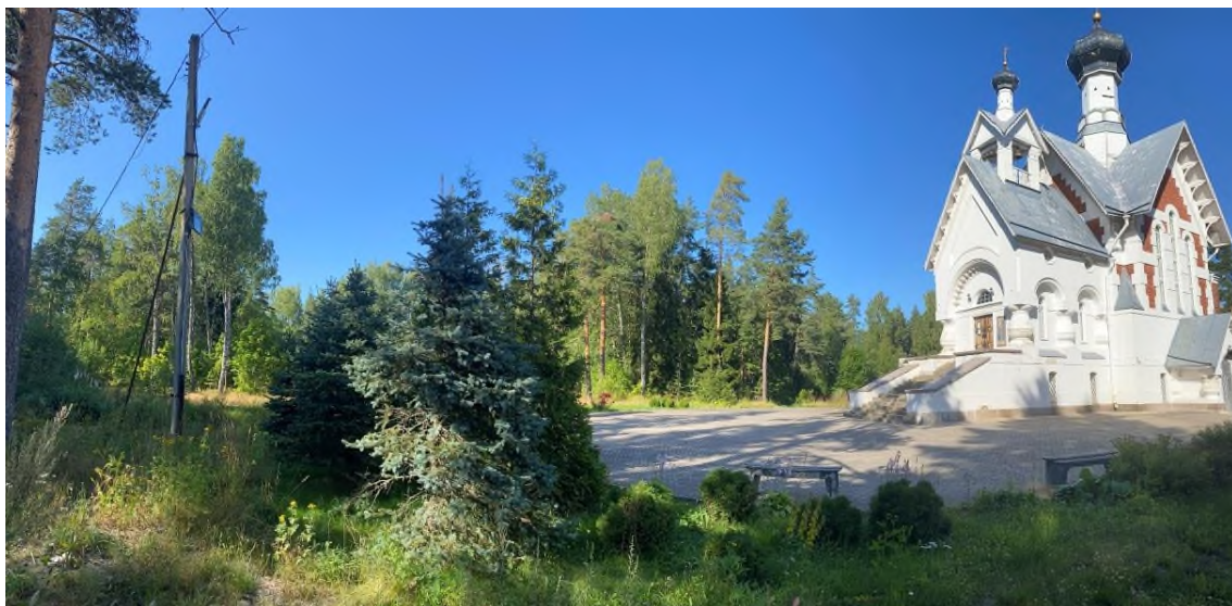
Фото 9. Площадка церкви Александра Невского, вид с юго-запада, слева - существующая железобетонная опора с установленным прибором для подсветки здания церкви
