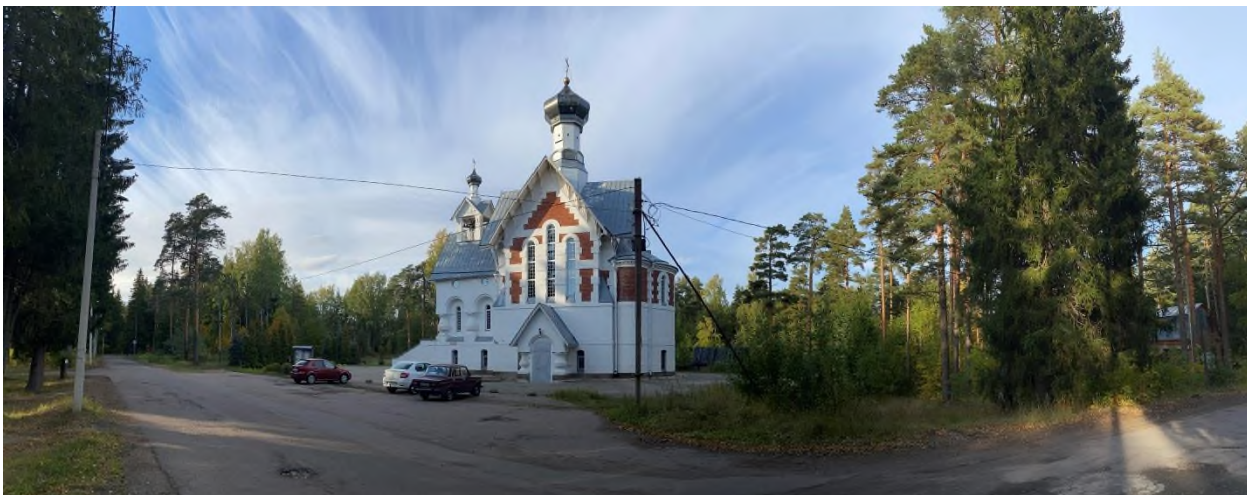
Фото 2. Панорама церкви Александра Невского, вид с юго-востока
