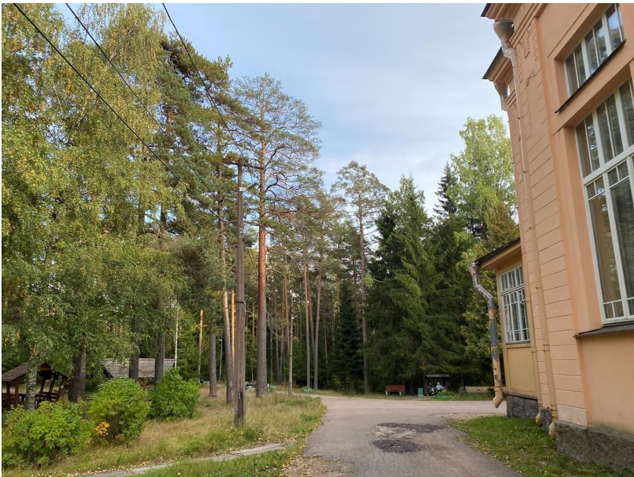
Фото 13. Территория объекта культурного наследия федерального значения «Санаторий, в котором в декабре 1917 г. отдыхал Ленин Владимир Ильич. Здесь им написаны 4 работы»: существующая ЛЭП вдоль главного лечебного корпуса
