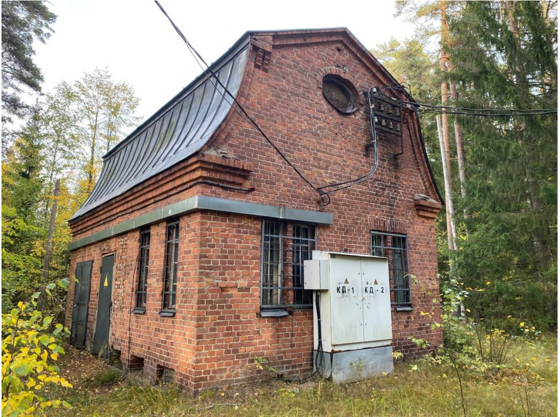
Фото 9. Здание прозекторской (трансформаторная подстанция), вид с юго-запада
