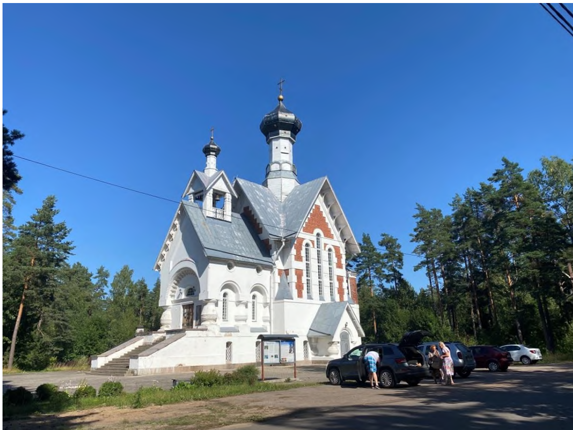
Фото 1. Вид на церковь с юго-западной стороны.
