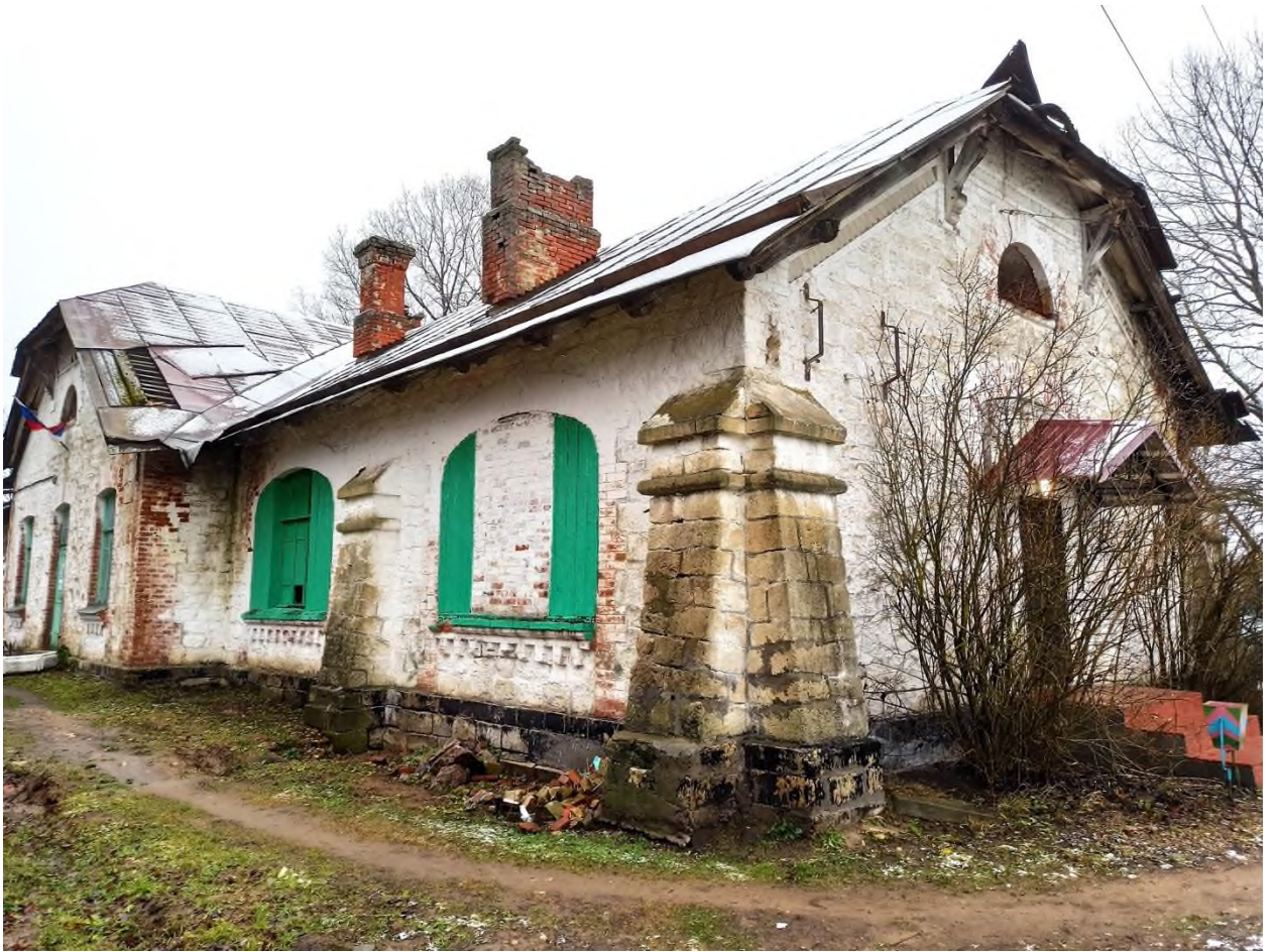
77. Каменная дача (административное здание). Общий вид с юга
