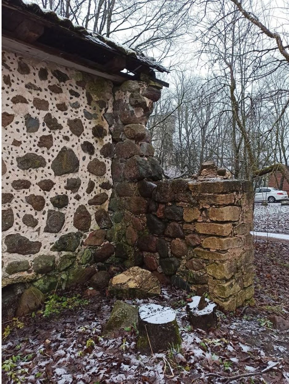
86. Служебная постройка (амбар). Фрагмент ограды, примыкающей к юго-западному углу объема. Вид с севера
