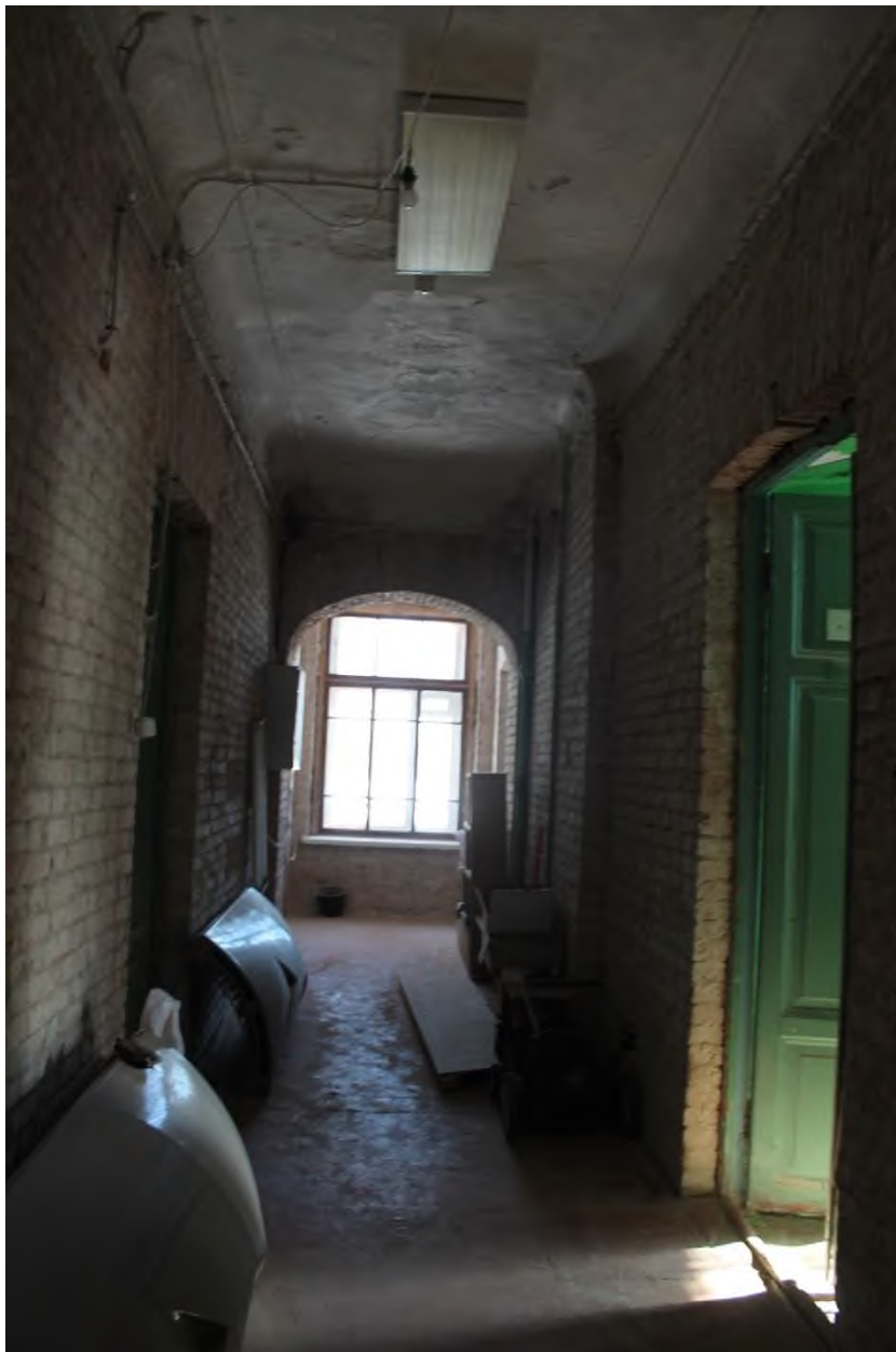
37. Здание сельскохозяйственного (земского) училища. Коридор 2-го этажа
