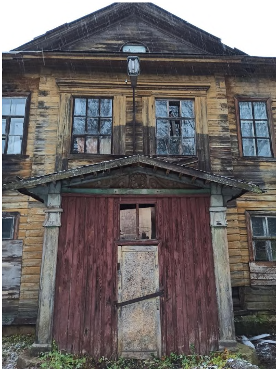
50. Жилой (деревянный) дом. Фрагмент южного фасада
