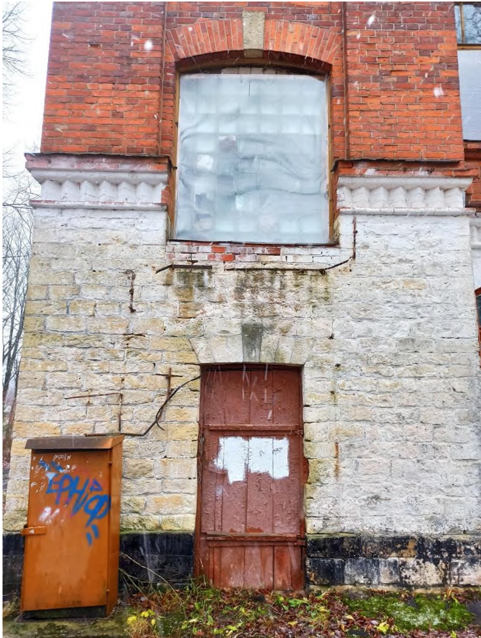
14. Здание сельскохозяйственного (земского) училища. Южный фасад. Входной проем в западной боковой оси фасада
