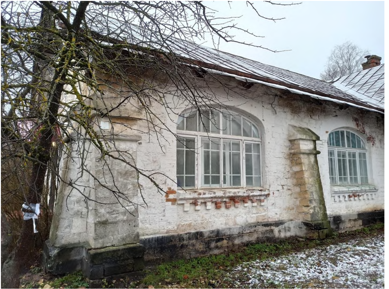
74. Каменная дача (административное здание). Южная часть восточного фасада. Контрфорсы
