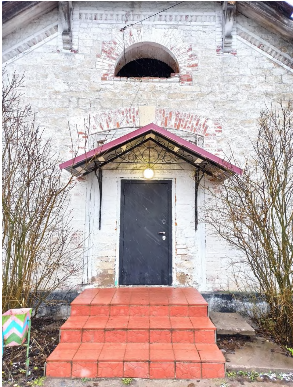
76. Каменная дача (административное здание). Центральная часть южного фасада
