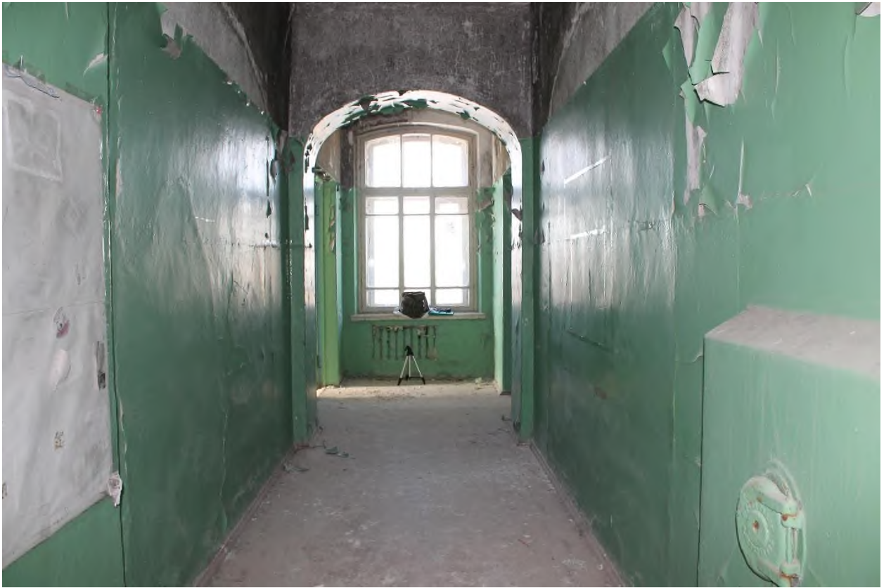
35. Здание сельскохозяйственного (земского) училища. Коридор 2-го этажа
