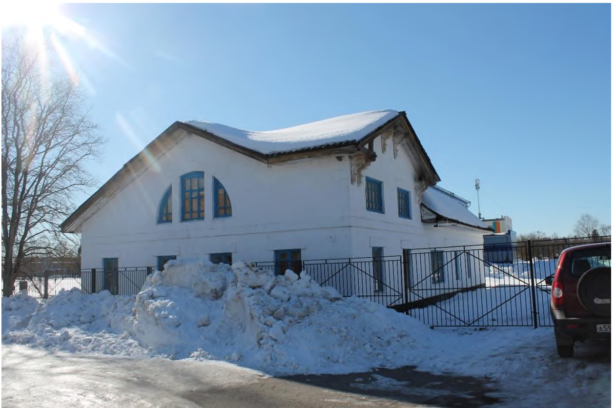
99. Каменный корпус у перекрестка дорог (баня и столовая). Общий вид с северо-востока
