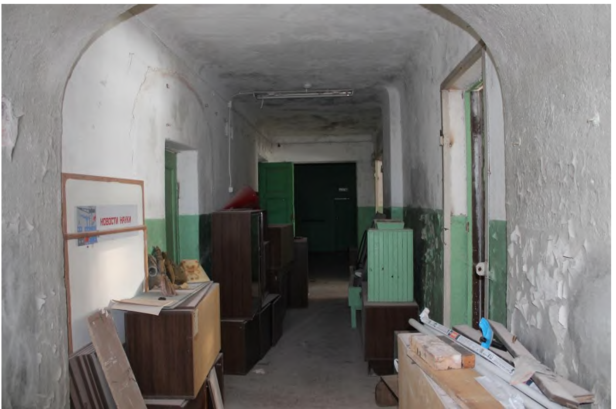
26. Здание сельскохозяйственного (земского) училища. Коридор 1-го этажа
