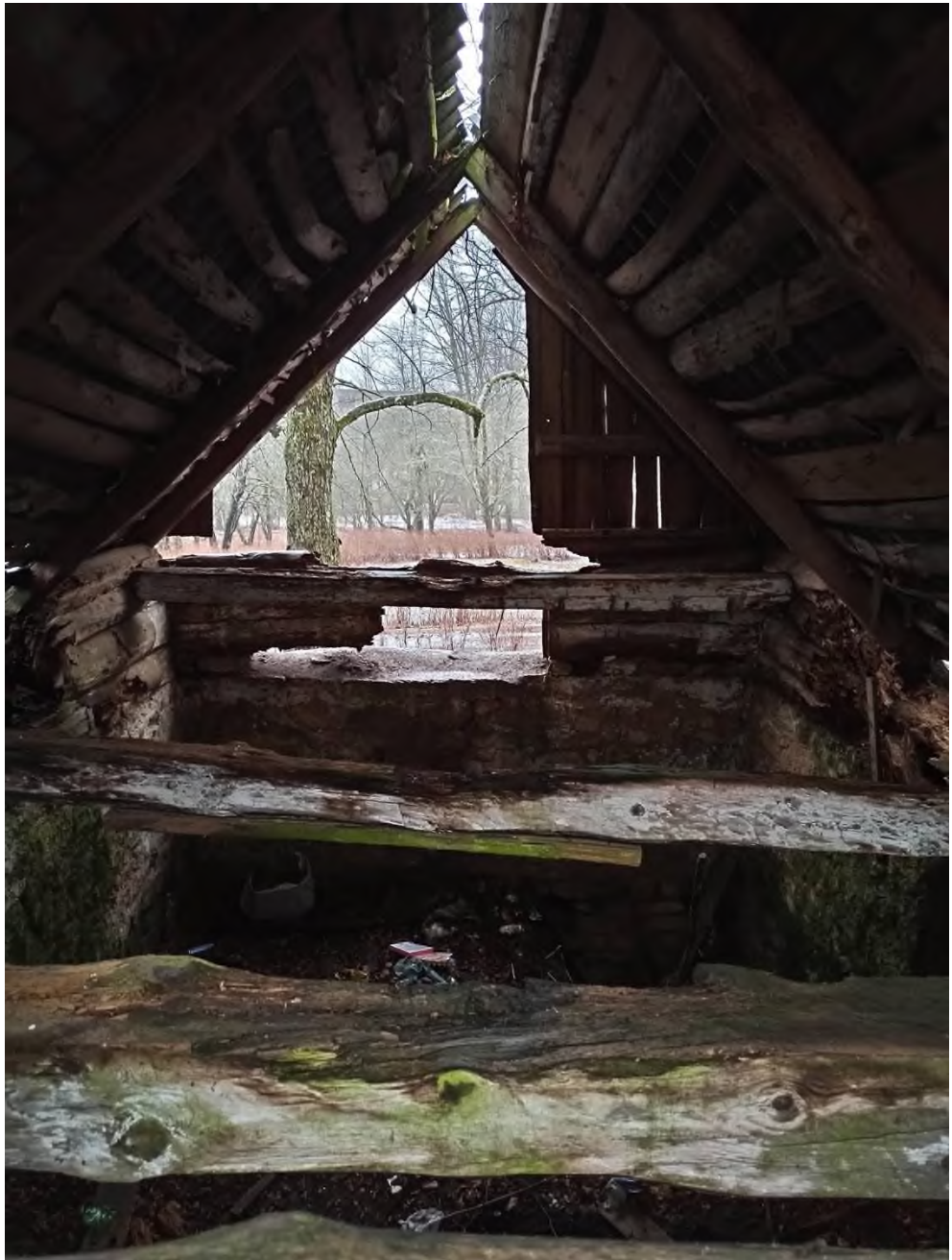
66. Хозяйственная постройка (погреб) на территории парка. Вид изнутри. Состояние конструкций
