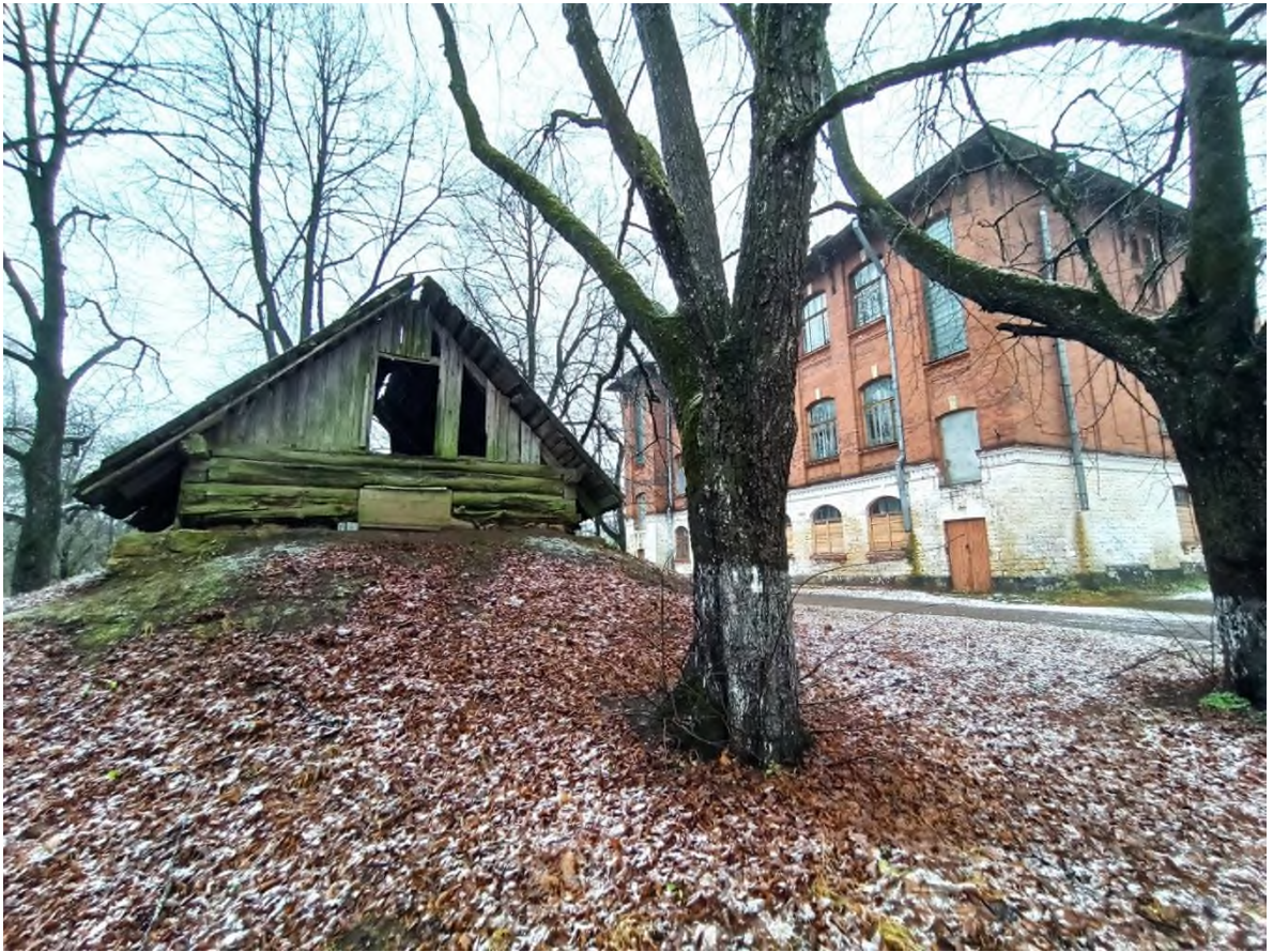
67. Общий вид хозяйственной постройки (погреб) в составе парка и здания земского сельскохозяйственного училища с востока
