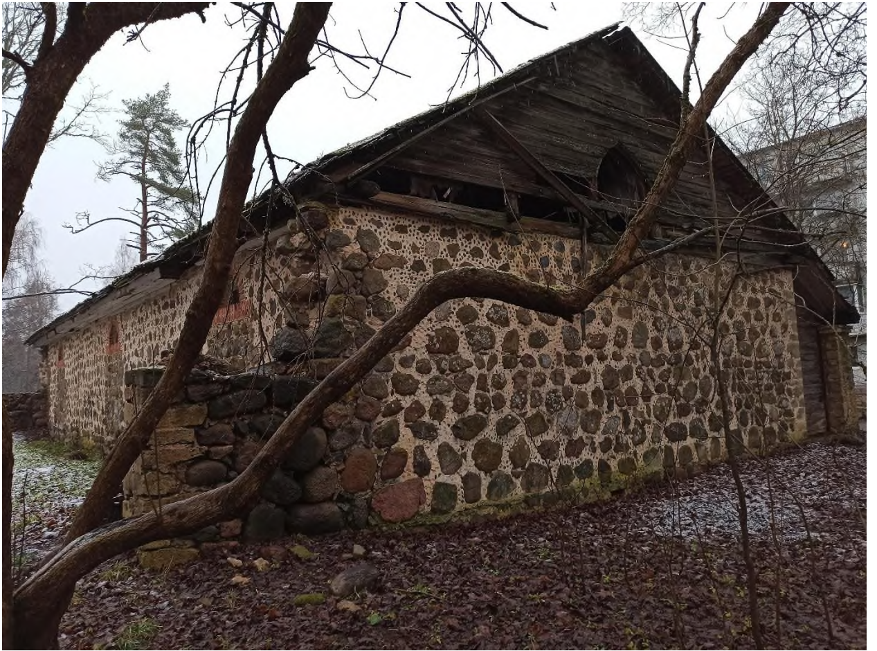
85. Служебная постройка (амбар). Общий вид с юга
