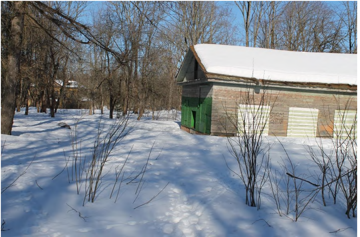
96. Служебная постройка (каретный сарай). Вид с юга
