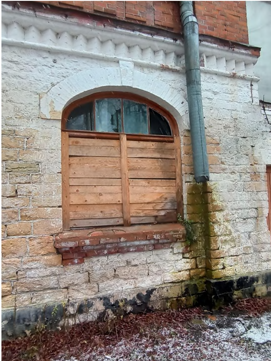
18. Здание сельскохозяйственного (земского) училища. Фрагмент южного фасада. Оформление оконного проема 1-го этажа
