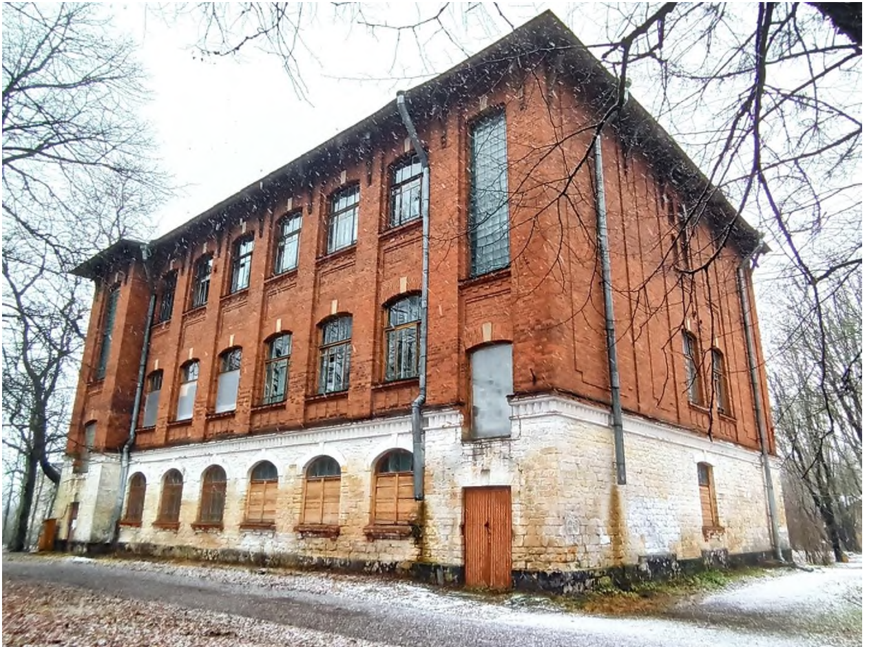
19. Здание сельскохозяйственного (земского) училища. Общий вид с юго-востока
