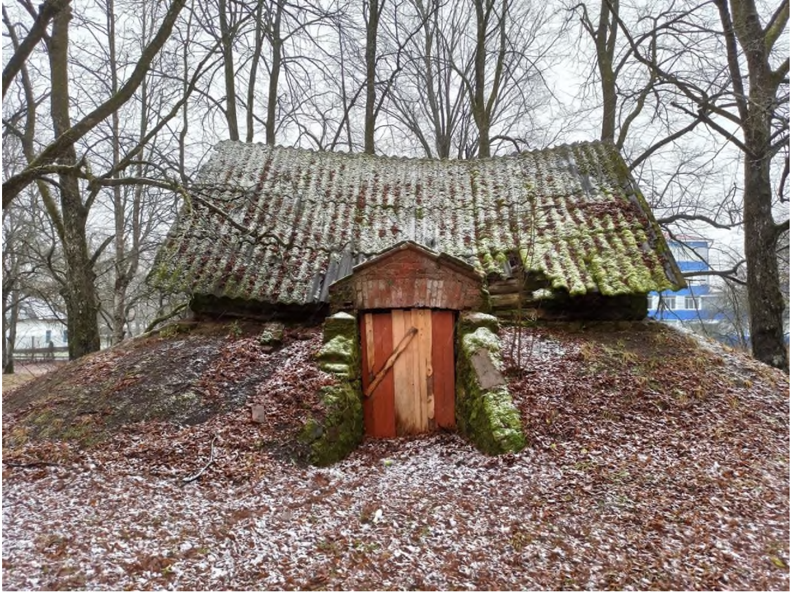
59. Хозяйственная постройка (погреб) на территории парка. Вид с северо-запада
