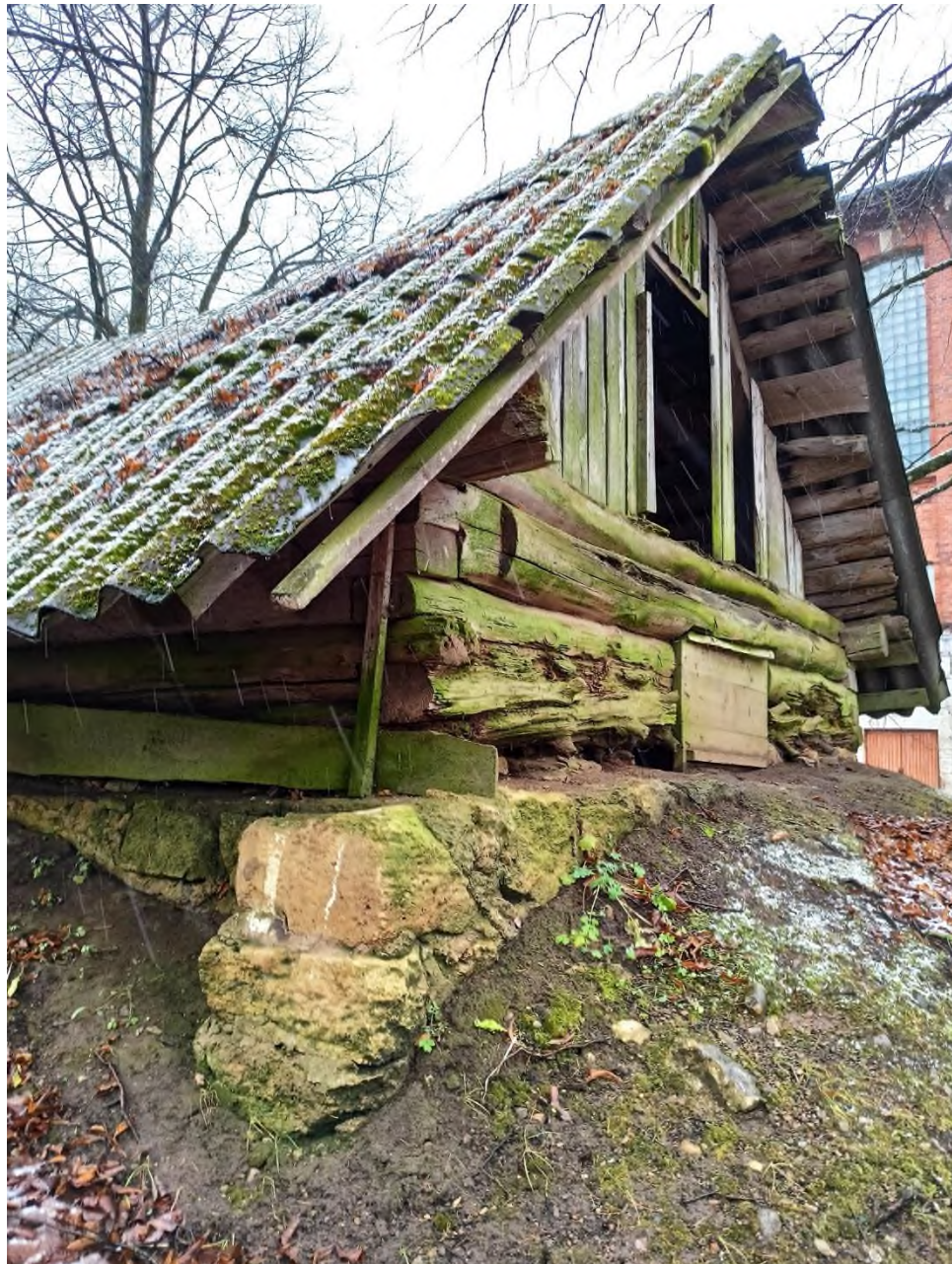
64. Хозяйственная постройка (погреб) на территории парка. Вид с востока
