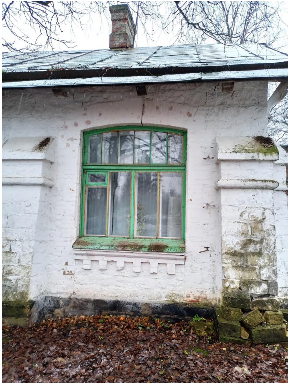
71. Каменная дача (административное здание). Фрагмент восточного фасада. Оконный проем
