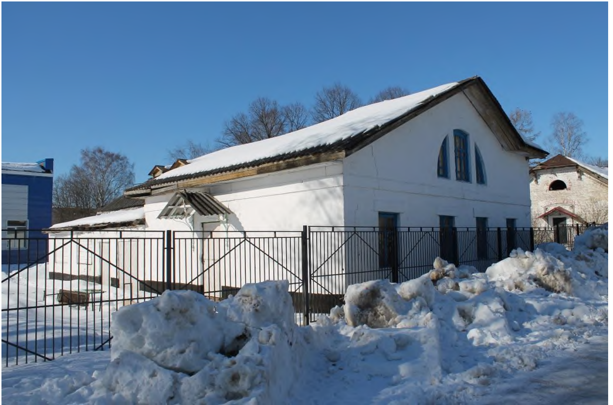
100. Каменный корпус у перекрестка дорог (баня и столовая). Общий вид с юго-востока
