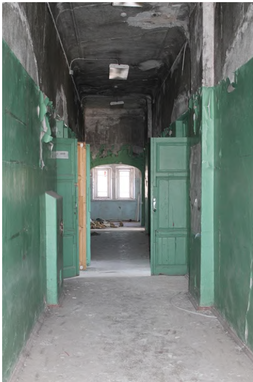
41. Здание сельскохозяйственного (земского) училища. Коридор 3-го этажа
