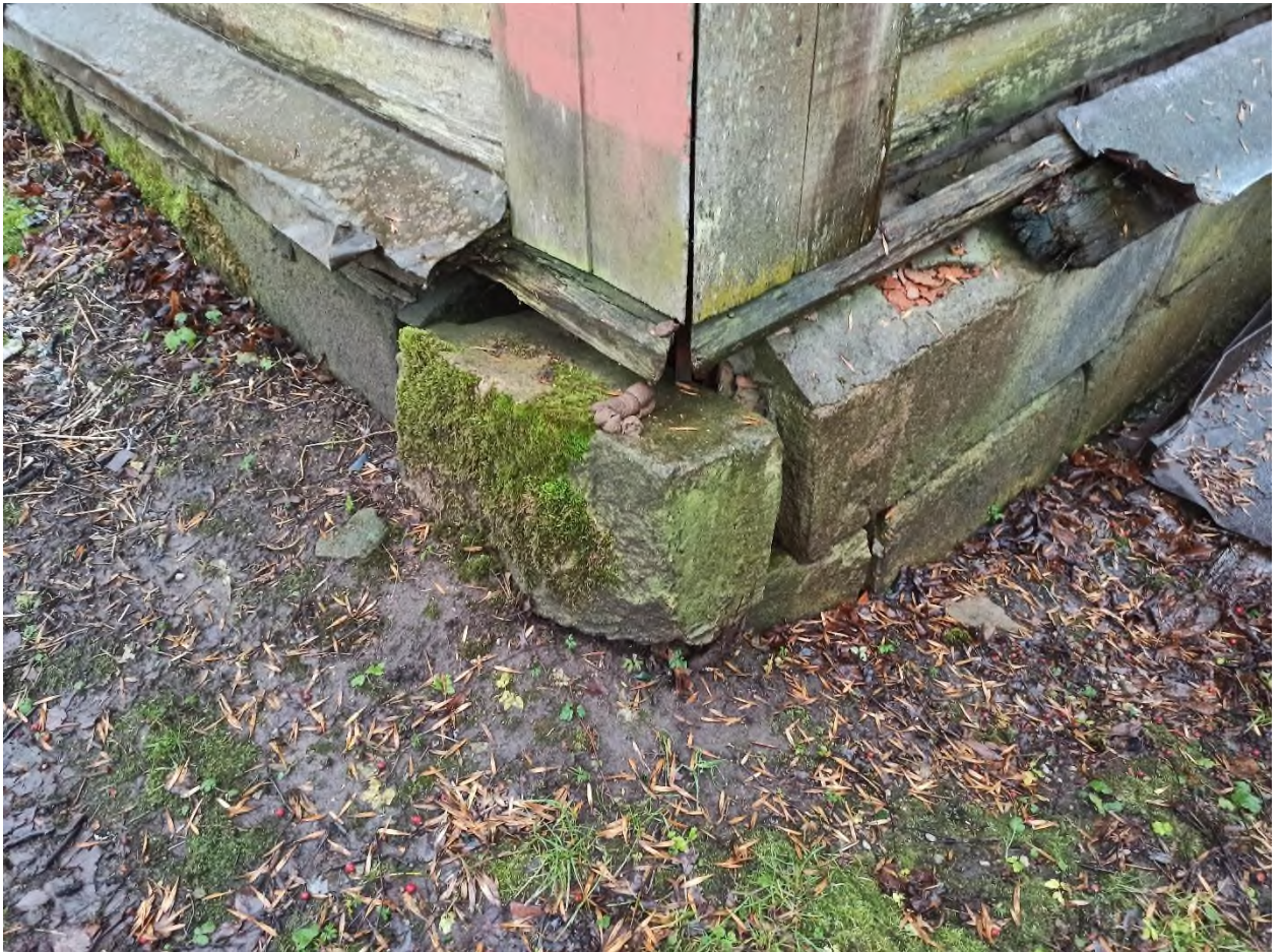
57. Жилой (деревянный) дом. Деталь цоколя из белокаменных блоков
