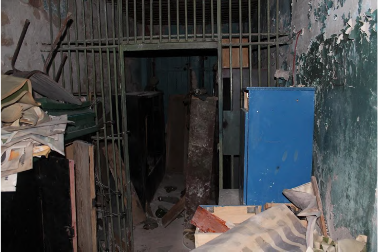
33. Здание сельскохозяйственного (земского) училища. Помещение под западной лестницей
