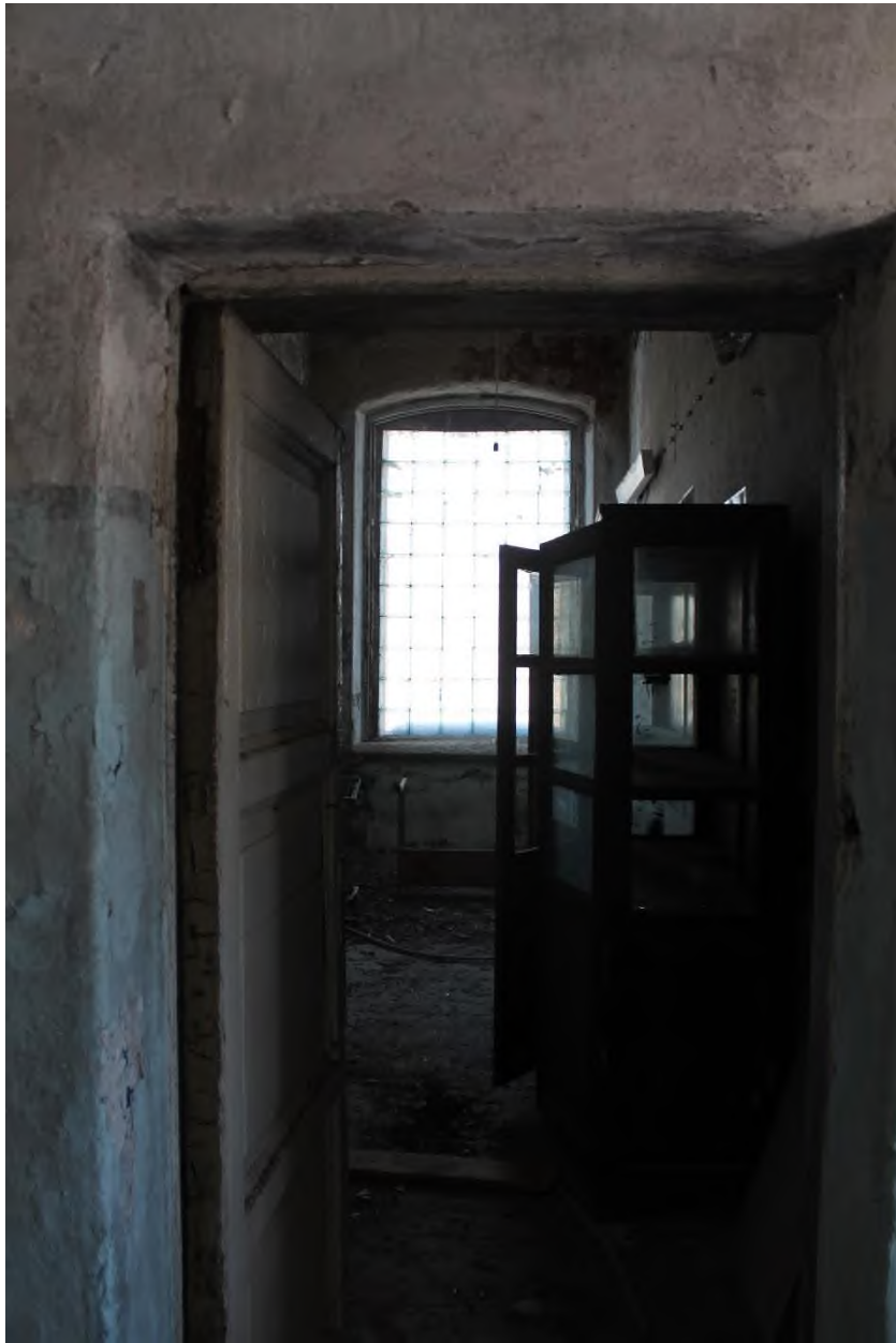
43. Здание сельскохозяйственного (земского) училища. Коридор 3-го этажа
