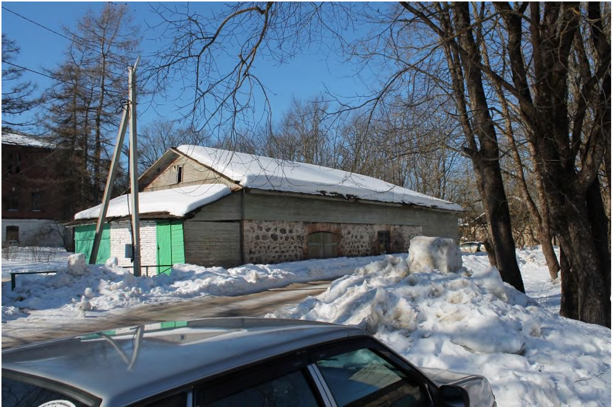
94. Служебная постройка (каретный сарай). Общий вид с востока
