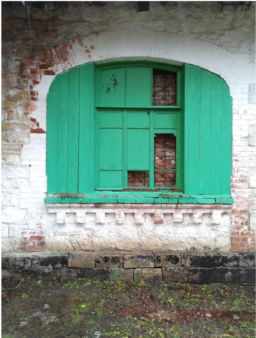
79. Каменная дача (административное здание). Фрагмент западного фасада. Оконный проем
