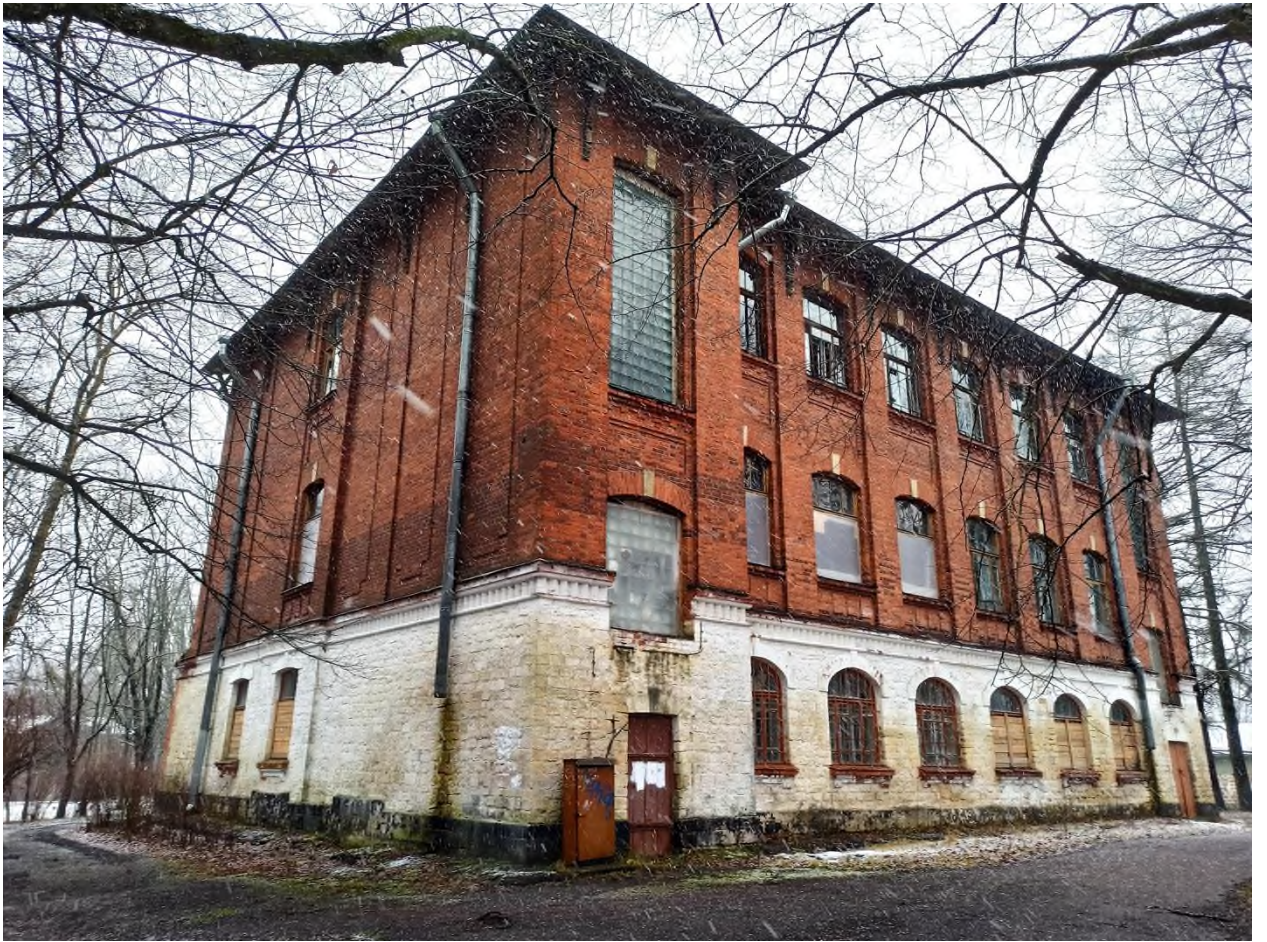
13. Здание сельскохозяйственного (земского) училища. Общий вид с юго-запада
