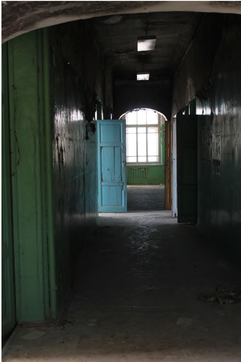
36. Здание сельскохозяйственного (земского) училища. Коридор 2-го этажа
