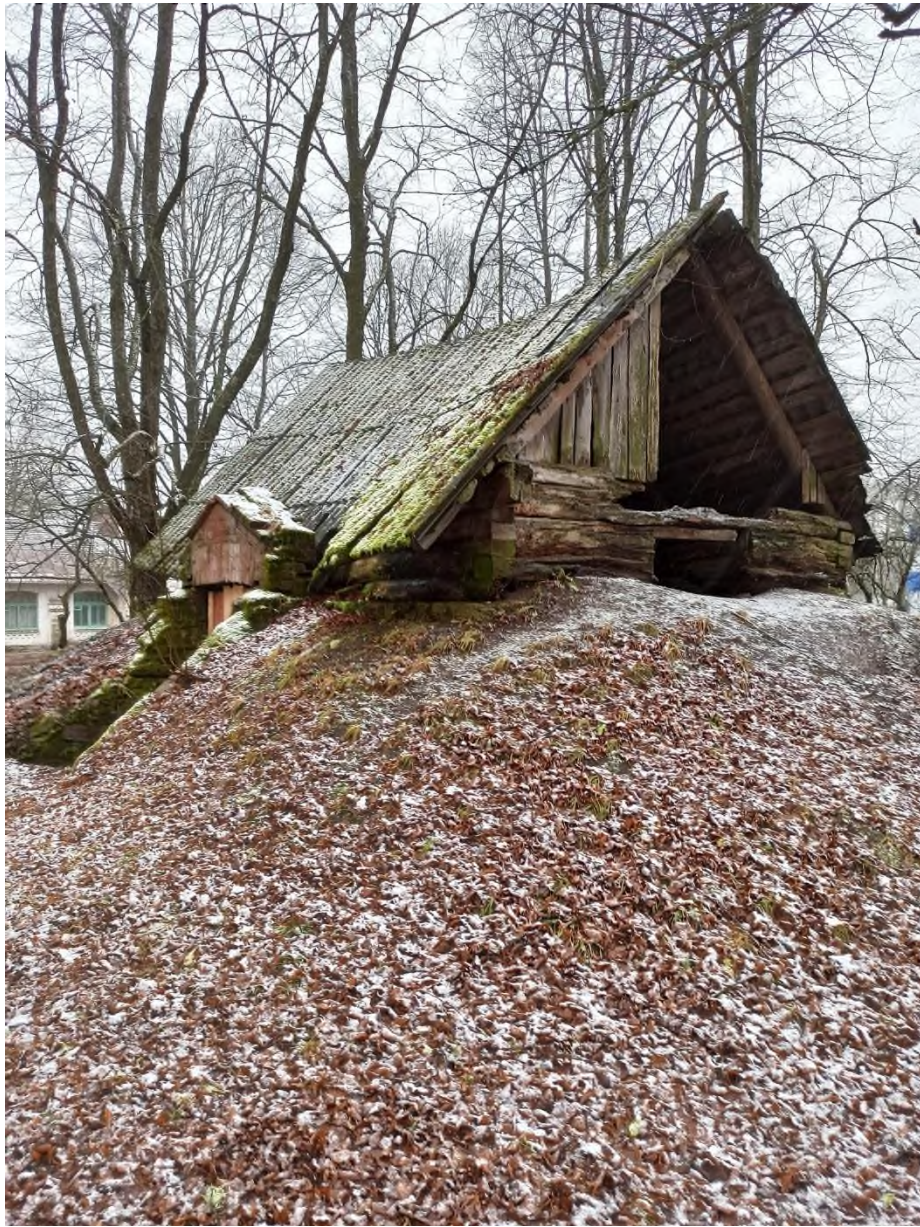
61. Хозяйственная постройка (погреб) на территории парка. Вид с запада
