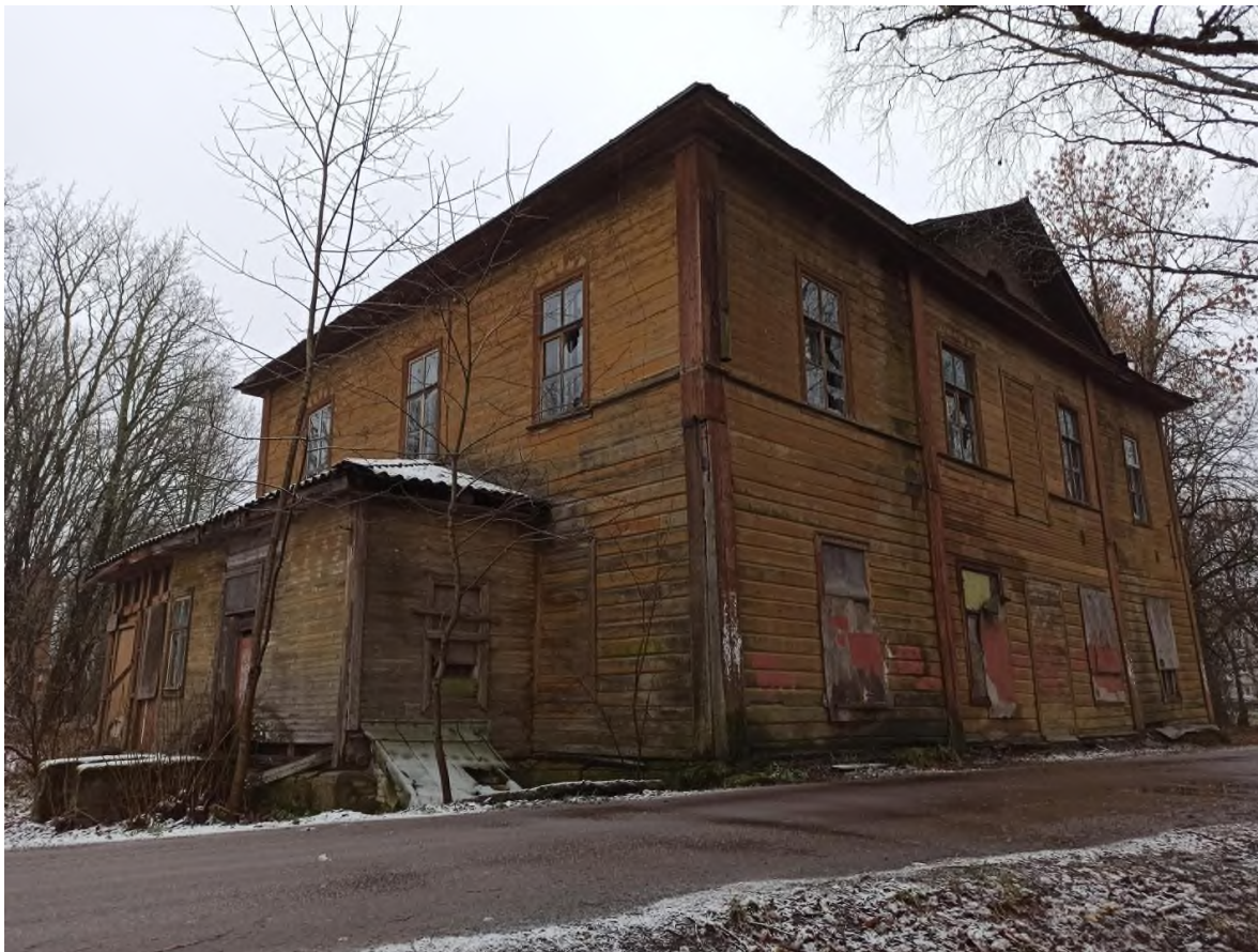
53. Жилой (деревянный) дом. Общий вид с северо-востока
