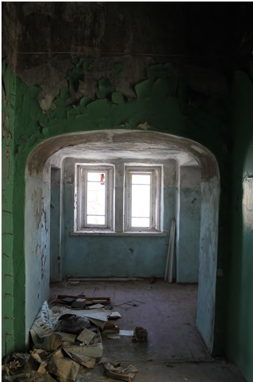
42. Здание сельскохозяйственного (земского) училища. Коридор 3-го этажа
