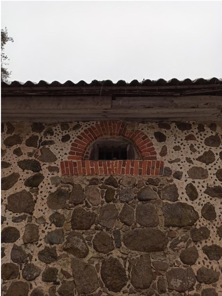
91. Служебная постройка (амбар). Деталь западного фасада - полуциркульное окно в верхней части
