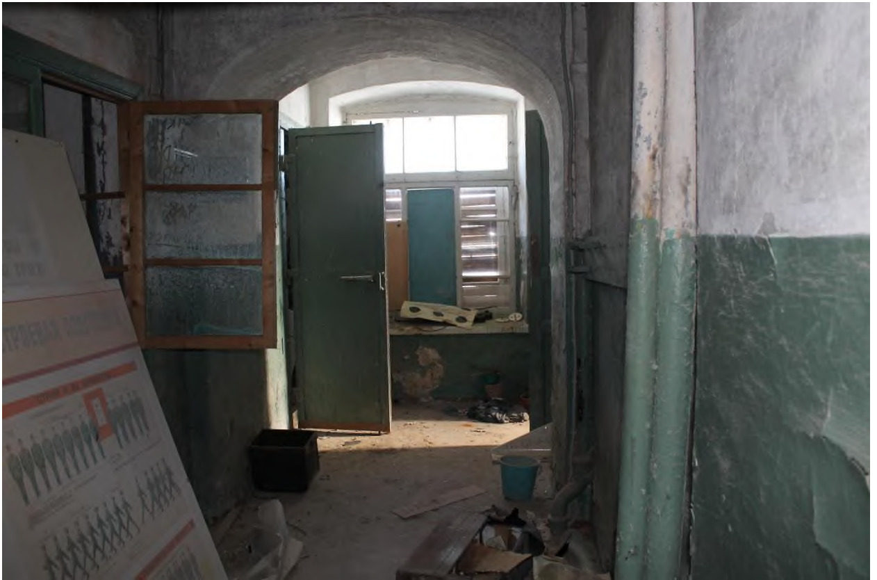
31. Здание сельскохозяйственного (земского) училища. Коридор 1-го этажа
