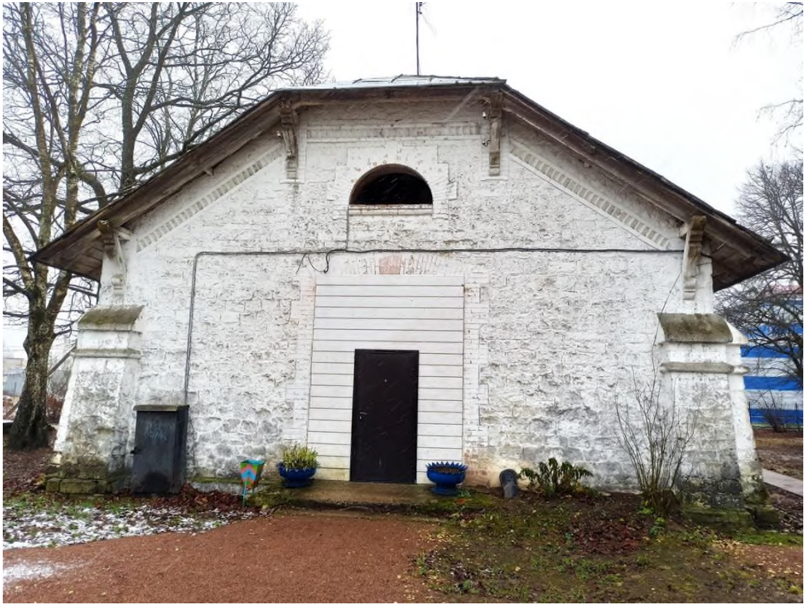
69. Каменная дача (административное здание). Северный фасад
