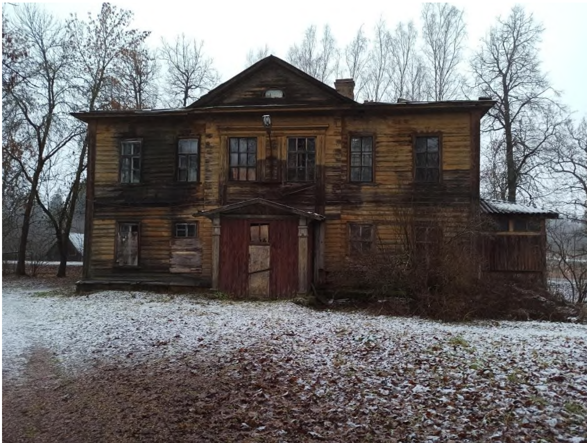
49. Жилой (деревянный) дом. Южный фасад.
