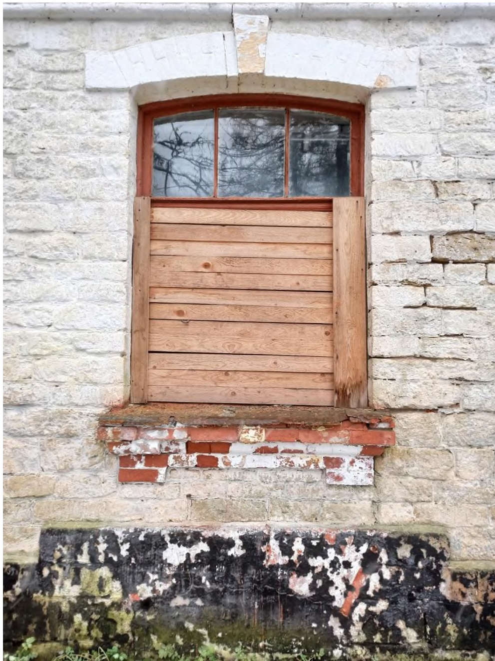
22. Фрагмент восточного фасада здания сельскохозяйственного (земского) училища. Оформление оконного проема первого этажа.
