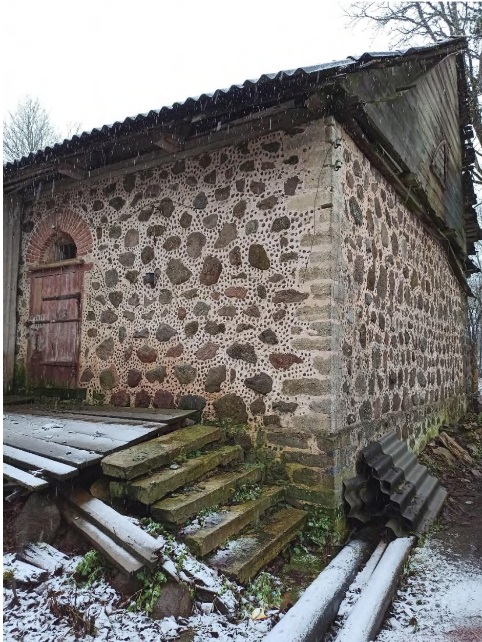
87. Службная постройка (амбар). Фрагмент северного фасада. Кладка
