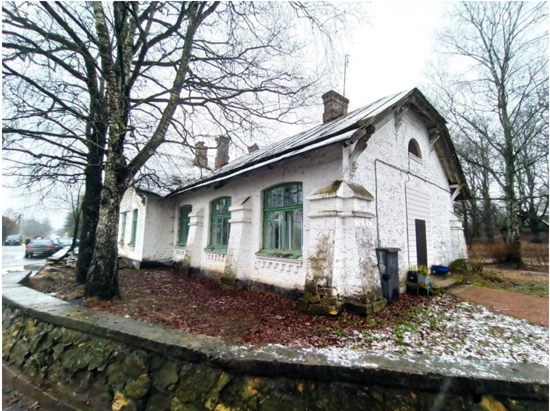
70. Каменная дача (административное здание). Общий вид с севера
