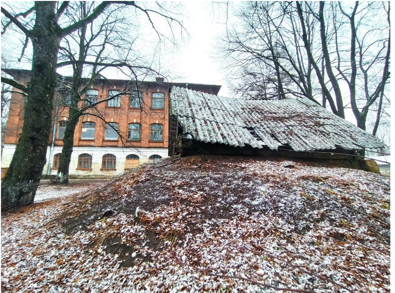
63. Общий вид хозяйственной постройки (погреба) в составе парка и здания земского сельскохозяйственного училища с юго-востока
