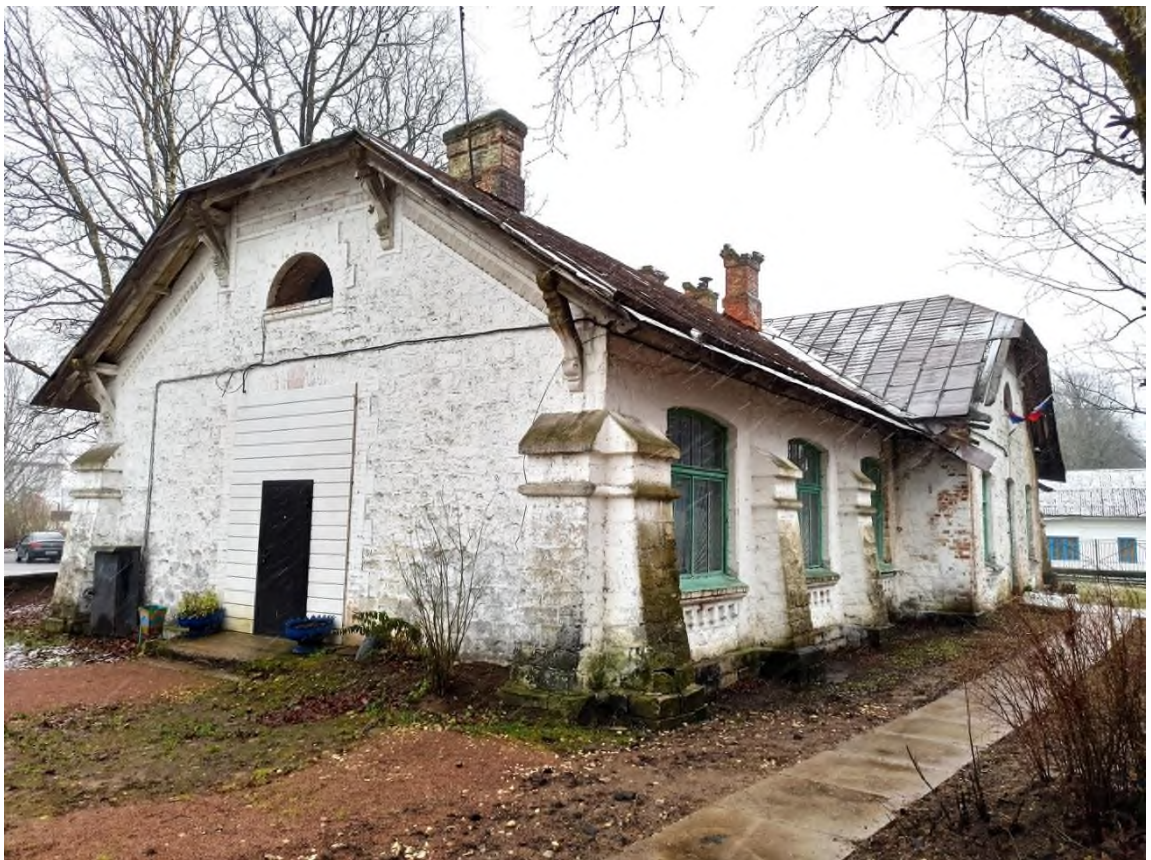
68. Каменная дача (административное здание). Общий вид с северо-запада
