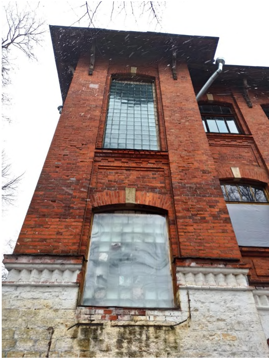
15. Фрагмент южного фасада здания сельскохозяйственного (земского) училища. Оформление лестничных оконных проемов 2 и 3 этажей
