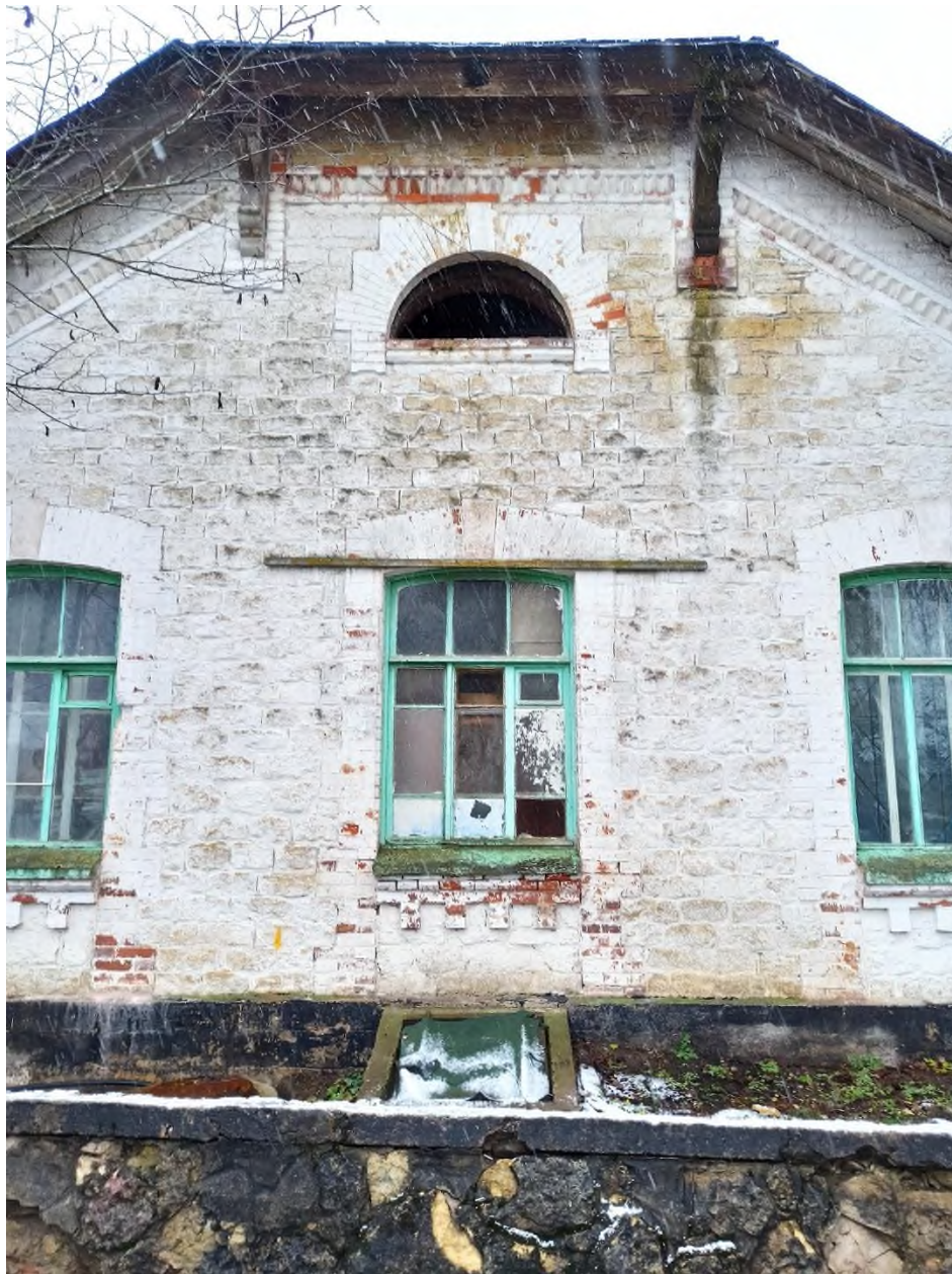
73. Каменная дача (административное здание). Фрагмент восточного фасада
