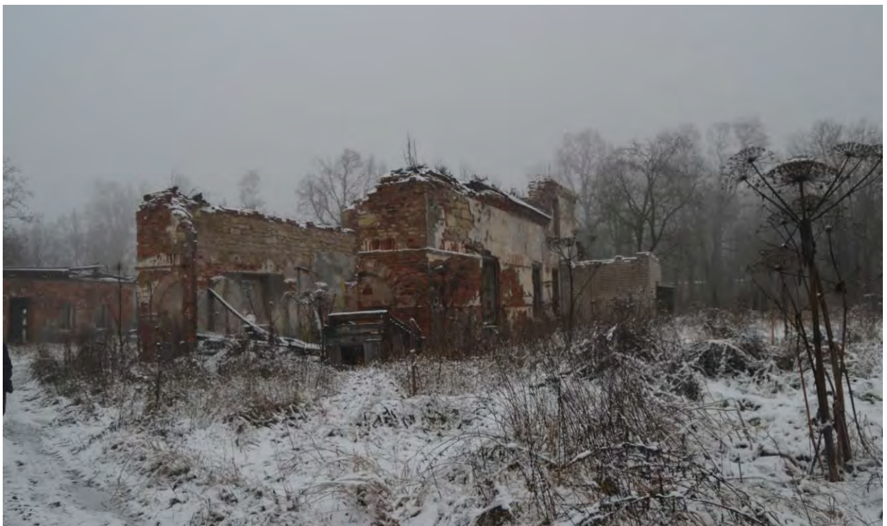
Фото 40. Постройки хозяйственного двора. Направление съемки -север. Дата съемки 16.12.2019. Автор съемки Е.Б. Яковлева.
