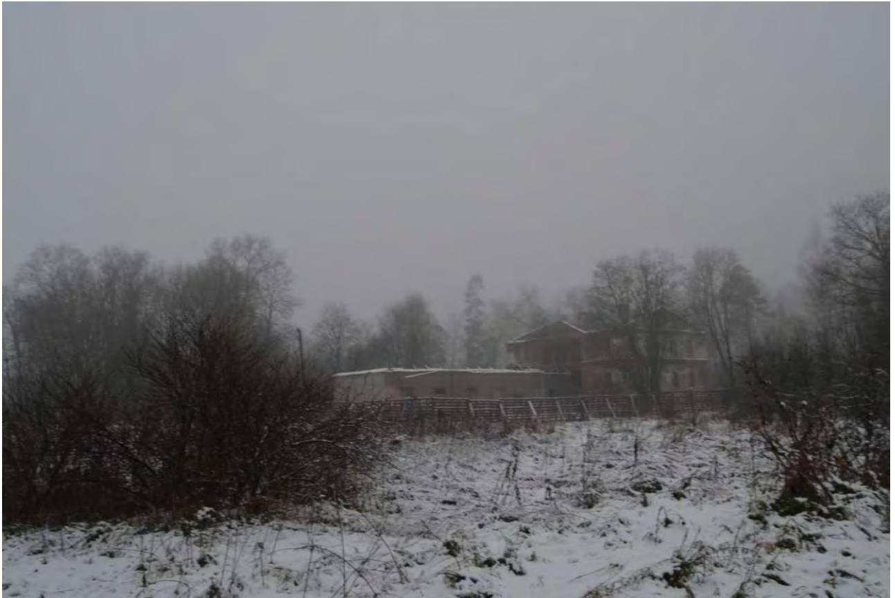
Фото 29. Вид на южную часть усадебного дома и позднюю пристройку. Направление съемки – северо-запад. Дата съемки 16.12.2019. Автор съемки Е.Б. Яковлева.
