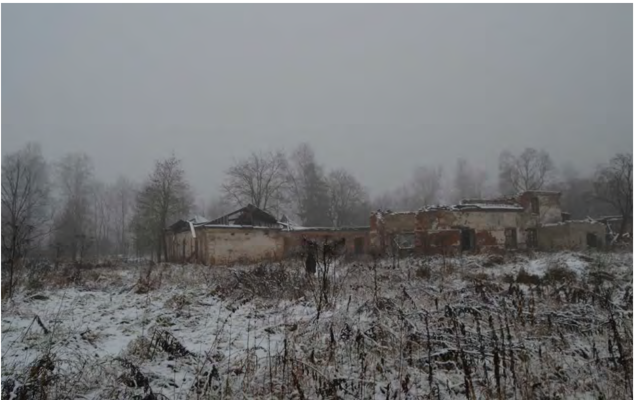
Фото 38. Остатки построек хозяйственного двора. Направление съемки - северо-запад. Дата съемки 16.12.2019. Автор съемки Е.Б. Яковлева.
