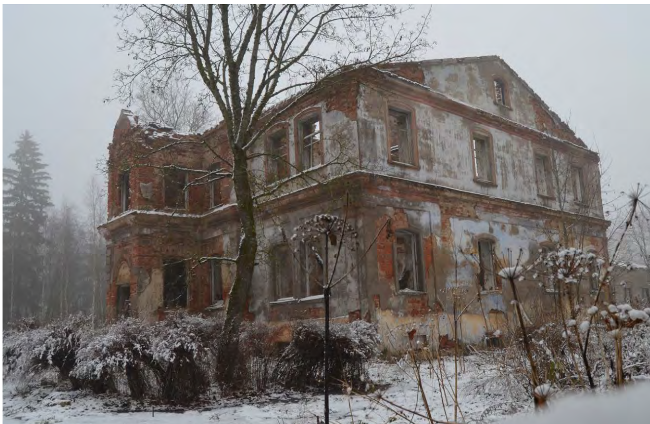
Фото 15. Вид на лицевой фасад усадебного дома. Направление съемки- юго-восток. Дата съемки 16.12.2019. Автор съемки Е.Б. Яковлева.
