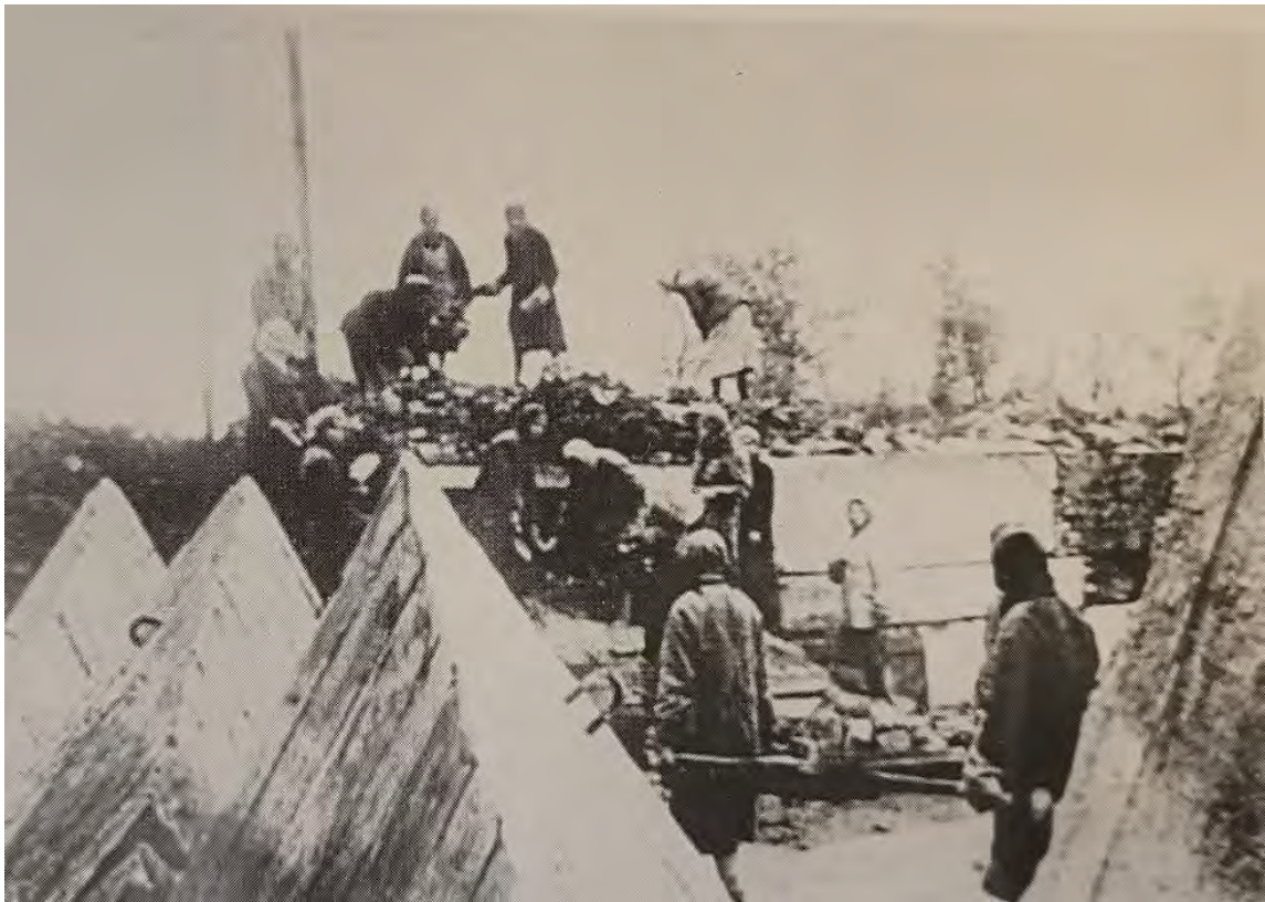
Илл.37. Колпинцы на строительстве оборонительных сооружений. Сизенов Е.П., Ефимова Г.А., Иволга Р.С. Подвигу твоему, Колпино. СПб, 2017.
