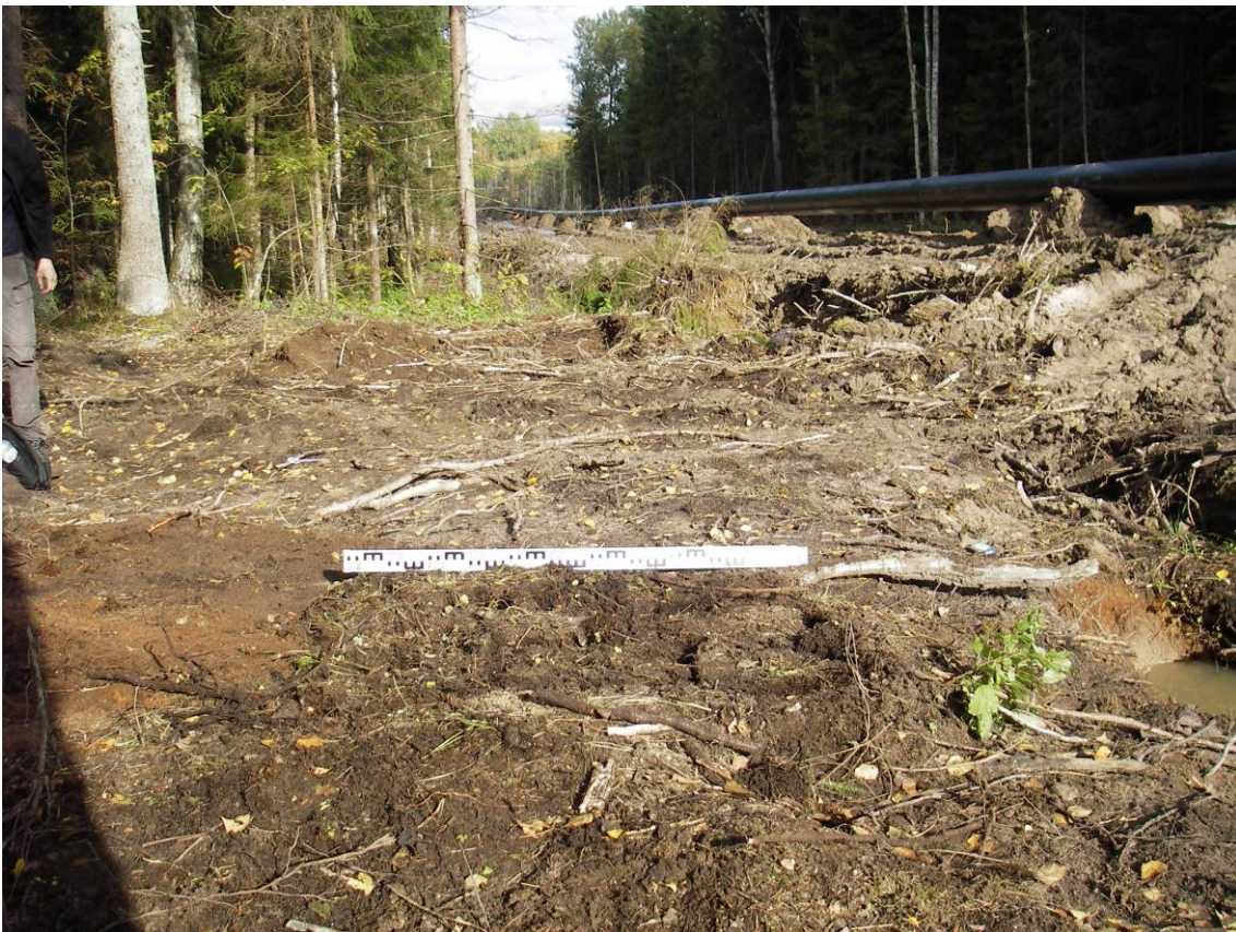
Рис. 88. Шурф 11. Восстановление поверхности. Вид с юга
