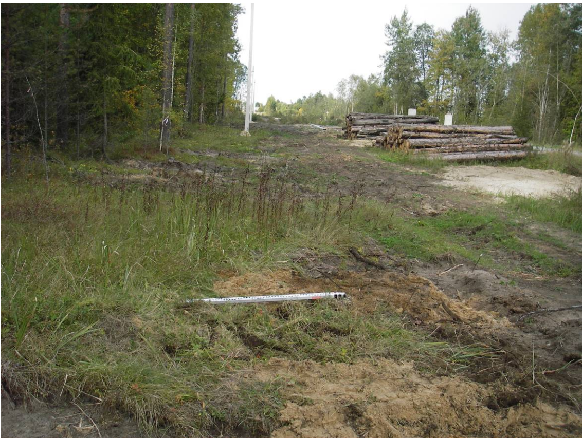
Рис. 169. Шурф 24. Восстановление поверхности. Вид с юга
