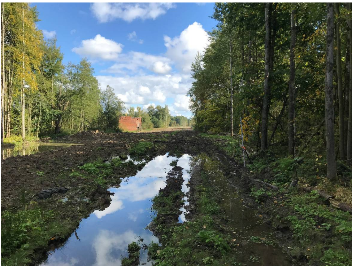
Рис. 49. Участок проектируемого объекта к западу от д. Александровская Горка (ТФ9). Вид с юго-запада
