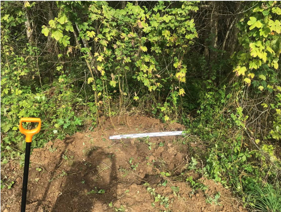
Рис. 110. Шурф 13. Восстановление поверхности. Вид с юга
