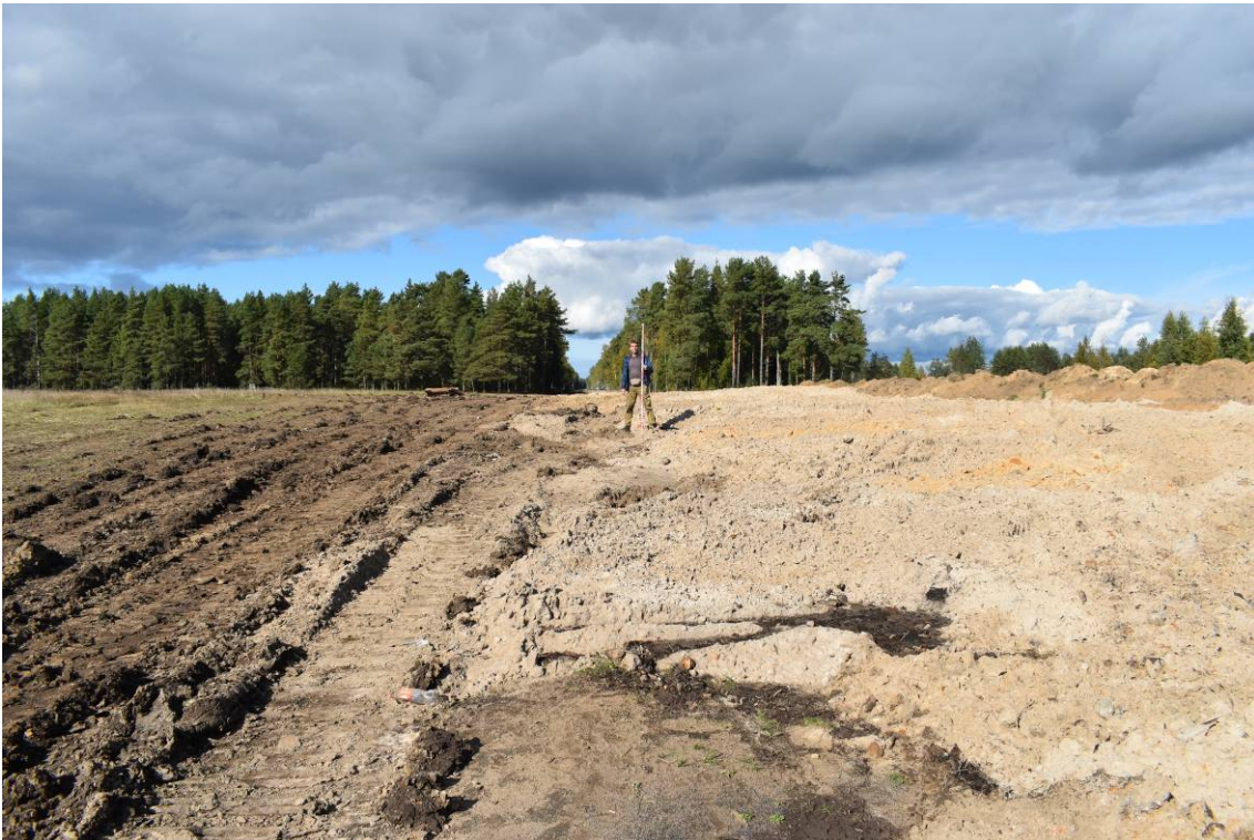
Рис. 106. Участок объекта у д. Извоз (ТФ21). Вид с юго-востока
