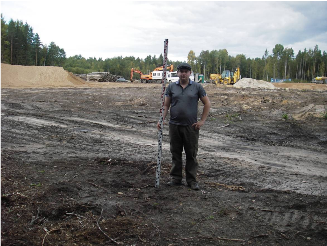
Рис. 157. Место закладки шурфа 22. Вид с юга
