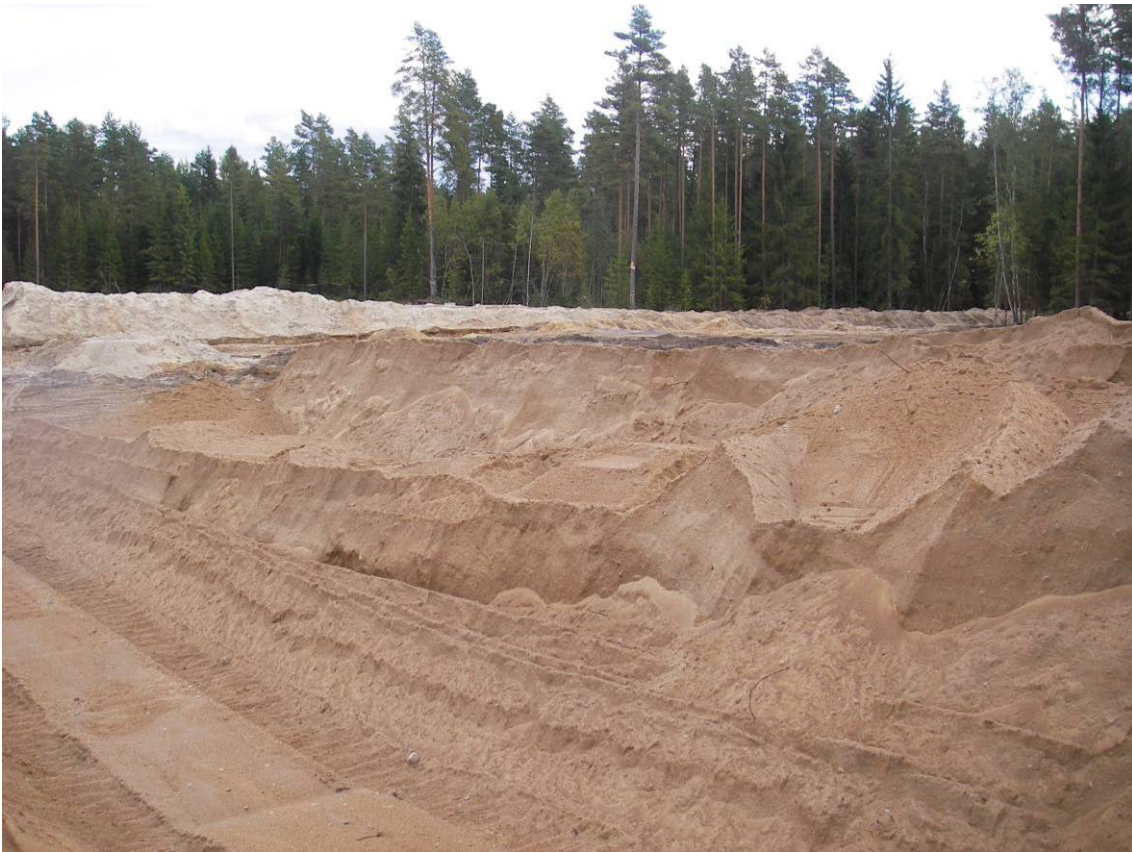
Рис. 146. Участок строительства технологической площадки (ТФ25). Вид с севера
