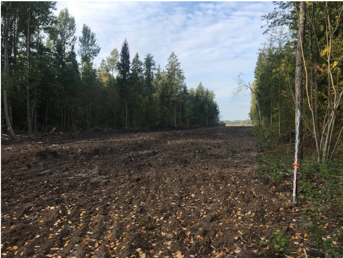
Рис. 64. Участок проектируемого объекта в месте пересечения руч. Верховской (ТФ12). Вид с северо-востока
