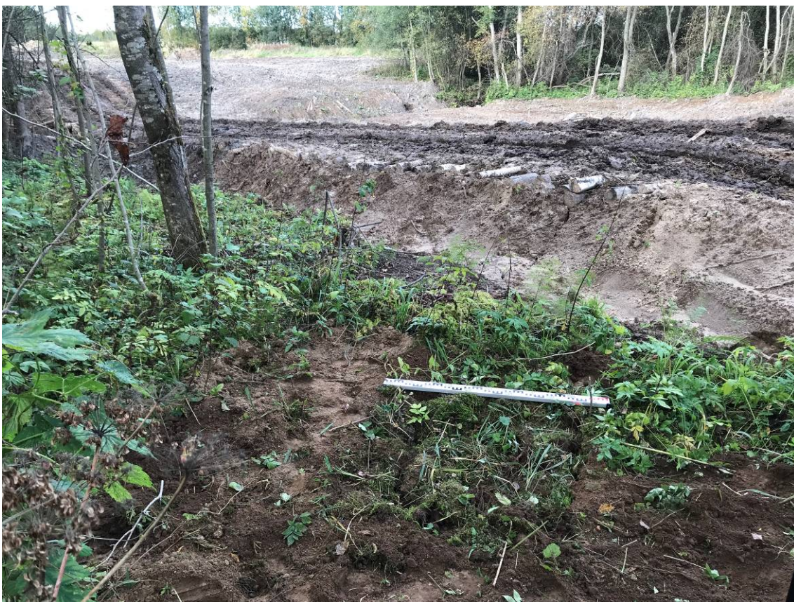
Рис. 114. Шурф 14. Восстановление поверхности. Вид с юга
