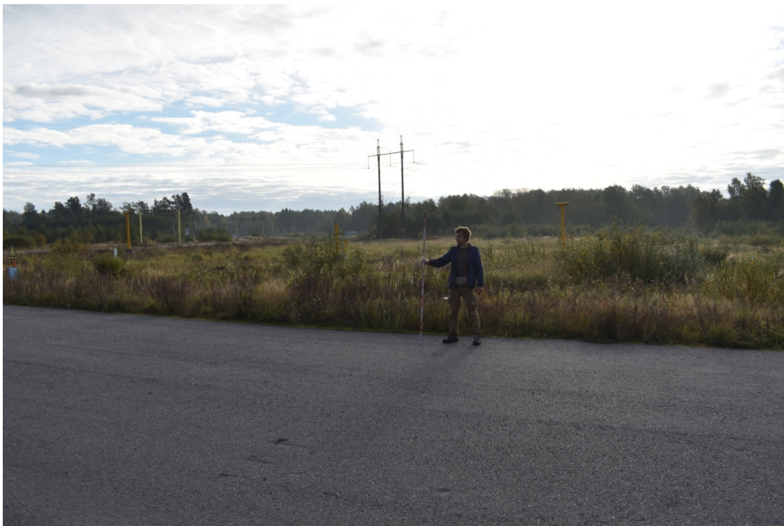
Рис. 15. Участок проектируемого объекта в месте пересечения с дорогой в д. Новопятницкое (ТФЗ). Вид с востока.
