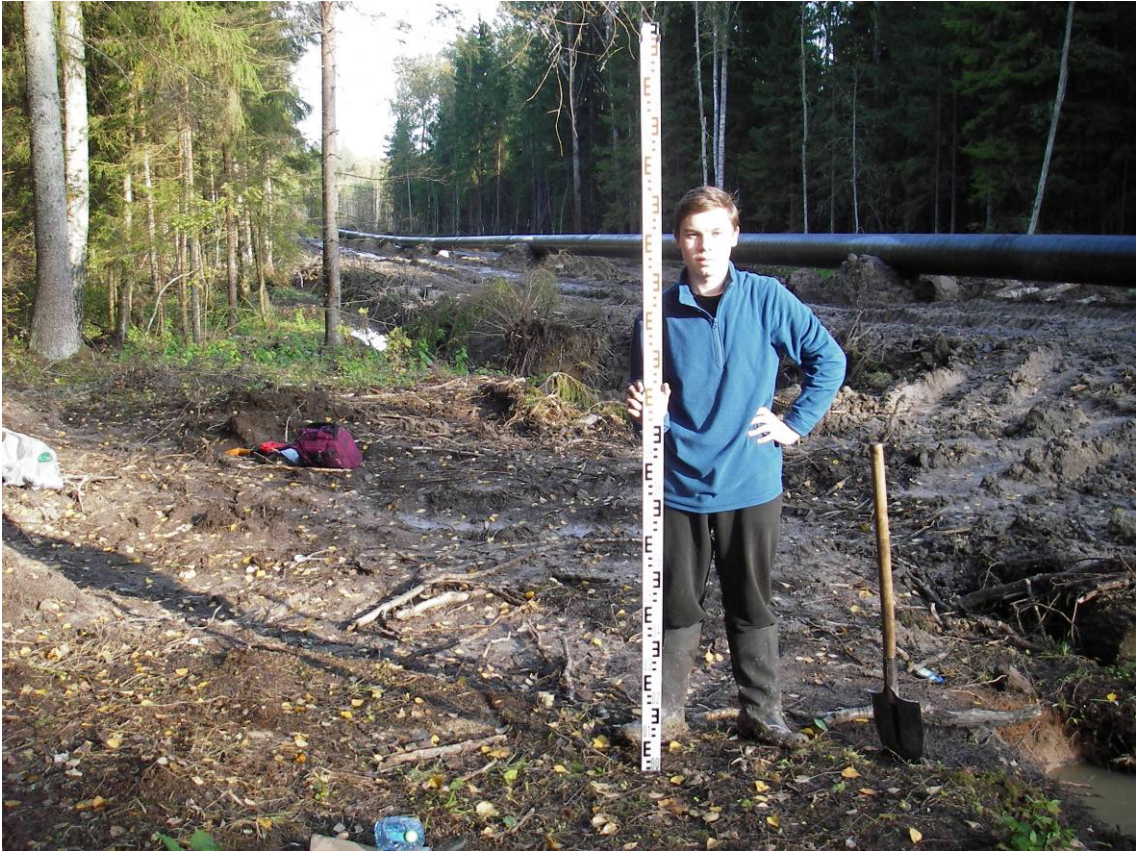
Рис. 85. Место закладки шурфа 11. Вид с юга
