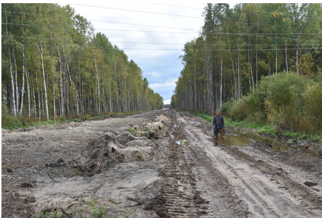
Рис. 130. Участок объекта обследования между д. Извоз и д. Кейкино (ТФ 23). Вид с северо-запада
