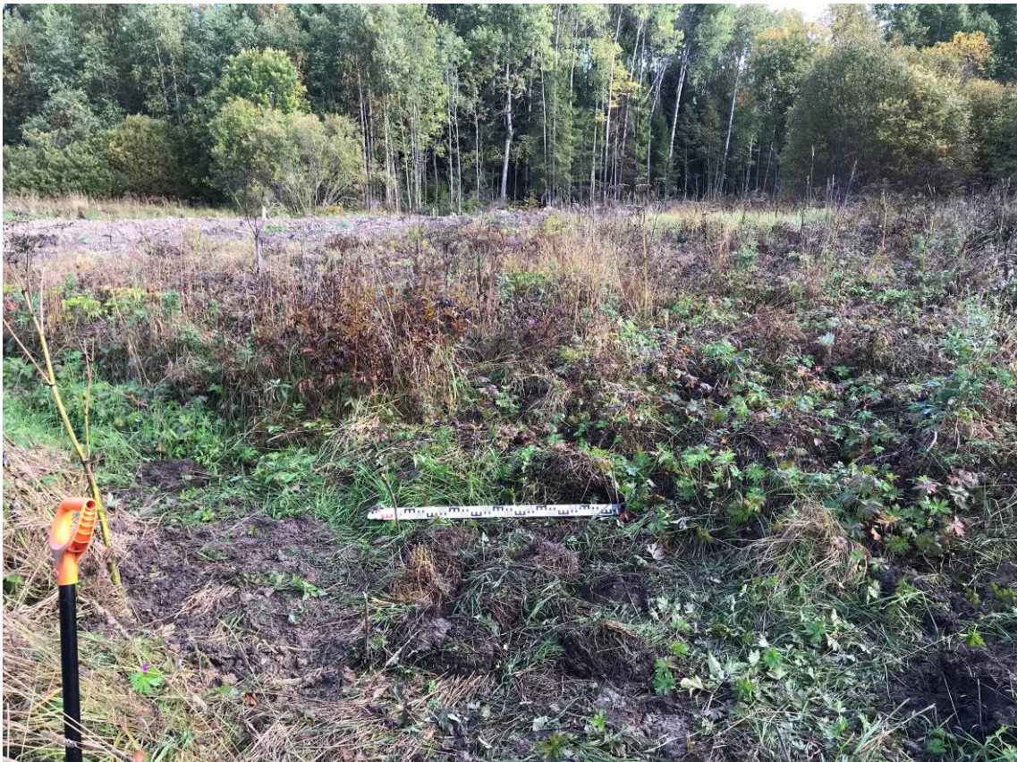
Рис. 56. Шурф 5. Восстановление поверхности. Вид с юга
