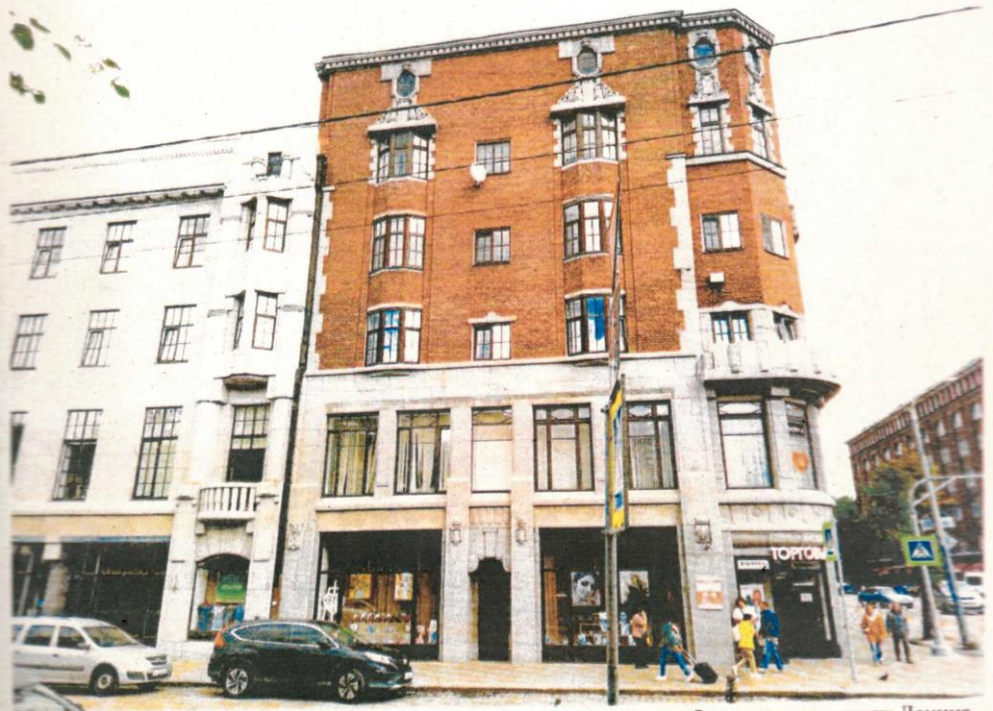
Фото 5. «Жилой и торговый дом «Карьяла». Угловая часть фасада объекта по проспекту Ленина.
