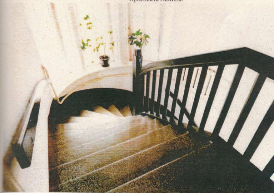
Фото 15. «Жилой и торговый дом «Карьяла». Фрагмент служебной лестницы. Левая, со стороны проспекта Ленина. Деревянное ограждение.
