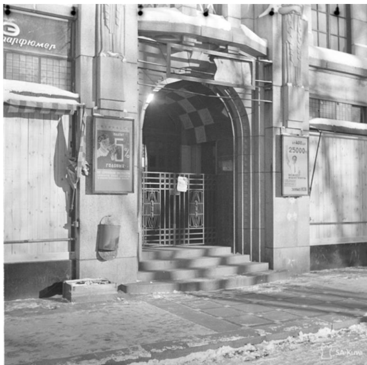
36. Портал главного входа в здание б. отделения Хельсинкского акционерного банка. Фотография. 30.08. 1941 г. Архив изображений Сил обороны Финляндии.
