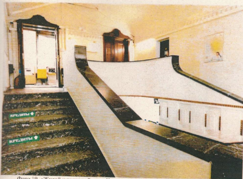
Фото 19. «Жилой и торговый дом «Карьяла». Фриз с декором парадной лестницы.
