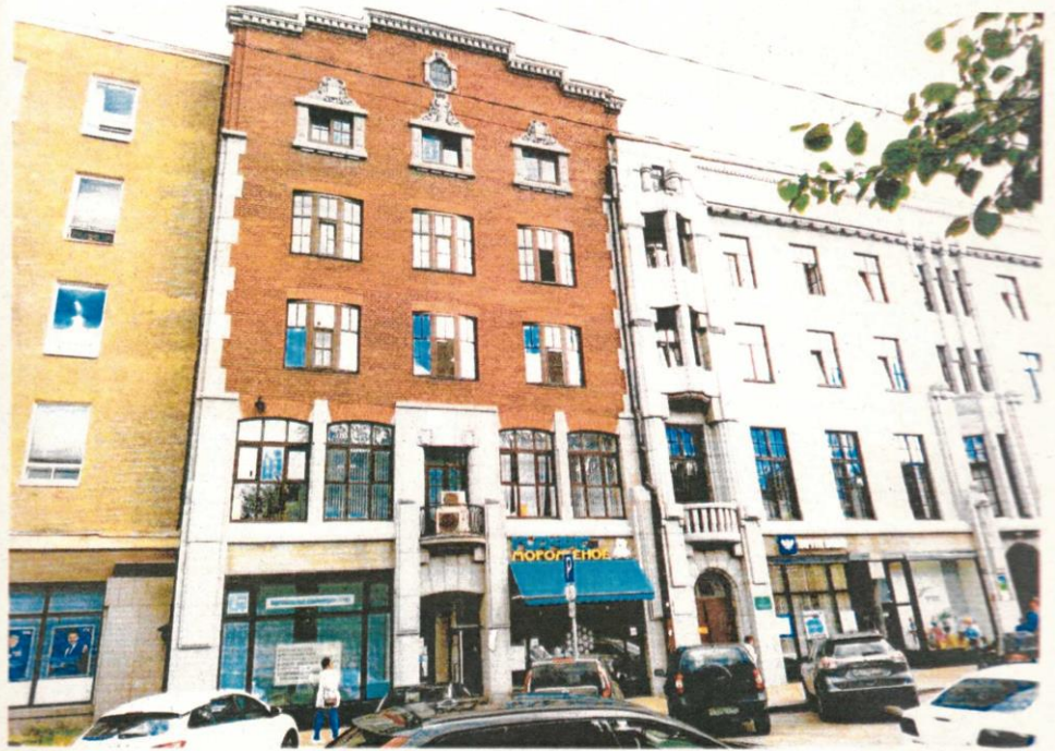
Фото 4. «Жилой и торговый дом «Карьяла». Часть фасада объекта по проспекту Ленина.
