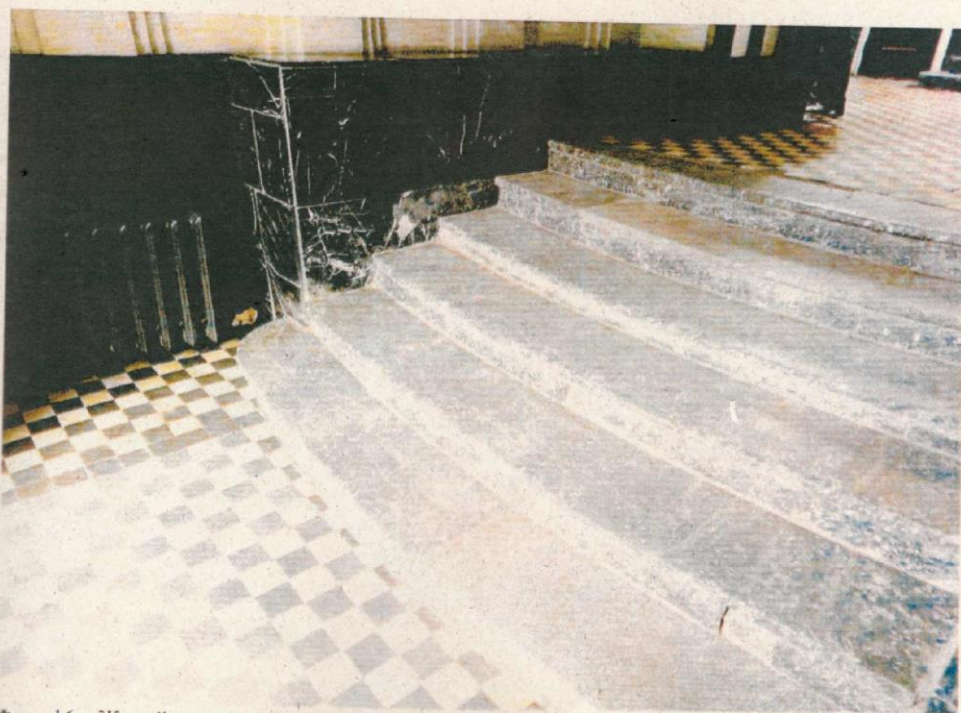
Фото 16. «Жилой и торговый дом «Карьяла». Мраморная лестница и метлахская плитка пола на входе в банк.
