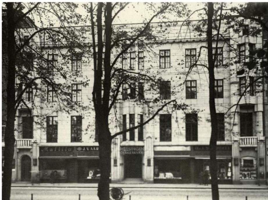
33. Здание Хельсинкского акционерного банка, вид из парка Торккелинпуйсто. Фотография. 1930-е гг. Музейное ведомство Финляндии.
