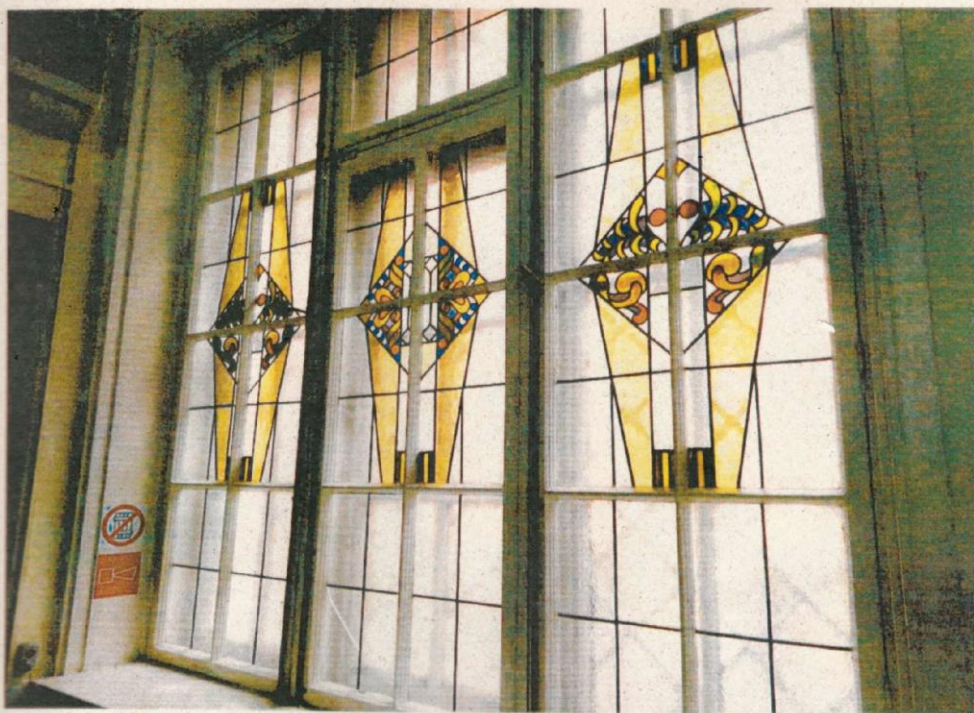
Фото 22. «Жилой и торговый дом «Карьяла». Витражное заполнение оконного проема операционного зала.
