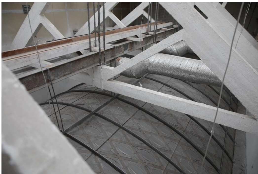
13. Объект культурного наследия регионального значения «Жилой и торговый дом «Карьяла» по адресу: Ленинградская область, Выборгский район, город Выборг, проспект Ленина, д.12/10. Вид на витражный свод сверху (со стороны ходовых мостков на входе в помещение в пространстве между витражом и световым фонарем).
