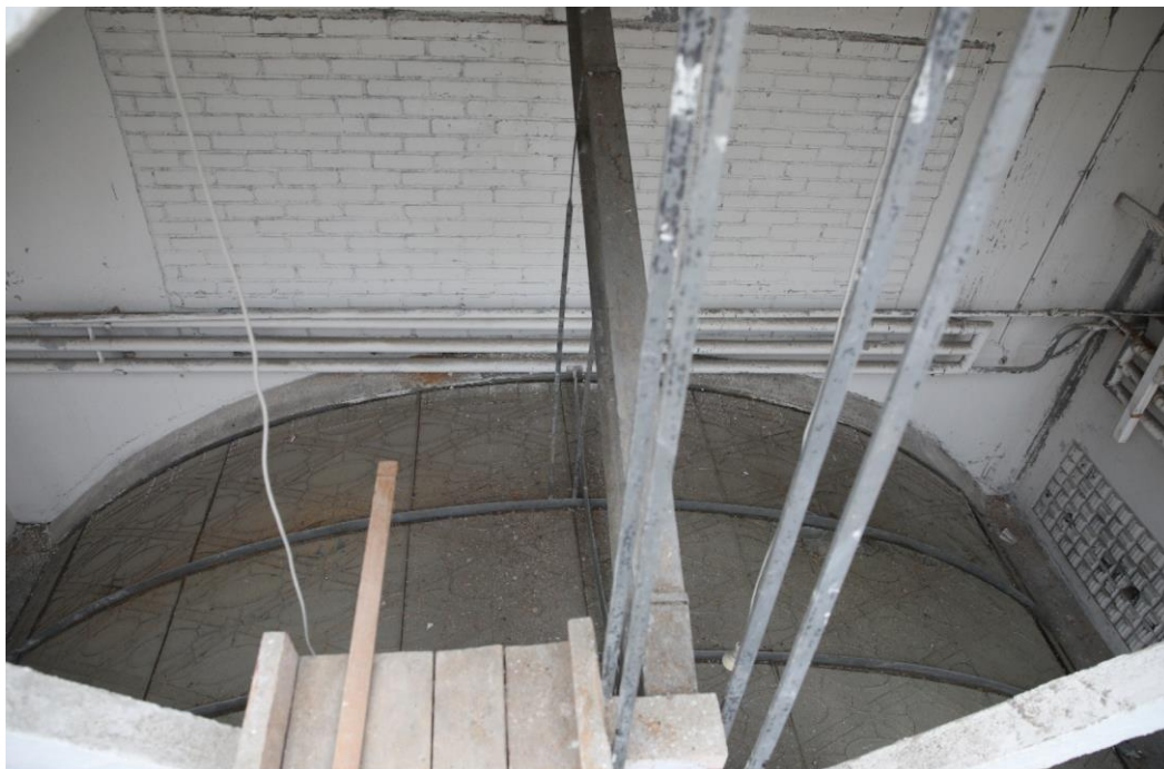
12. Объект культурного наследия регионального значения «Жилой и торговый дом «Карьяла» по адресу: Ленинградская область, Выборгский район, город Выборг, проспект Ленина, д.12/10. Вид на витраж сверху (с ходовых мостков в пространстве между витражом и световым фонарем).
