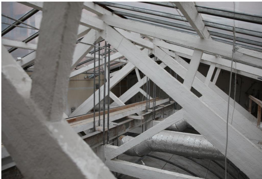
14. Объект культурного наследия регионального значения «Жилой и торговый дом «Карьяла» по адресу: Ленинградская область, Выборгский район, город Выборг, проспект Ленина, д.12/10. Конструкции кровли и светового фонаря над витражом.
