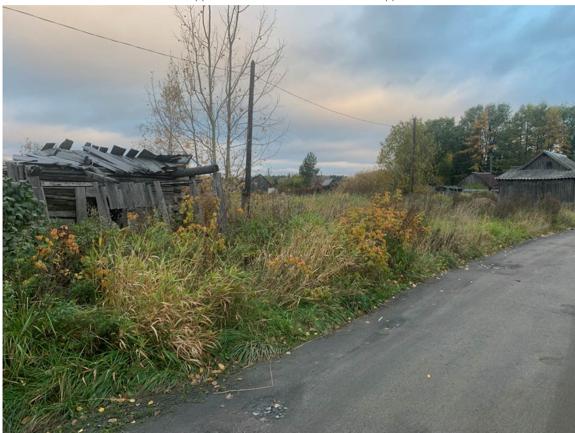
Рис. 47. Ленинградская область, Приозерский район, поселок Починок. Общий вид участка обследования. Точка съемки 18. Вид с ЮВ.
