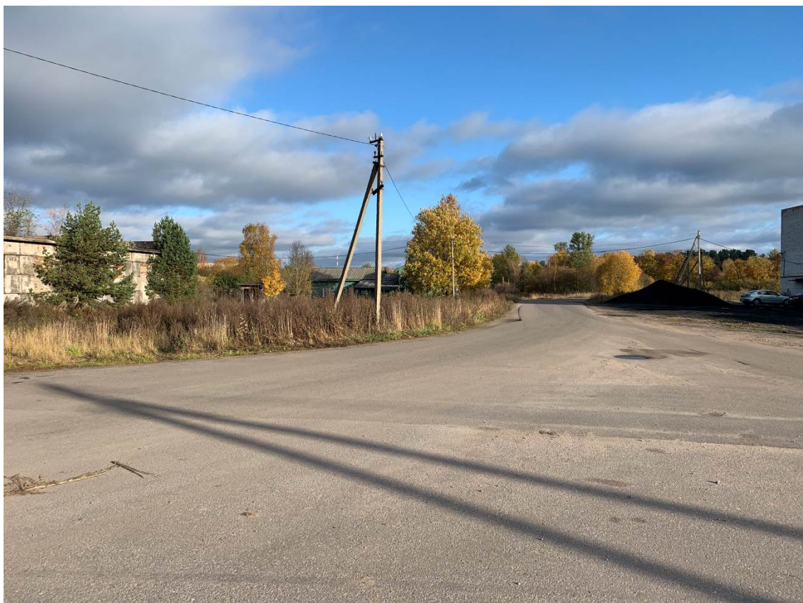
Рис. 70. Ленинградская область, Приозерский район, поселок Починок. Общий вид участка обследования. Точка съемки 28. Вид с Ю.
