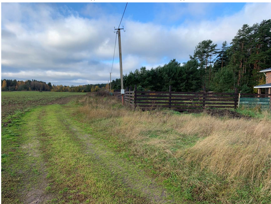
Рис. 75. Ленинградская область, Приозерский район, поселок Починок. Общий вид участка обследования. Точка съемки 30. Вид с СВ.
