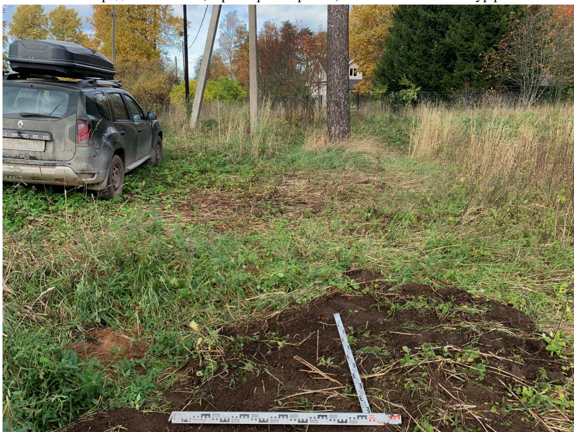
Рис. 85. Ленинградская область, Приозерский район, поселок Починок. Месторасположение Шурфа 2. После рекультивации. Вид с Ю.
