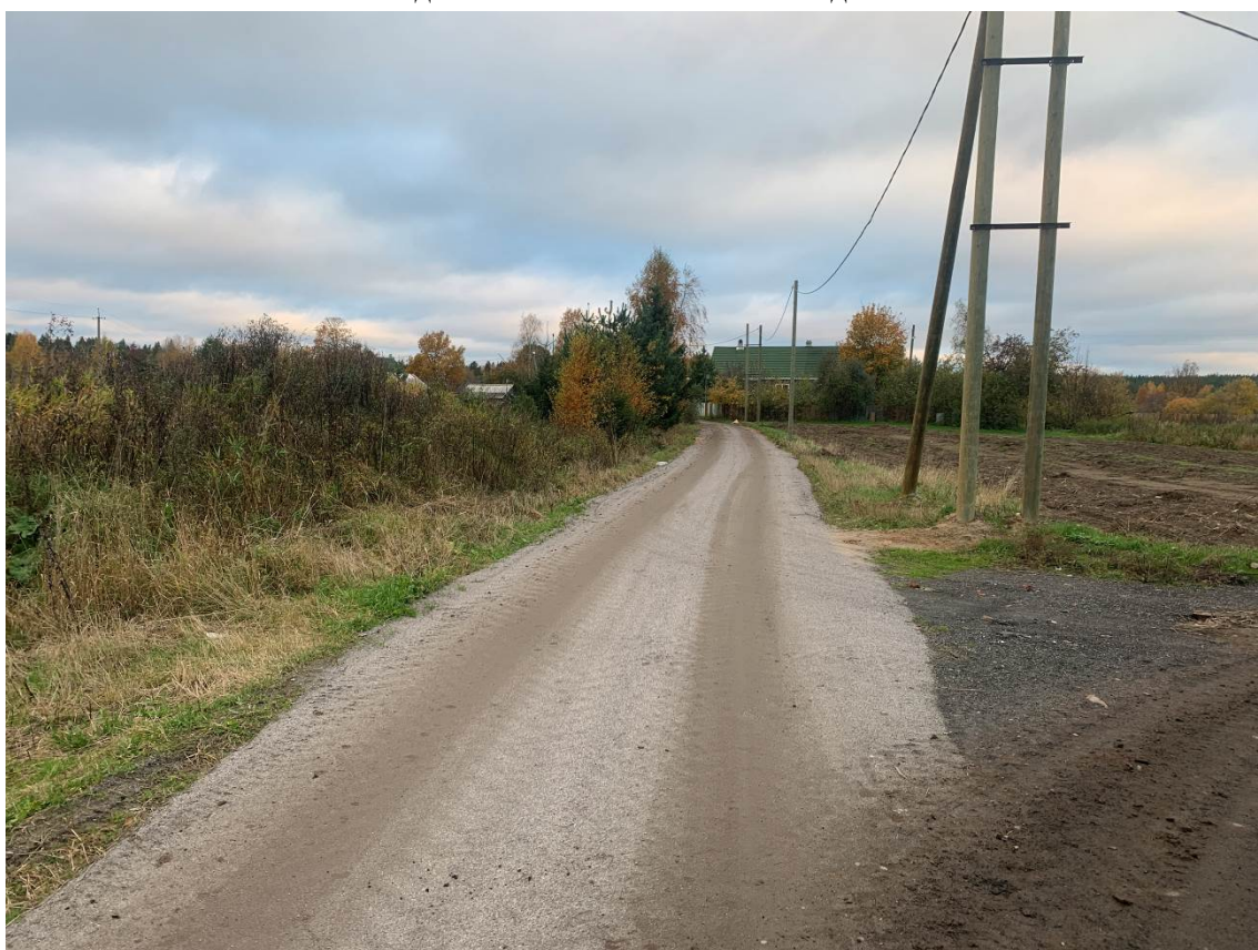
Рис. 57. Ленинградская область, Приозерский район, поселок Починок. Общий вид участка обследования. Точка съемки 21. Вид с ЮВ.
