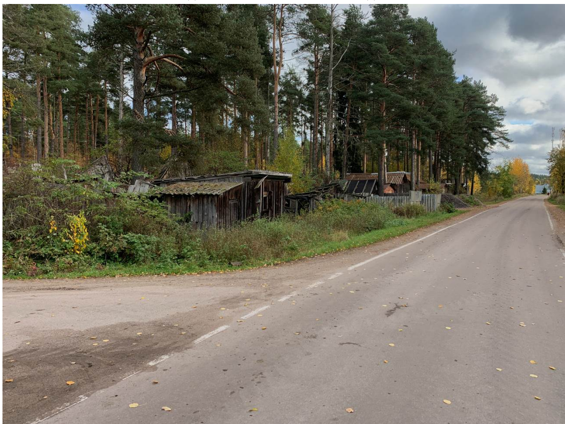
Рис. 19. Ленинградская область, Приозерский район, поселок Починок. Общий вид участка обследования. Точка съемки 6. Вид с СЗ.
