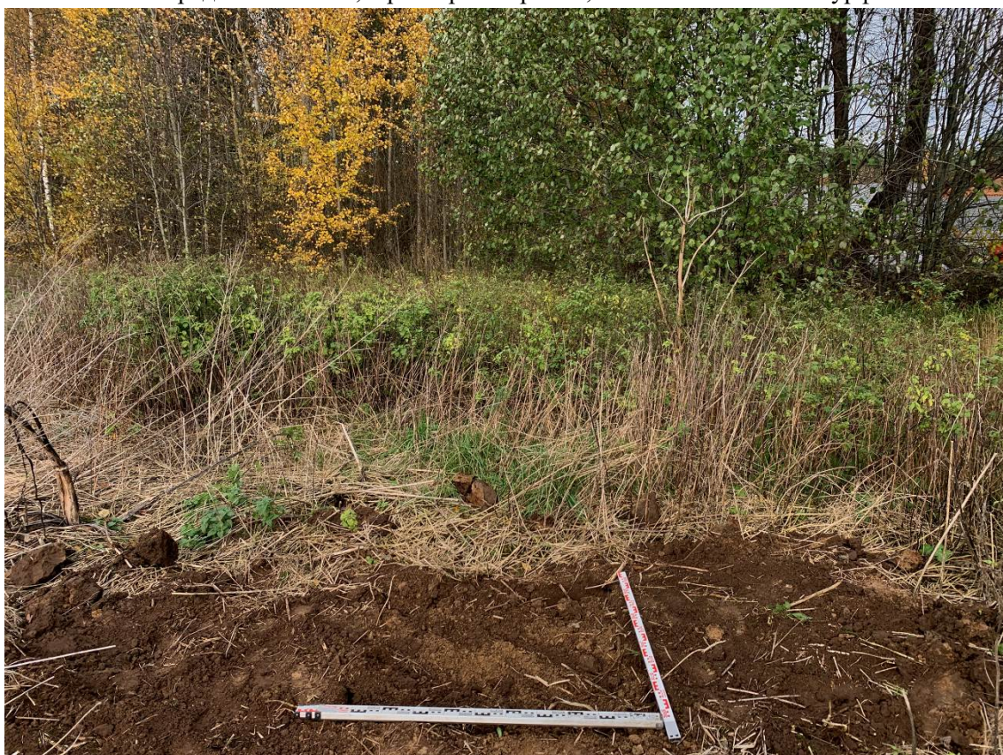
Рис. 80. Ленинградская область, Приозерский район, поселок Починок. Месторасположение Шурфа 1. После рекультивации. Вид с Ю.
