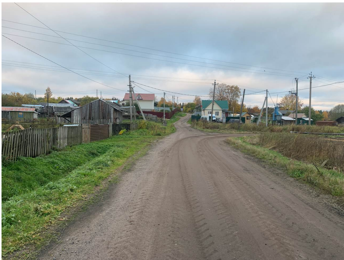
Рис. 53. Ленинградская область, Приозерский район, поселок Починок. Общий вид участка обследования. Точка съемки 20. Вид с В.
