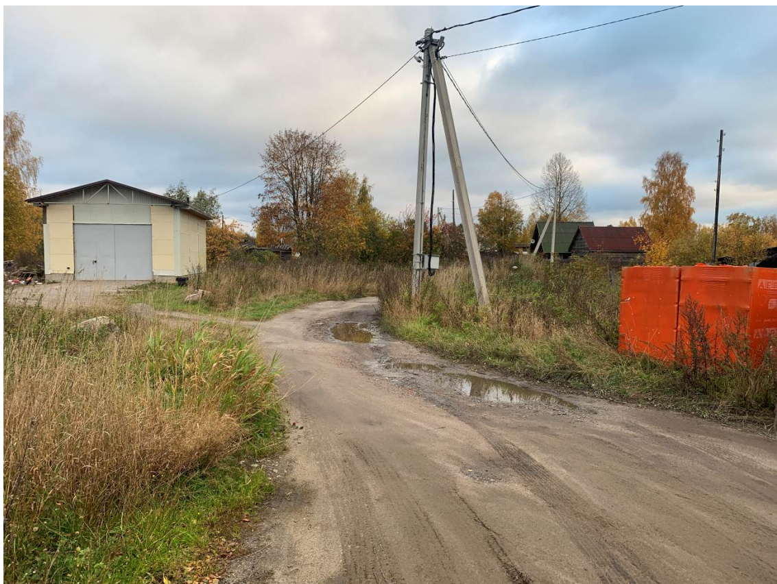
Рис. 64. Ленинградская область, Приозерский район, поселок Починок. Общий вид участка обследования. Точка съемки 25. Вид с Ю.
