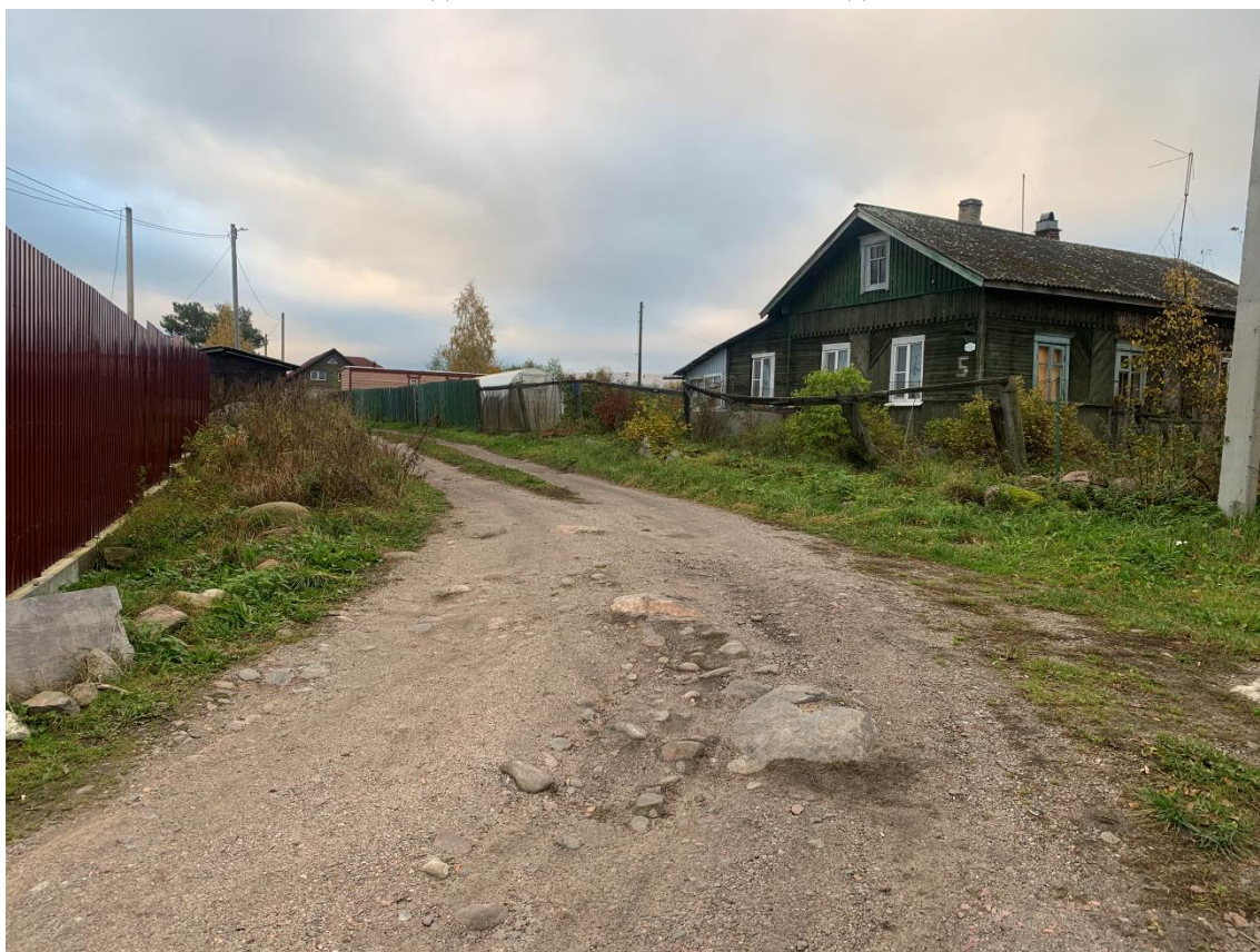
Рис. 61. Ленинградская область, Приозерский район, поселок Починок. Общий вид участка обследования. Точка съемки 23. Вид с СВ.
