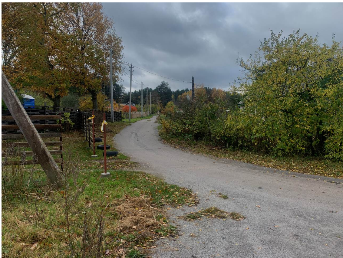
Рис. 9. Ленинградская область, Приозерский район, поселок Починок. Общий вид участка обследования. Точка съемки 1. Вид с СВ.
