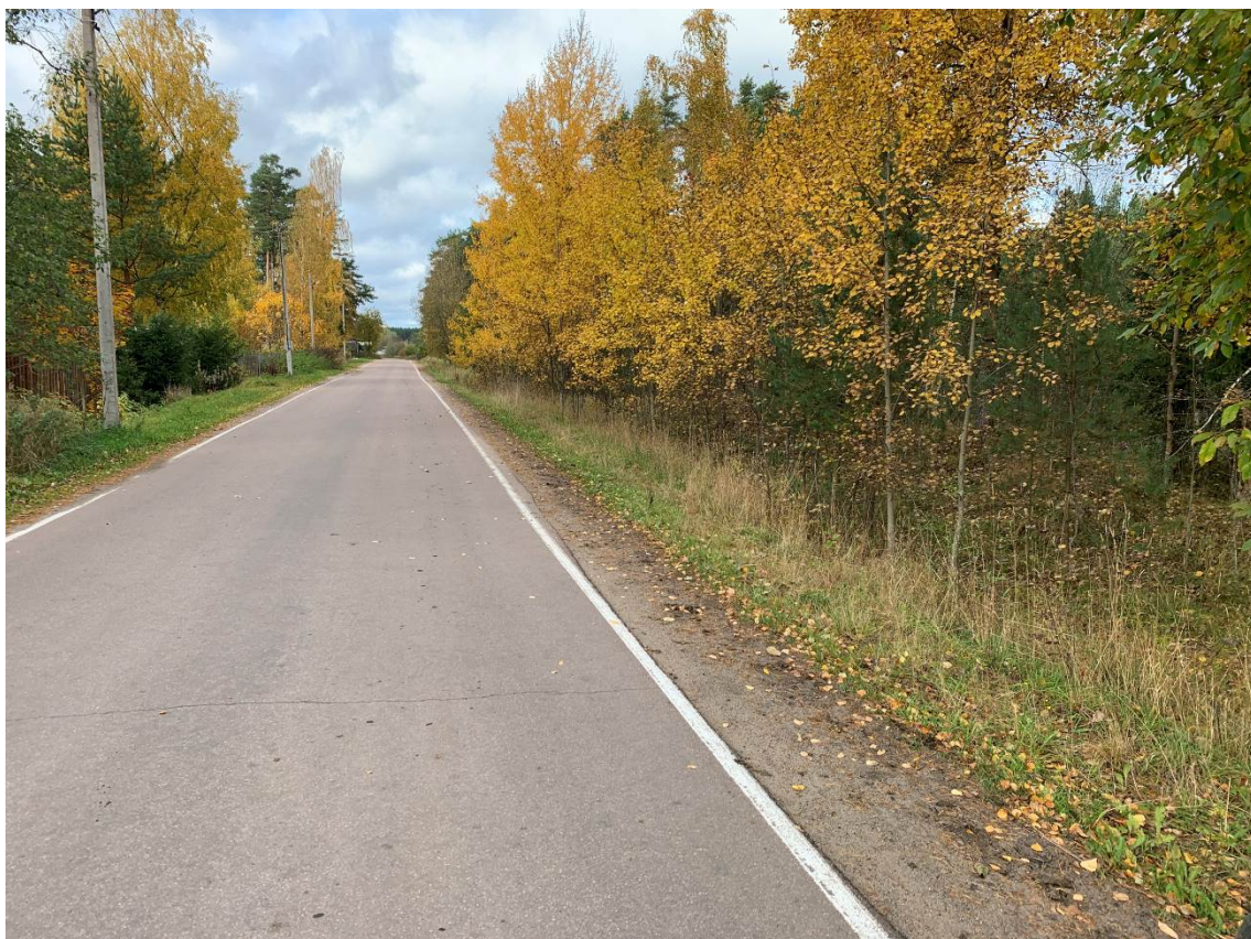
Рис. 18. Ленинградская область, Приозерский район, поселок Починок. Общий вид участка обследования. Точка съемки 5. Вид с ЮВ.
