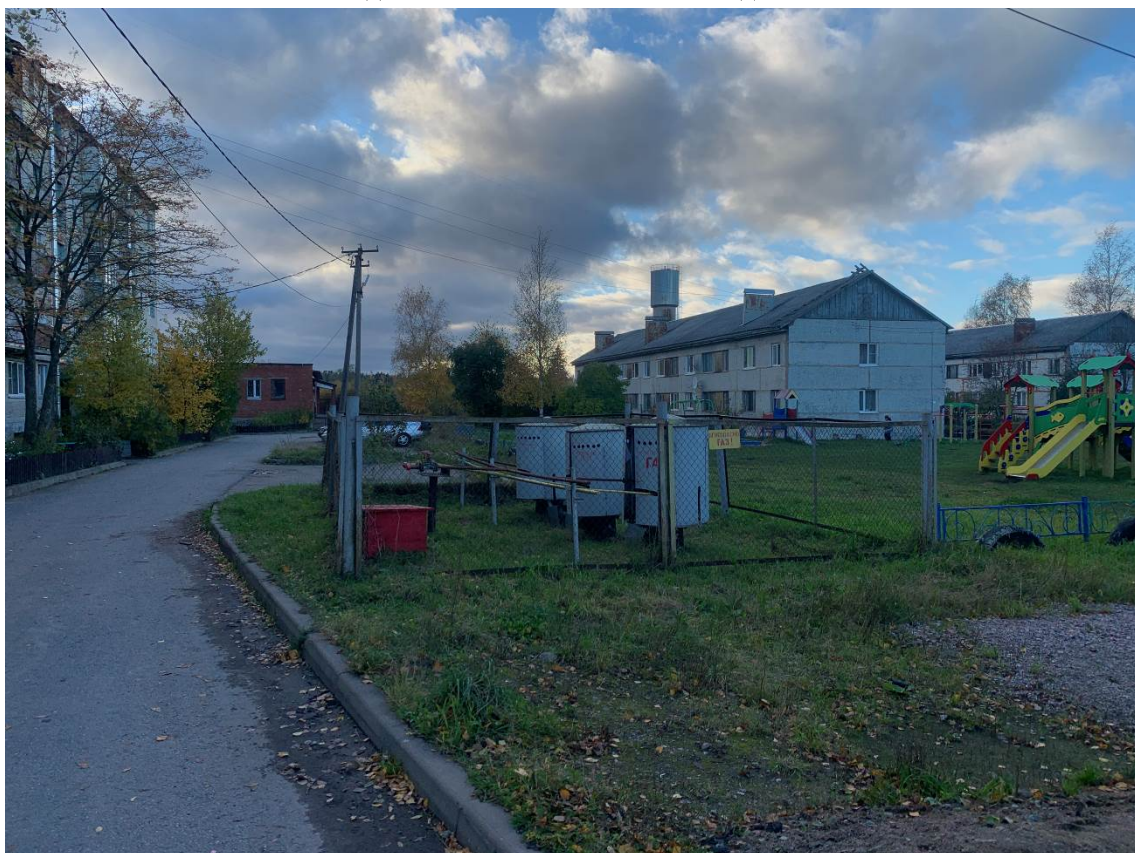
Рис. 33. Ленинградская область, Приозерский район, поселок Починок. Общий вид участка обследования. Точка съемки 12. Вид с В.
