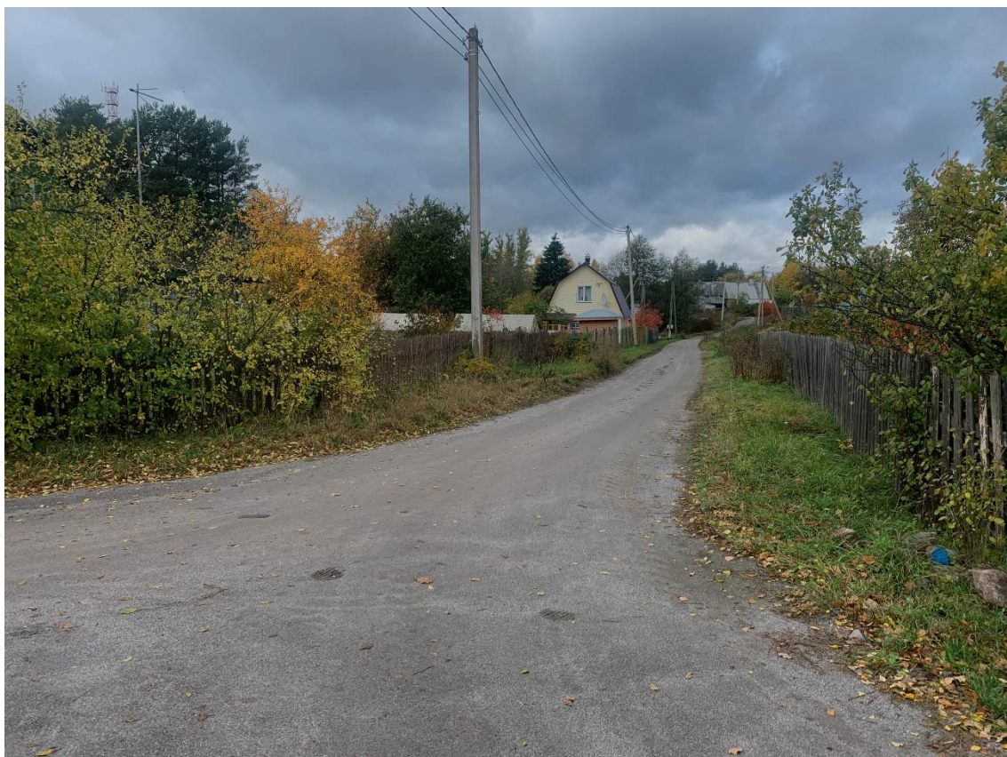
Рис. 10. Ленинградская область, Приозерский район, поселок Починок. Общий вид участка обследования. Точка съемки 1. Вид с В.
