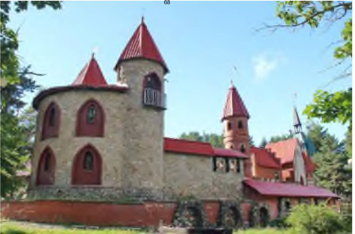
45 Выявленный ОКН «Детский игровой комплекс «Андерсенград», адрес: Ленинградская обл., г. Сосновый Бор, ул. Солнечная, д. 1. Амфитеатр «Дюймовочка». Южный и восточный фасады. Дата съемки: 19.07.2022 г.
