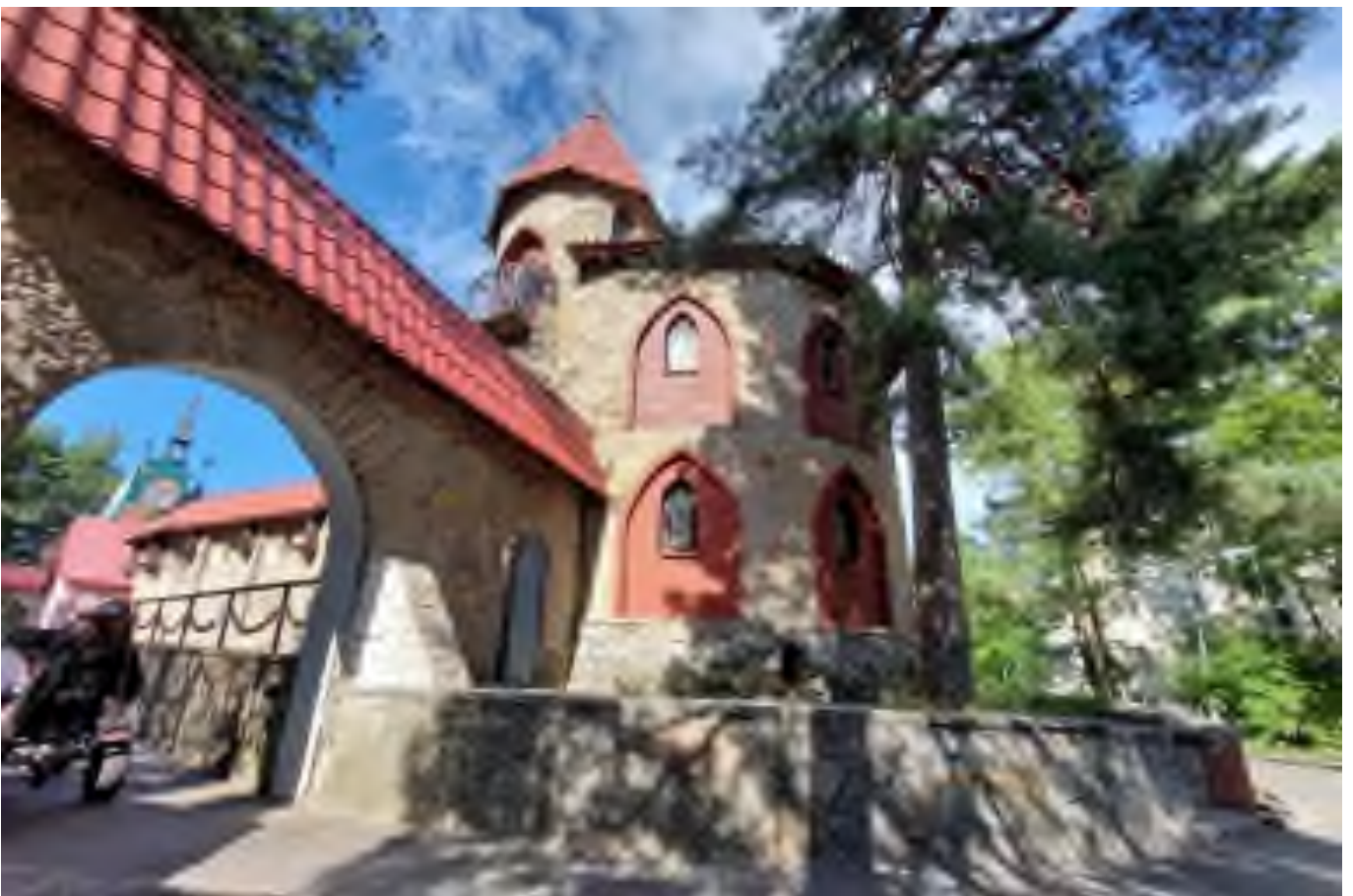
46 Выявленный ОКН «Детский игровой комплекс «Андерсенград», адрес: Ленинградская обл., г. Сосновый Бор, ул. Солнечная, д. 1. Амфитеатр «Дюймовочка». Западный и южный фасады. Дата съемки: 19.07.2022 г.
