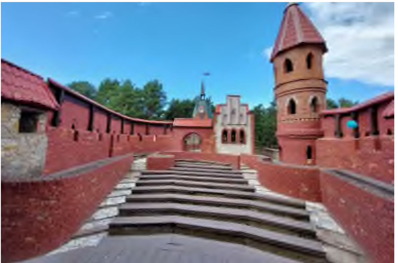
48 Выявленный ОКН «Детский игровой комплекс «Андерсенград», адрес: Ленинградская обл., г. Сосновый Бор, ул. Солнечная, д. 1. Амфитеатр «Дюймовочка». Вид на север на зрительный зал. Дата съемки: 19.07.2022 г.
