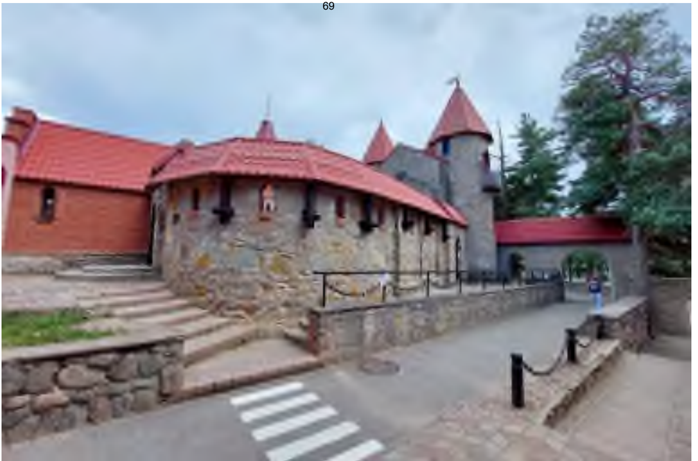
47 Выявленный ОКН «Детский игровой комплекс «Андерсенград», адрес: Ленинградская обл., г. Сосновый Бор, ул. Солнечная, д. 1. Амфитеатр «Дюймовочка». Северный и западный фасады стен ограждающих зрительный зал. Дата съемки: 19.07.2022 г.
