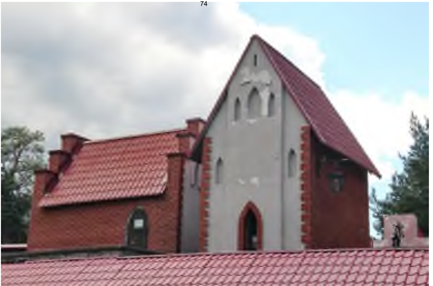
57 Выявленный ОКН «Детский игровой комплекс «Андерсенград», адрес: Ленинградская обл., г. Сосновый Бор, ул. Солнечная, д. 1. Домик Оле-Лукойе. Радиорубка. Восточный и северный фасады. Дата съемки: 19.07.2022 г.
