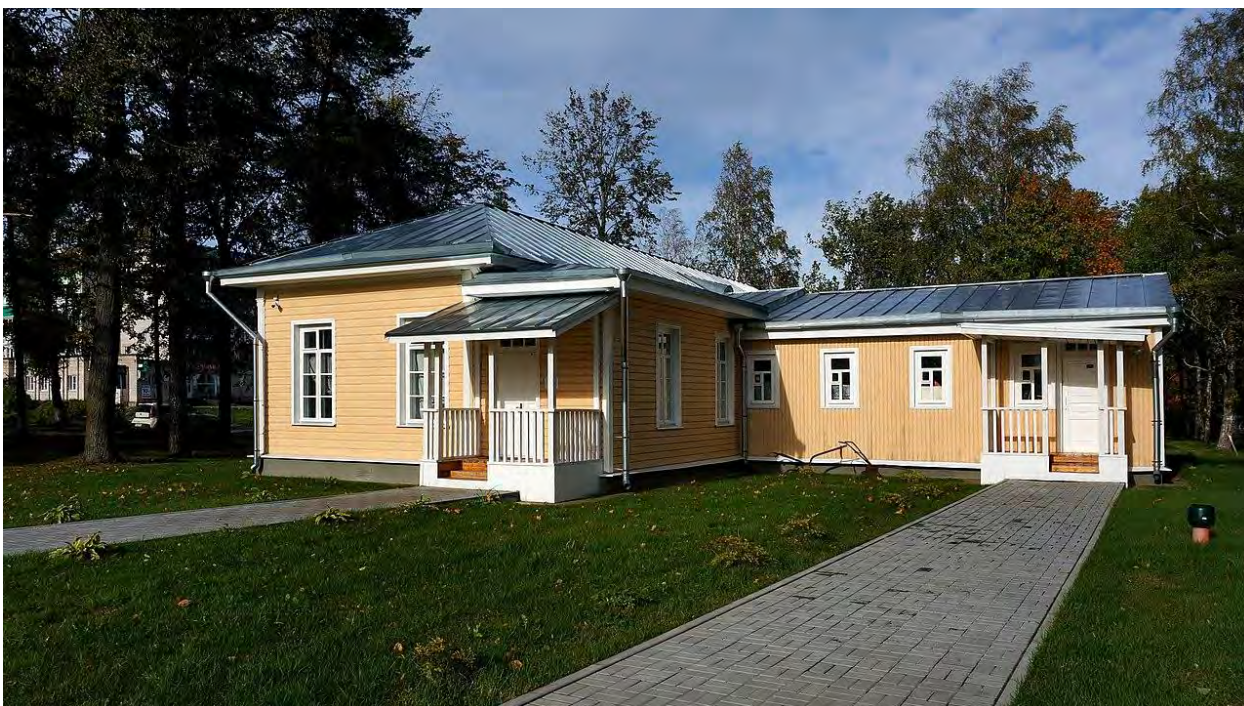
17. Ракурс дома с западной стороны (после реставрации). Фото 2018 года.
