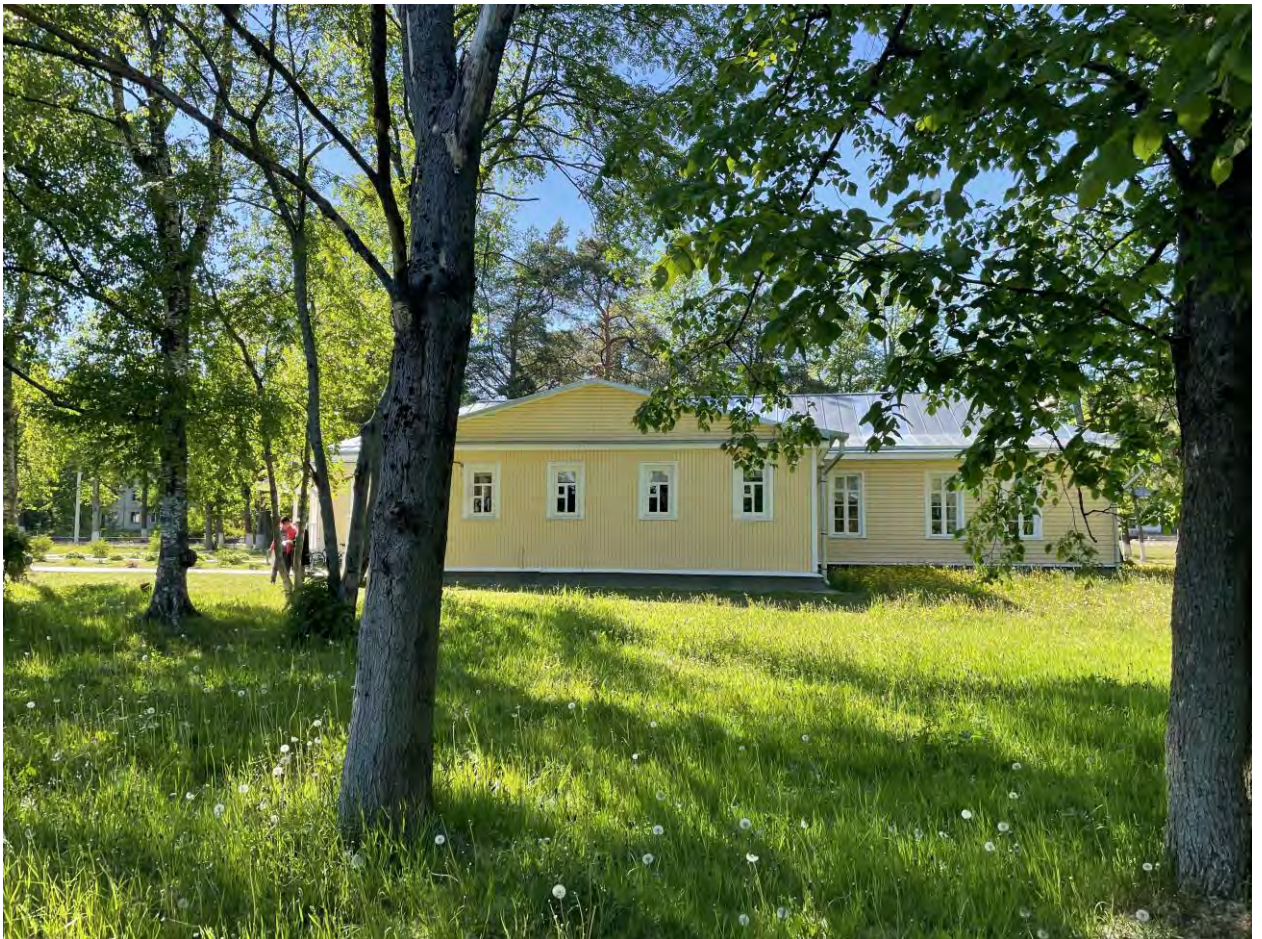
Фото 5. Вид на восточный фасад здания музея – объекта культурного наследия.
