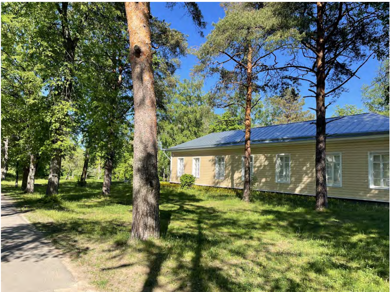
Фото 17. Западная часть территории проектирования и западный фасад здания музея.
