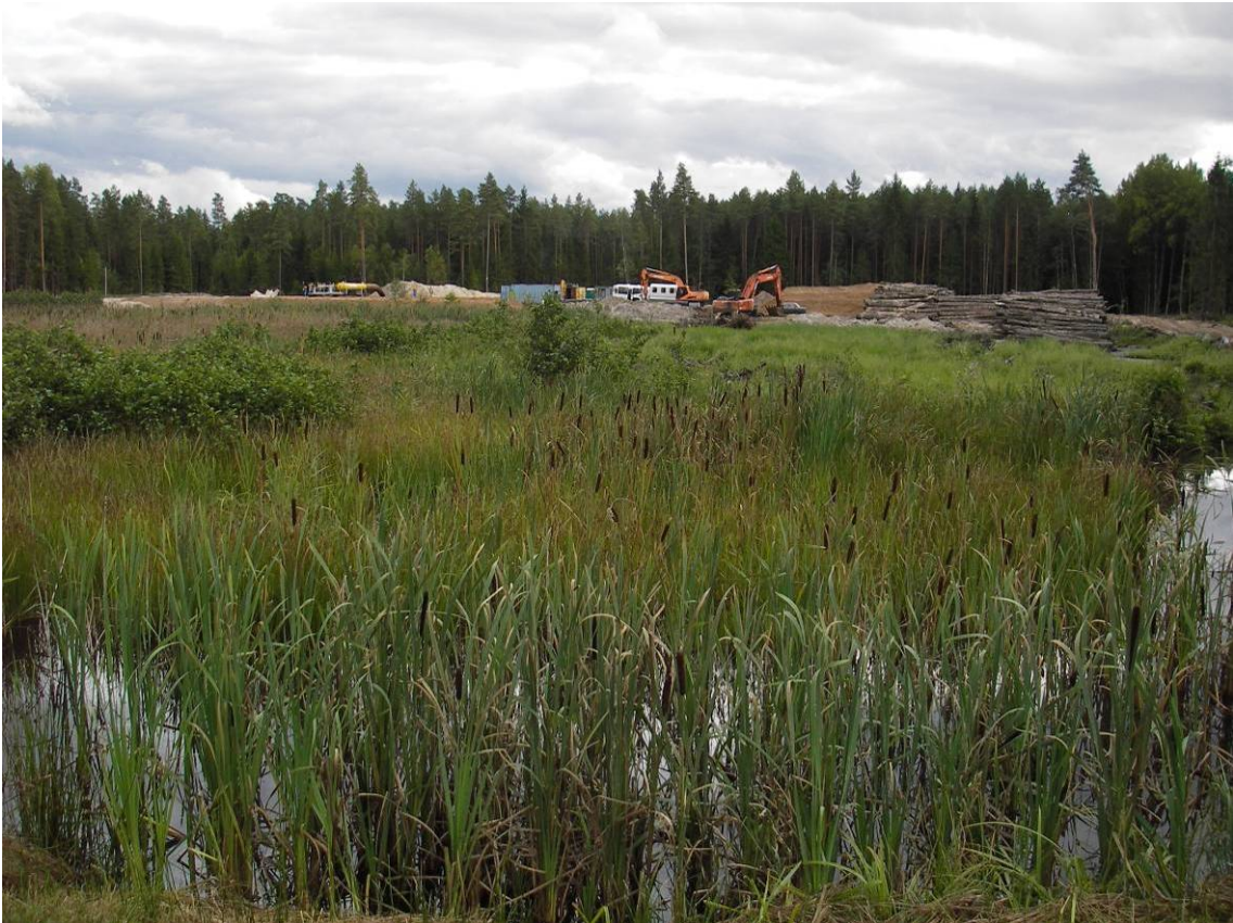
Рис. 147. Участок строительства технологической площадки (ТФ26). Вид с севера
