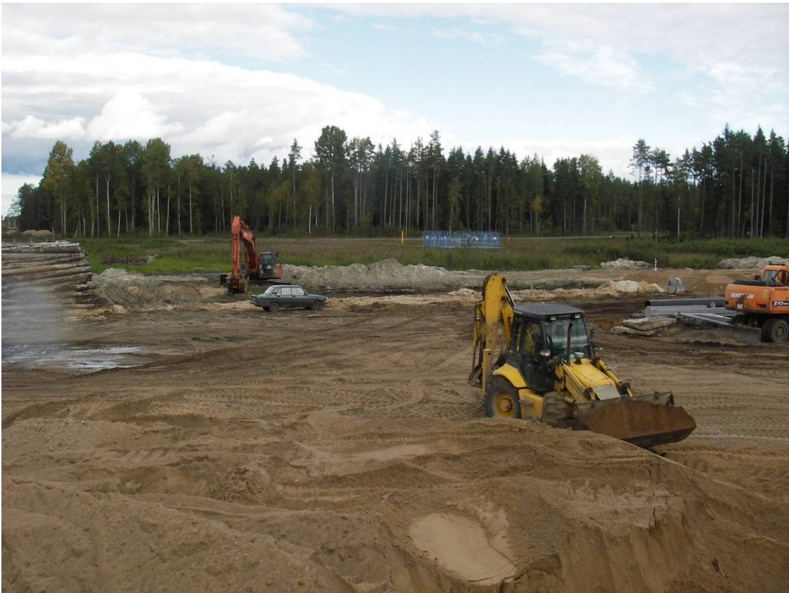
Рис. 144. Участок строительства технологической площадки (ТФ25). Вид с юга
