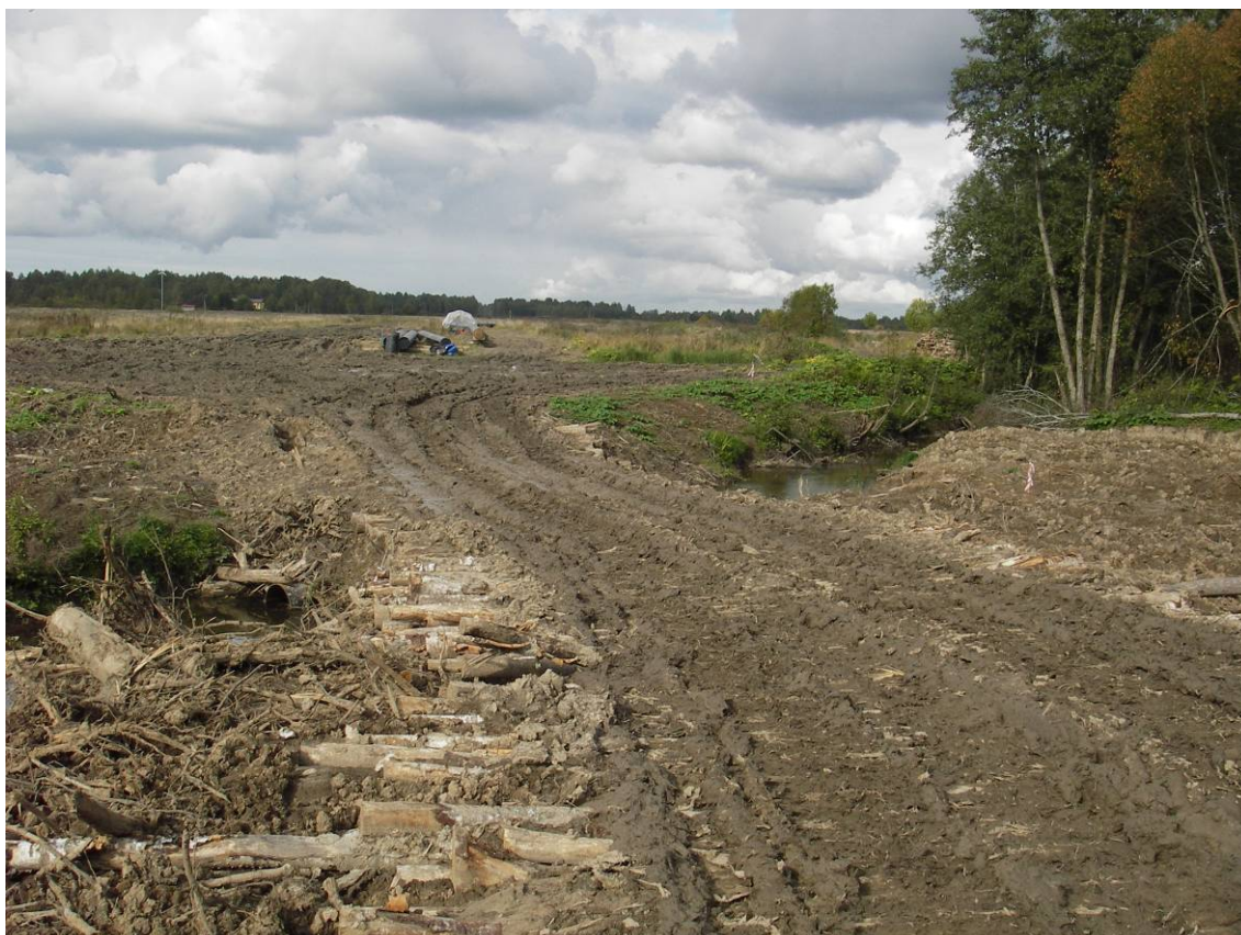
Рис. 94. Участок пересечения объектом обследования р. Нотика (ТФ14). Вид с юго-востока
