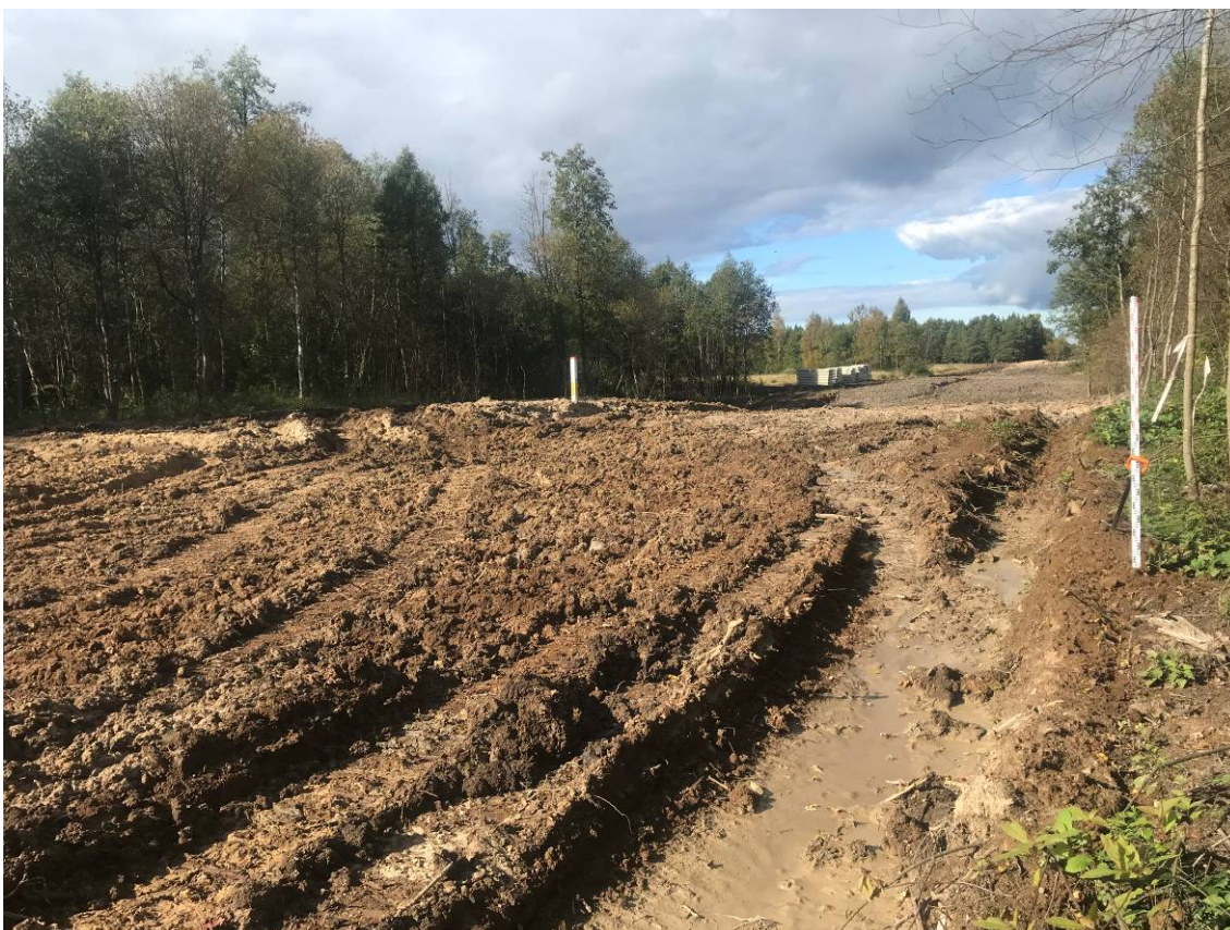
Рис. 103. Участок пересечения объектом обследования р. Оръевки (ТФ18). Вид с юго-востока
