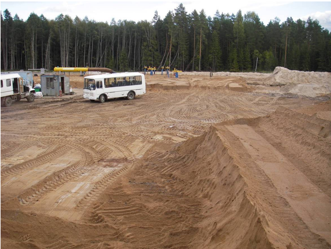
Рис. 145. Участок строительства технологической площадки (ТФ25). Вид с запада
