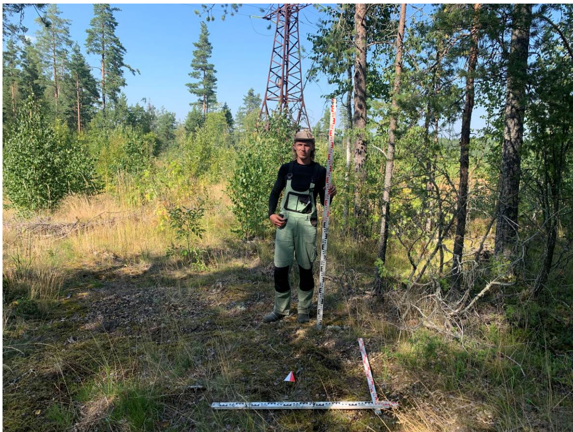
Илл. 77. Ленинградская обл., Приозерский район, Севастьяновское сельское поселение. Месторасположение Шурфа 5. До начала работ. Вид с Ю.
