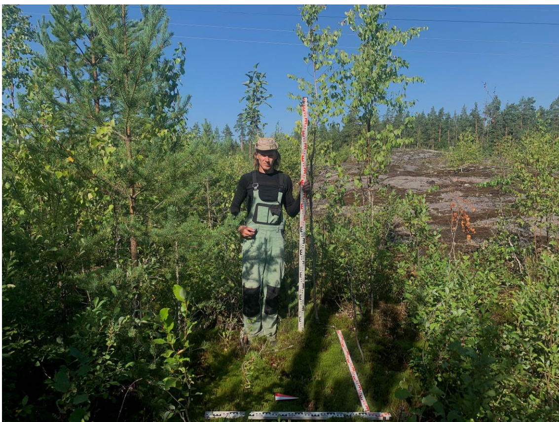
Илл. 67. Ленинградская обл., Приозерский район, Севастьяновское сельское поселение. Месторасположение Шурфа 3. До начала работ. Вид с В.
