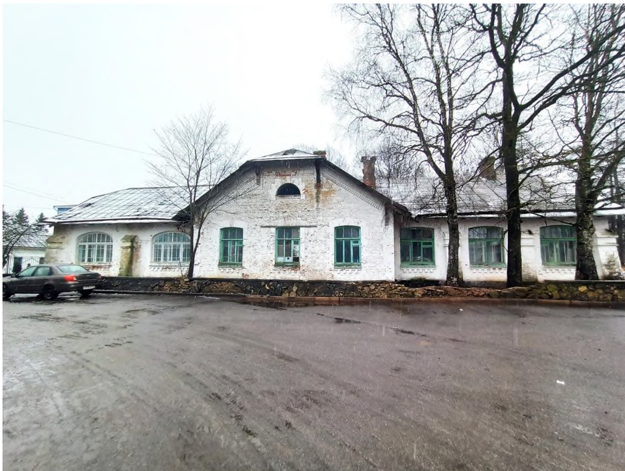
73. Каменная дача (административное здание). Восточный фасад. Общий вид
