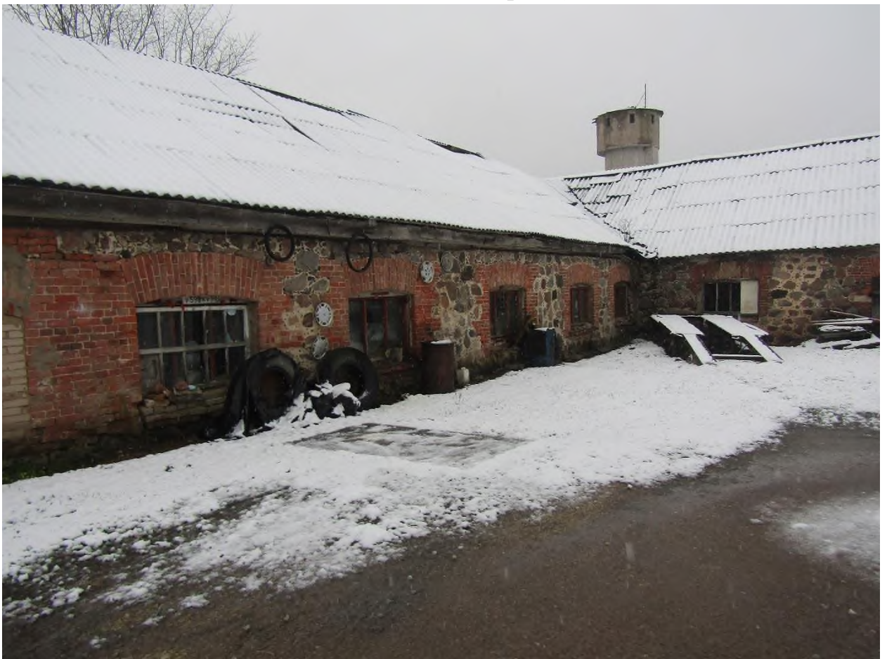
141. Скотный двор. Фрагмент восточной части. Вид с северо-востока
