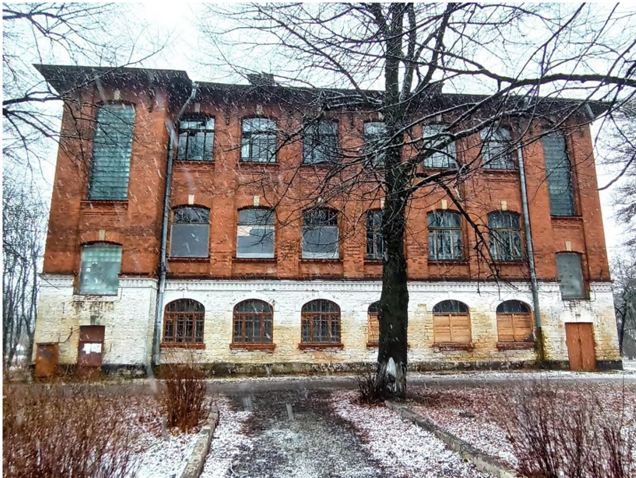
17. Здание сельскохозяйственного (земского) училища. Южный фасад
