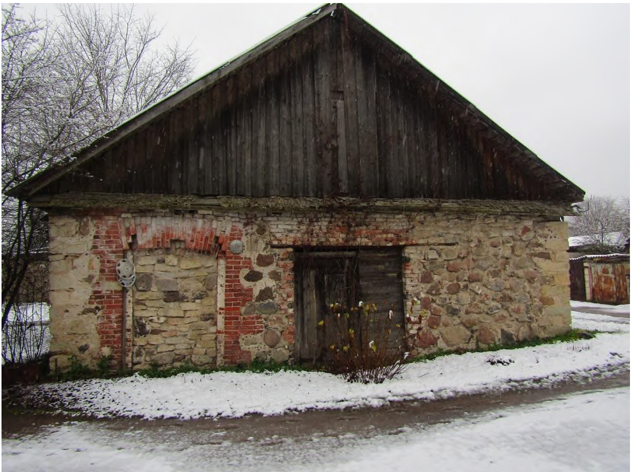
139. Скотный двор. Фрагмент восточного фасада.
