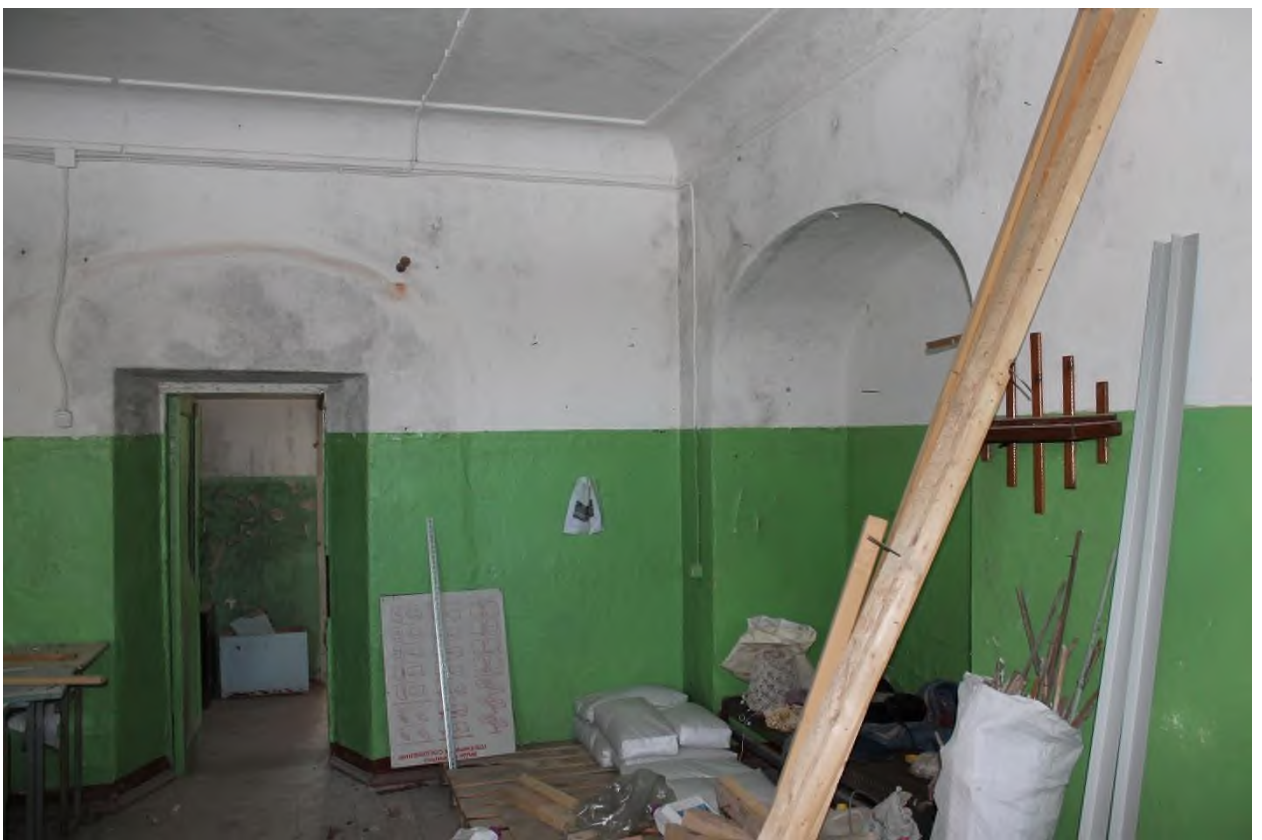
28. Здание сельскохозяйственного (земского) училища. Интерьер. Одно из помещений 1-го этажа
