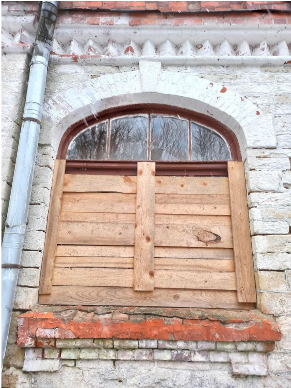
5. Фрагмент северного фасада здания сельскохозяйственного (земского) училища. Оконный проем 1-го этажа
