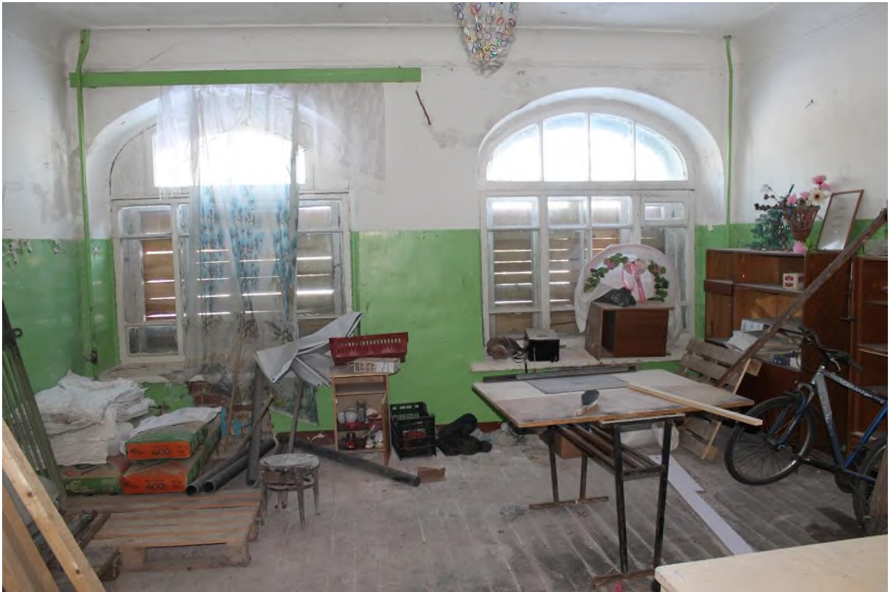
27. Здание сельскохозяйственного (земского) училища. Интерьер. Одно из помещений 1-го этажа
