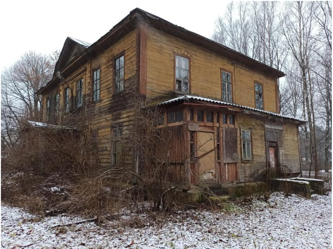
51. Жилой (деревянный) дом. Общий вид с юго-востока
