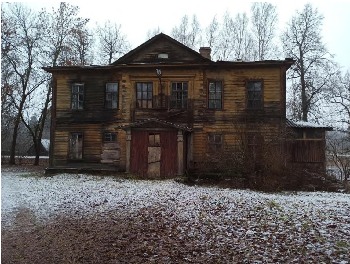
49. Жилой (деревянный) дом. Южный фасад.
