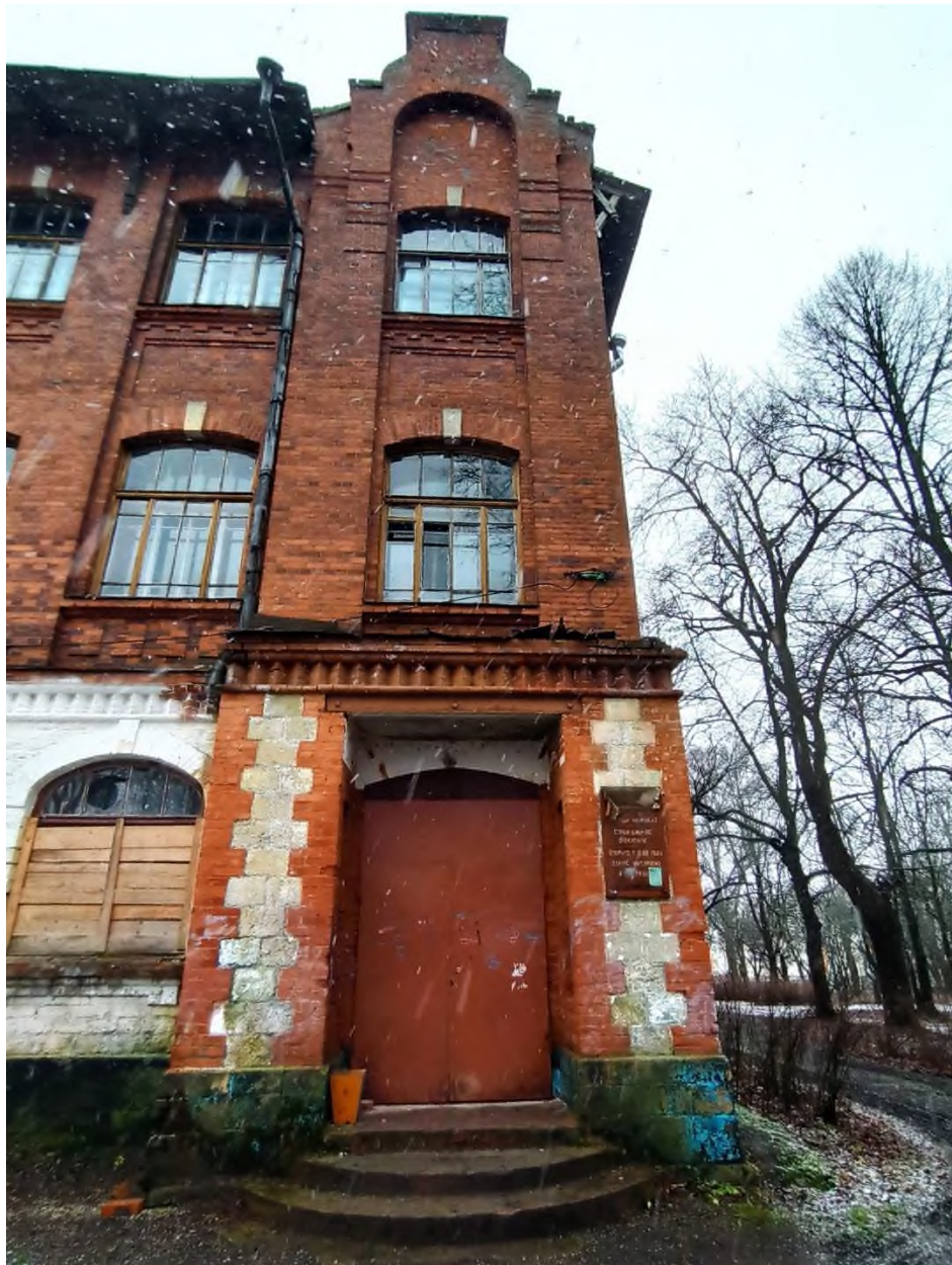
6. Фрагмент северного фасада здания сельскохозяйственного (земского) училища. Главный вход
