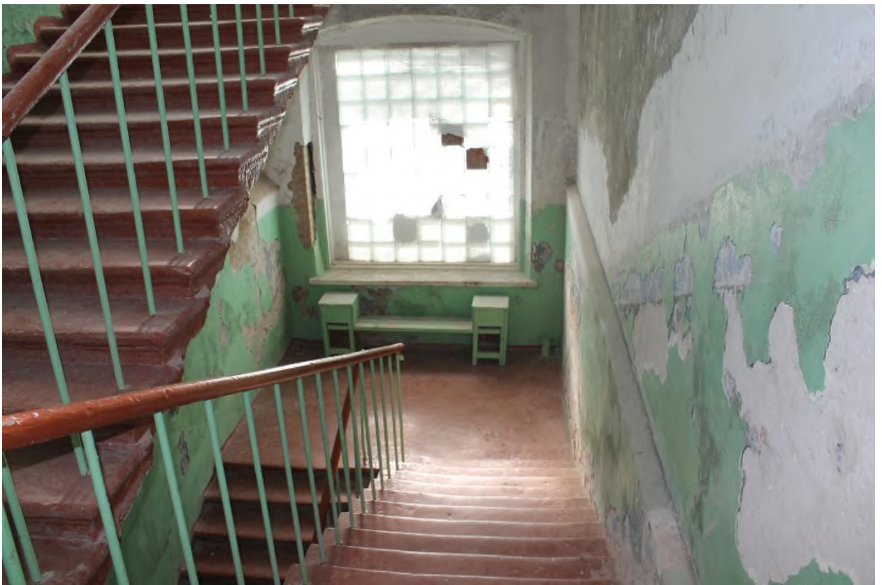
34. Здание сельскохозяйственного (земского) училища. Лестница в западной части здания. Вид с площадки 2-го этажа
