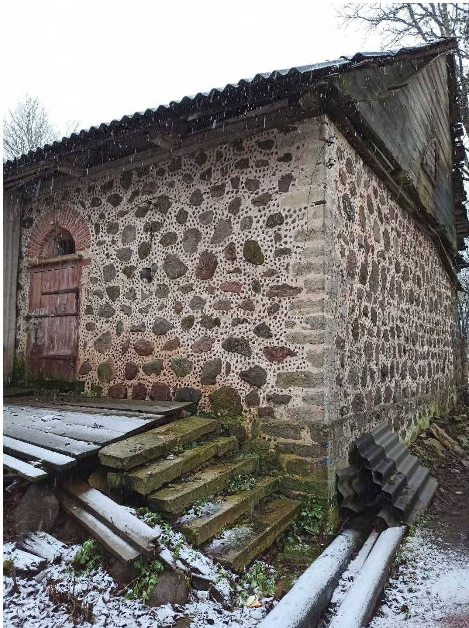
95. Службная постройка (амбар). Фрагмент северного фасада. Кладка
