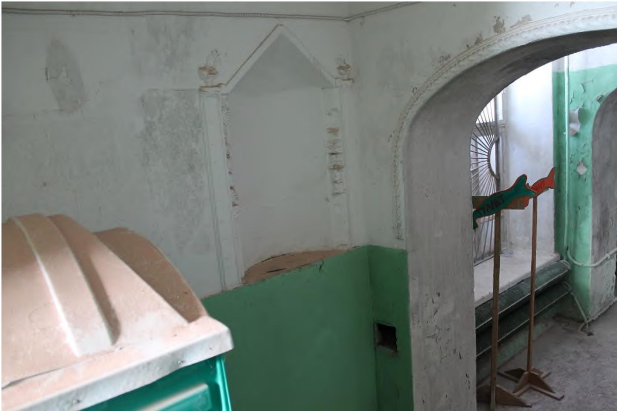
25. Здание сельскохозяйственного (земского) училища. Интерьер. Ниша в стене площадки 1-го этажа на западной лестнице
