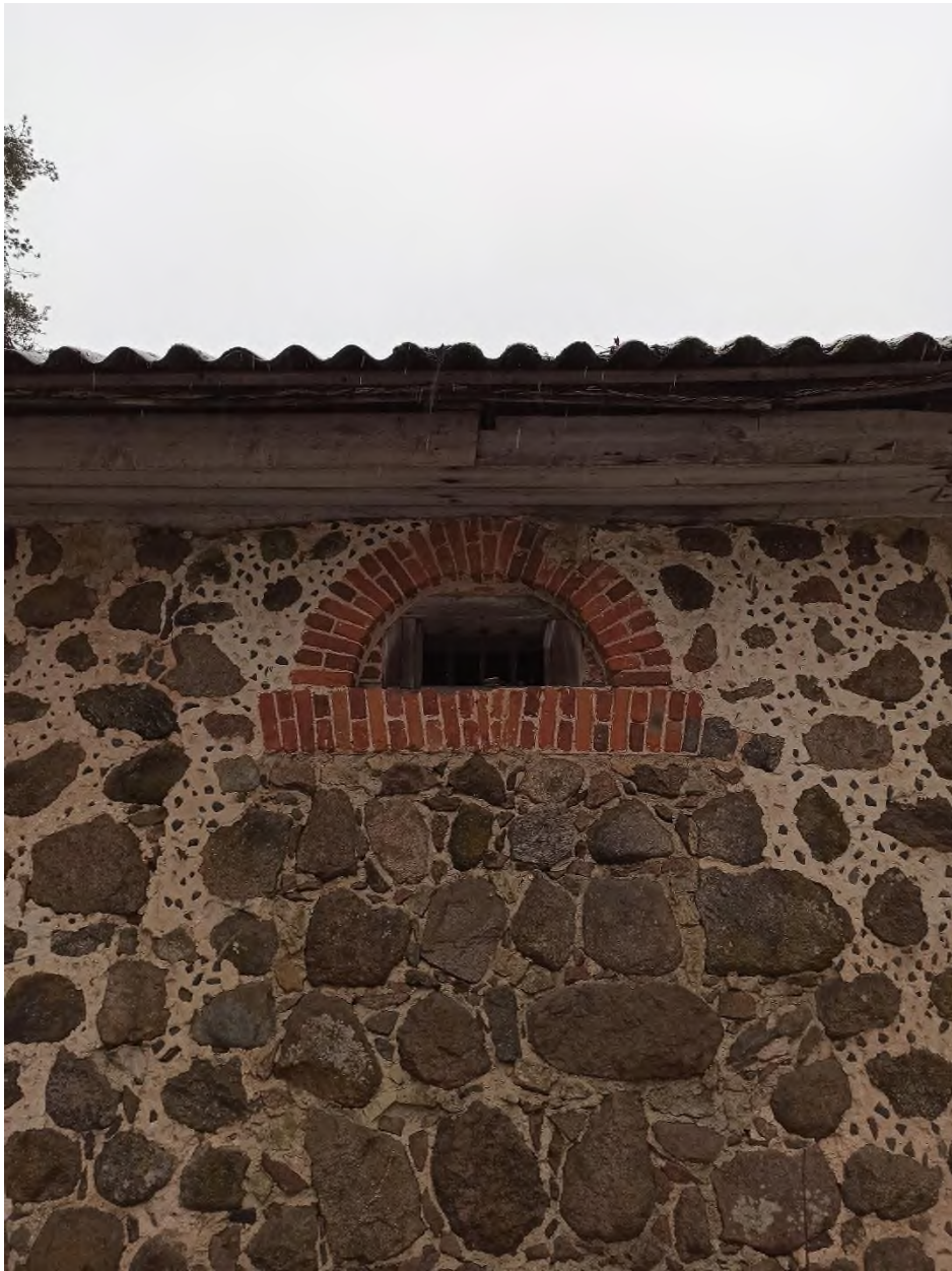
99. Служебная постройка (амбар). Деталь западного фасада - полуциркульное окно в верхней части
