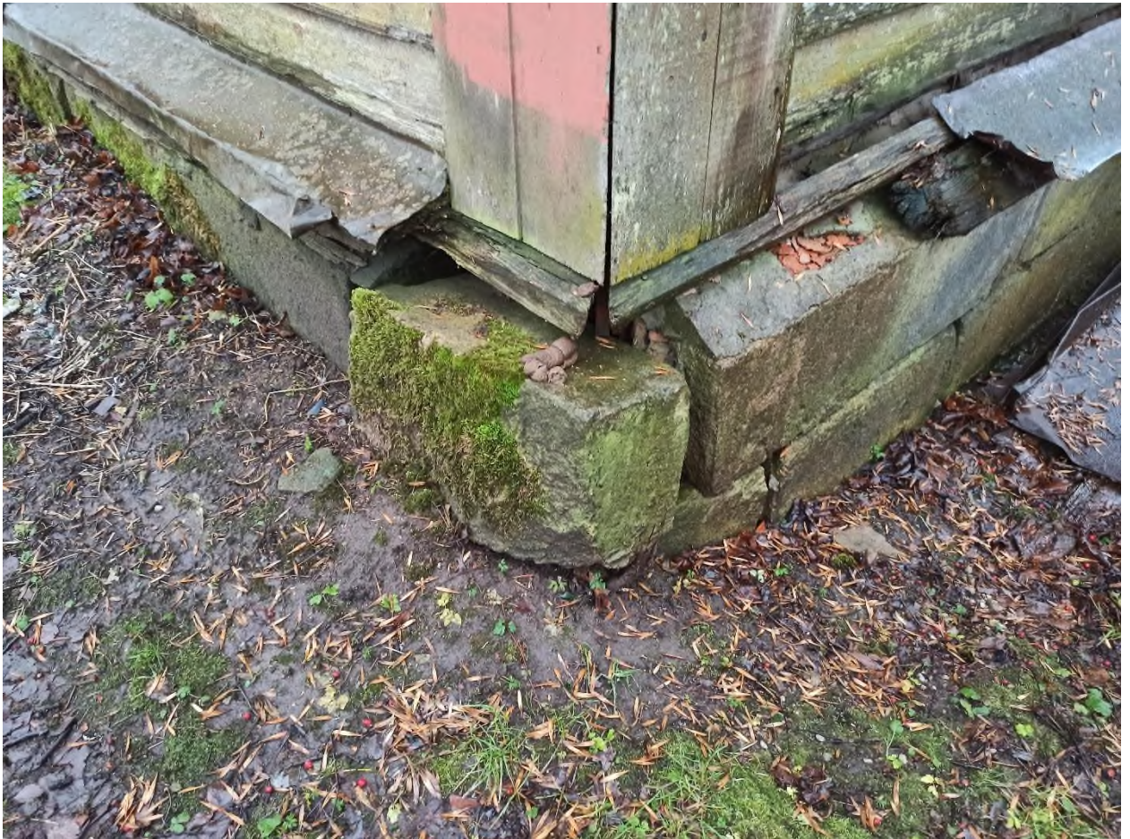
58. Жилой (деревянный) дом. Деталь цоколя из белокаменных блоков
