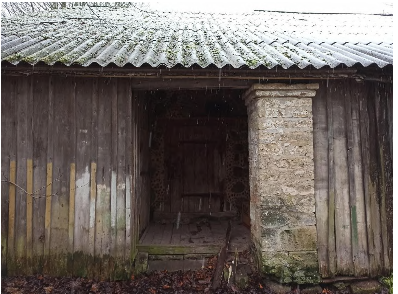
97. Служебная постройка (амбар). Фрагмент восточного фасада
