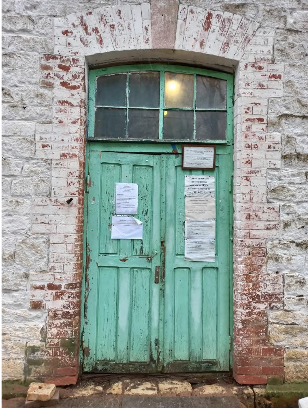
81. Каменная дача (административное здание). Фрагмент западного фасада. Входная дверь с остекленной фрамугой
