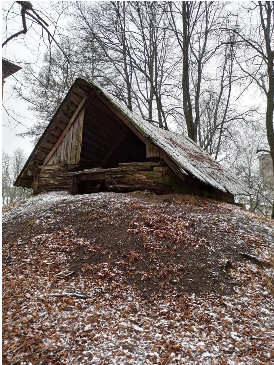
63. Хозяйственная постройка (погреб) на территории парка. Вид с юго-запада
