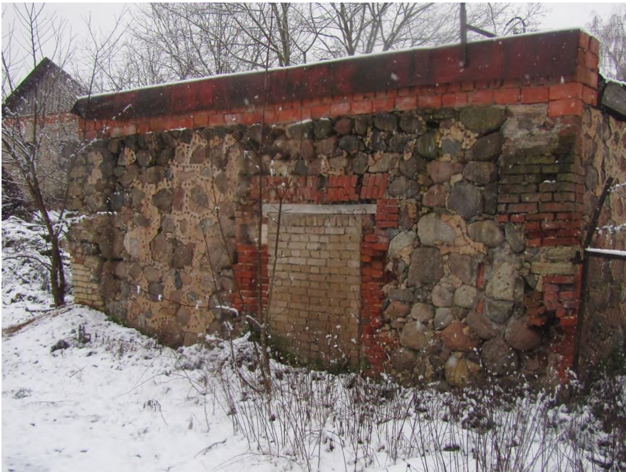
128. Фрагмент фасада скотного двора
