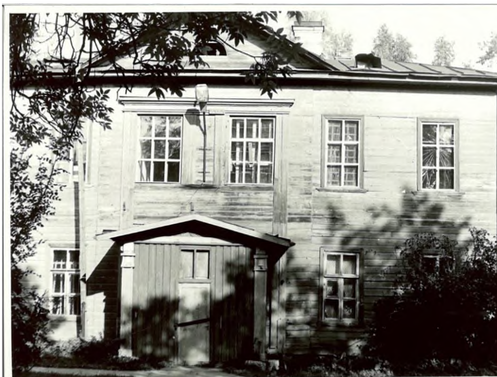
12. 1989 г. Двухэтажный деревянный дом (бывший господский). Фото из паспорта выявленного памятника истории и культуры «Комплекс усадьбы и земского училища. Парк». 1990 г. Архив Комитета по сохранению культурного наследия Ленинградской области
