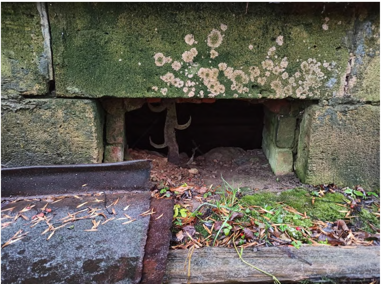
59. Жилой (деревянный) дом. Деталь западного фасада - кованые решетки из металлической полосы в окне полуподвала
