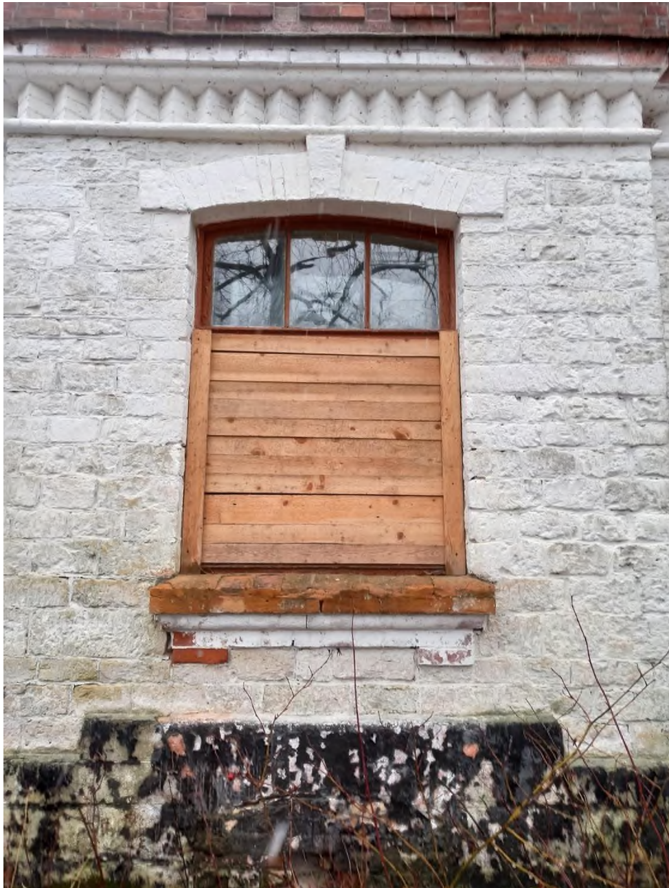
11. Здание сельскохозяйственного (земского) училища. Оконный проем 1-го этажа на западном фасаде
