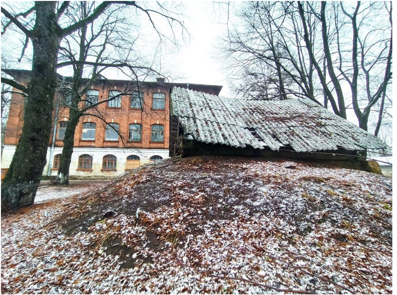
64. Общий вид хозяйственной постройки (погребa) в составе парка и здания земского сельскохозяйственного училища с юго-востока
