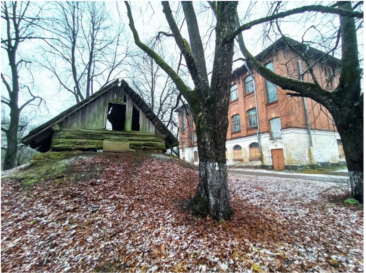
68. Общий вид хозяйственной постройки (погреба) в составе парка и здания земского сельскохозяйственного училища с востока
