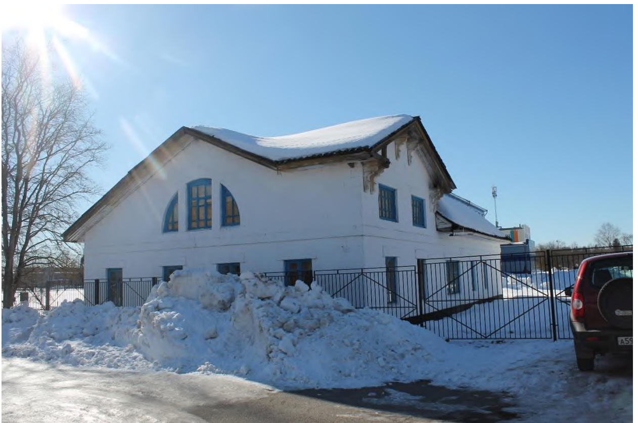
117. Каменный корпус у перекрестка дорог (баня и столовая). Общий вид с северо-востока
