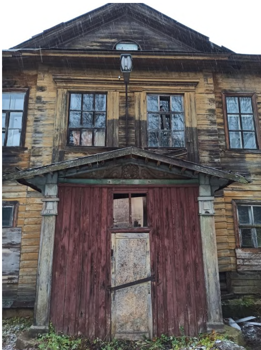
50. Жилой (деревянный) дом. Фрагмент южного фасада
