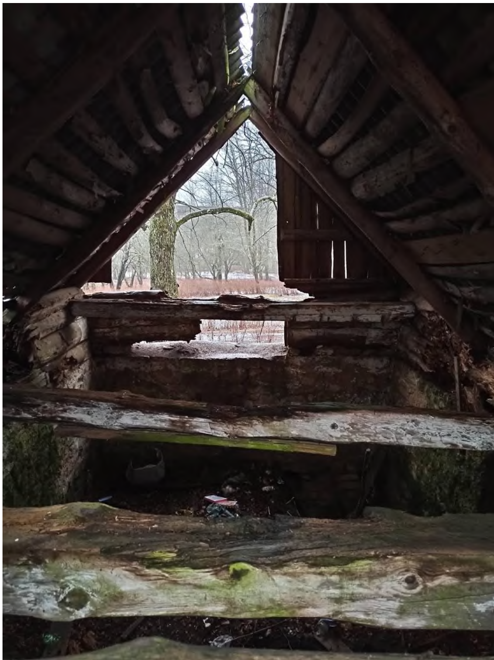
67. Хозяйственная постройка (погреб) на территории парка. Вид изнутри. Состояние конструкций
