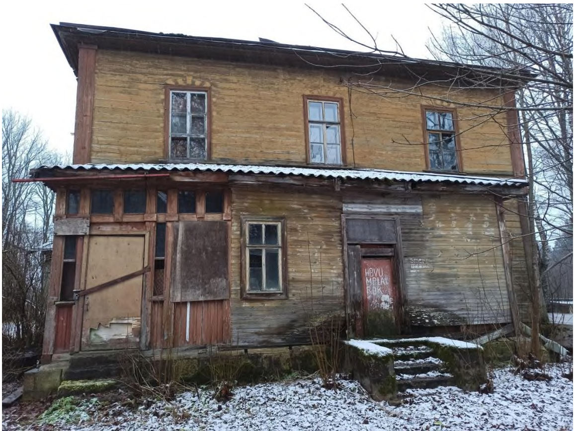
52. Жилой (деревянный) дом. Восточный фасад
