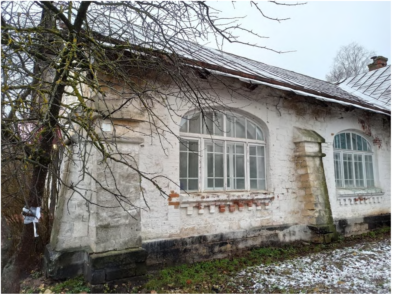
75. Каменная дача (административное здание). Южная часть восточного фасада. Контрфорсы
