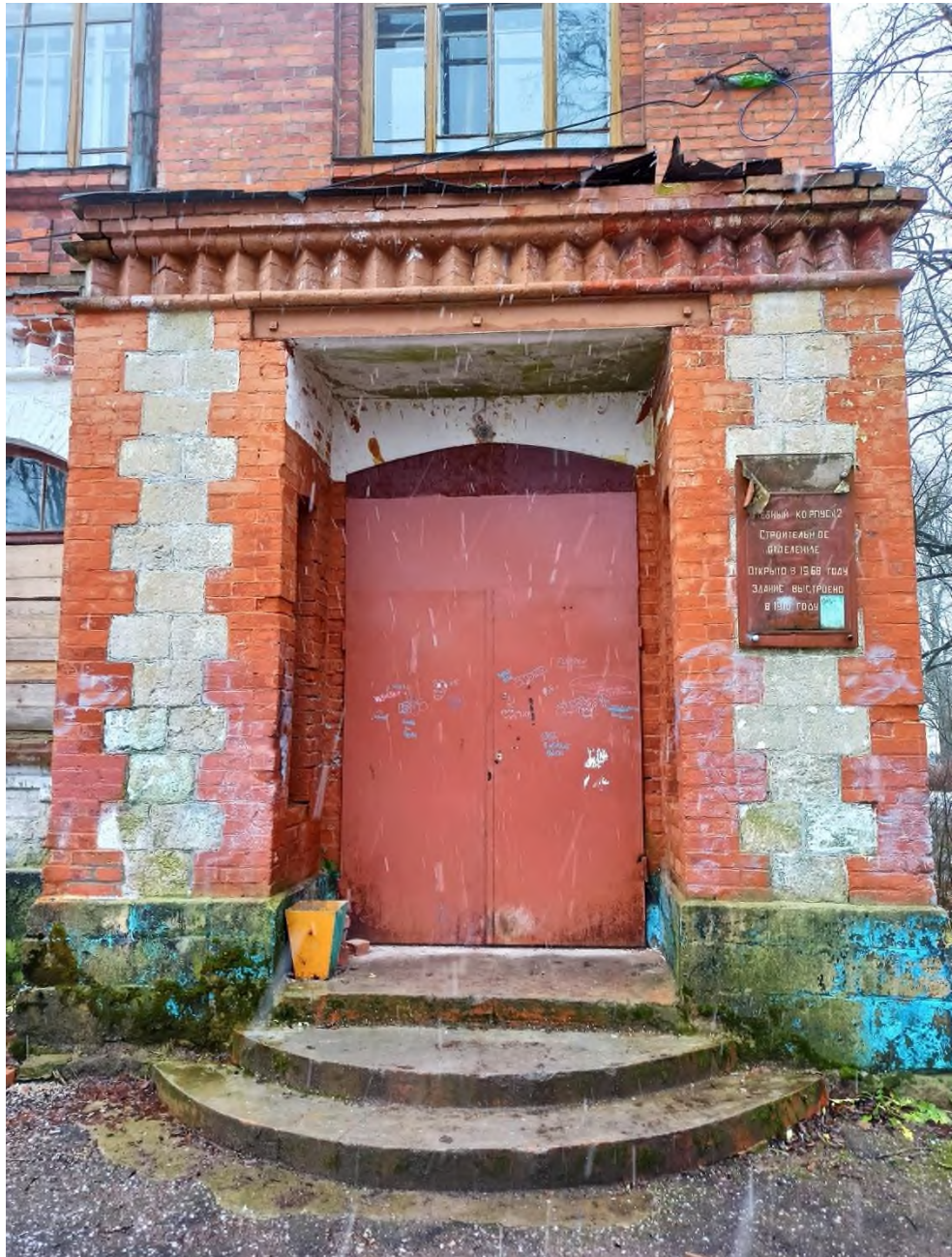
7. Здание сельскохозяйственного (земского) училища. Портал главного входа со стороны северного фасада
