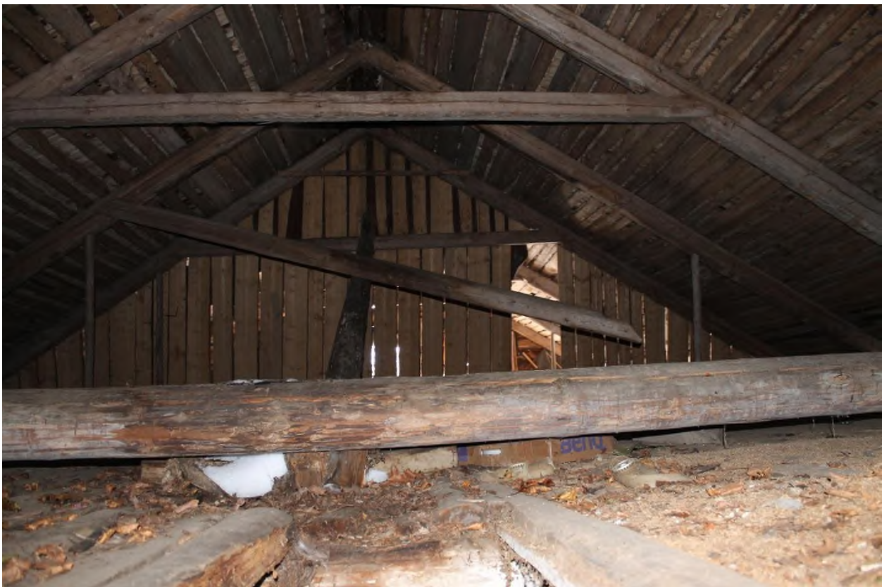
105. Служебная постройка (амбар). Вид подкровельного пространства и конструкции крыши
