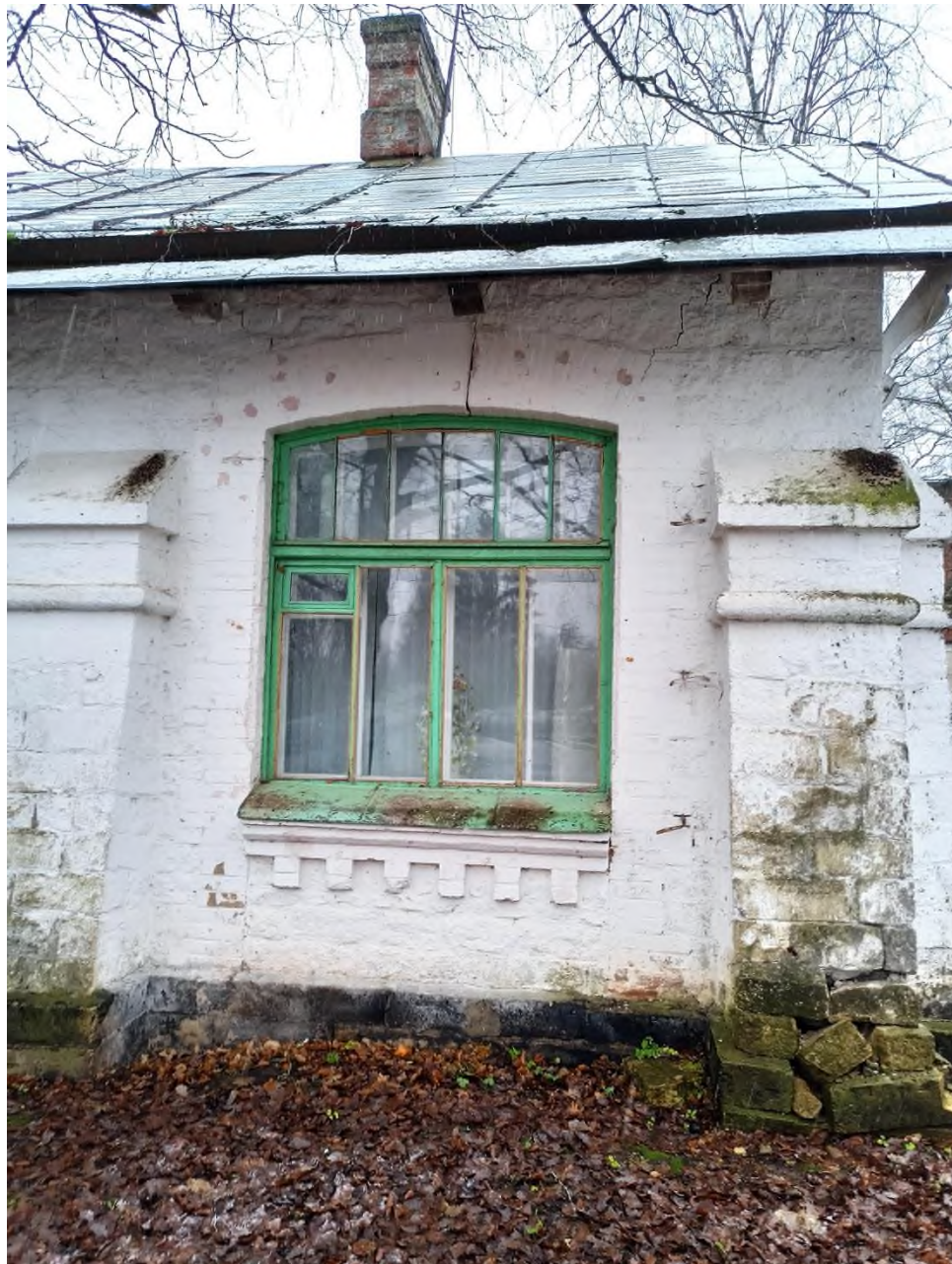
72. Каменная дача (административное здание). Фрагмент восточного фасада. Оконный проем
