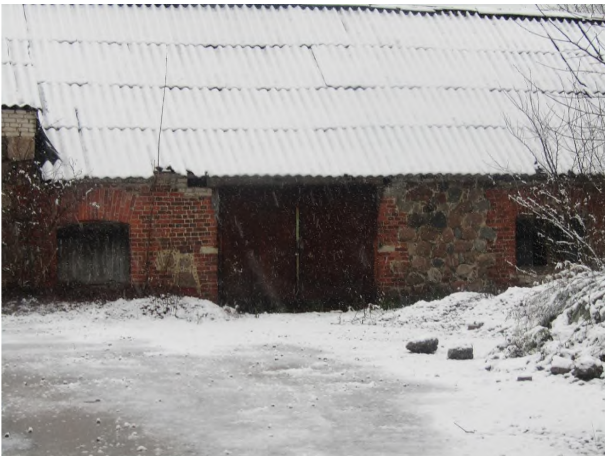
127. Фрагмент фасада скотного двора
