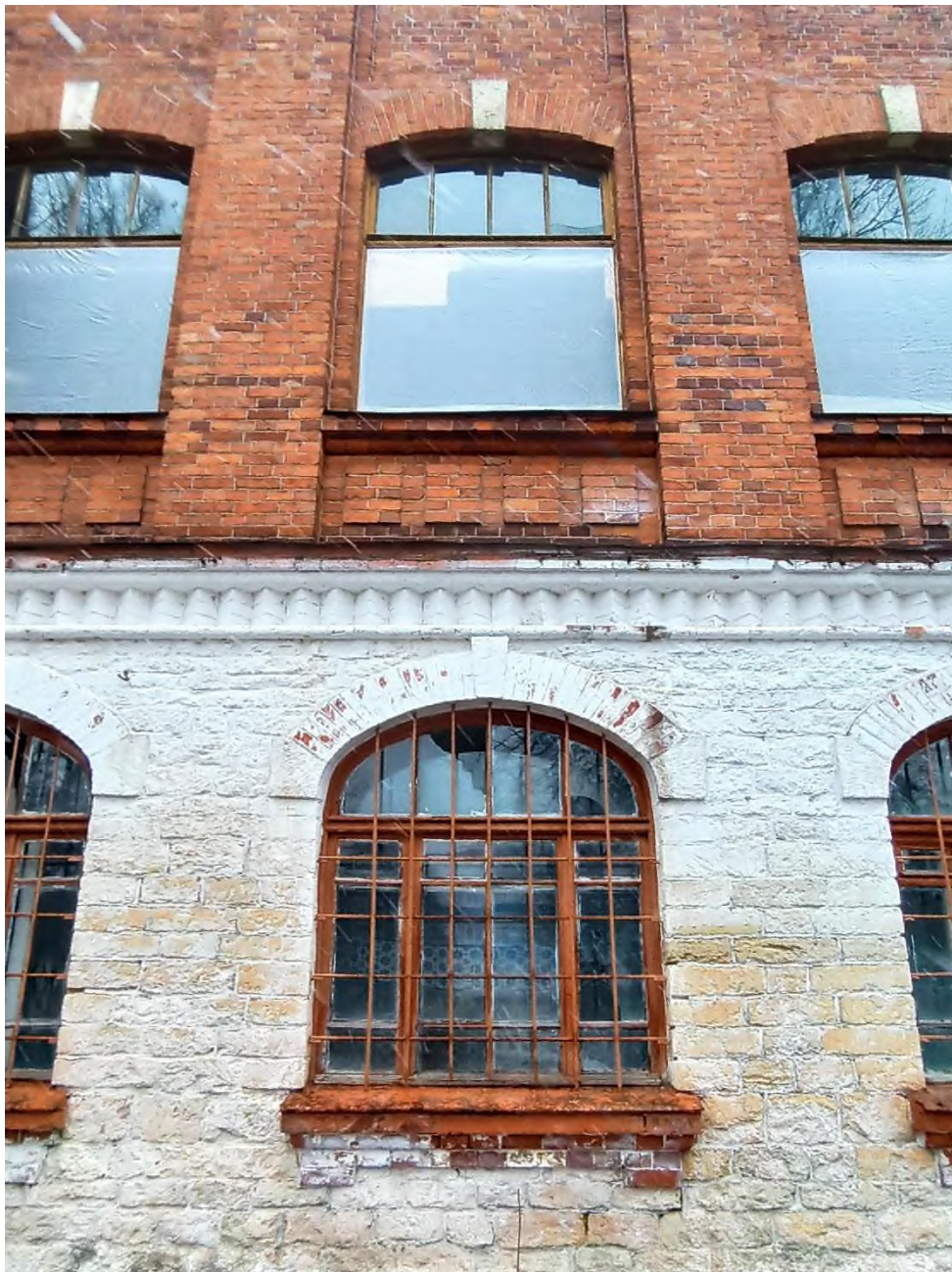
16. Фрагмент южного фасада здания сельскохозяйственного (земского) училища. Оконные проемы 1 и 2 этажей
