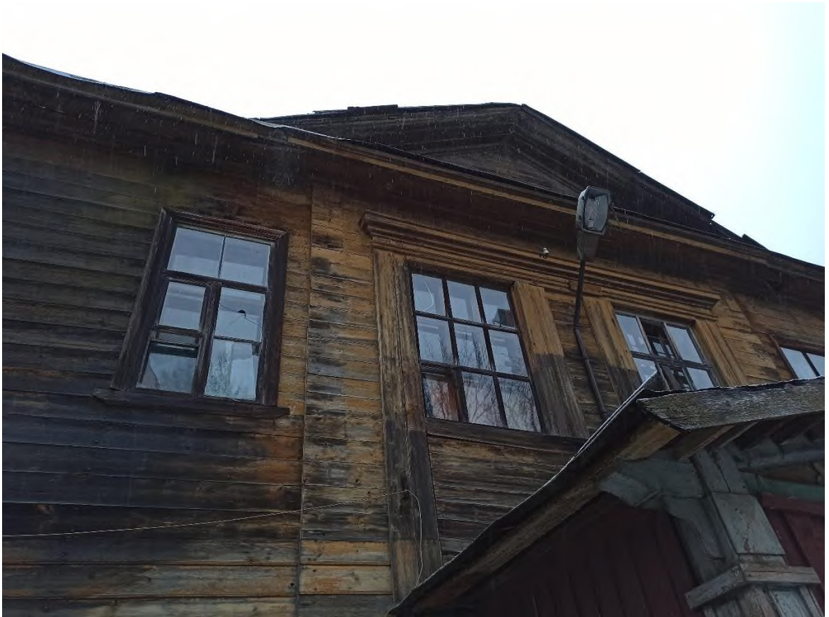
56. Жилой (деревянный) дом. Фрагмент южного фасада. Фронтон над центральной частью дома
