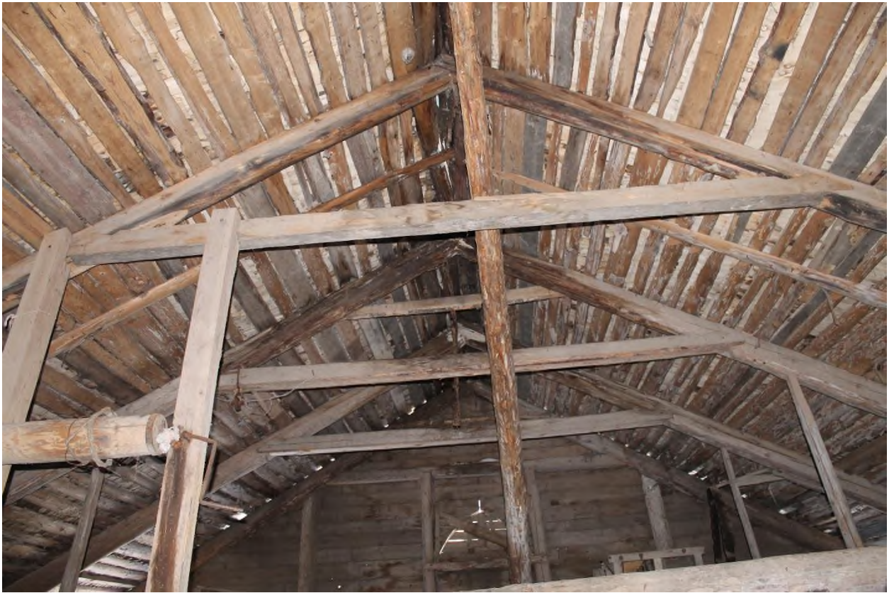
106. Служебная постройка (амбар). Вид подкровельного пространства и конструкции крыши
