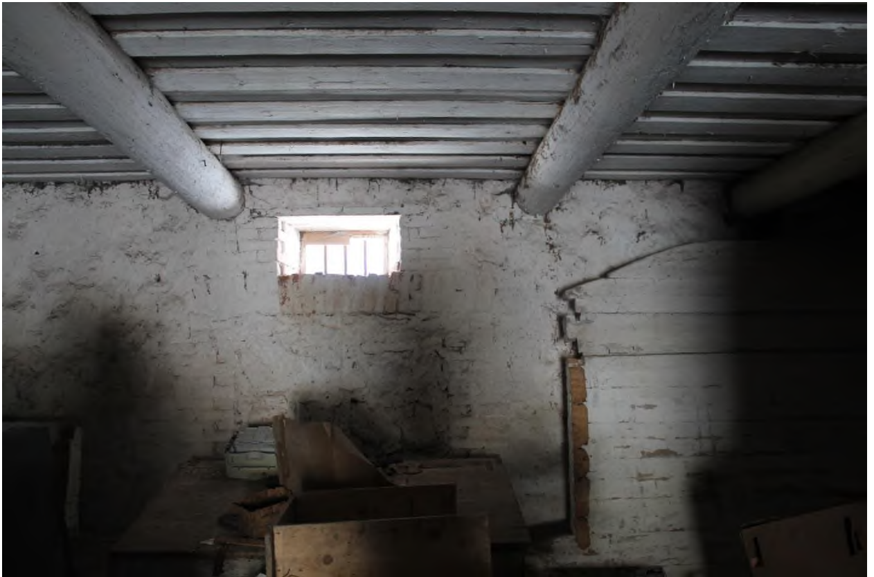
100. Служебная постройка (амбар). Интерьер
