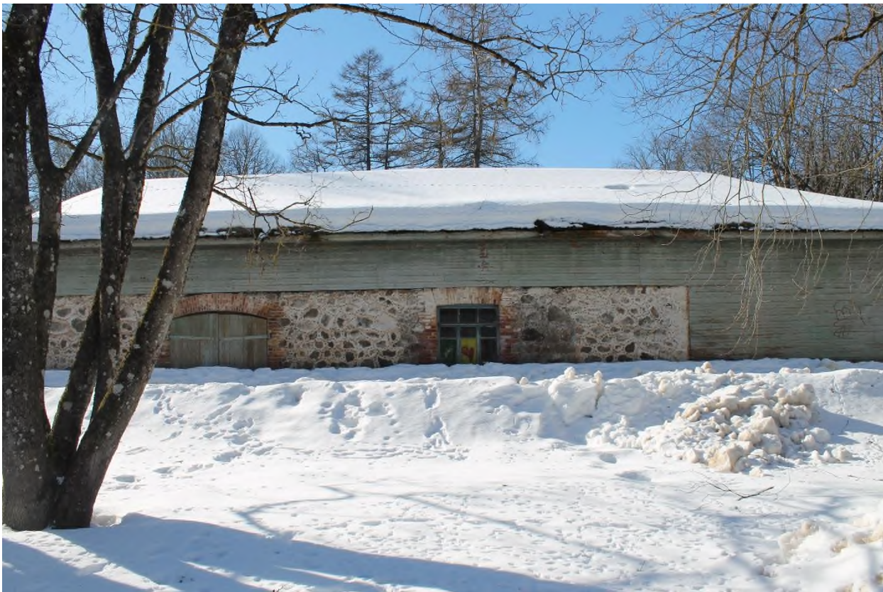
110. Служебная постройка (каретный сарай). Восточный фасад
