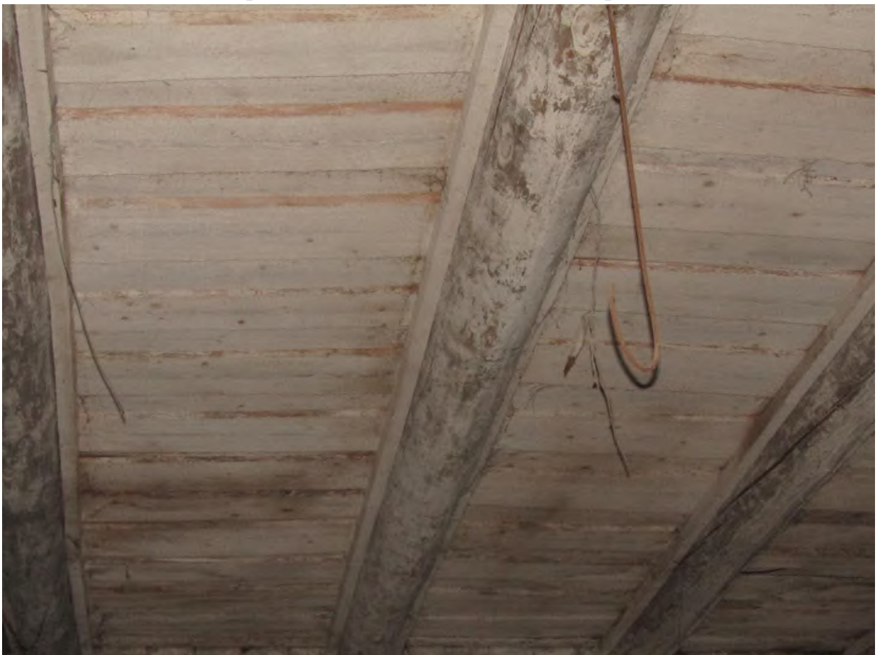
143. Фрагмент конструкции перекрытий скотного двора
