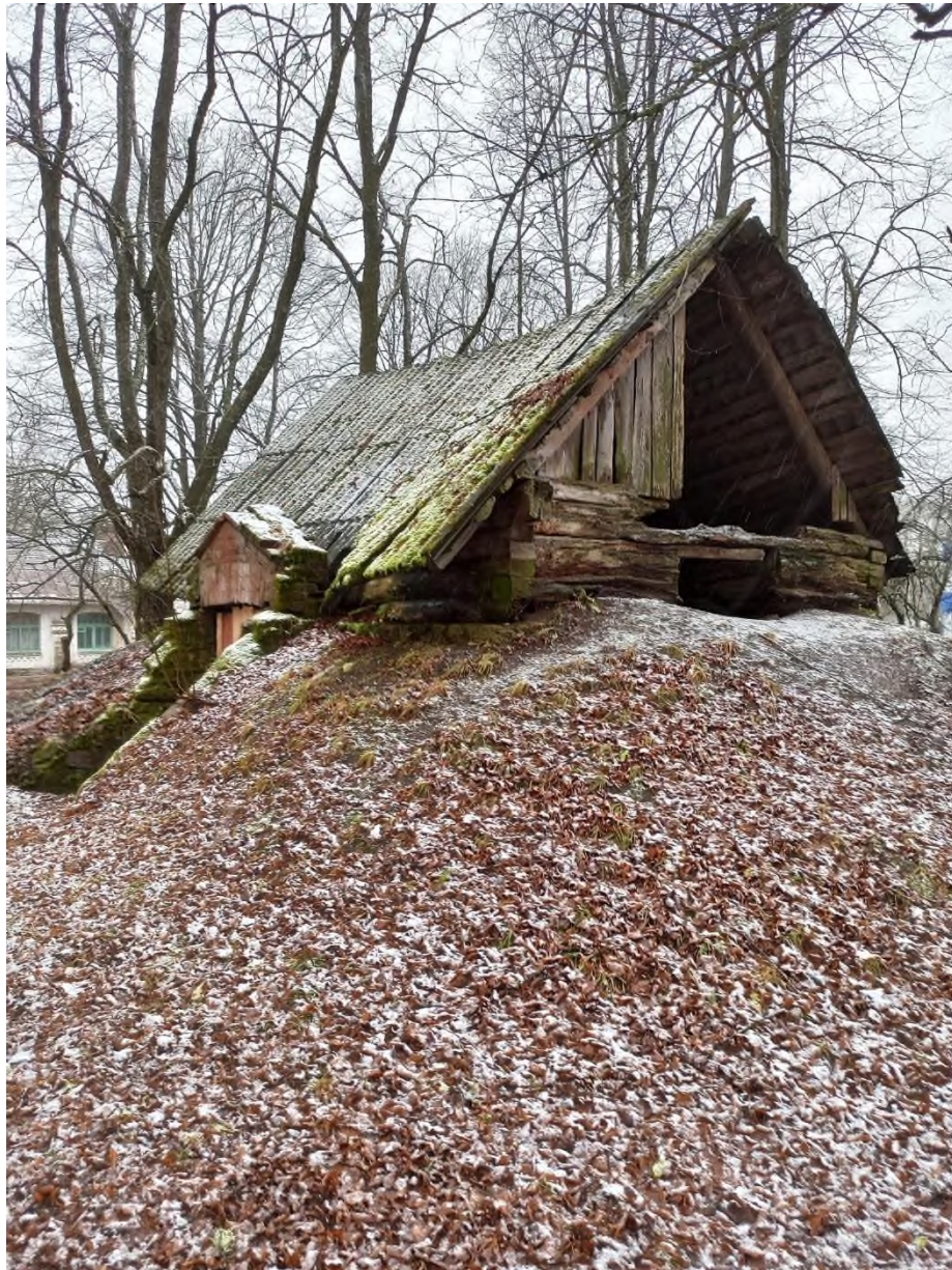
62. Хозяйственная постройка (погреб) на территории парка. Вид с запада
