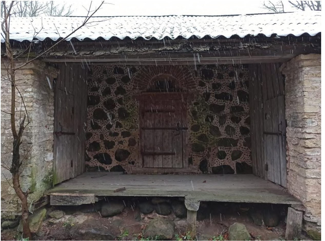
96. Служебная постройка (амбар). Фрагмент восточного фасада
