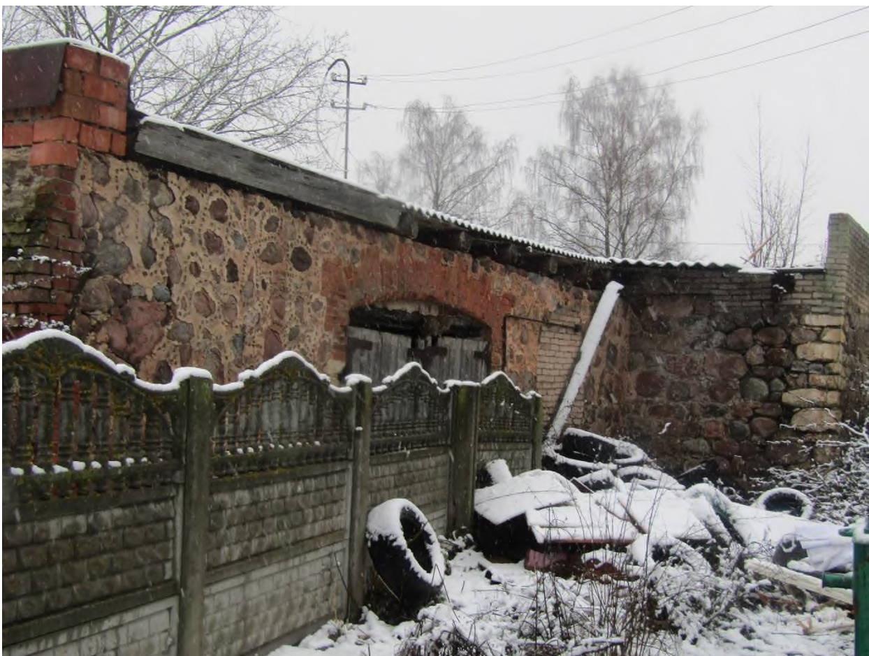
129. Фрагмент фасада скотного двора
