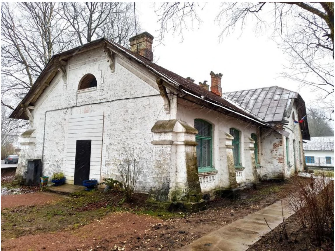
69. Каменная дача (административное здание). Общий вид с северо-запада
