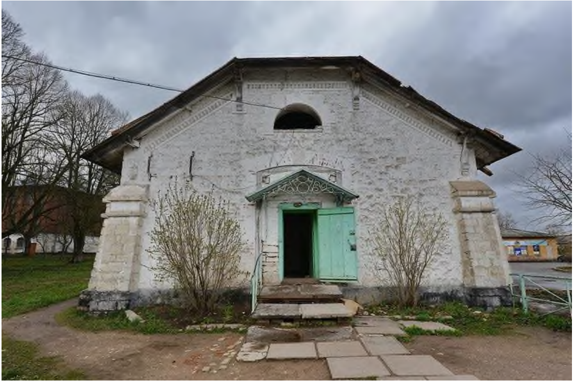
18. 2016 г. Вид входа в корпус Каменной дачи со стороны южного торца. Источник - https://deni-spiri.livejournal.com/69473.html?ysclid=11dkslhigt
