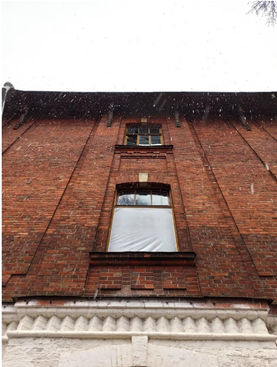
12. Здание сельскохозяйственного (земского) училища. Оконные проемы западного фасада (2 и 3 этажи)
