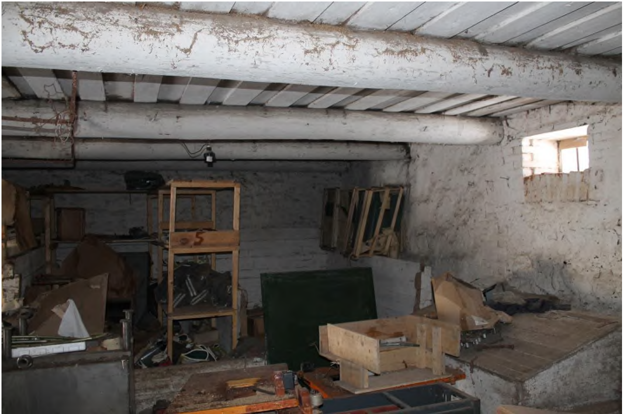
102. Служебная постройка (амбар). Интерьер
