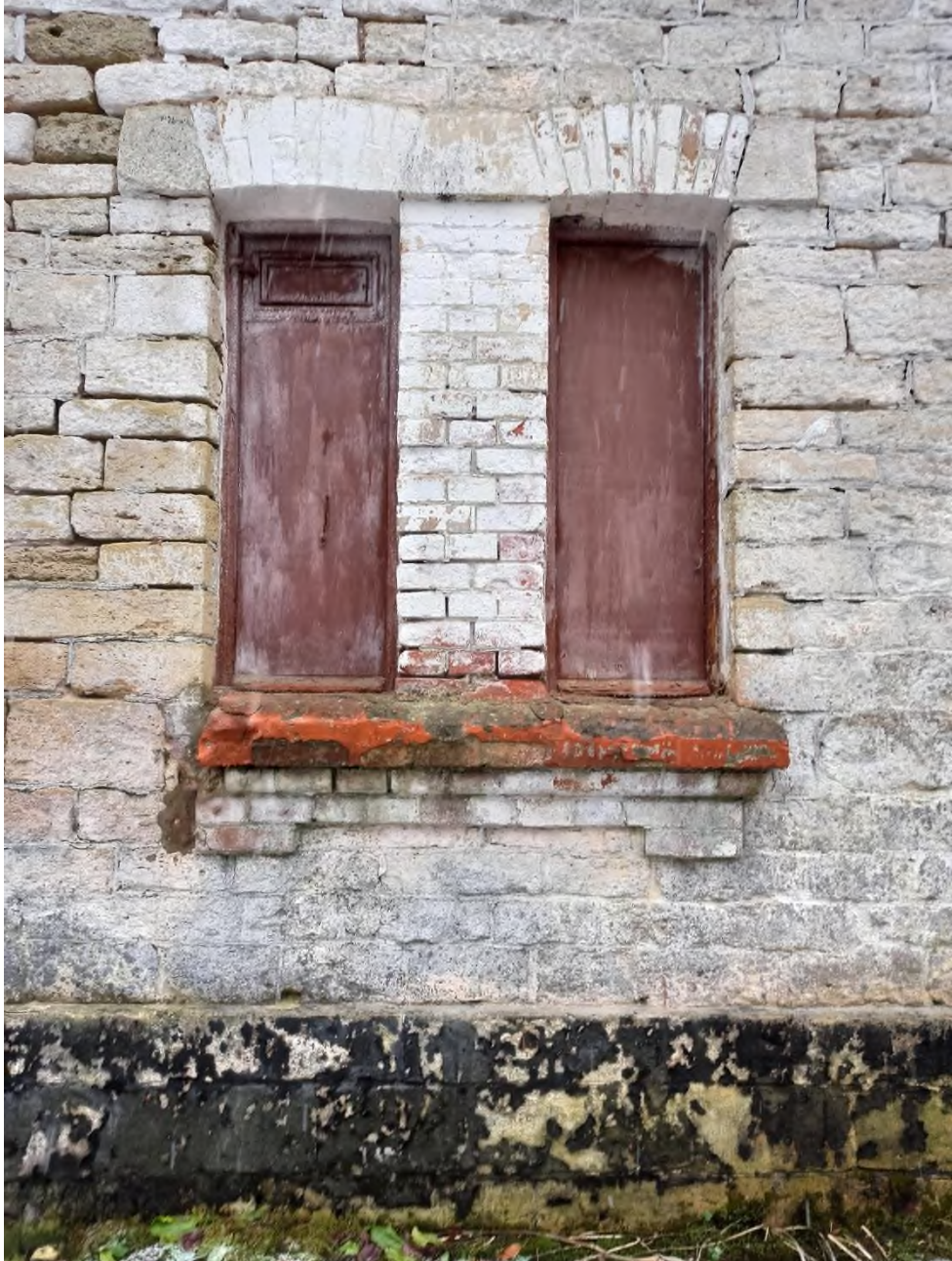
4. Фрагмент северного фасада здания сельскохозяйственного (земского) училища. Оконные проемы первого этажа
