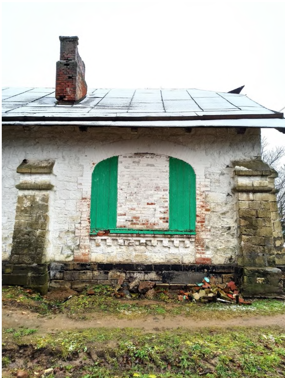
79. Каменная дача (административное здание). Фрагмент западного фасада
