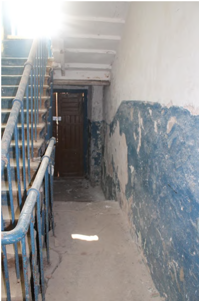
32. Здание сельскохозяйственного (земского) училища. Лестница в восточной части здания
