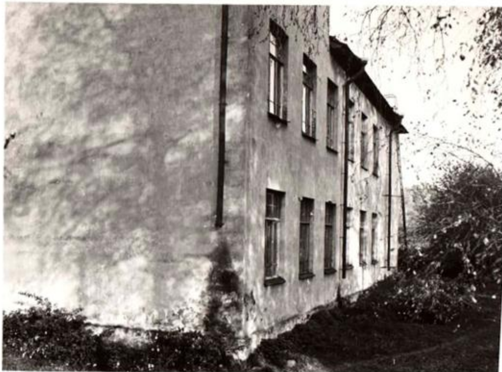
9. Вид фасада здания школы в д. Ставотино 1980 г. Направление съемки север. // Паспорт объекта Ставотинская восьмилетняя школа имени братьев И. и А. Воробьевых. Главное управление охраны памятников истории и культуры Министерства культуры РСФСР 21 декабря 1980 г
