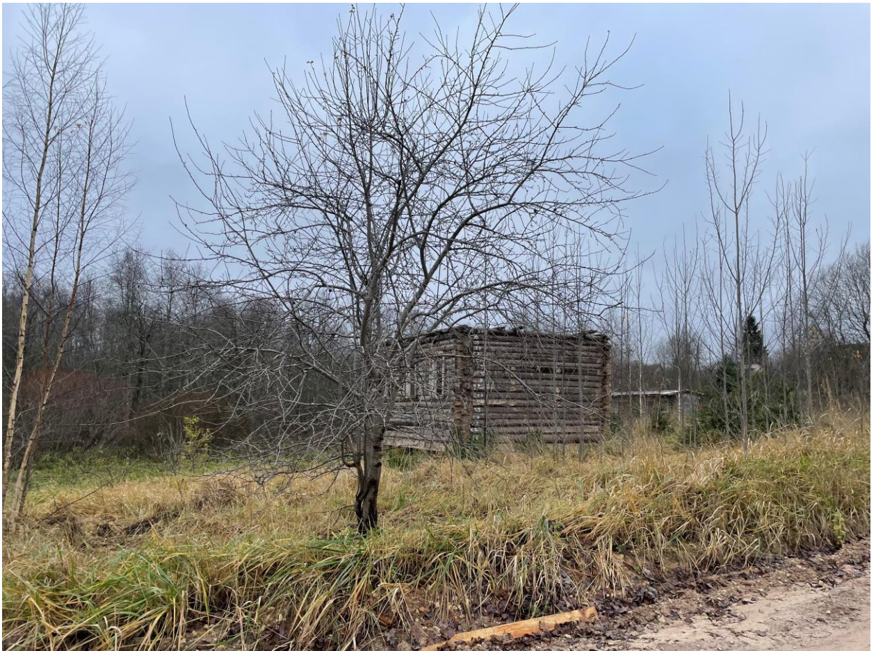
Фото 2. Вид на незавершенный индивидуальный жилой дом.
