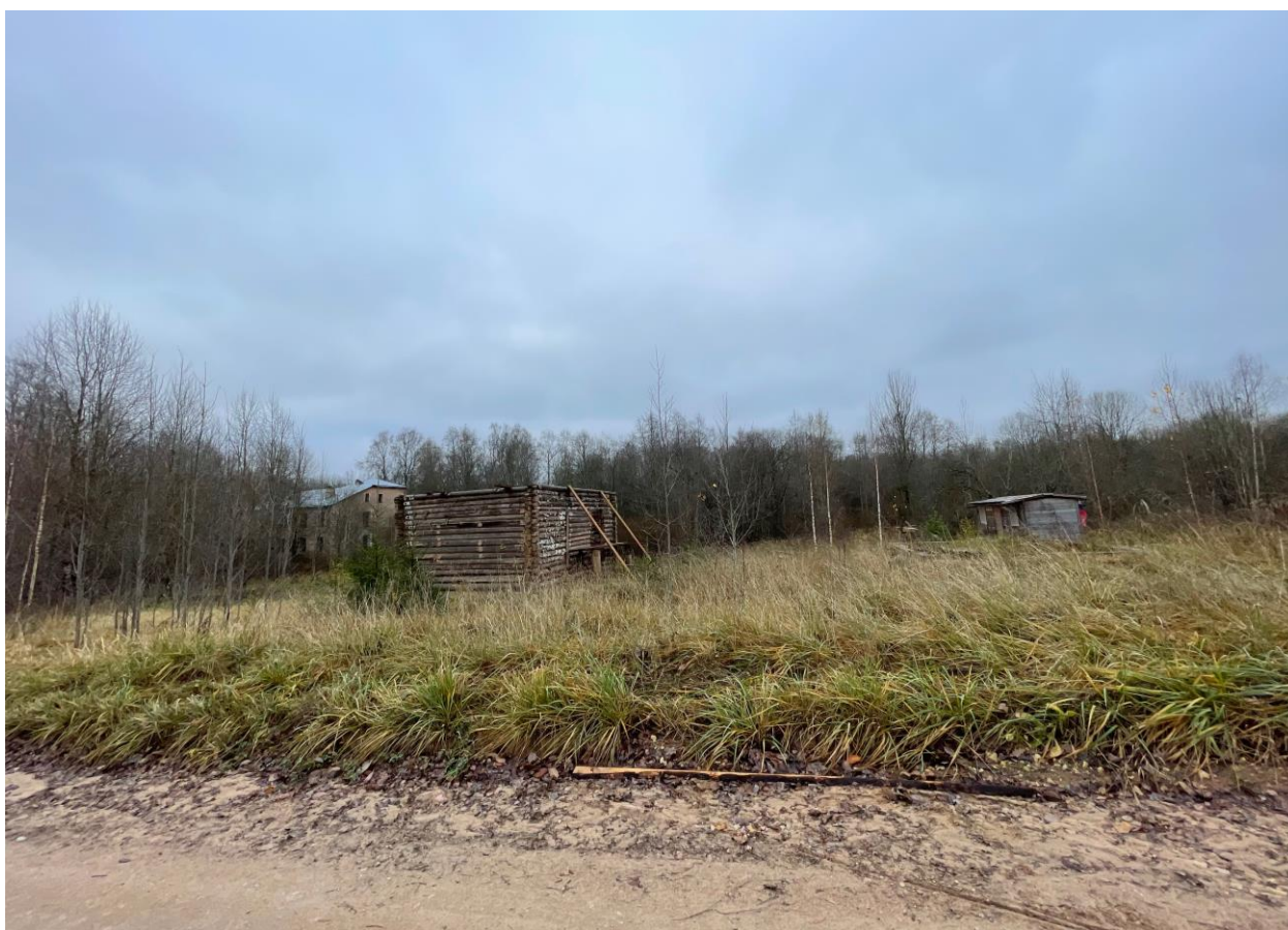
Фото 1. Вид на незавершенный индивидуальный жилой дом и объект культурного наследия.
