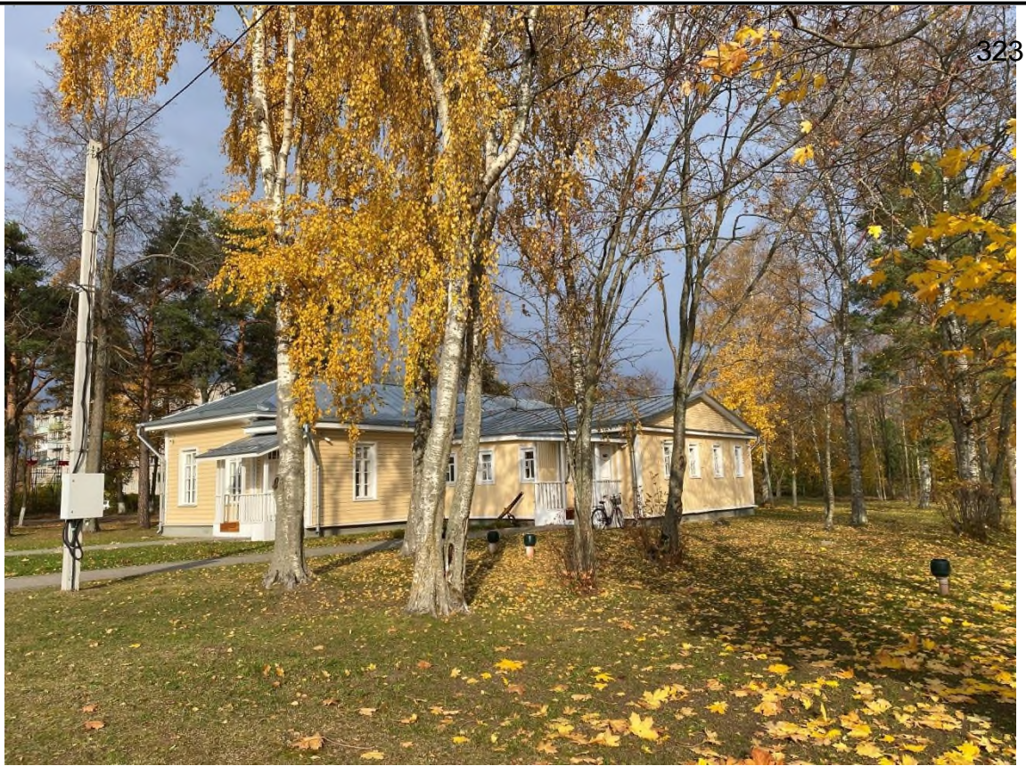
Фот. 2. Вид на объект культурного наследия с юго-востока.
