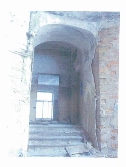
Фото 28. Арочный проем входа на 2-ой этаж и лестничный подъем Л-8 со стороны лестничной клетки ЛК-1.
