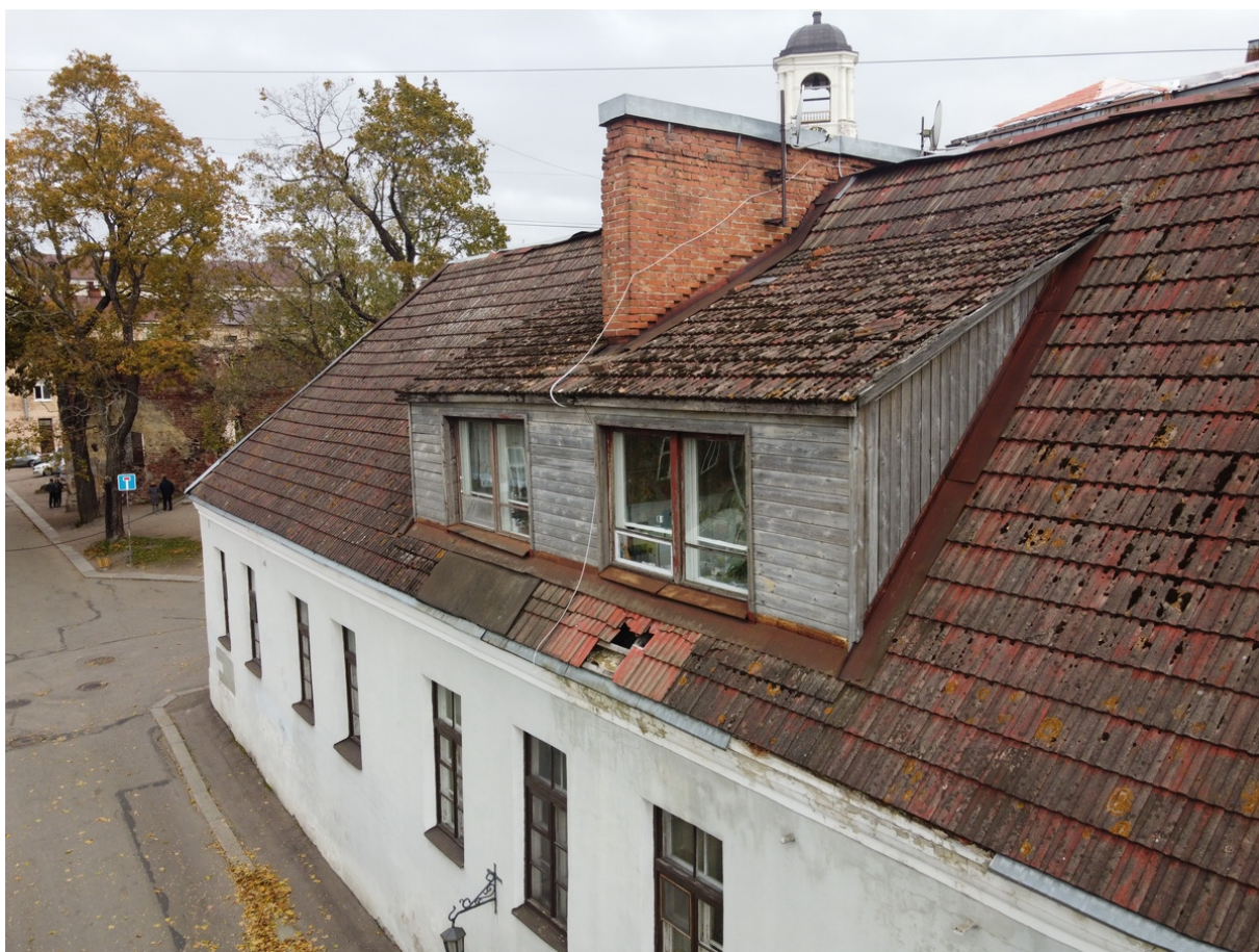
12 ОКН регионального значения “Купеческий дом” ул. Сторожевой башни, д. 3. Вид на северо-восток с квадрокоптера с Подгорной ул. Дата съемки: 13.10.2021 г.
