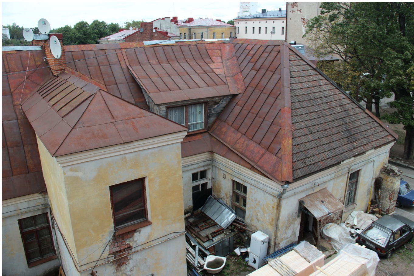
6 ОКН регионального значения “Купеческий дом” ул. Сторожевой башни, д. 3. Вид на восточный фасад со стороны двора. Фрагмент. Дата съемки: 13.10.2021 г.
