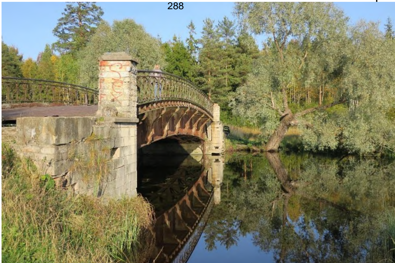
5. Южный фасад Осинового моста через реку Теплую по северной дороге.
