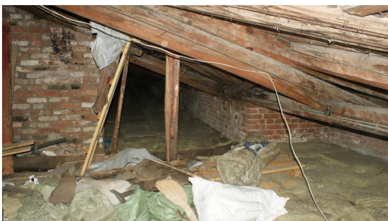
30. «Ансамбль зданий бывших казарм и жилых зданий гвардейского батальона (ранее крепость Ингербург)», Ленинградская обл., Гатчинский р-н, г. Гатчина, ул. Рощинская, д.4. Чердак. Общий вид. Фото 01.11.2022г.
