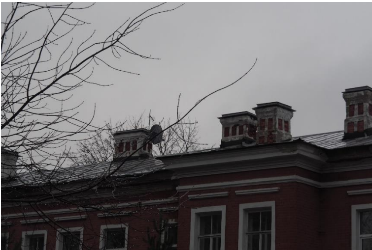
19. «Ансамбль зданий бывших казарм и жилых зданий гвардейского батальона (ранее крепость Ингербург)», Ленинградская обл., Гатчинский р-н, г. Гатчина, ул. Роцинская, д.4. Юго-западный фасад. Фрагмент. Фото 01.11.2022г.
