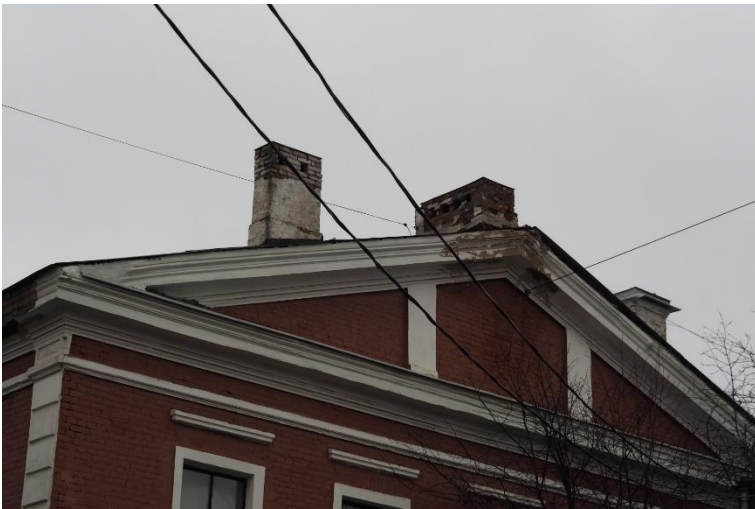
10. «Ансамбль зданий бывших казарм и жилых зданий гвардейского батальона (ранее крепость Ингербург)», Ленинградская обл., Гатчинский р-н, г. Гатчина, ул. Роцинская, д.4. Северо-западный фасад. Фрагмент. Фото 01.11.2022г.
