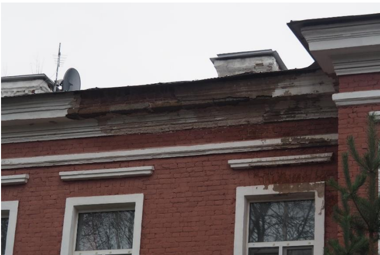
17. «Ансамбль зданий бывших казарм и жилых зданий гвардейского батальона (ранее крепость Ингербург)», Ленинградская обл., Гатчинский р-н, г. Гатчина, ул. Роцинская, д.4. Юго-западный фасад. Фрагмент. Фото 01.11.2022г.
