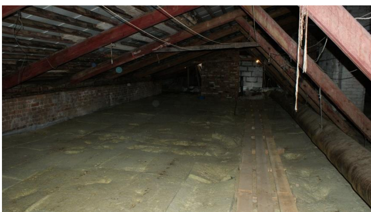
32. «Ансамбль зданий бывших казарм и жилых зданий гвардейского батальона (ранее крепость Ингербург)», Ленинградская обл., Гатчинский р-н, г. Гатчина, ул. Рощинская, д.4. Чердак. Общий вид. Фото 01.11.2022г.
