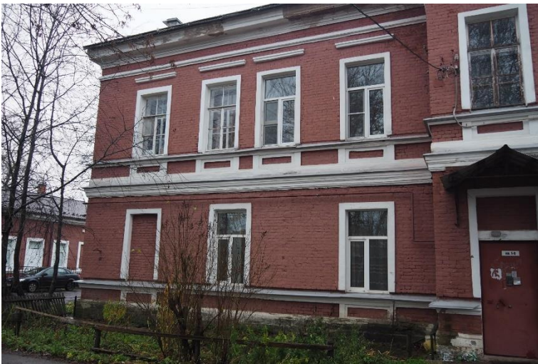
14. «Ансамбль зданий бывших казарм и жилых зданий гвардейского батальона (ранее крепость Ингербург)», Ленинградская обл., Гатчинский р-н, г. Гатчина, ул. Роцинская, д.4. Юго-западный фасад. Фрагмент. Фото 01.11.2022г.
