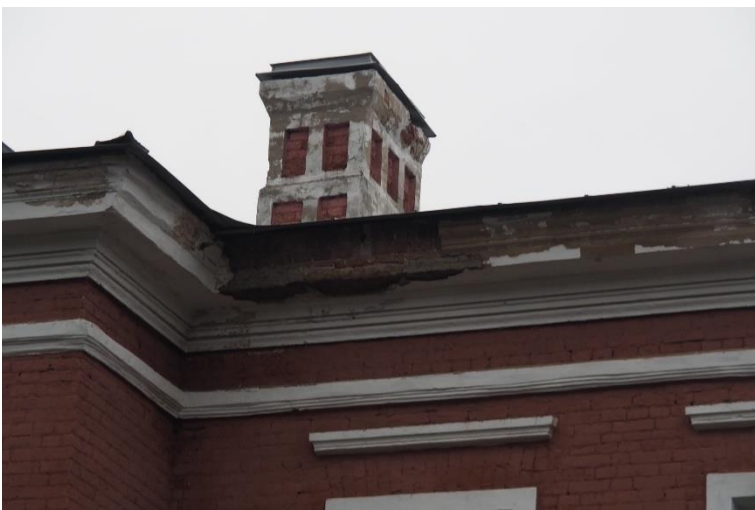
18. «Ансамбль зданий бывших казарм и жилых зданий гвардейского батальона (ранее крепость Ингербург)», Ленинградская обл., Гатчинский р-н, г. Гатчина, ул. Роцинская, д.4. Юго-западный фасад. Фрагмент. Фото 01.11.2022г.
