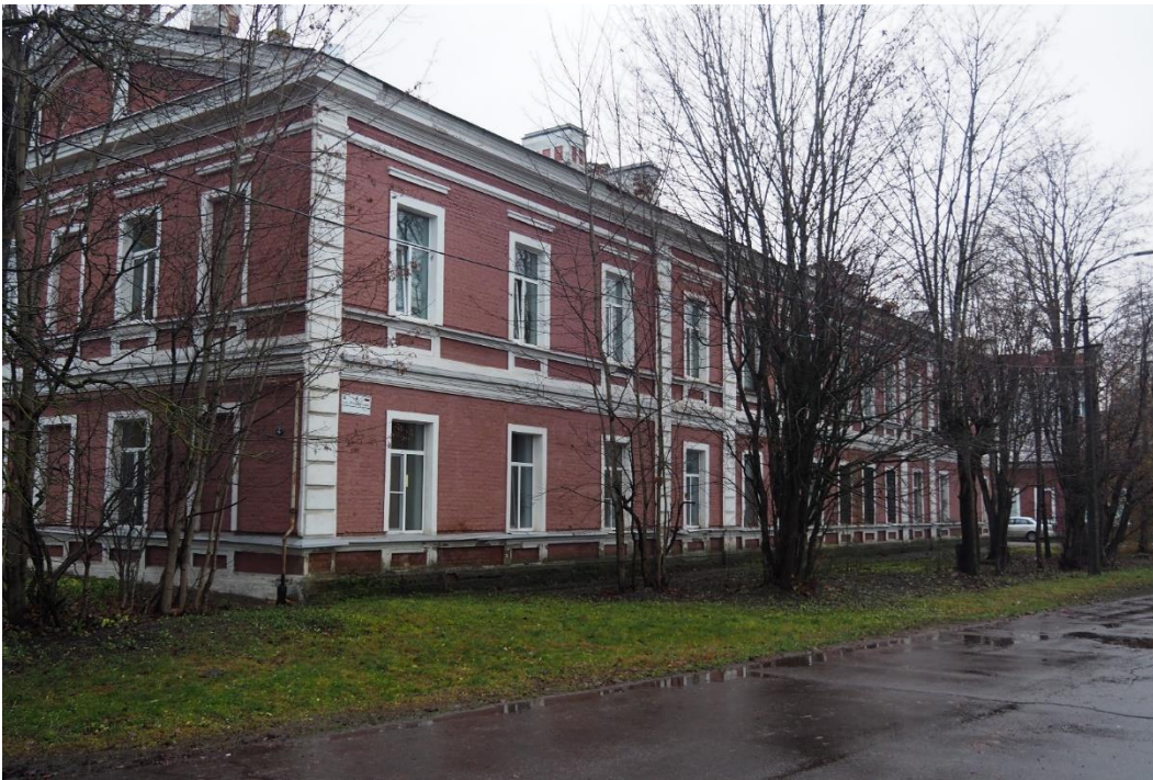
1. «Ансамбль зданий бывших казарм и жилых зданий гвардейского батальона (ранее крепость Ингербург)», Ленинградская обл., Гатчинский р-н, г. Гатчина, ул. Рощинская, д.4. Северо-восточный фасад. Общий вид. Фото 01.11.2022г.
