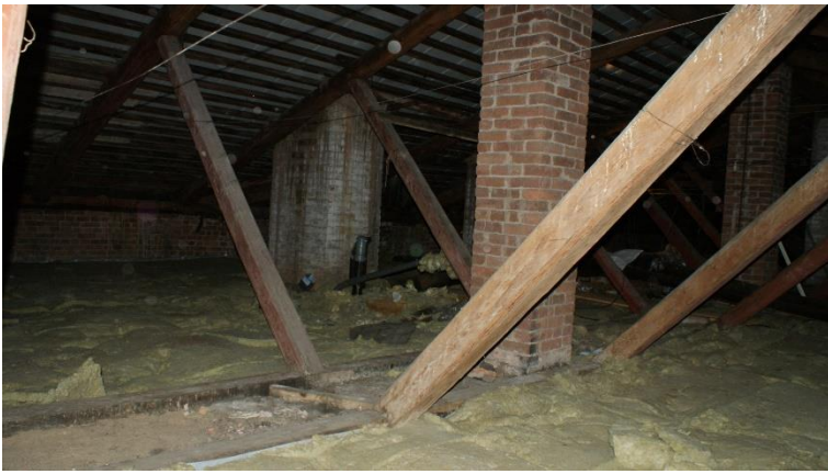
34. «Ансамбль зданий бывших казарм и жилых зданий гвардейского батальона (ранее крепость Ингербург)», Ленинградская обл., Гатчинский р-н, г. Гатчина, ул. Рощинская, д.4. Чердак. Общий вид. Фото 01.11.2022г.
