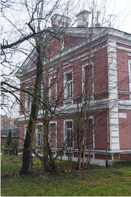
8. «Ансамбль зданий бывших казарм и жилых зданий гвардейского батальона (ранее крепость Ингербург)», Ленинградская обл., Гатчинский р-н, г. Гатчина, ул. Рощинская, д.4. Юго-восточный фасад. Фрагмент. Фото 01.11.2022г.
