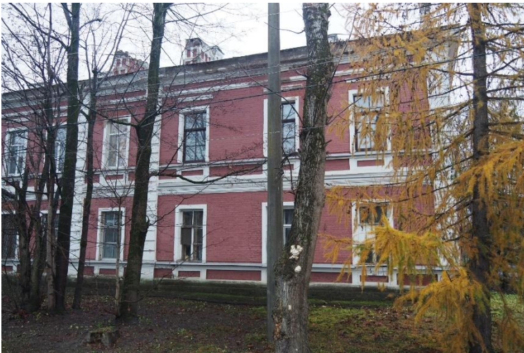
5. «Ансамбль зданий бывших казарм и жилых зданий гвардейского батальона (ранее крепость Ингербург)», Ленинградская обл., Гатчинский р-н, г. Гатчина, ул. Рощинская, д.4. Северо-восточный фасад. Фрагмент. Фото 01.11.2022г.
