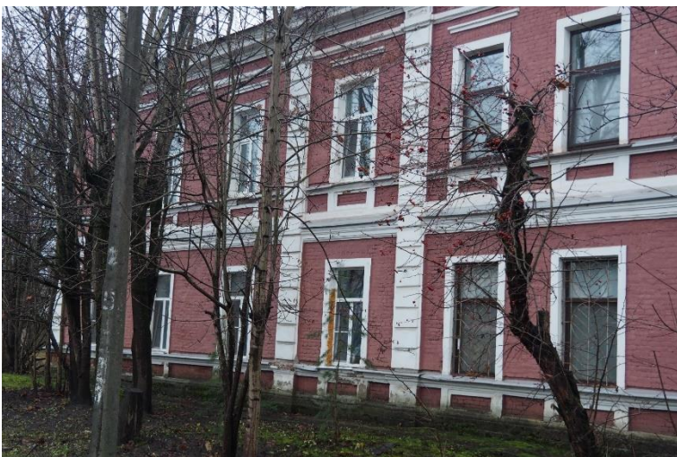
7. «Ансамбль зданий бывших казарм и жилых зданий гвардейского батальона (ранее крепость Ингербург)», Ленинградская обл., Гатчинский р-н, г. Гатчина, ул. Рощинская, д.4. Северо-восточный фасад. Фрагмент. Фото 01.11.2022г.
