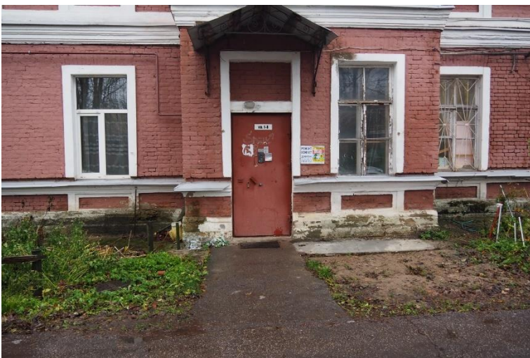
15. «Ансамбль зданий бывших казарм и жилых зданий гвардейского батальона (ранее крепость Ингербург)», Ленинградская обл., Гатчинский р-н, г. Гатчина, ул. Роцинская, д.4. Юго-западный фасад. Фрагмент. Фото 01.11.2022г.
