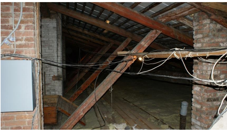
26. «Ансамбль зданий бывших казарм и жилых зданий гвардейского батальона (ранее крепость Ингербург)», Ленинградская обл., Гатчинский р-н, г. Гатчина, ул. Рощинская, д.4. Чердак. Общий вид. Фото 01.11.2022г.
