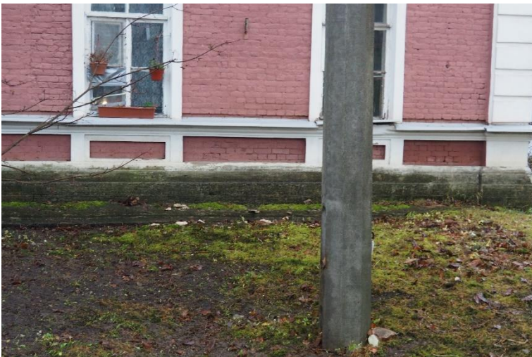
23. «Ансамбль зданий бывших казарм и жилых зданий гвардейского батальона (ранее крепость Ингербург)», Ленинградская обл., Гатчинский р-н, г. Гатчина, ул. Роцинская, д.4. Юго-западный фасад. Фрагмент. Фото 01.11.2022г.
