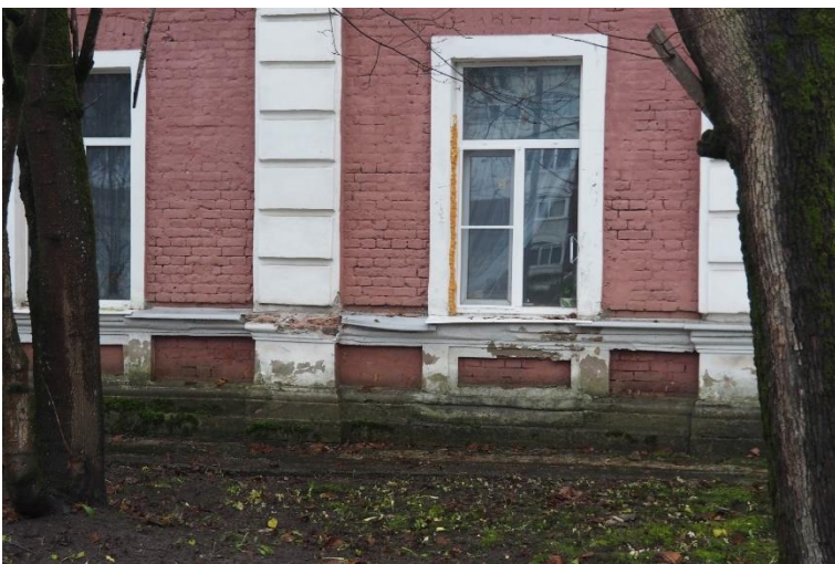
21. «Ансамбль зданий бывших казарм и жилых зданий гвардейского батальона (ранее крепость Ингербург)», Ленинградская обл., Гатчинский р-н, г. Гатчина, ул. Роцинская, д.4. Юго-западный фасад. Фрагмент. Фото 01.11.2022г.
