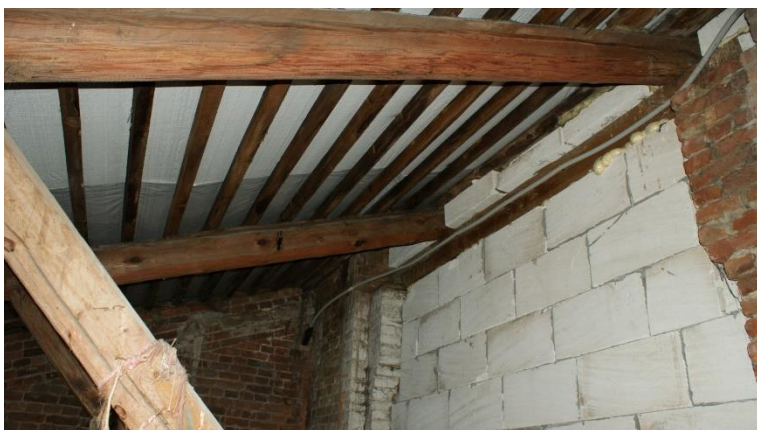
28. «Ансамбль зданий бывших казарм и жилых зданий гвардейского батальона (ранее крепость Ингербург)», Ленинградская обл., Гатчинский р-н, г. Гатчина, ул. Рощинская, д.4. Чердак. Фрагмент. Фото 01.11.2022г.
