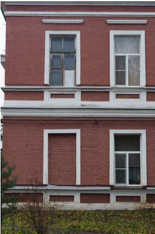
9. «Ансамбль зданий бывших казарм и жилых зданий гвардейского батальона (ранее крепость Ингербург)», Ленинградская обл., Гатчинский р-н, г. Гатчина, ул. Рощинская, д.4. Юго-восточный фасад. Фрагмент. Фото 01.11.2022г.
