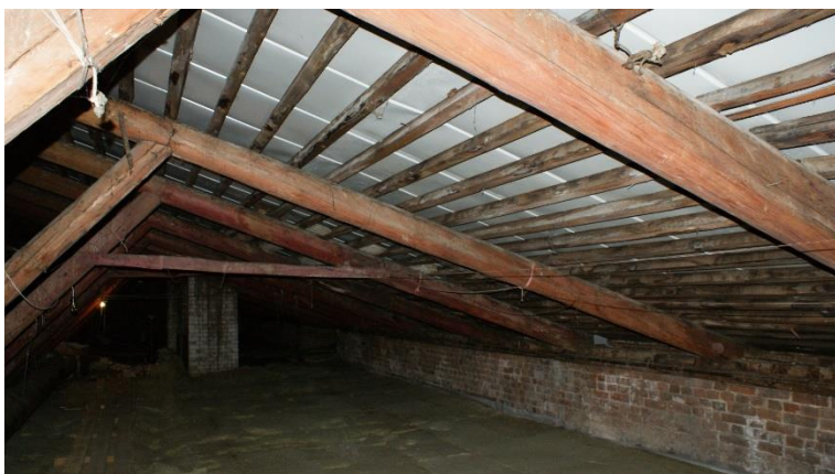
31. «Ансамбль зданий бывших казарм и жилых зданий гвардейского батальона (ранее крепость Ингербург)», Ленинградская обл., Гатчинский р-н, г. Гатчина, ул. Рощинская, д.4. Чердак. Общий вид. Фото 01.11.2022г.
