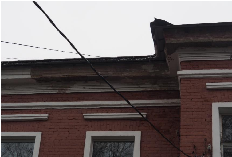
16. «Ансамбль зданий бывших казарм и жилых зданий гвардейского батальона (ранее крепость Ингербург)», Ленинградская обл., Гатчинский р-н, г. Гатчина, ул. Роцинская, д.4. Юго-западный фасад. Фрагмент. Фото 01.11.2022г.
