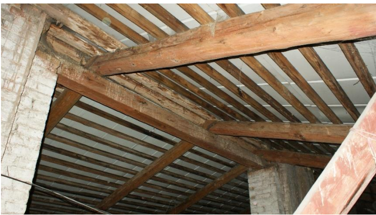
35. «Ансамбль зданий бывших казарм и жилых зданий гвардейского батальона (ранее крепость Ингербург)», Ленинградская обл., Гатчинский р-н, г. Гатчина, ул. Рощинская, д.4. Чердак. Фрагмент. Фото 01.11.2022г.
