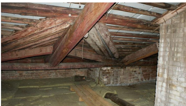
33. «Ансамбль зданий бывших казарм и жилых зданий гвардейского батальона (ранее крепость Ингербург)», Ленинградская обл., Гатчинский р-н, г. Гатчина, ул. Рощинская, д.4. Чердак. Общий вид. Фото 01.11.2022г.
