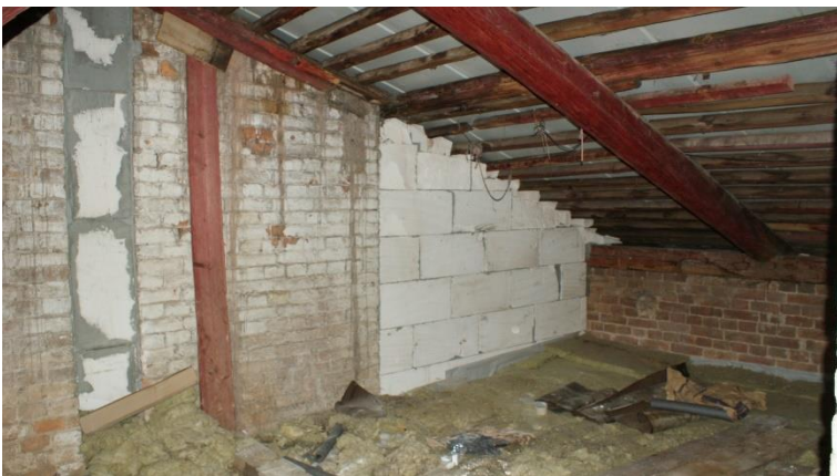
36. «Ансамбль зданий бывших казарм и жилых зданий гвардейского батальона (ранее крепость Ингербург)», Ленинградская обл., Гатчинский р-н, г. Гатчина, ул. Рощинская, д.4. Чердак. Фрагмент. Фото 01.11.2022г.
