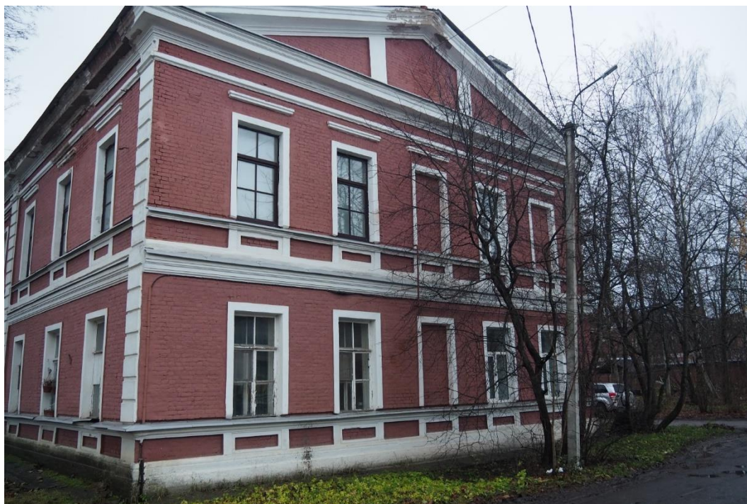
3. «Ансамбль зданий бывших казарм и жилых зданий гвардейского батальона (ранее крепость Ингербург)», Ленинградская обл., Гатчинский р-н, г. Гатчина, ул. Роцинская, д.4. Северо-западный фасад. Общий вид. Фото 01.11.2022г.
