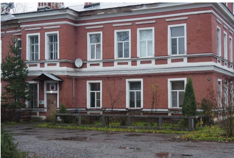
11. «Ансамбль зданий бывших казарм и жилых зданий гвардейского батальона (ранее крепость Ингербург)», Ленинградская обл., Гатчинский р-н, г. Гатчина, ул. Роцинская, д.4. Юго-западный фасад. Фрагмент. Фото 01.11.2022г.
