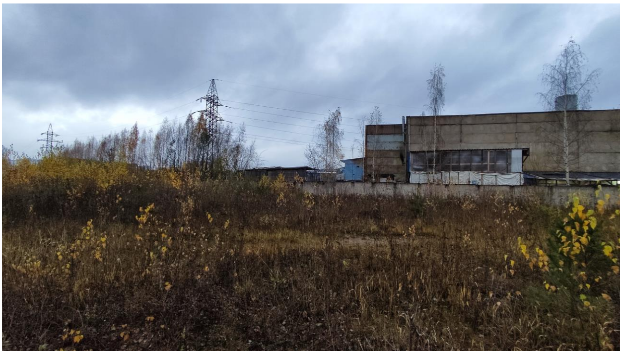
Илл. 4. Ломоносовский район, Виллозское городское поселение, земельный участок с кадастровым номером 47:14:0602002:867. Юго-восточная часть участка, общий вид с юго-запада. 28.10.2022 г.
