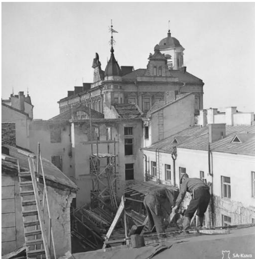
27. Фотография. Ремонтные работы 1942 г.
