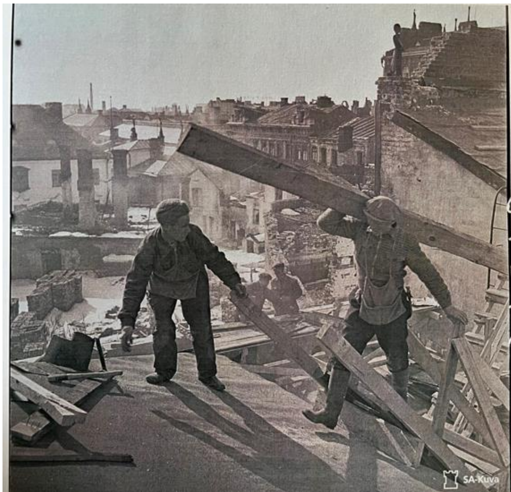
25. Фотография. Ремонтные работы на Замковой улице 17 апреля 1942.
