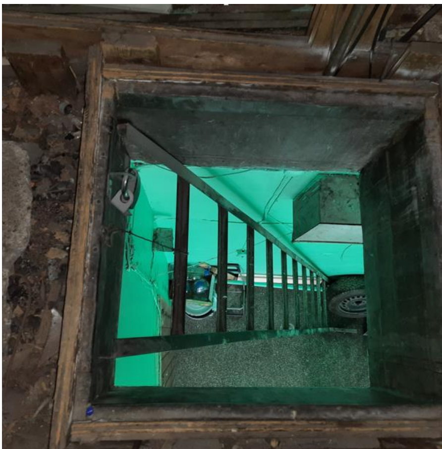
Фото 15. Чердачное пом. № 4. Лаз.
