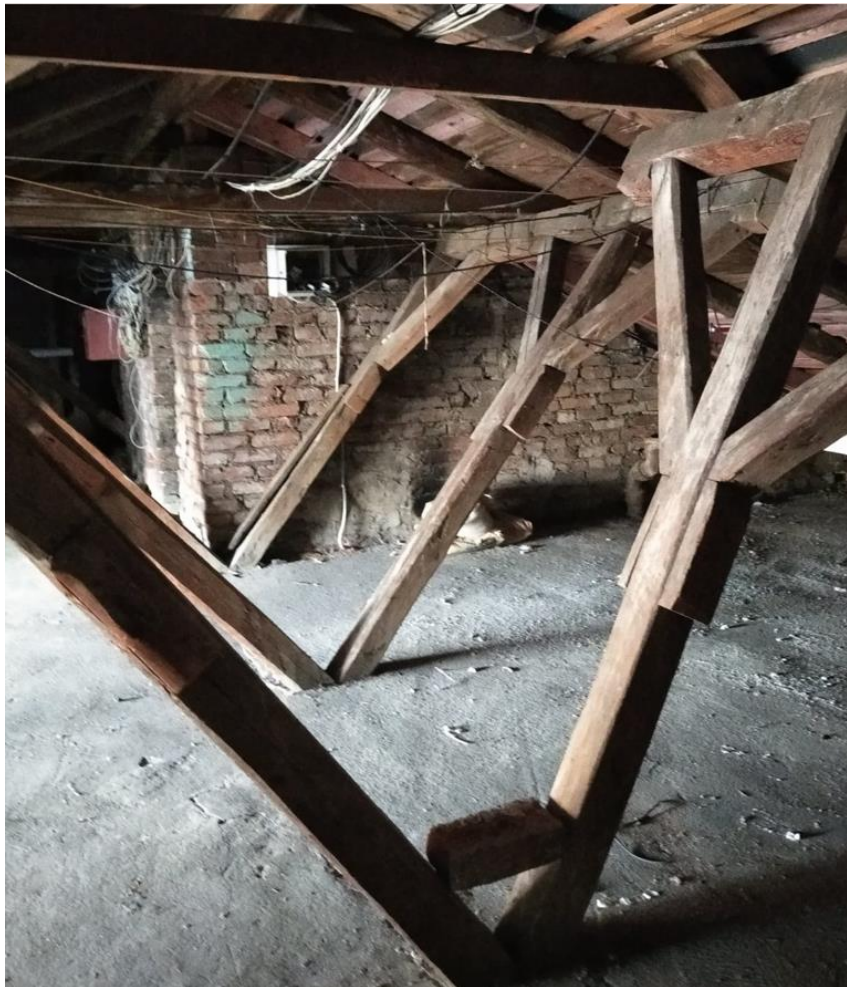
Фото 2. Чердачное пом. № 1. Вид на лестницу.
