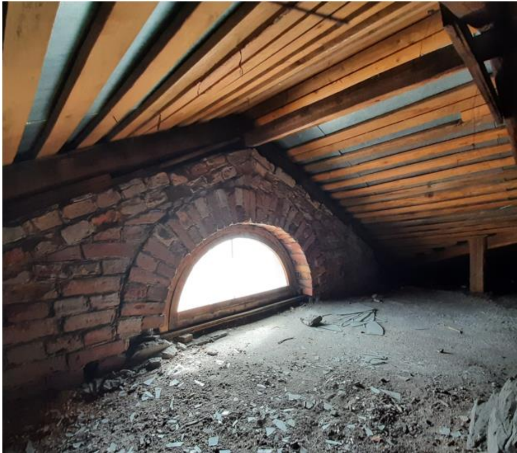
Фото 13. Чердачное пом. № 4. Вид на коно.
