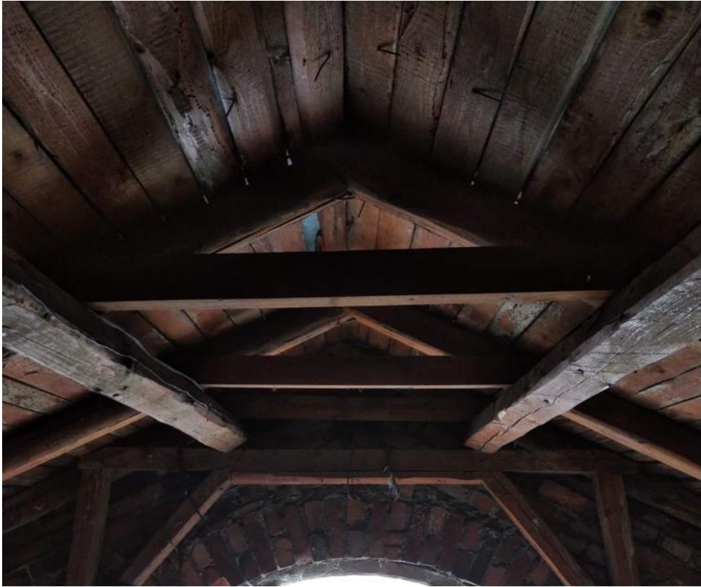
Фото 3. Чердачное пом. № 1. Стропильные ноги над окном.
