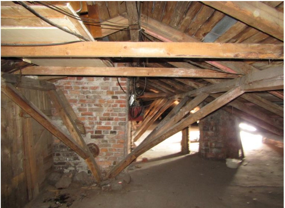
Фото 7. Чердачное пом. № 1. Вид на лестницу.
