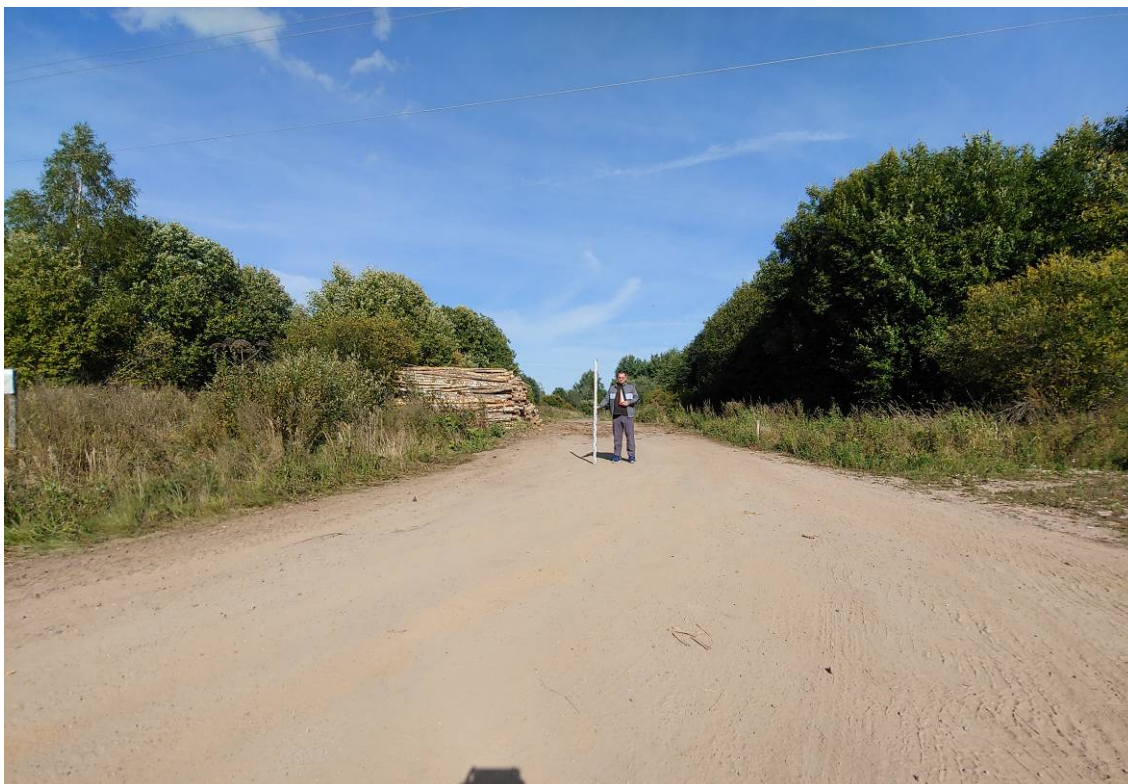
Рис. 9. Ленинградская область-2022. Киришский район. Участок обследования. Точка фотофиксации 2. Вид с юга.
