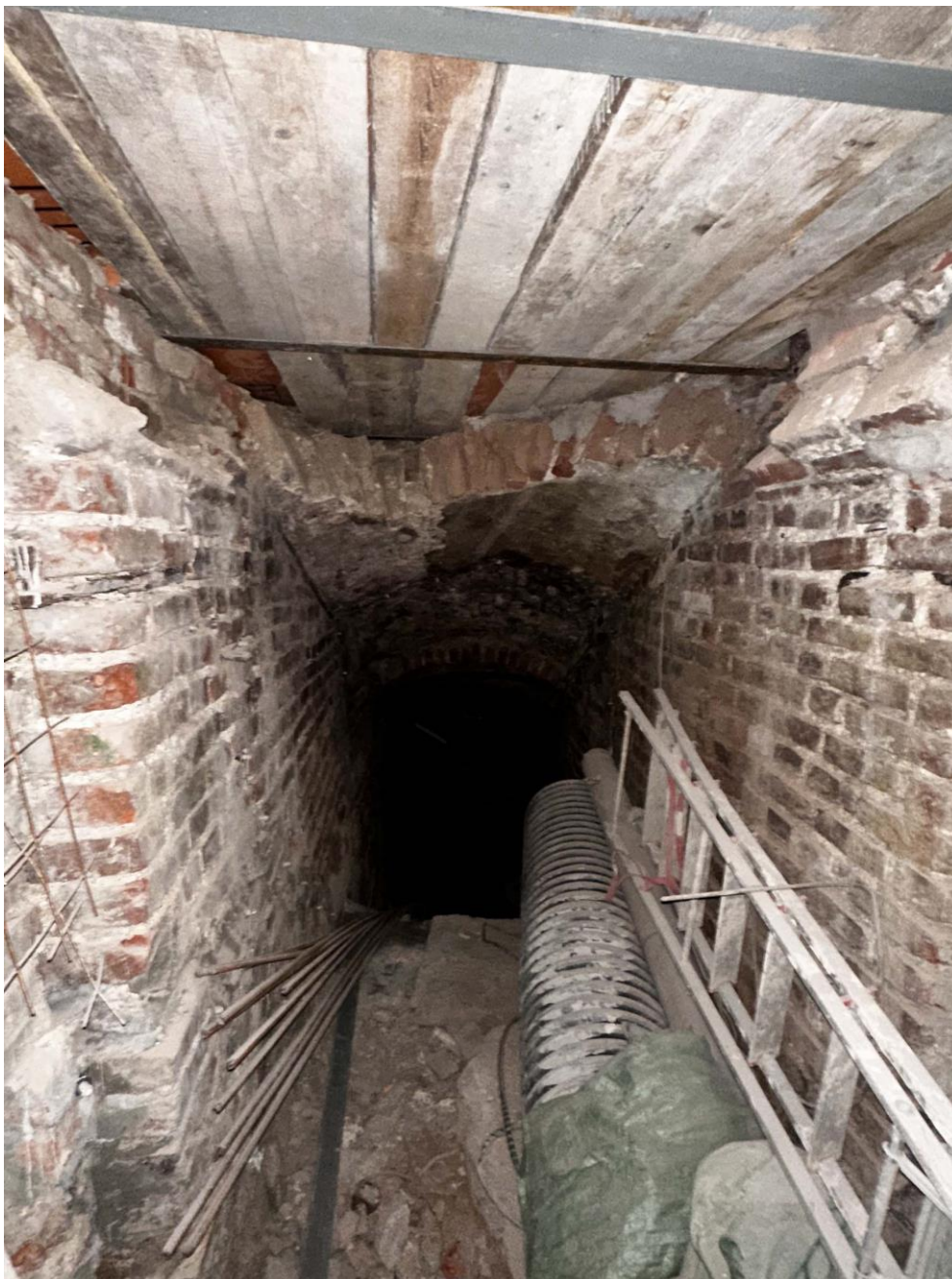
Фото 10. Пом. 0.1. Выявленный проход в помещение подвала из помещения 1-го этажа 1.8. фото с северо-востока. Дата съемки: 15.11.2022 г. Автор съемки: Глинская Н.Б.
