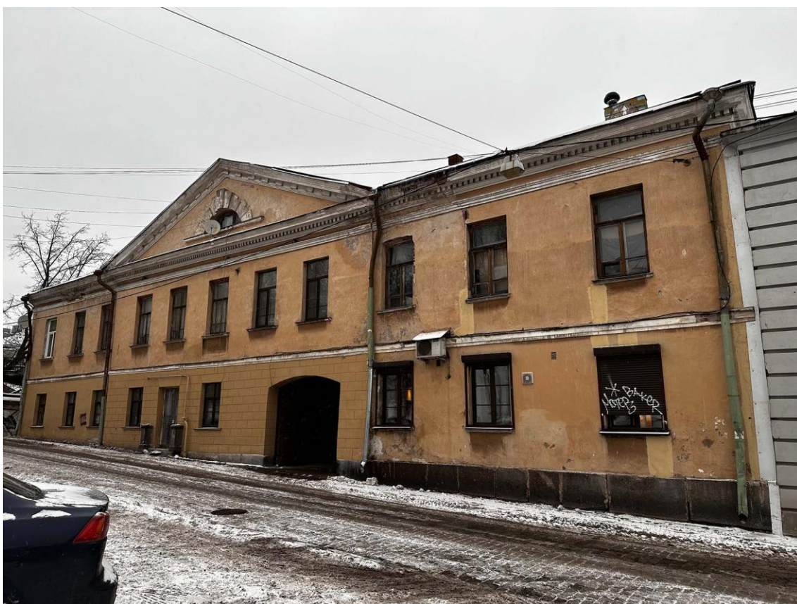
Фото 2. Общий вид лицевого юго-западного фасада здания по ул. Прогонной. Фото с юга. Дата съемки: 15.11.2022 г. Автор съемки: Глинская Н.Б.
