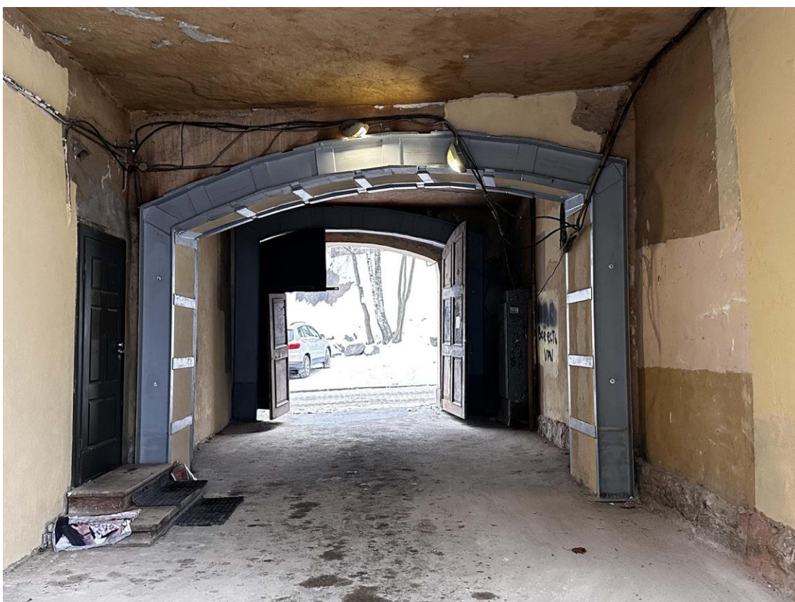
Фото 4. Общий вид сквозного арочного проема, усиленного в 2021 г. Фото с северо-востока. Дата съемки: 15.11.2022 г. Автор съемки: Глинская Н.Б.
