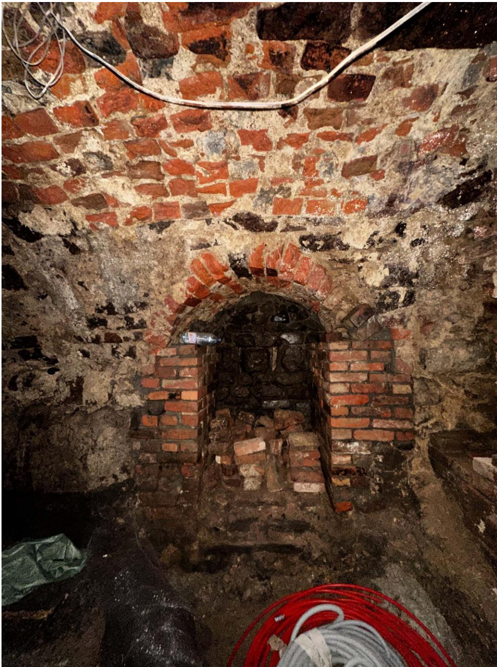
Фото 14. Пом. 0.2. Заложенный проем прохода, расположенный под ул. Прогонной, в юго-западной стене помещения подвала. Фото с северо-востока. Дата съемки: 15.11.2022 г. Автор съемки: Глинская Н.Б.
