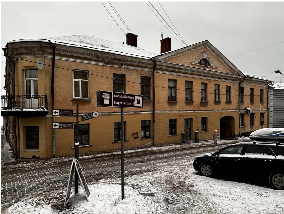
Фото 1. Общий вид здания с запада, со стороны перекрестка ул. Прогонной и Водной заставы. Дата съемки: 15.11.2022 г. Автор съемки: Глинская Н.Б.
