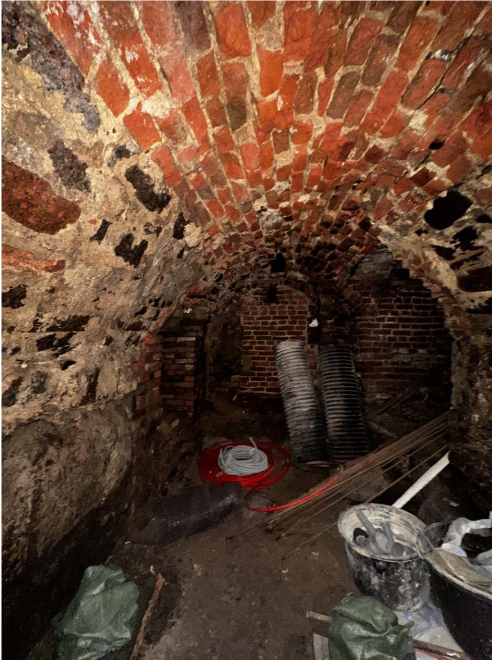
Фото 13. Пом. 0.2. Общий вид помещения с юго-востока. Дата съемки: 15.11.2022 г. Автор съемки: Глинская Н.Б.
