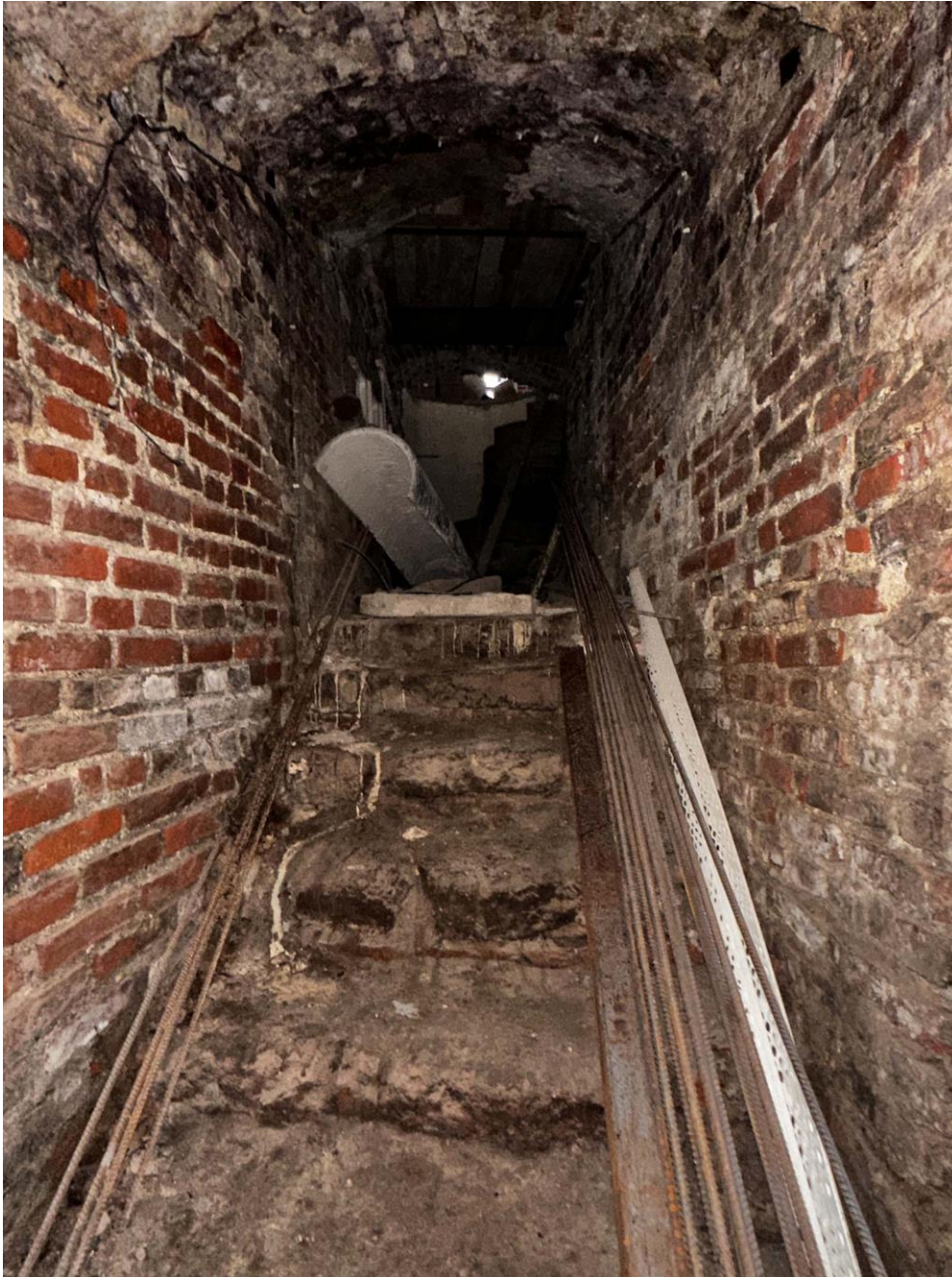
Фото 11. Пом. 0.1. Выявленный проход с каменной лестницей из пом. 1.8 в помещение подвала. Фото с юго-запада. Дата съемки: 15.11.2022 г. Автор съемки: Глинская Н.Б.
