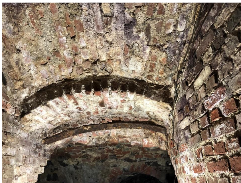
Фото 13. Фрагмент нижней части кирпичного свода помещения лестницы Л-1 с северной стороны.
