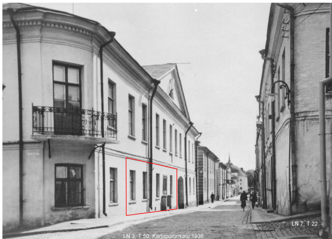
Илл. 9. Общий вид здания со стороны ул. Водной заставы. Фотография 1936 г.
