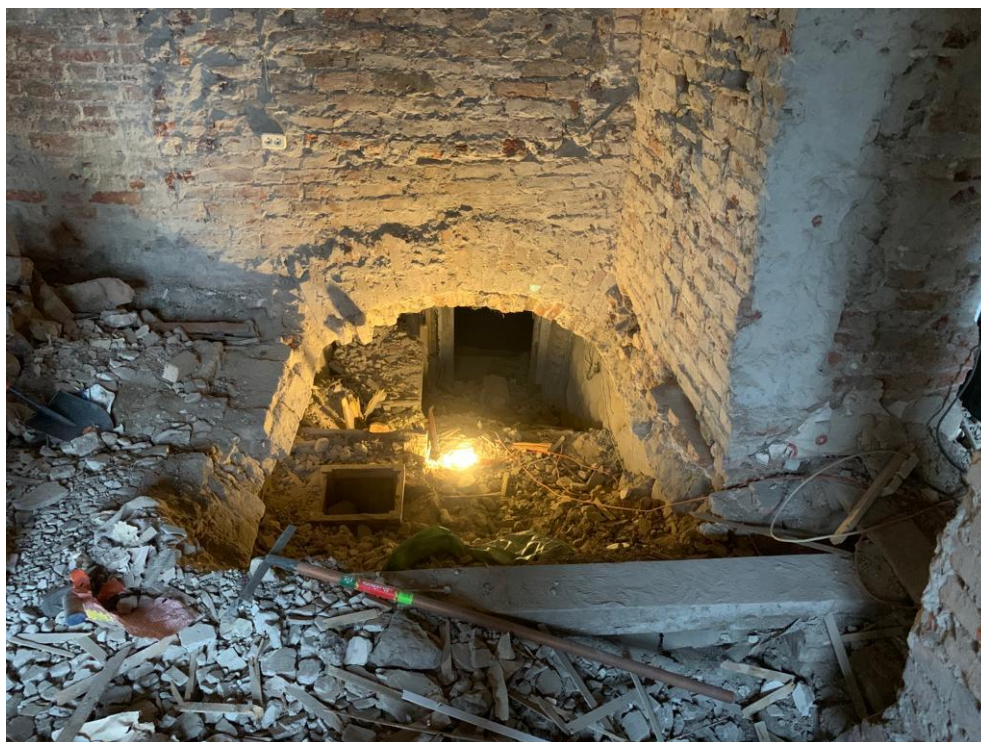
Фото 6. Фрагмент частично разрушенного кирпичного свода и заваленного строительным мусором помещения прохода к Л-1. Вид с северной стороны.
