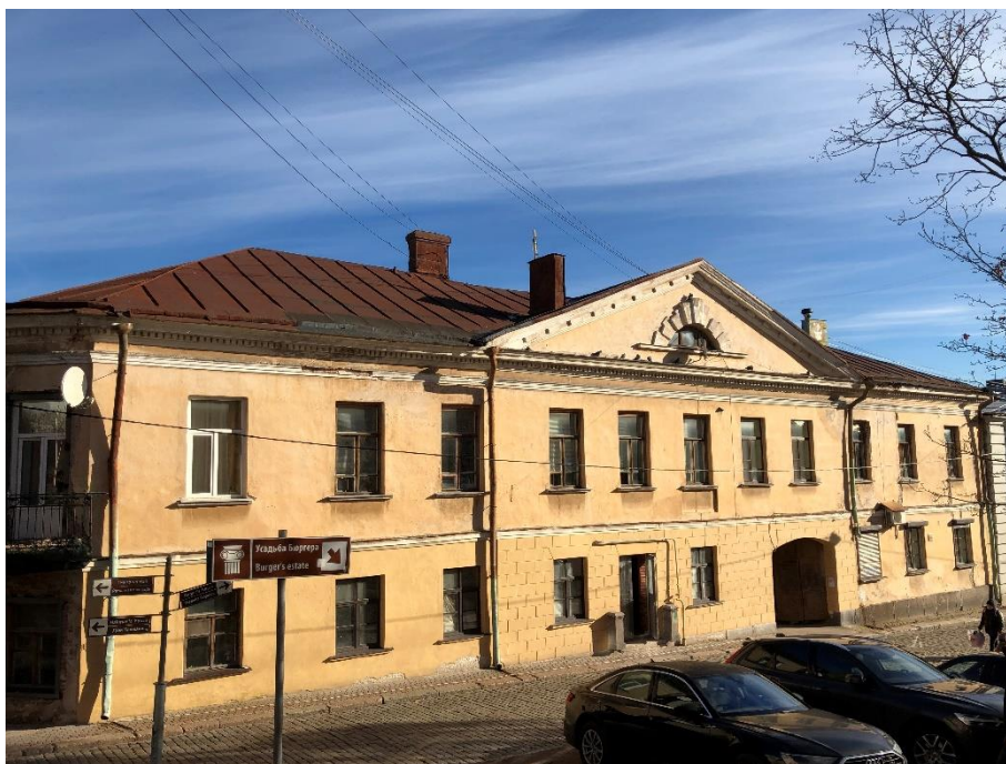
Фото 1. Общий вид Ю-З фасада здания по ул. Прогонной.
