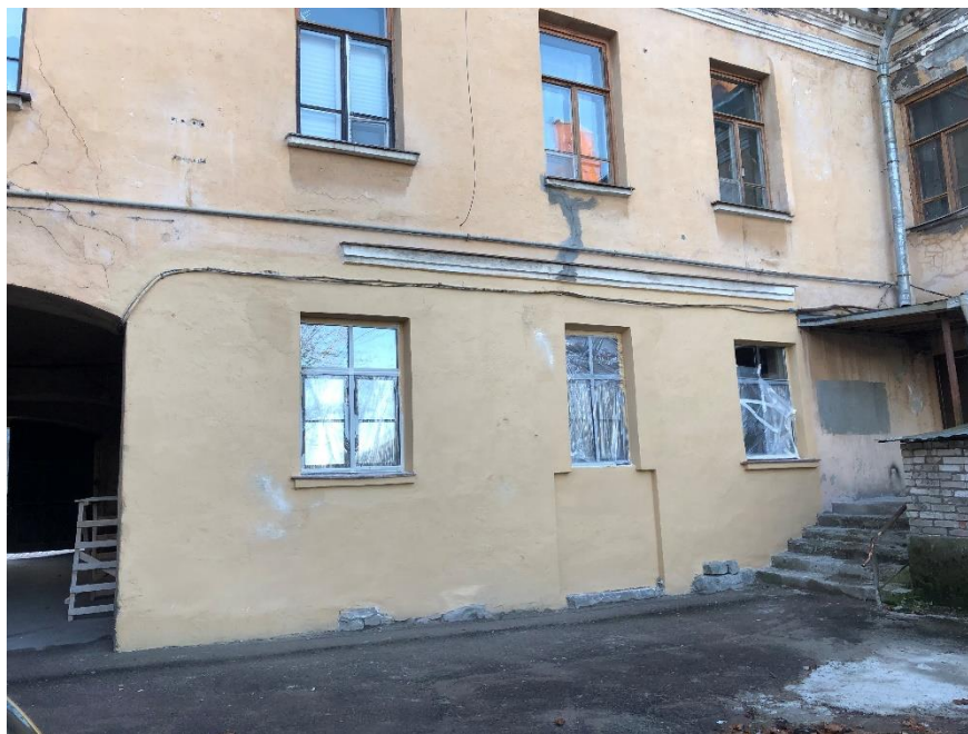
Фото 3. Фрагмент С-В дворового фасада здания в марте 2022 г. (соответствующий помещениям бывшей кв. № 6)
