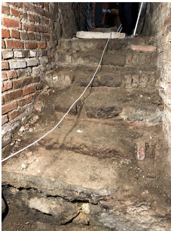
Фото 14. Общий вид лестничного марша Л-1 с Ю-З стороны.
