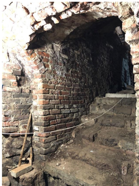
Фото 15. Общий вид помещения лестницы Л-1 с южной стороны.
