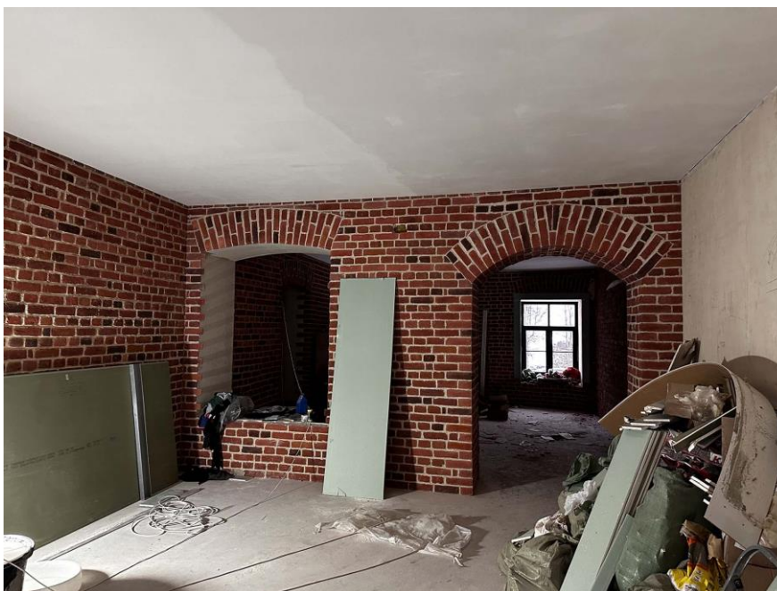
Фото 9. Фрагмент помещения 1.1. Вид на стену по оси Б с южной стороны.
