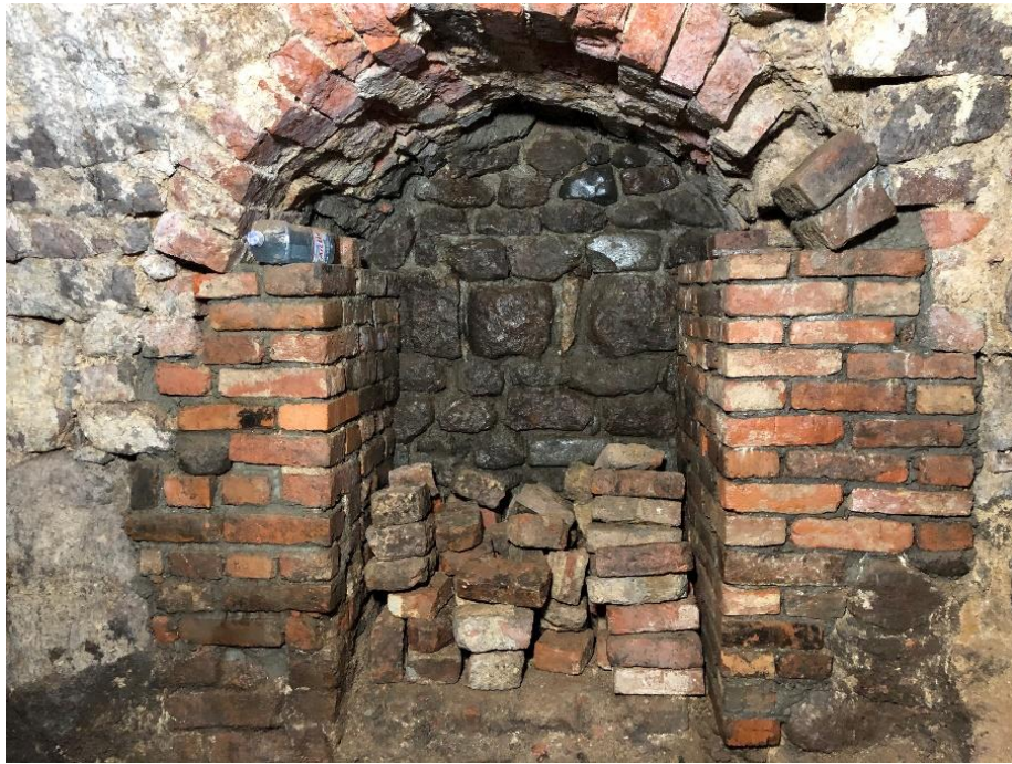
Фото 21. Общий вид с С-В стороны на дверной проем заложенного прохода, ведущего из сводчатого помещения в Ю-З сторону.
