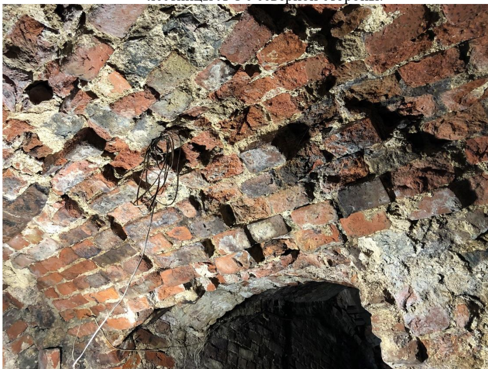
Фото 11. Общий вид кирпичного свода помещения лестницы Л-1 с северной стороны.
