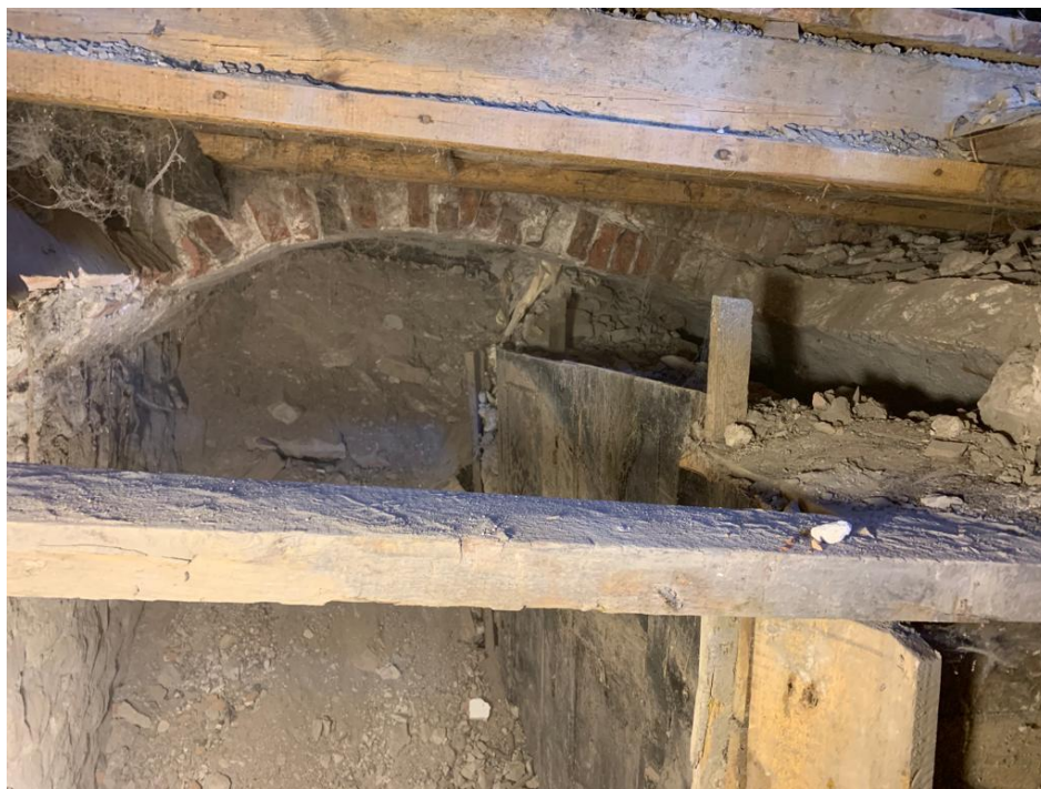
Фото 6. Фрагмент частично разрушенного кирпичного свода и заваленного строительным мусором помещения прохода к Л-1. Вид с северной стороны.
