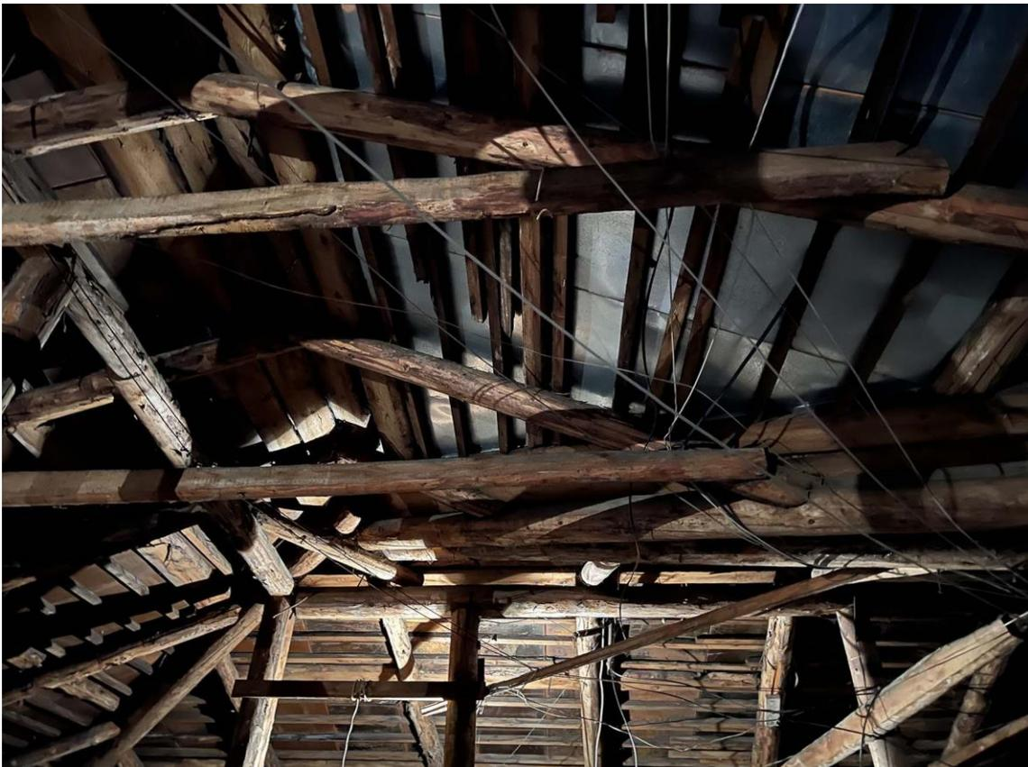
Фото 29. Чердак. Конструкции стропильной системы в центральной части юго-западного крыла. Автор съемки: Куваева Ю.П. Дата съемки: 27.09.2022 г.
