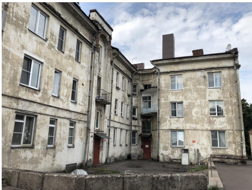
Фото 4. Общий вид здания со стороны двора с восточной стороны.
