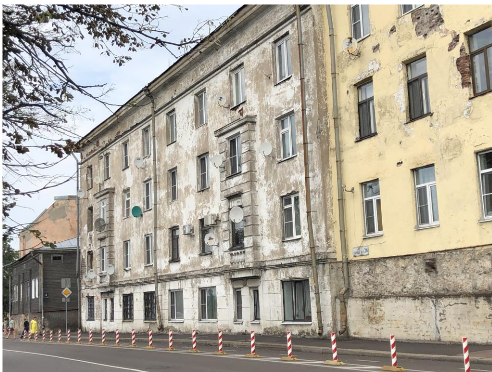
Фото 1. Общий вид здания со стороны ул. Южный вал с Ю-В стороны.
