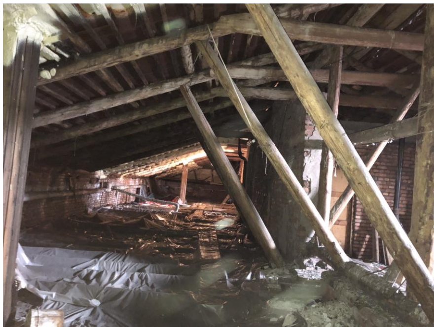
Фото 15. Общий вид чердака Ю-В крыла здания вдоль ул. Южный вал.. Вид с Ю-В стороны.
