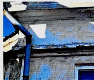
Фрагмент дворового фасада. Первоначальный венчающий карниз
