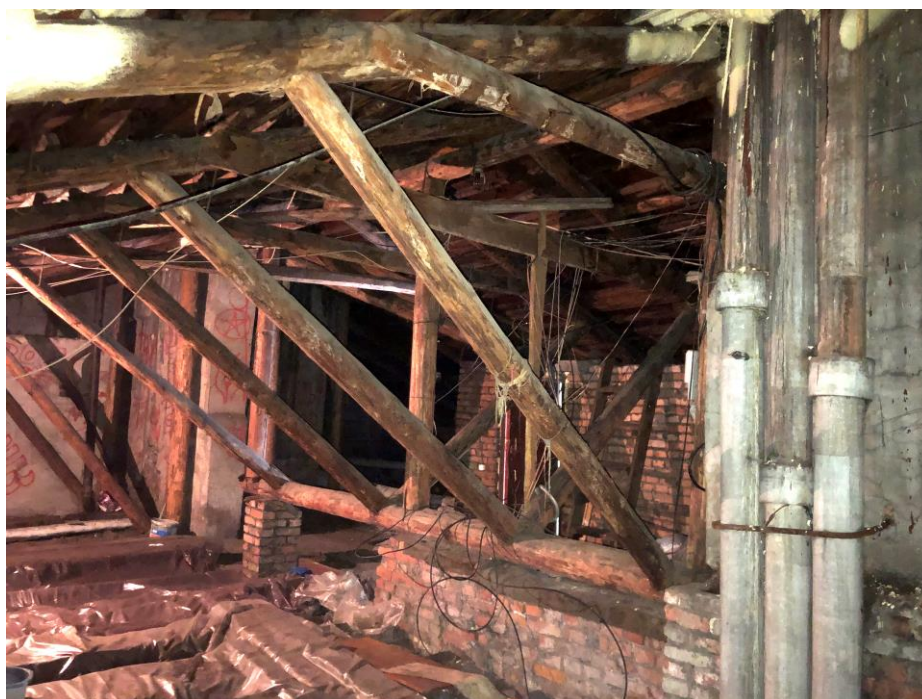
Фото 11. Фрагмент С-В крыла чердака здания. Вид с Ю-З стороны.
