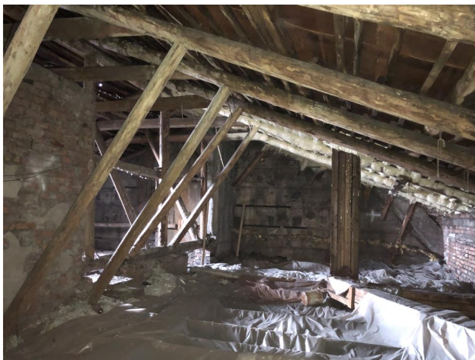
Фото 16. Фрагмент чердака Ю-В крыла здания вдоль ул. Южный вал.. Вид с Ю-З стороны.
