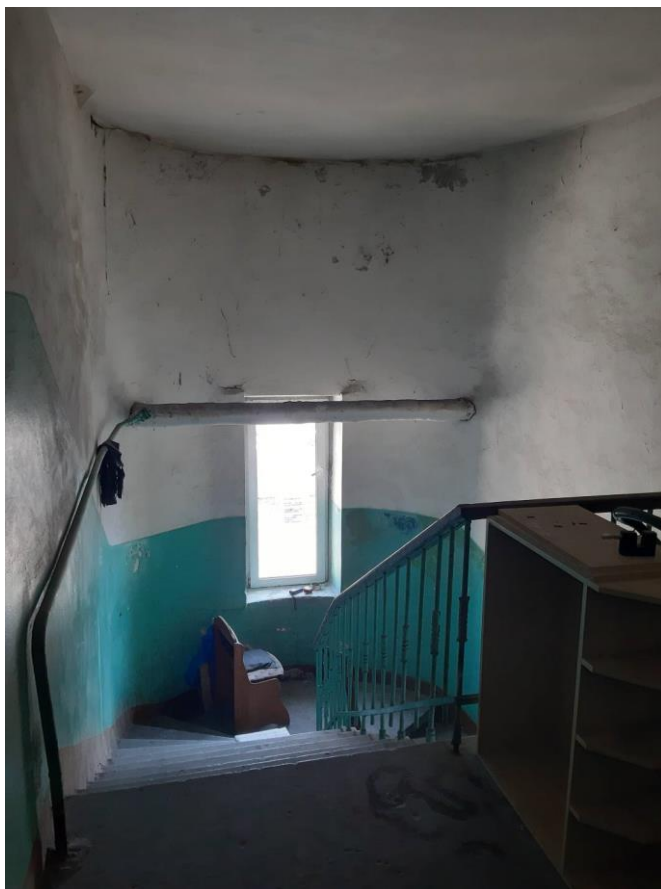
Фото 9. Фрагмент лестничной клетки ЛК-1
