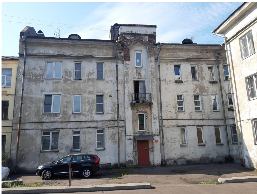
Фото 5. Общий вид здания со стороны двора с северной стороны.
