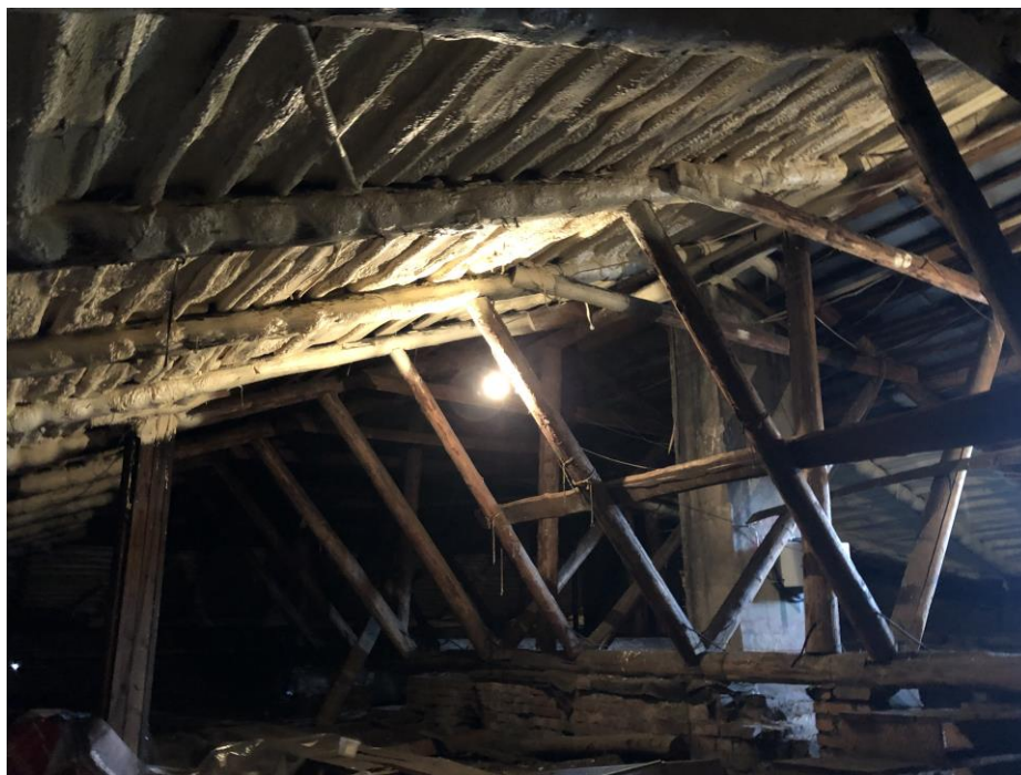
Фото 14. Общий вид центральной части чердака Ю-В крыла здания. Вид с южной Ю-В стороны.
