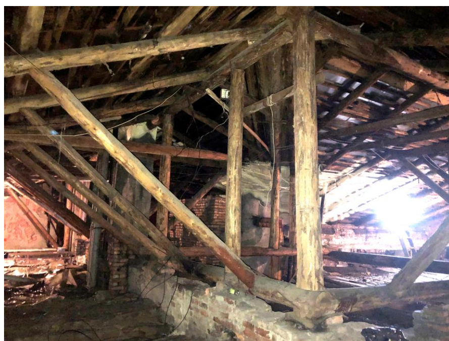
Фото 12. Общий вид центральной части чердака С-З крыла здания. Вид с Ю-З стороны
