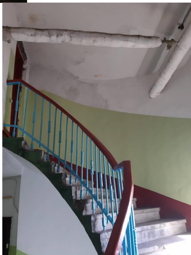
Фото 10. Фрагмент лестничной клетки ЛК-2
