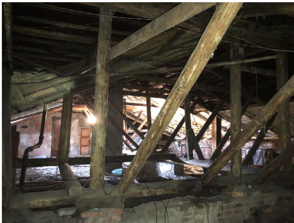
Фото 13. Общий вид центральной части чердака Ю-В крыла здания. Вид с С-З стороны.
