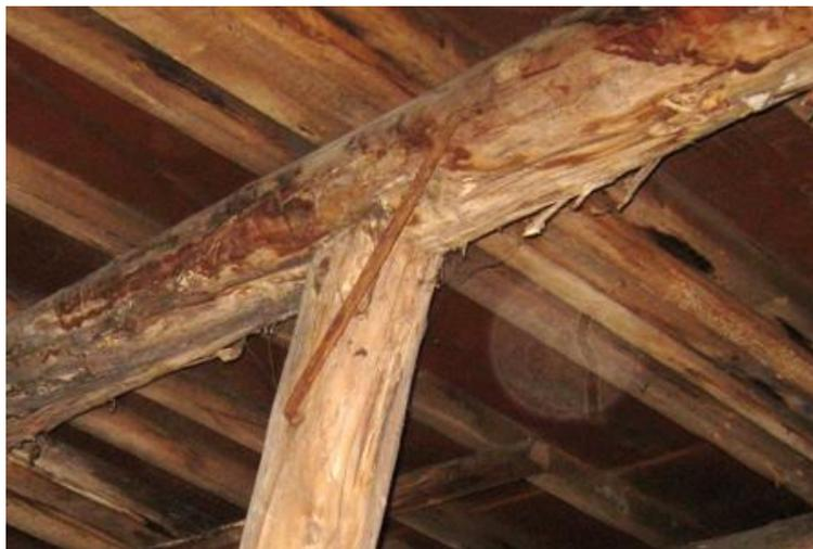
**Фото 29.** Типовой узел опирания стропильной ноги на подкос, коррозия скобы.
