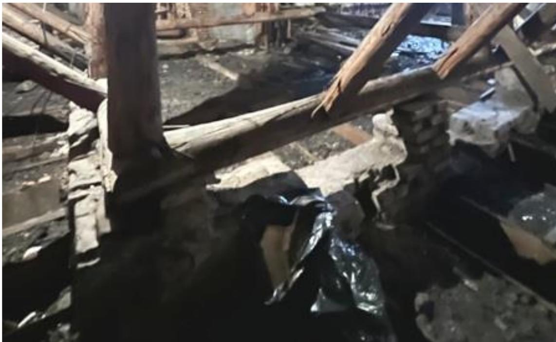
**Фото 25.** Намокание, разрушение участков кладки, деструкция раствора, утрата отдельных кирпичей.
