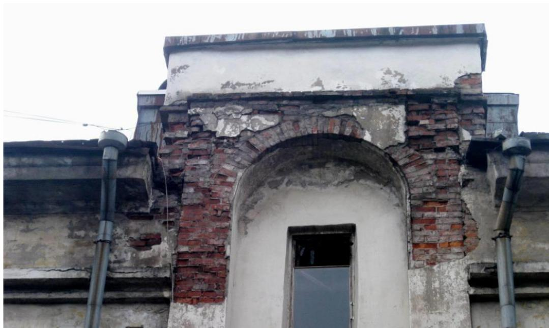
**Фото 36.** Намокание, обрушение штукатурки, деструкция кладки на глубину до 120 мм, нарушения отвода воды с кровли.
