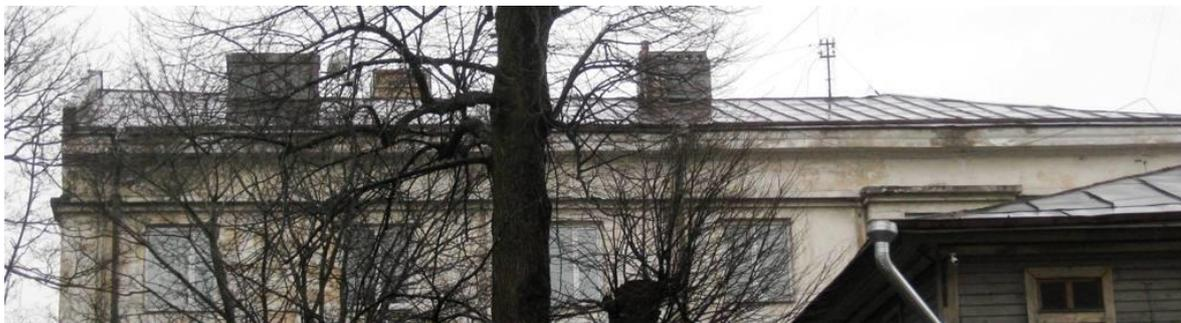
**Фото 5.** Со стороны улицы прогиб линии конька – общая деформация стропильной системы.
