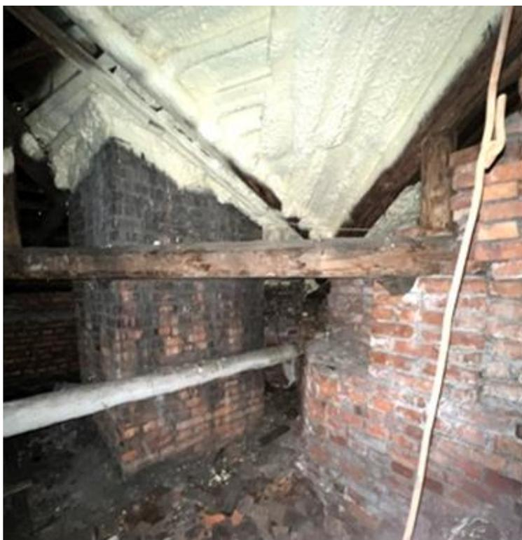
**Фото 19.** Узлы примыканий крыши к вентиляционным шахтам синтетической пеной. Следы протечек на кладке вентиляционных шахт, отслоения штукатурки.
