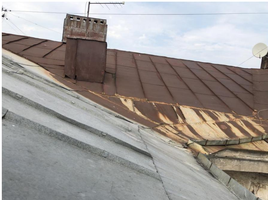
**Фото 35.** Сплошная коррозия кровельного железа, погнутость, локальные разрывы замена кровельного покрытия на отдельных участках, отсутствие ограждения на крыше.
