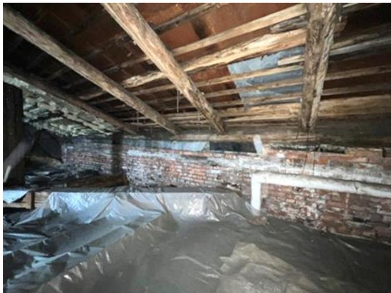
**Фото 8.** Замена отдельных участков кровельного покрытия). Повсеместно намокание, гниение, прогибы и изломы обрешетки.
