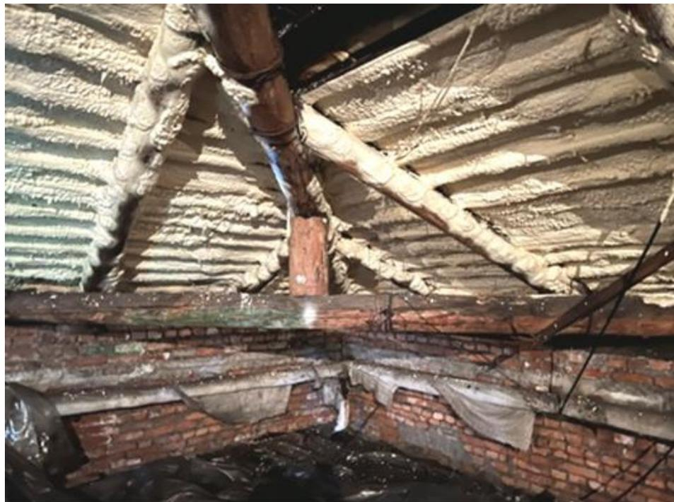
**Фото 16.** Прогибы, трещины вдоль волокон, расщепление несущих балок под промежуточные опоры диагональных стропильных ног.
