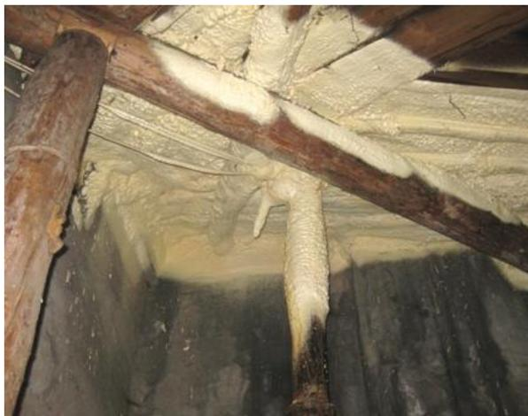
**Фото 20.** Узлы примыканий крыши к вентиляхтам, к фановым трубам покрыты синтетической пеной. Следы протечек на кладке вентиляхт, отслоения штукатурки.
