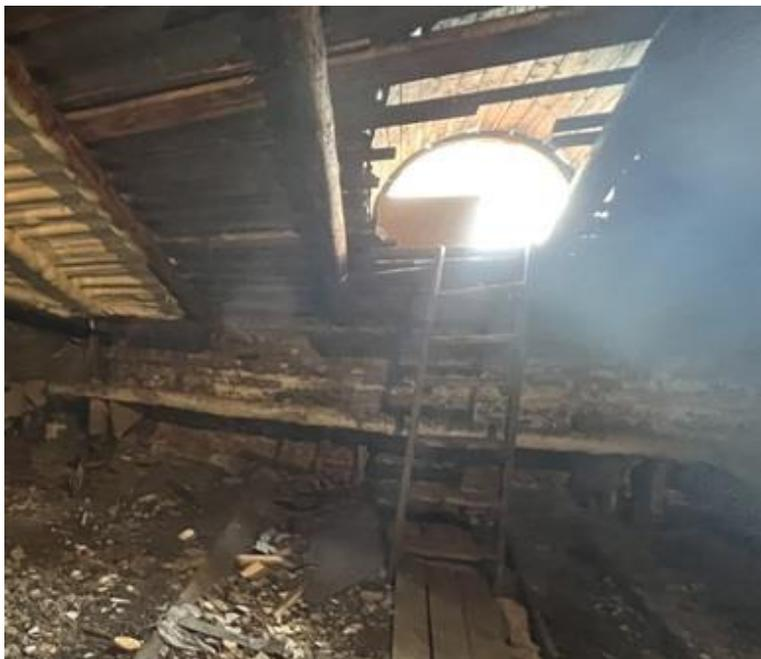
**Фото 18.** Значительные протечки, гниение и изломы обрешетки у слуховых окон, деформация стропил.
