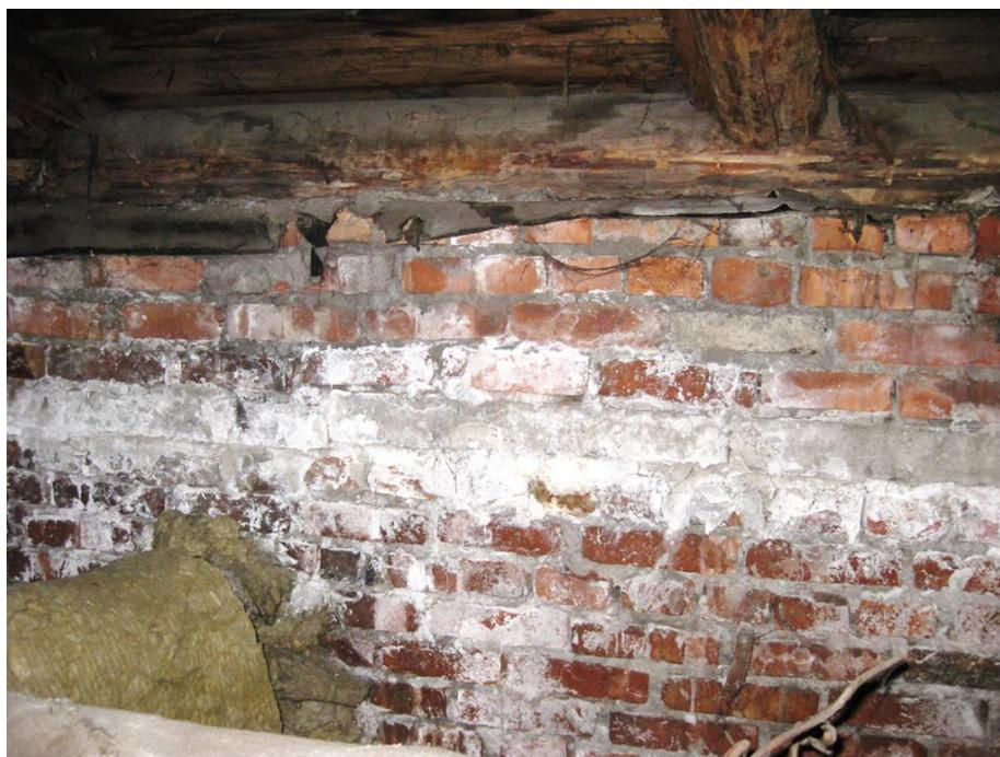
**Фото 15.** намокание и промораживание кладки наружных стен чердака
