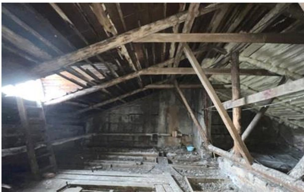
**Фото 17.** Значительные протечки, гниение и изломы обрешетки у слуховых окон, деформация стропил.
