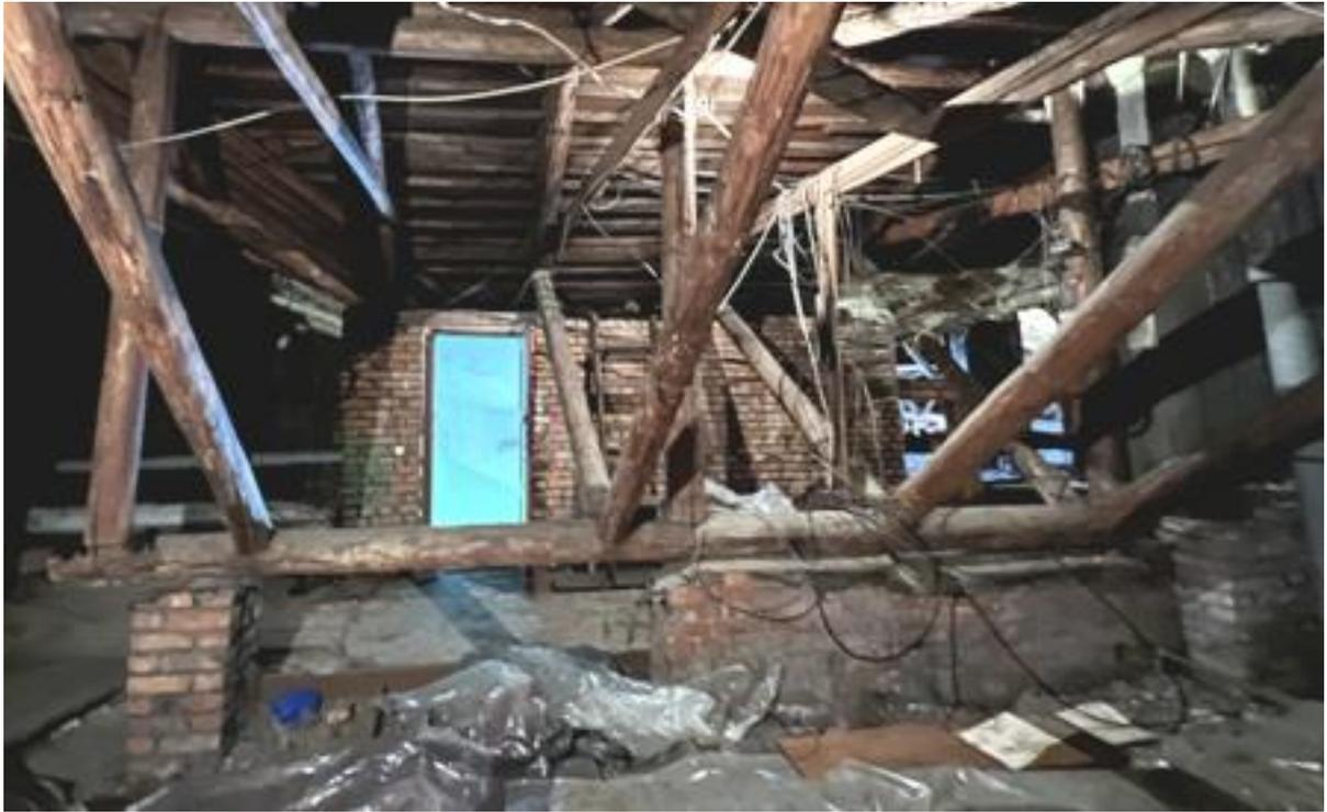
**Фото 27.** Разрушение кладки, излом консоли лежня, отклонение стойки подстропильной рамы.
