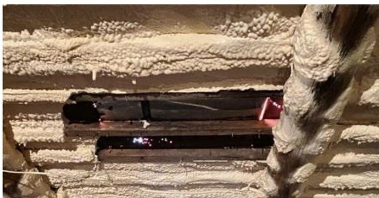
**Фото 6.** Сплошная коррозия кровельного железа до локальных изломов, просветов. Конструкции покрыты пеной.
