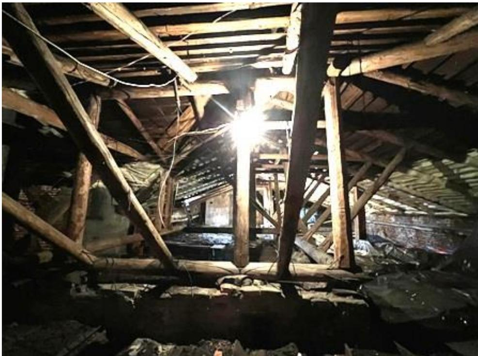
**Фото 4.** Отклонения стоек от вертикали, нет вертикальных связей между стойками, нарушение соосности стропильных ног с подкосами и затяжками, конструкции покрыты пеной.
