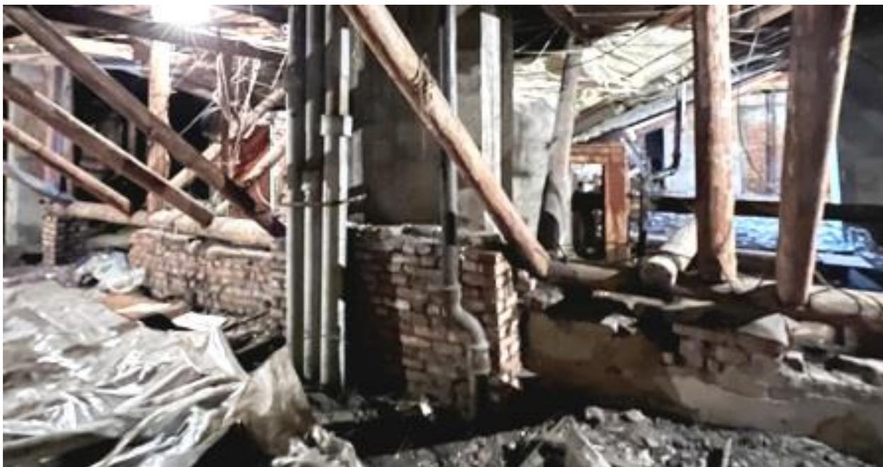
**Фото 24.** Верх кладки внутренних стен под лежни на разных отметках. Намокание, разрушение участков кладки, деструкция раствора, утрата отдельных кирпичей.
