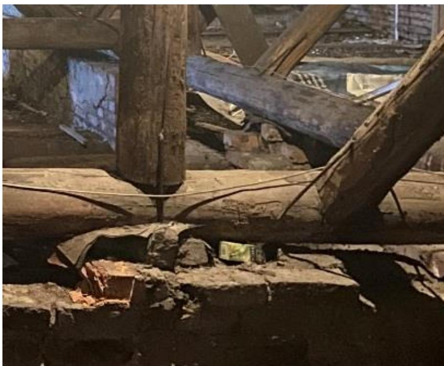
**Фото 30.** Типовой узел опирания стоек и подкосов на лежень. Коррозия, погнутость скоб. Трещины в древесине под скобами.
