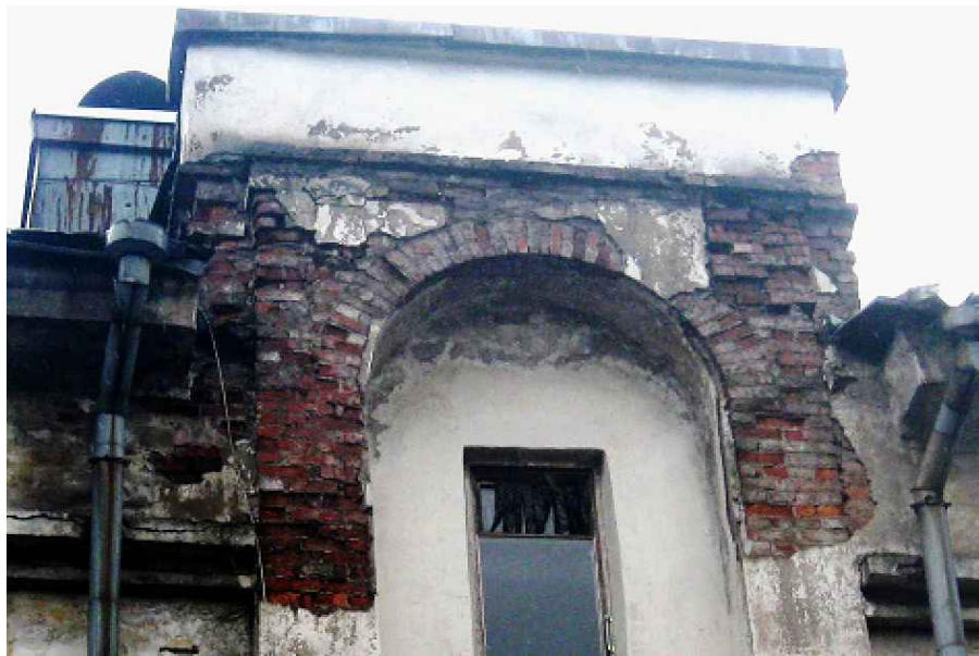
Фото 1. Башнеобразная надстройка над лестницей ЛК-1.
