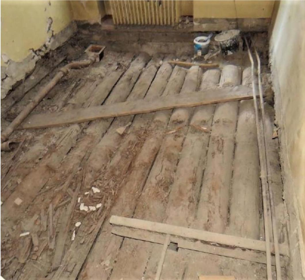
Фото 19. Пом. 2.23. Перекрытие 1-го этажа. Дата съемки: 01.12.2022 г. Автор съемки: Глинская Н.Б.
