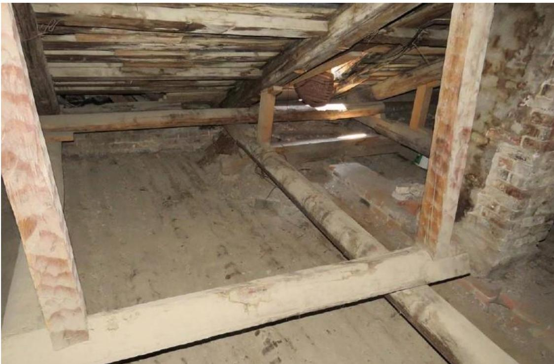
Фото 28. Бревенчатый чати перекрытия. Дата съемки: 01.12.2022 г. Автор съемки: Глинская Н.Б.
