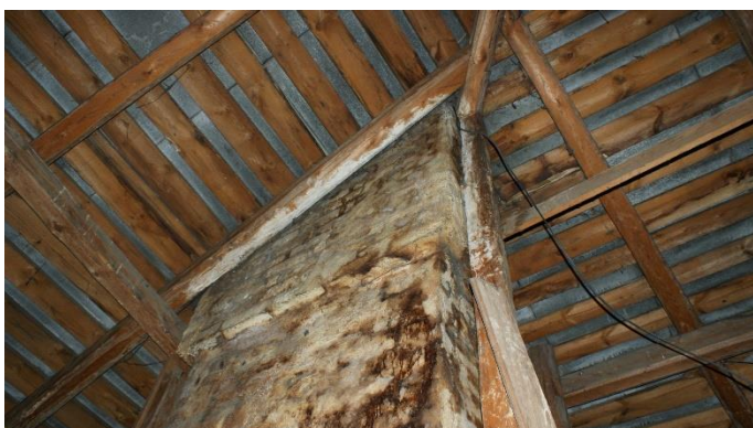
27. «Жилой дом с магазинами акционерного общества «Понтус», Ленинградская обл., Выборгский р-н, г. Выборг, пр. Суворова, д.1. Чердак. Фрагмент. Фото 05.10.2022г.
