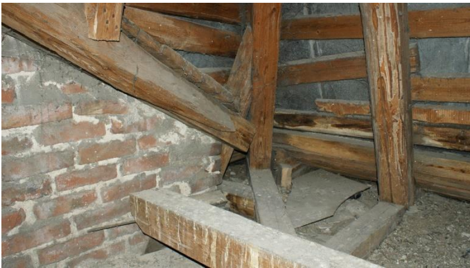
21. «Жилой дом с магазинами акционерного общества «Понтус», Ленинградская обл., Выборгский р-н, г. Выборг, пр. Суворова, д.1. Чердак. Фрагмент. Фото 05.10.2022г.
