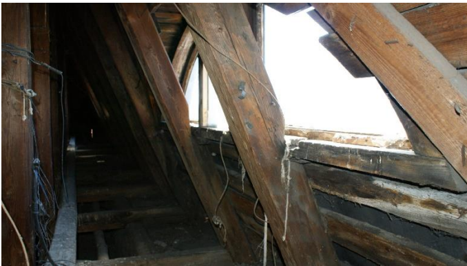
19. «Жилой дом с магазинами акционерного общества «Понтус», Ленинградская обл., Выборгский р-н, г. Выборг, пр. Суворова, д.1. Чердак. Фрагмент. Фото 05.10.2022г.
