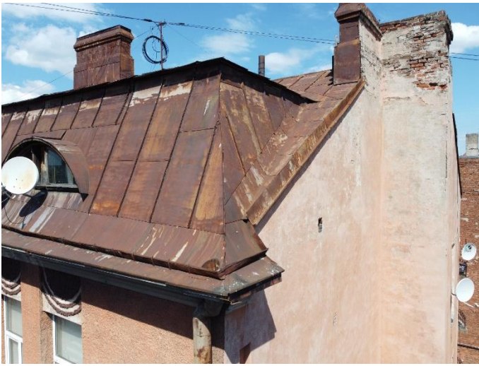
7. «Жилой дом с магазинами акционерного общества «Понтус», Ленинградская обл., Выборгский р-н, г. Выборг, пр. Суворова, д.1. Кровля. Фрагмент. Фото 05.10.2022г.
