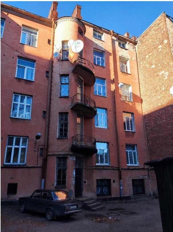
5. «Жилой дом с магазинами акционерного общества «Понтус», Ленинградская обл., Выборгский р-н, г. Выборг, пр. Суворова, д.1. Дворовый фасад. Общий вид. Фото 05.10.2022г.
