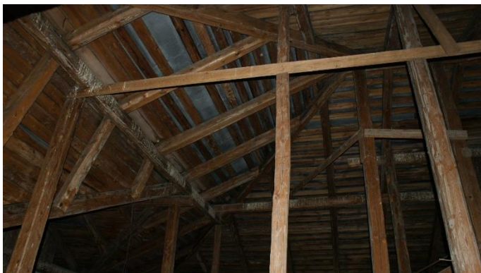
26. «Жилой дом с магазинами акционерного общества «Понтус», Ленинградская обл., Выборгский р-н, г. Выборг, пр. Суворова, д.1. Чердак. Фрагмент. Фото 05.10.2022г.
