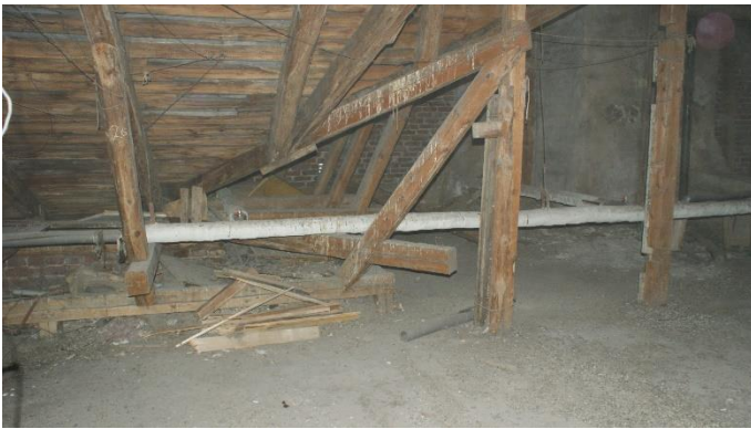
22. «Жилой дом с магазинами акционерного общества «Понтус», Ленинградская обл., Выборгский р-н, г. Выборг, пр. Суворова, д.1. Чердак. Фрагмент. Фото 05.10.2022г.
