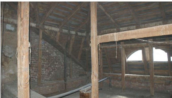
24. «Жилой дом с магазинами акционерного общества «Понтус», Ленинградская обл., Выборгский р-н, г. Выборг, пр. Суворова, д.1. Чердак. Фрагмент. Фото 05.10.2022г.
