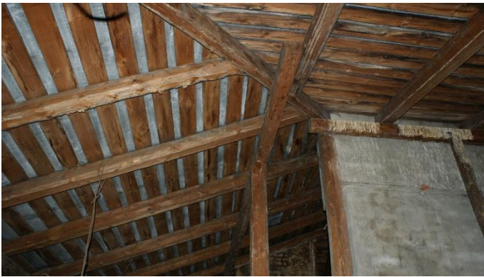
20. «Жилой дом с магазинами акционерного общества «Понтус», Ленинградская обл., Выборгский р-н, г. Выборг, пр. Суворова, д.1. Чердак. Фрагмент. Фото 05.10.2022г.
