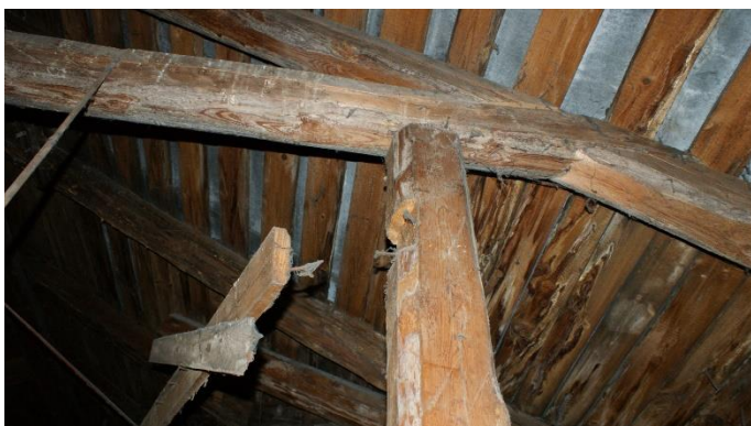
17. «Жилой дом с магазинами акционерного общества «Понтус», Ленинградская обл., Выборгский р-н, г. Выборг, пр. Суворова, д.1. Чердак. Фрагмент. Фото 05.10.2022г.
