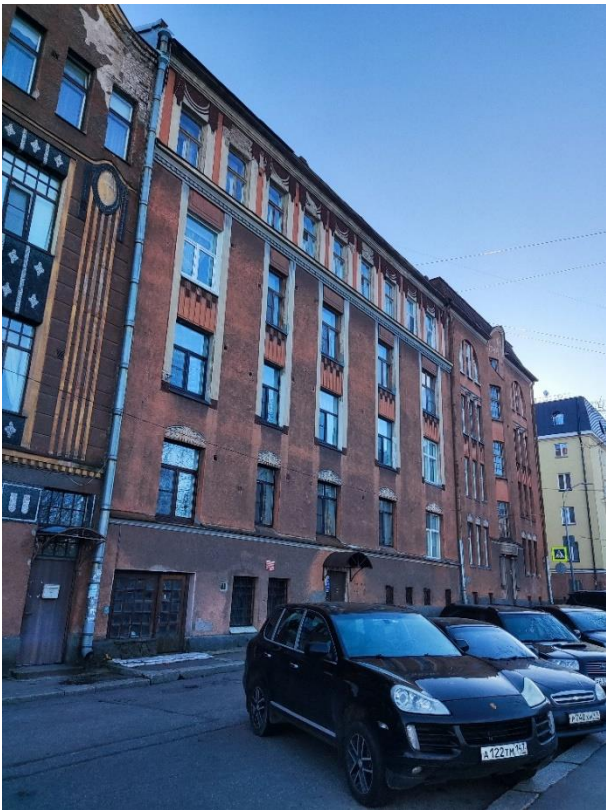
1. «Жилой дом с магазинами акционерного общества «Понтус», Ленинградская обл., Выборгский р-н, г. Выборг, пр. Суворова, д.1. Северо-западный фасад. Общий вид. Фото 05.10.2022г.
