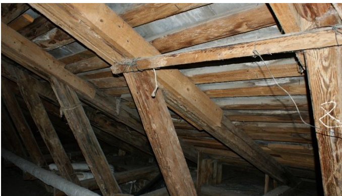
12. «Жилой дом с магазинами акционерного общества «Понтус», Ленинградская обл., Выборгский р-н, г. Выборг, пр. Суворова, д.1. Чердак. Фрагмент. Фото 05.10.2022г.
