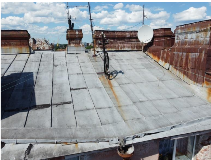
9. «Жилой дом с магазинами акционерного общества «Понтус», Ленинградская обл., Выборгский р-н, г. Выборг, пр. Суворова, д.1. Кровля. Фрагмент. Фото 05.10.2022г.
