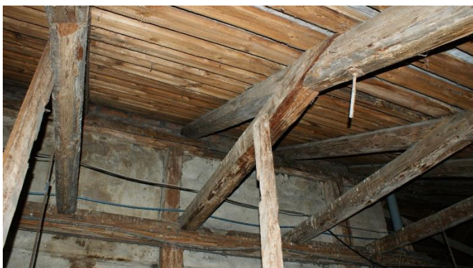
16. «Жилой дом с магазинами акционерного общества «Понтус», Ленинградская обл., Выборгский р-н, г. Выборг, пр. Суворова, д.1. Чердак. Фрагмент. Фото 05.10.2022г.
