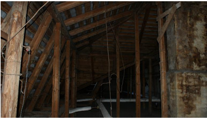
18. «Жилой дом с магазинами акционерного общества «Понтус», Ленинградская обл., Выборгский р-н, г. Выборг, пр. Суворова, д.1. Чердак. Фрагмент. Фото 05.10.2022г.
