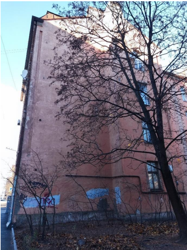
3. «Жилой дом с магазинами акционерного общества «Понтус», Ленинградская обл., Выборгский р-н, г. Выборг, пр. Суворова, д.1. Дворовый фасад. Общий вид. Фото 05.10.2022г.
