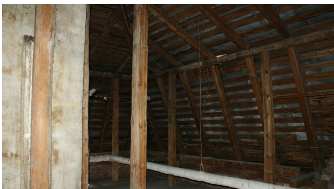
29. «Жилой дом с магазинами акционерного общества «Понтус», Ленинградская обл., Выборгский р-н, г. Выборг, пр. Суворова, д.1. Чердак. Фрагмент. Фото 05.10.2022г.
