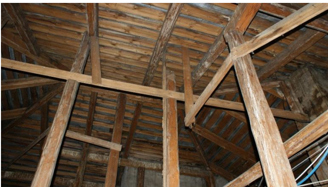
25. «Жилой дом с магазинами акционерного общества «Понтус», Ленинградская обл., Выборгский р-н, г. Выборг, пр. Суворова, д.1. Чердак. Фрагмент. Фото 05.10.2022г.
