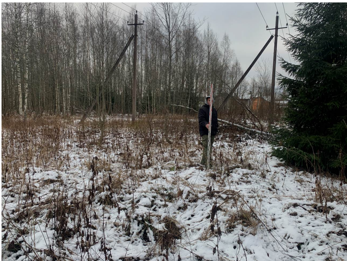
Рис. 23. Ленинградская область, Всеволожский район. Общий вид участка обследования. Точка съемки 5. Вид с северо-запада. 17.11.2022 г.
