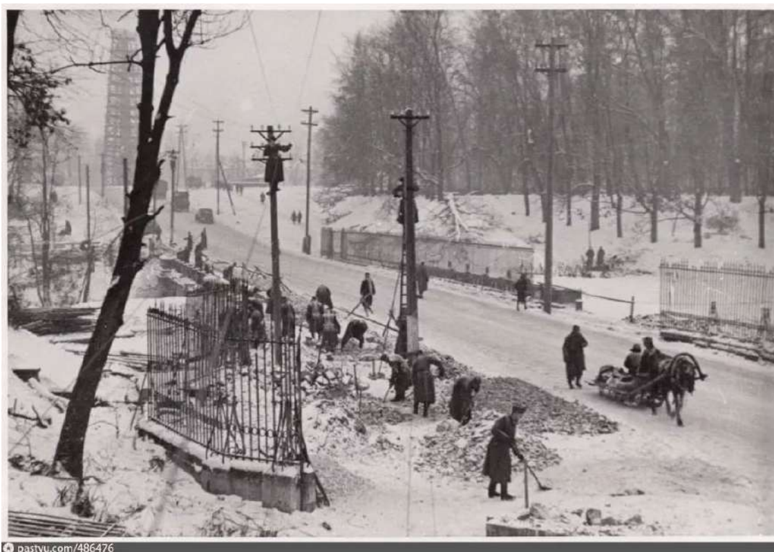
Илл 17. Карпичный (Львиный) мост1941. Россия, Ленинградская область, Гатчинский район, Гатчина, Дворцы и парки Гатчины, Приоратский парк
