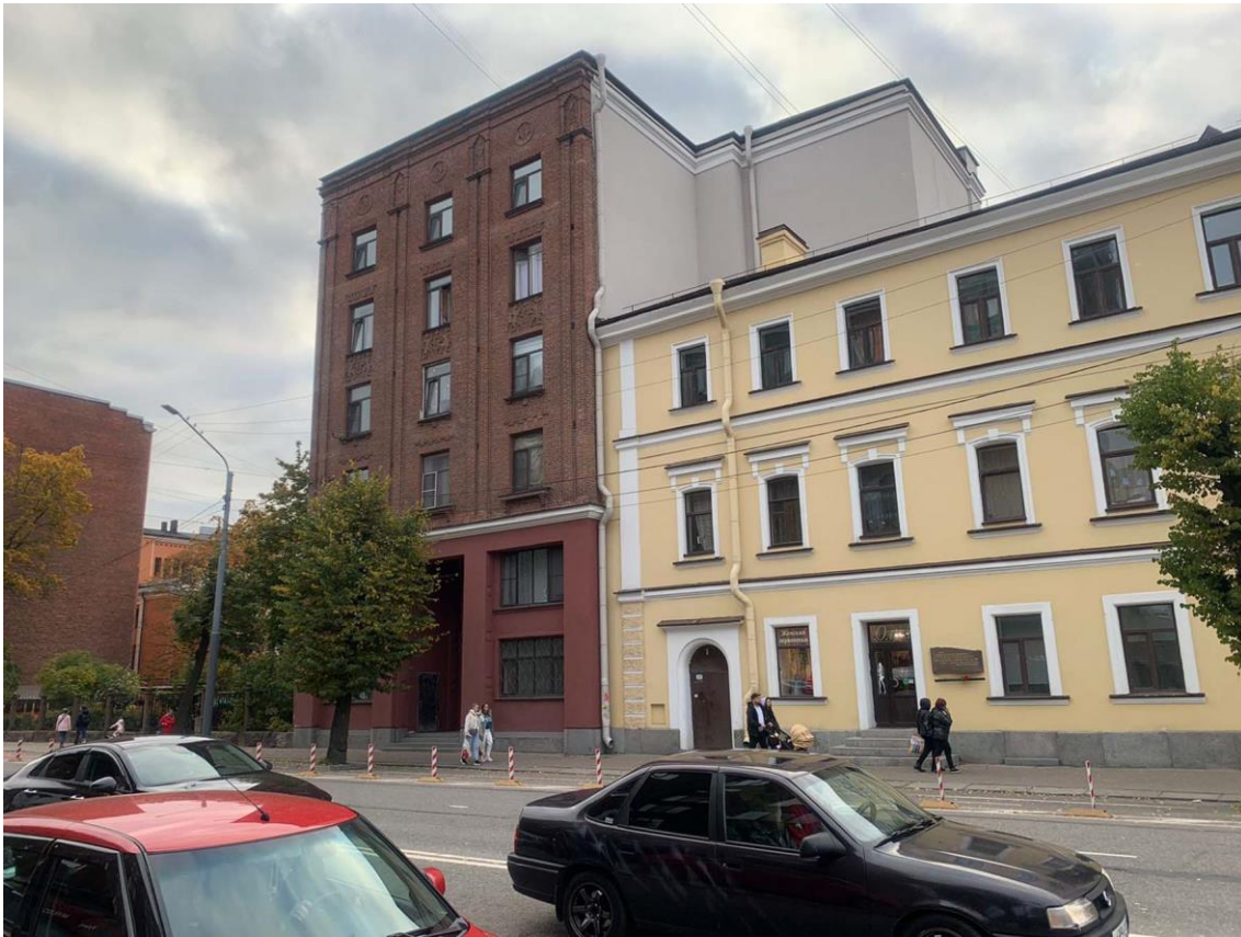
Фото 2. Общий вид здания с Ленинградского проспекта, с востока. Автор съемки: Куваева Ю.П. Дата съемки: 27.09.2022 г.
