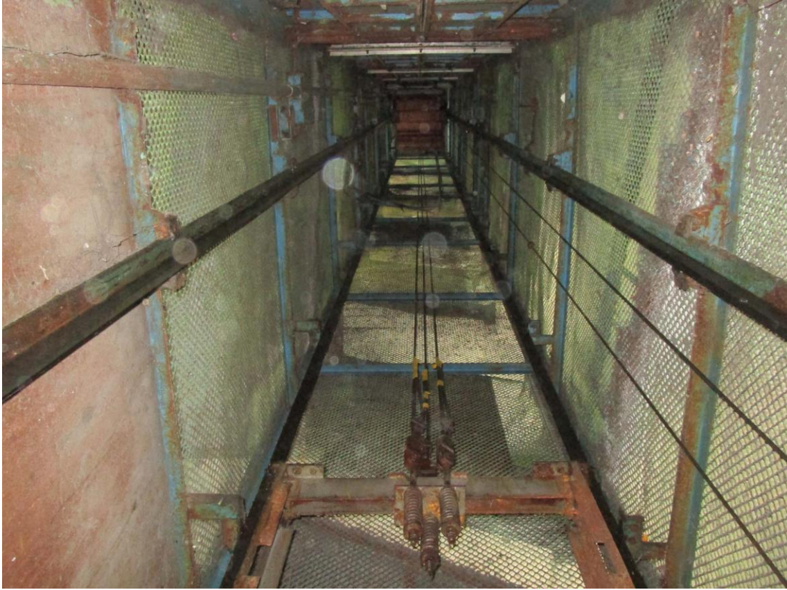
Фото 7. Лифтовая шахта в северной части уличного объема здания. Общий вид металлокаркасной шахты лифта изнутри. Автор съемки: Куваева Ю.П. Дата съемки: 27.09.2022 г.
