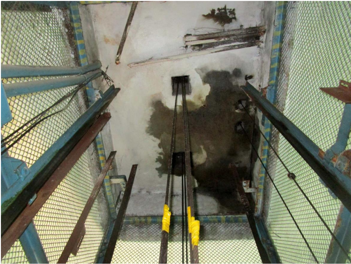
Фото 16. Лифтовая шахта в северной части уличного объема здания. Надшахтное перекрытие лифтовой шахты. Автор съемки: Куваева Ю.П. Дата съемки: 27.09.2022 г.
