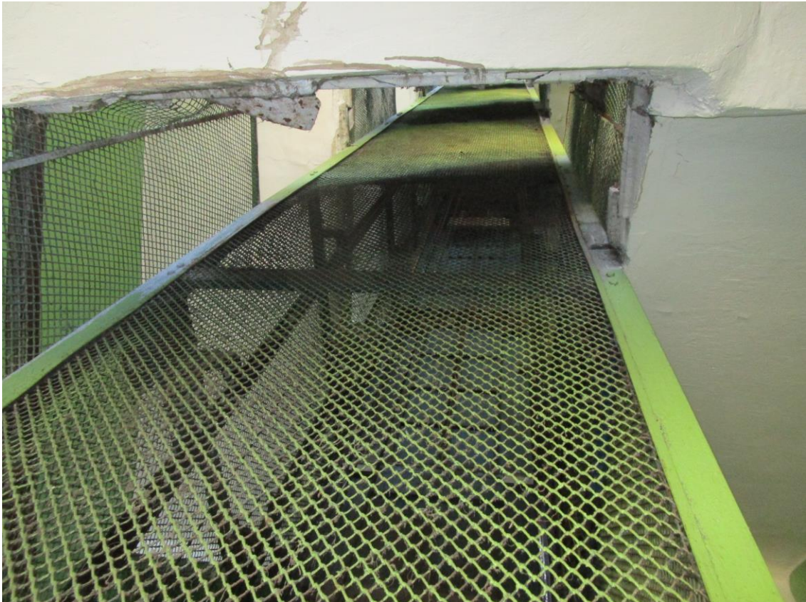
Фото 6. Лифтовая шахта в северной части уличного объема здания. Общий вид с нижних этажей. Автор съемки: Куваева Ю.П. Дата съемки: 27.09.2022 г.
