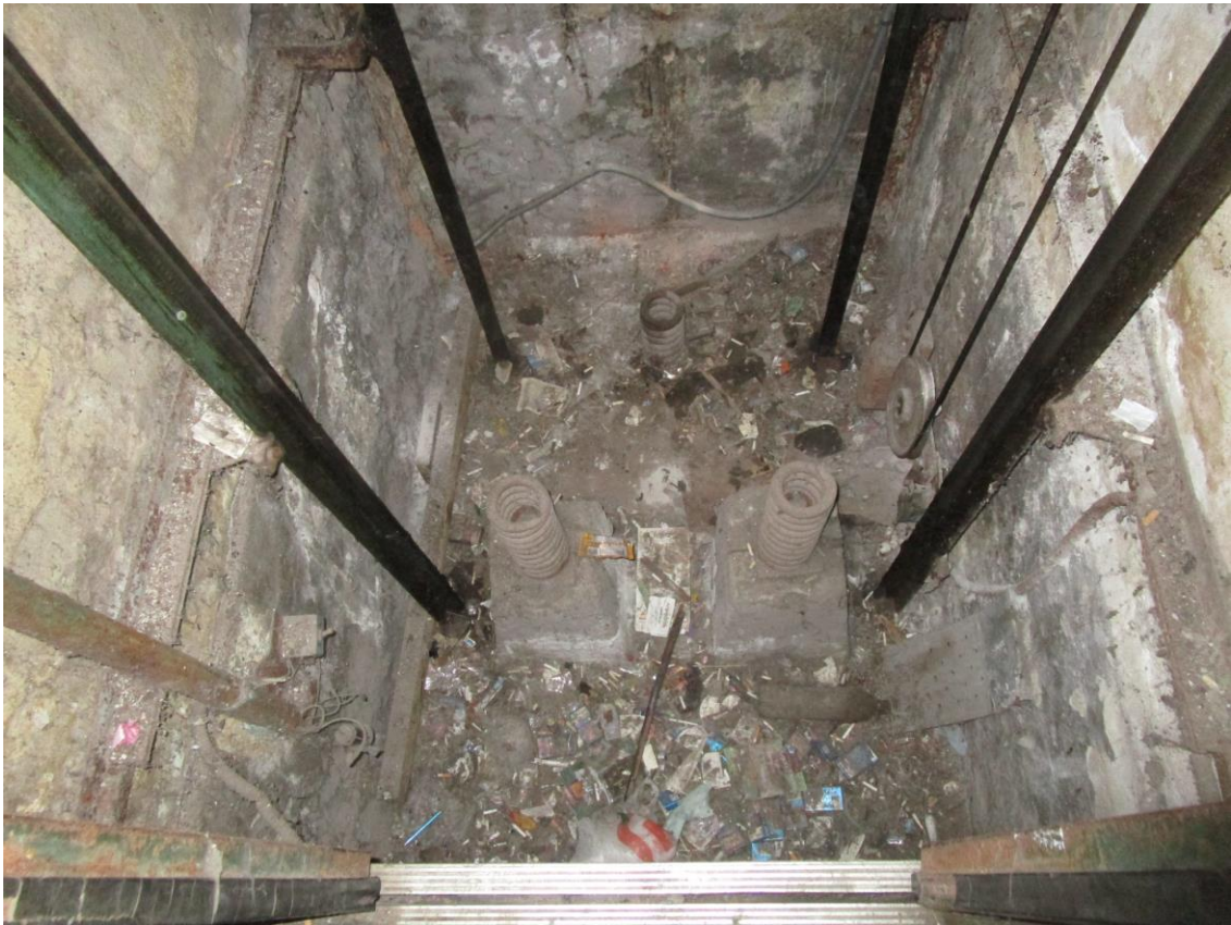
Фото 5. Лифтовая шахта в северной части уличного объема здания. Бетонный приямок шахты лифта. Автор съемки: Куваева Ю.П. Дата съемки: 27.09.2022 г.
