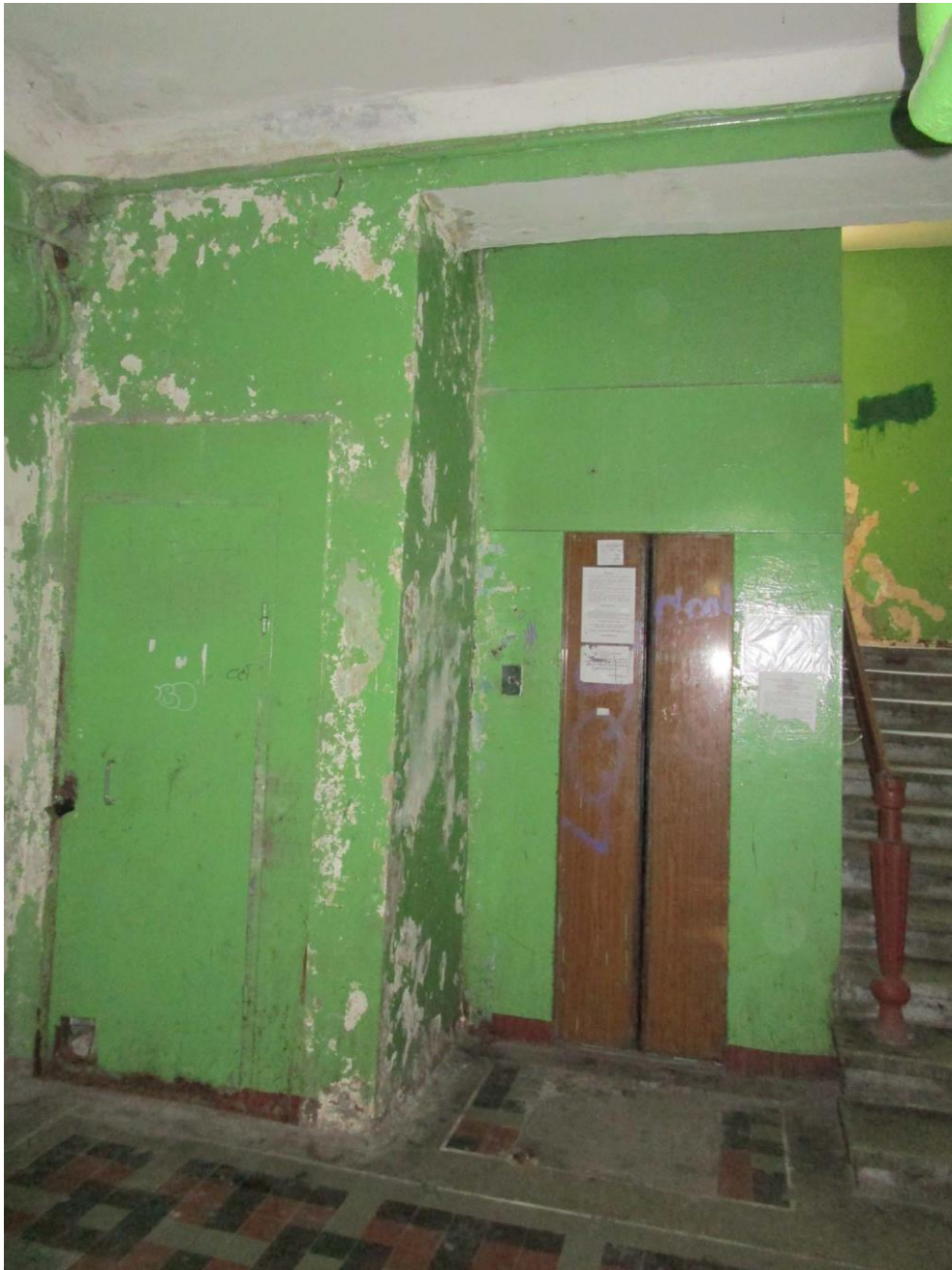
Фото 4. Лифтовая шахта в северной части уличного объема здания. 1-ый этаж. Автор съемки: Куваева Ю.П. Дата съемки: 27.09.2022 г.
