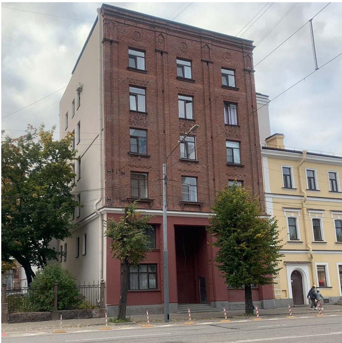
Фото 1. Общий вид здания с Ленинградского проспекта, с юга. Автор съемки: Куваева Ю.П. Дата съемки: 27.09.2022 г.
