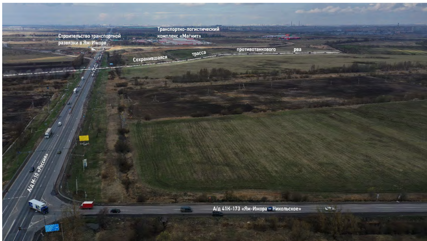
ФОТО 5. Вид с квадрокоптера в северо-западном направлении вдоль автомобильной дороги М-10 «Россия» с восточной стороны от нее.
