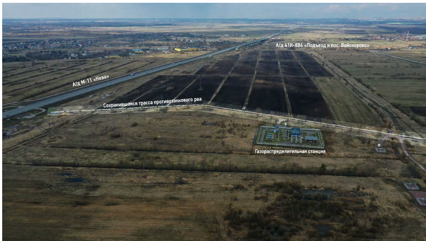
ФОТО 7. Вид с квадрокоптера в северо-западном направлении вдоль автомобильной дороги М-11 «Нева» с восточной стороны от нее.
