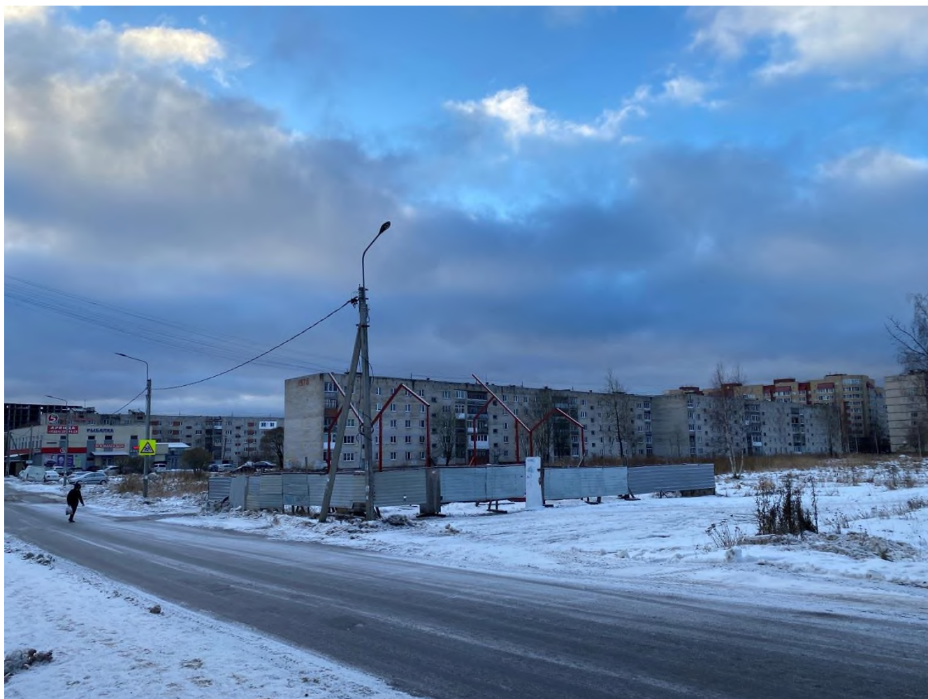
Фото 5. Вид на участок проектирования и соседний земельный участок с северо-востока
