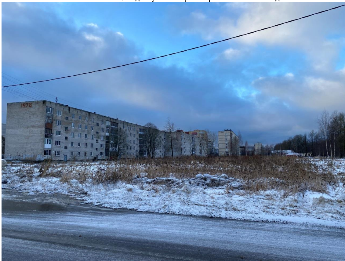
Фото 3. Вид на участок проектирования с востока
