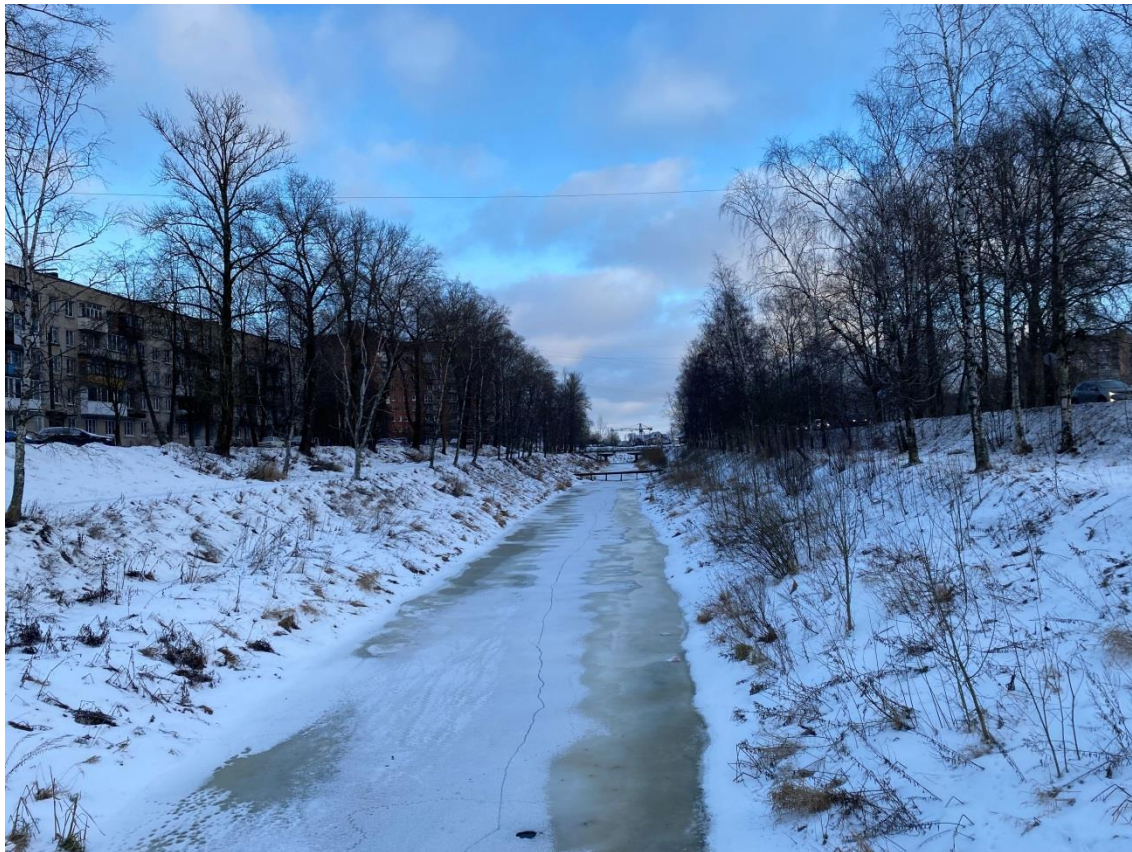
Фото 8. Вид на Малоневский канал, объект культурного наследия
