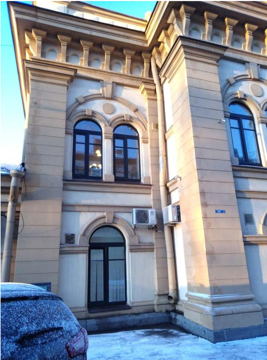
15. Восточный фасад, центральная часть. Современные металлопластиковые оконные заполнения.
