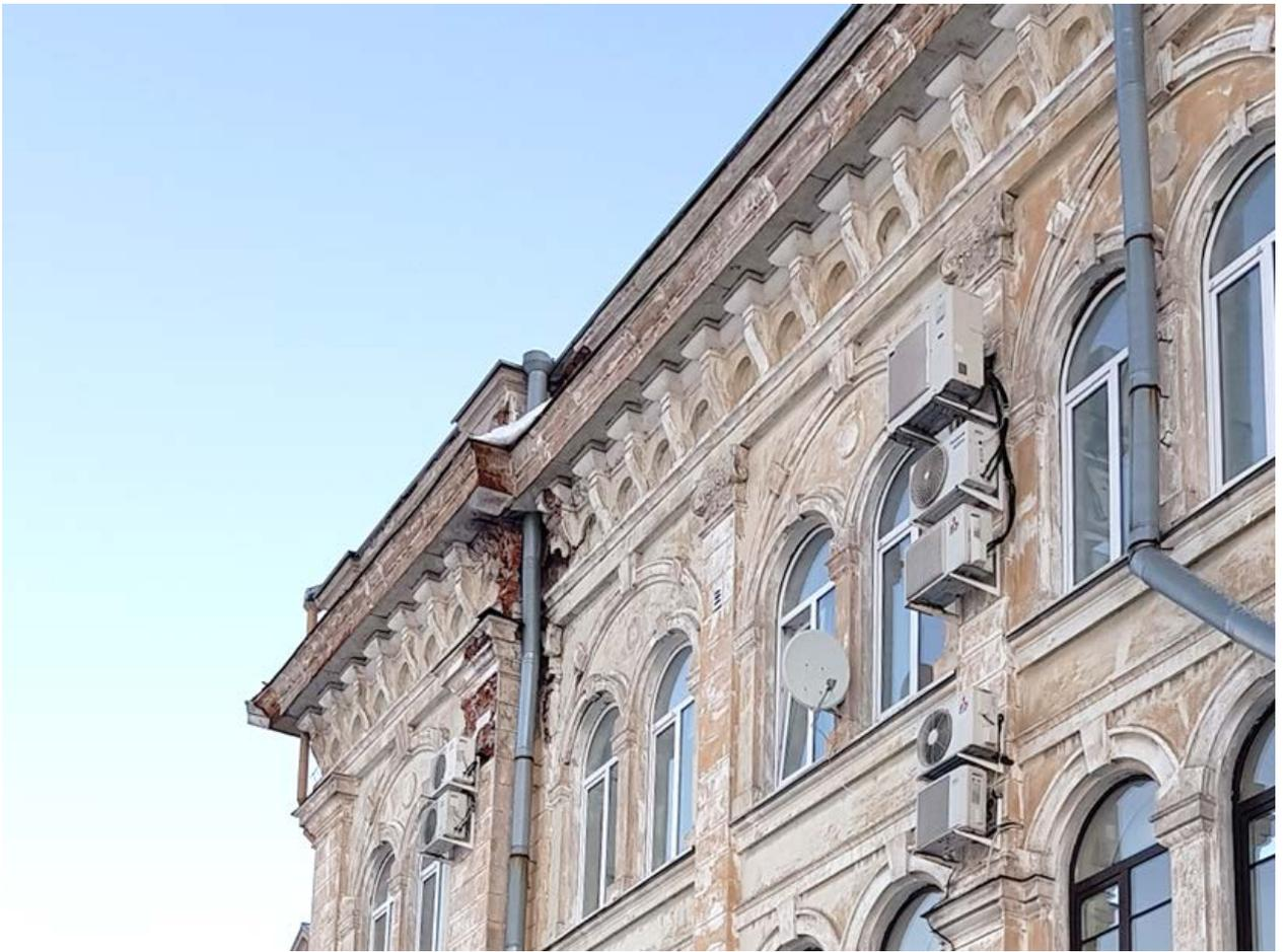
29. Западный фасад, центральная часть. Утрата штукатурного слоя, элементов декора и деструкция кладки в местах прохождения водосточной трубы. Размещение вентиляционного оборудования группами препятствует восприятию фасада.
